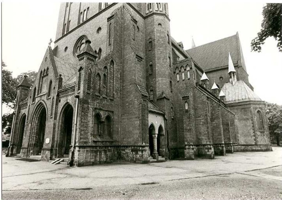
FRAGMENT ELEWACJI POŁUDNIOWO-WSCHODNIEJ.
