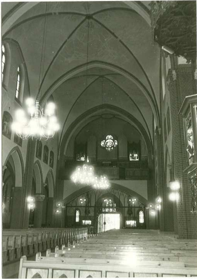
SKLEPIENIE NAWY GŁÓWNEJ.
