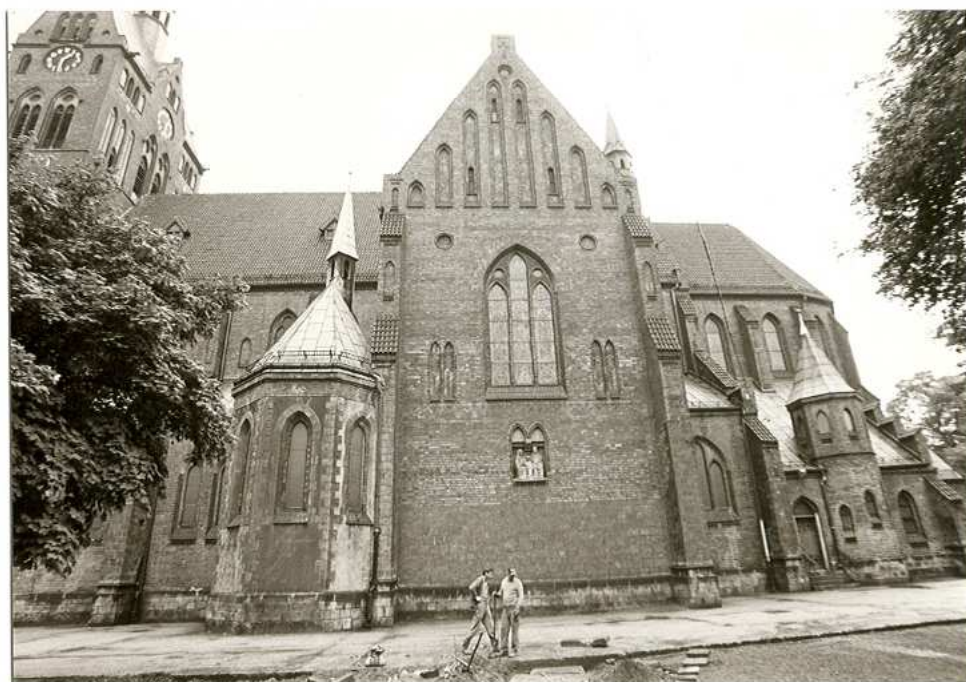
TRANSEPT OD STRONY WSCHODNIEJ.
