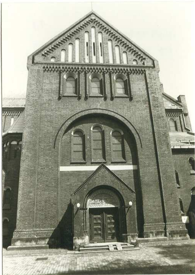
SKRZYDŁO TRANSEPTU OD STRONY ZACHODNIEJ Z PORTALEM WEJŚCIOWYM.
