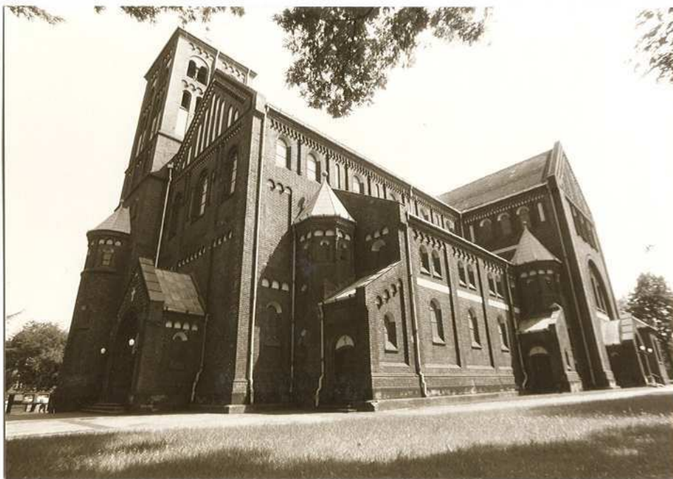
BRYŁA KOŚCIOŁA OD STRONY PÓŁNOCNO-ZACHODNIEJ.
