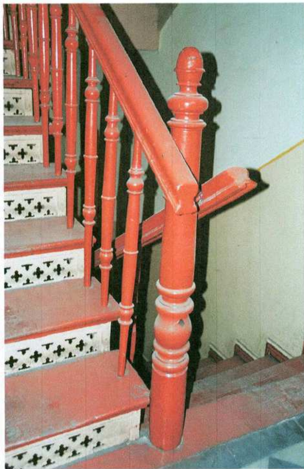
15. Budynek główny – klatka schodowa
