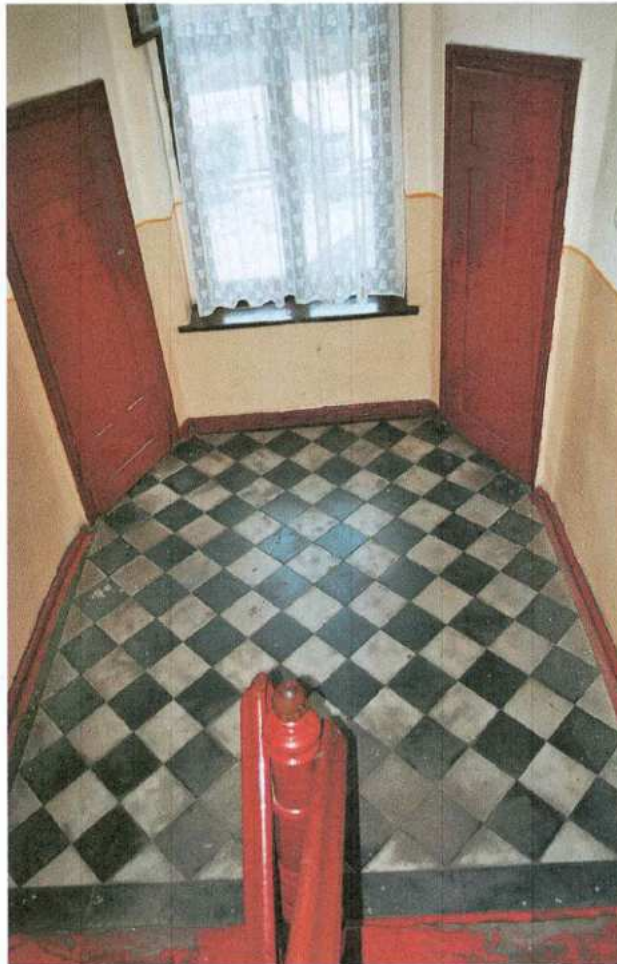
17. Budynek główny – klatka schodowa
