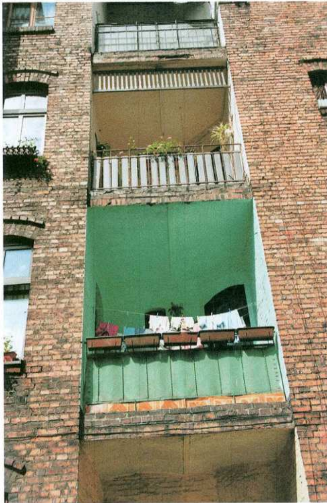
11. Elewacja tylna - balkony
