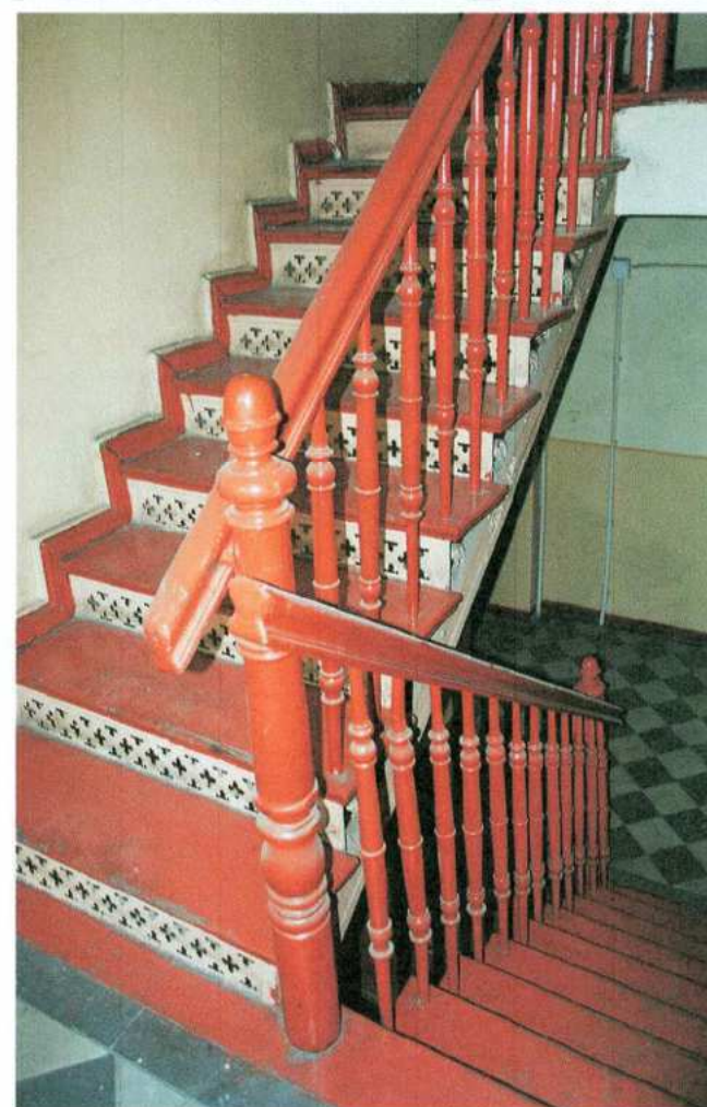
14. Budynek główny – klatka schodowa
