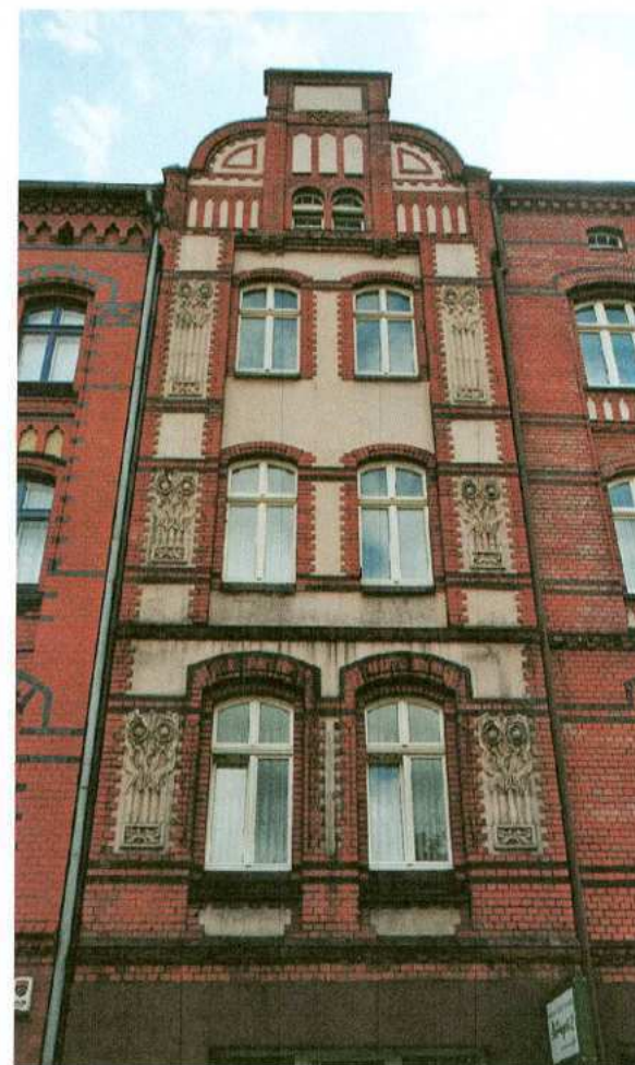
2. Elewacja frontowa – ryzalit
