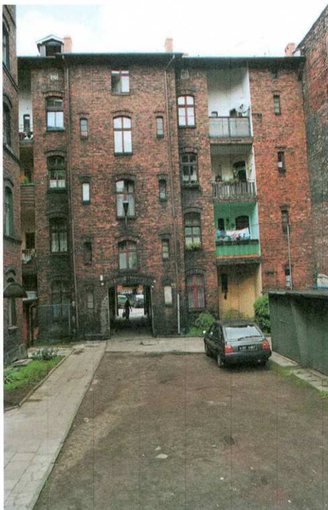
9. Budynek główny – elewacja tylna
