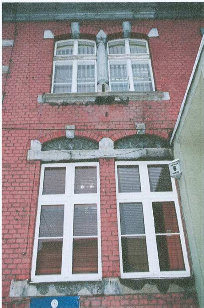
7. elewacja zachodnia - okna
