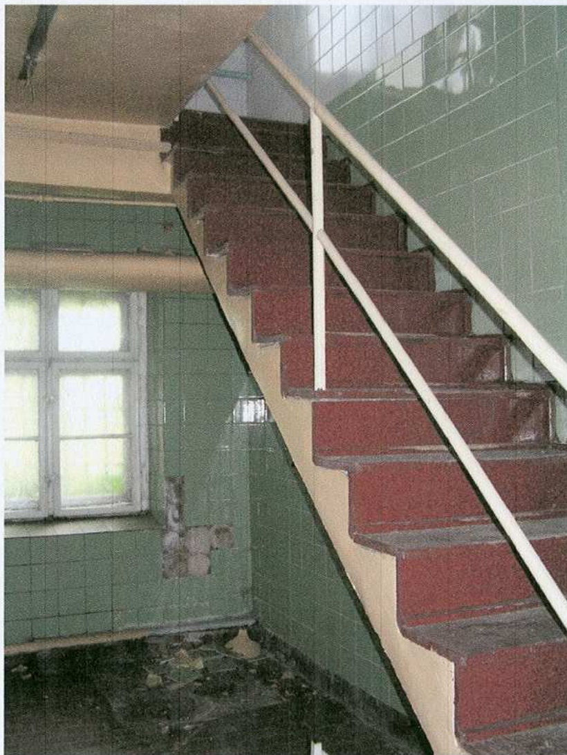
31. Schody do piwnicy
