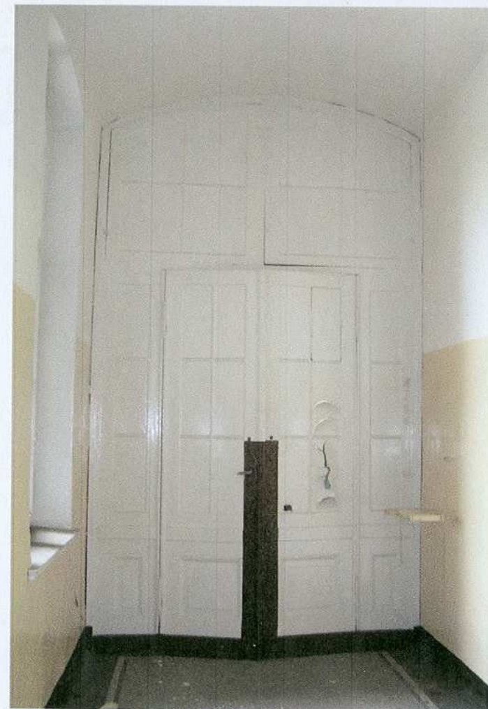
22. Drzwi wewnętrzne – I piętro
