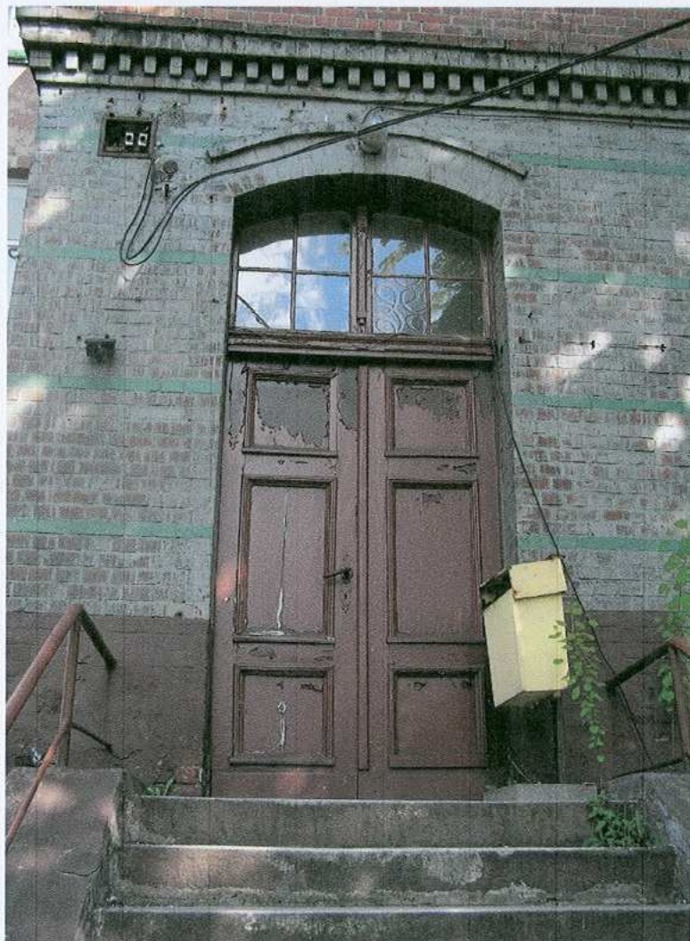
17. Drzwi zewnętrzne – elewacja zachodnia – skrzydło południowe
