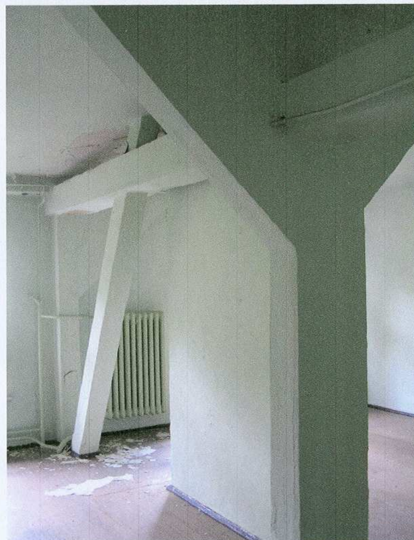
40. Pomieszczenie na 2 piętrze
