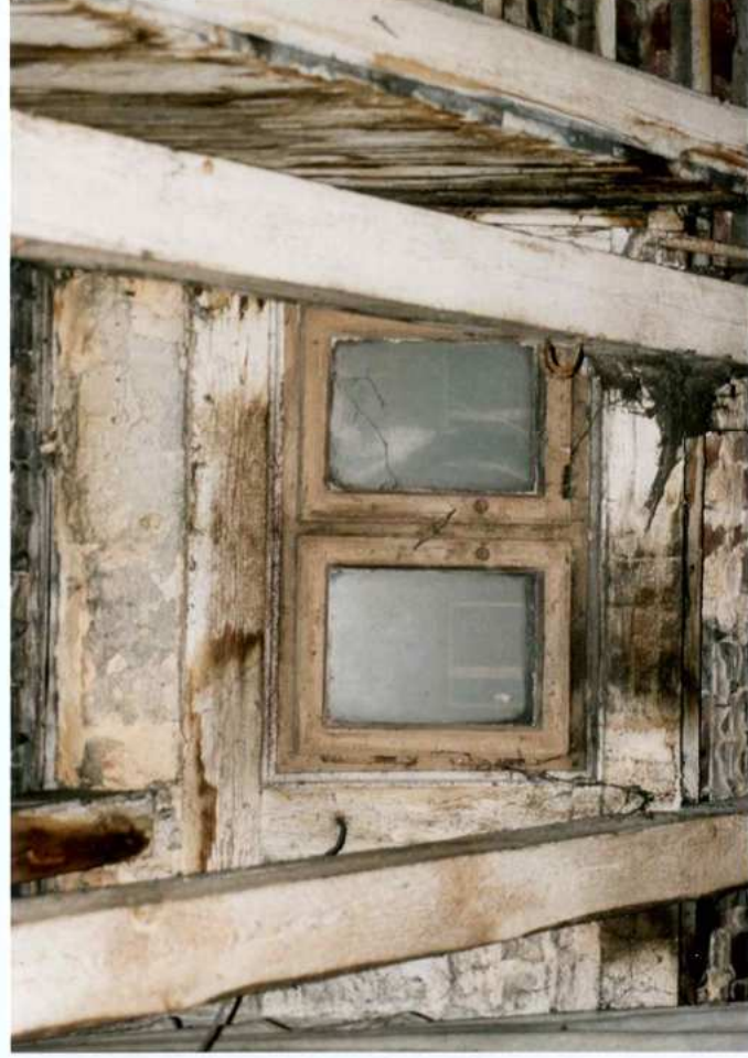
Fot. 33. Fragment więźby dachowej.
