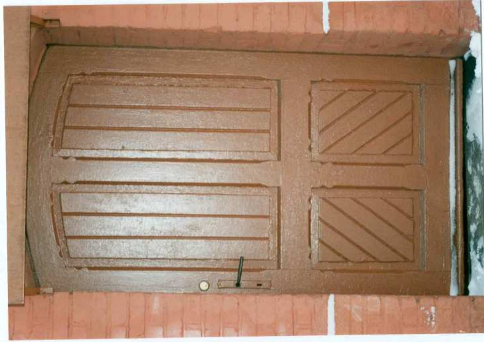
Fot. 14. Fragment elewacji wschodniej. Drzwi.
