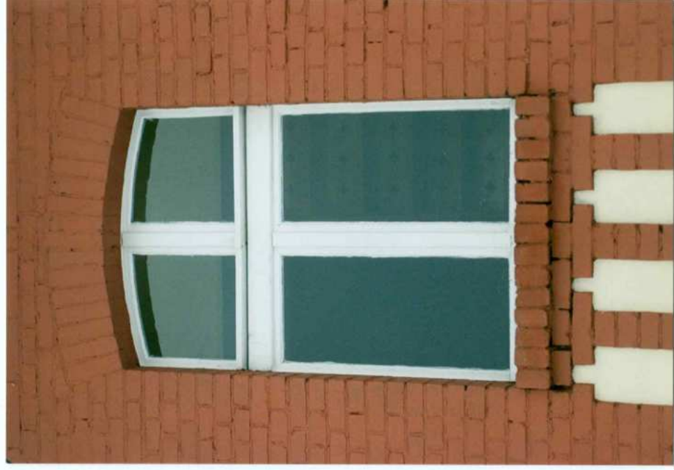
Fot. 15. Fragment elewacji wschodniej. Okno.
