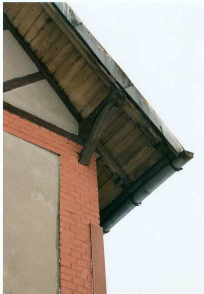
Fot. 10. Fragment elewacji północnej. Detal.
