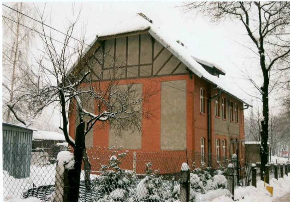
Fot. 7. Widok ogólny od północnego – zachodu.
