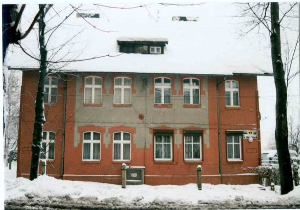
Fot. 1. Elewacja zachodnia. Widok ogólny.
