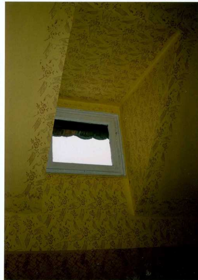
Fot. 28. Poddasze. Okno.
