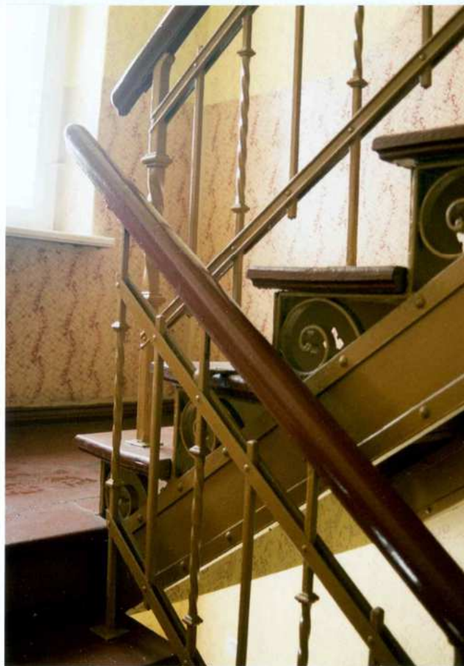
Fot. 24. Klatka schodowa. Balustrada.
