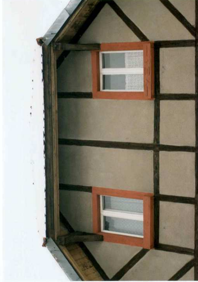
Fot. 20. Fragment elewacji południowej.
