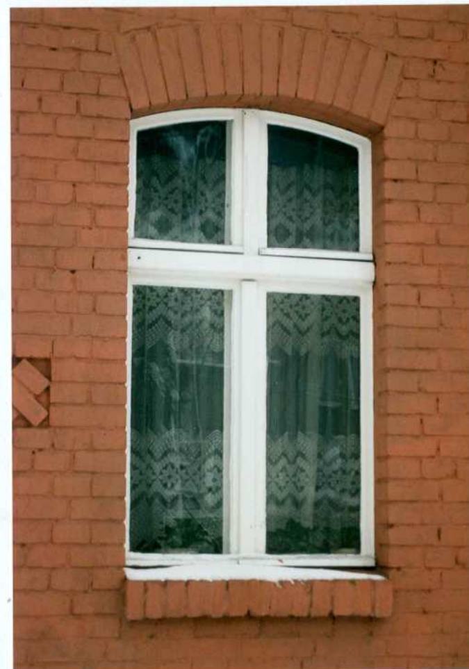
Fot.2. Fragment elewacji zachodniej. Okno.
