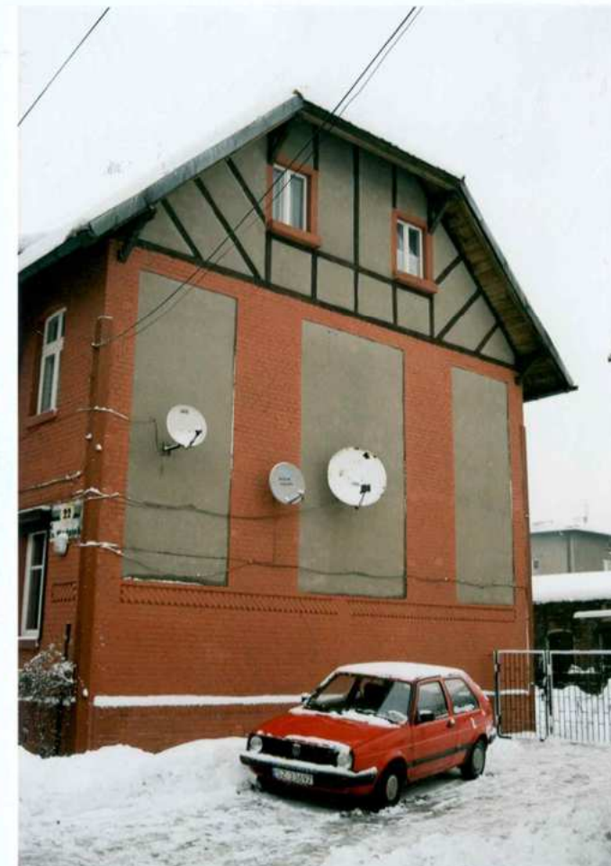
Fot. 19. Elewacja południowa.
