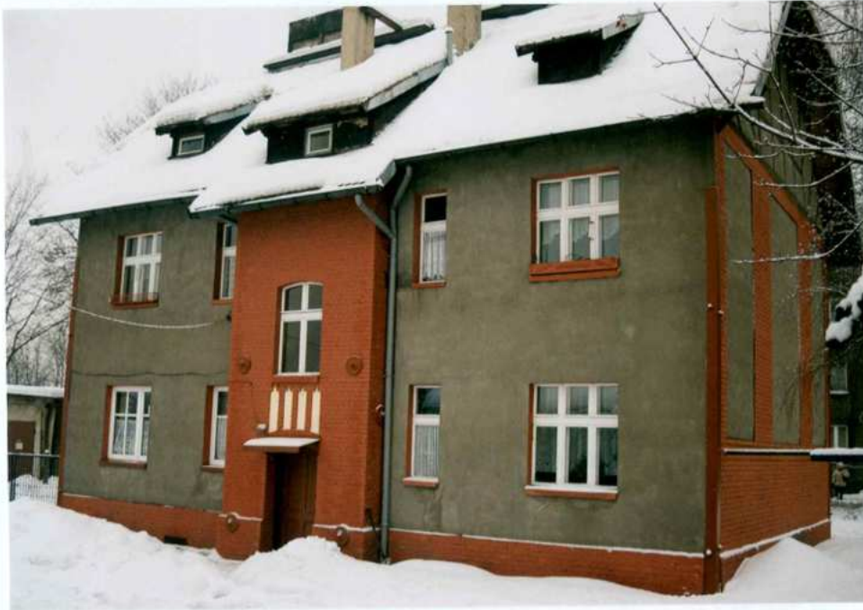
Fot. 12. Elewacja wschodnia. Widok od północnego – wschodu.
