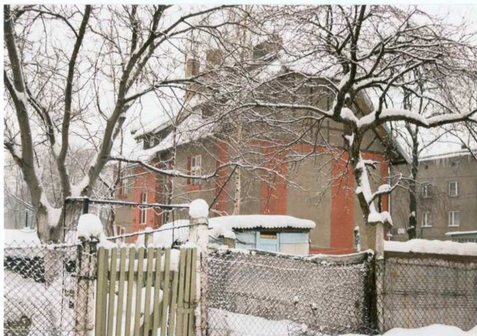
Fot. 11. Widok ogólny od północnego – wschodu.
