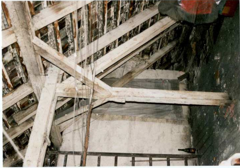
Fot. 31. Fragment więźby dachowej.
