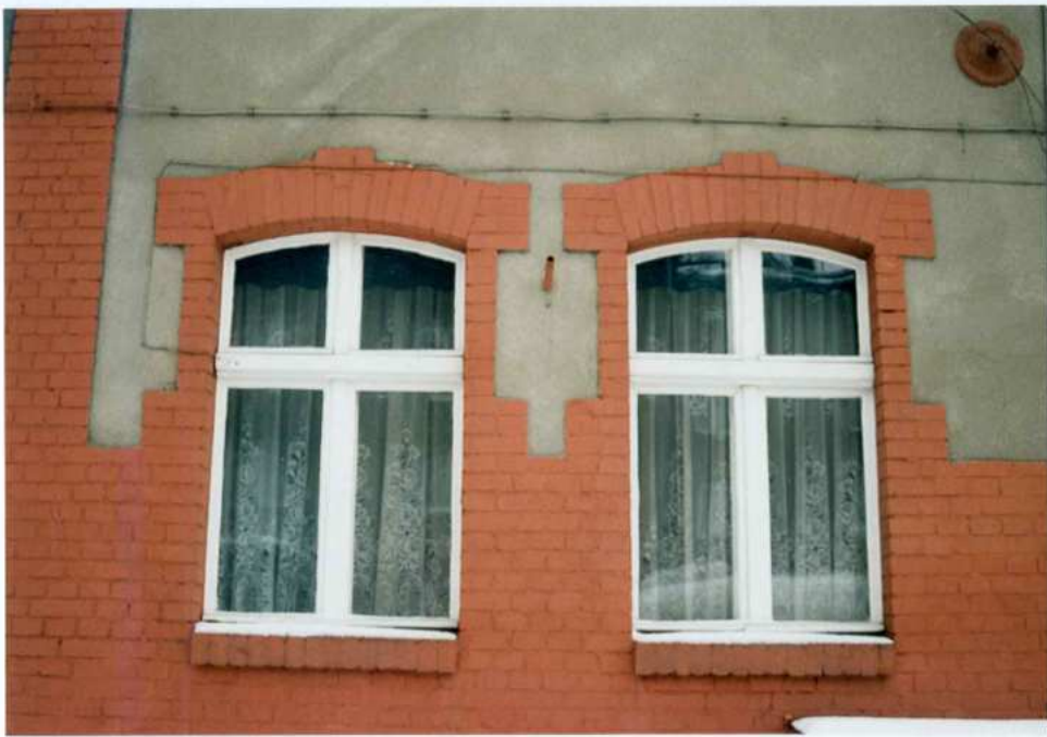
Fot. 3. Fragment elewacji zachodniej. Okna.
