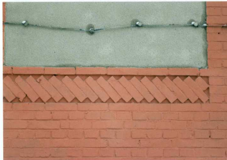
Fot. 8. Fragment elewacji północnej. Detal.
