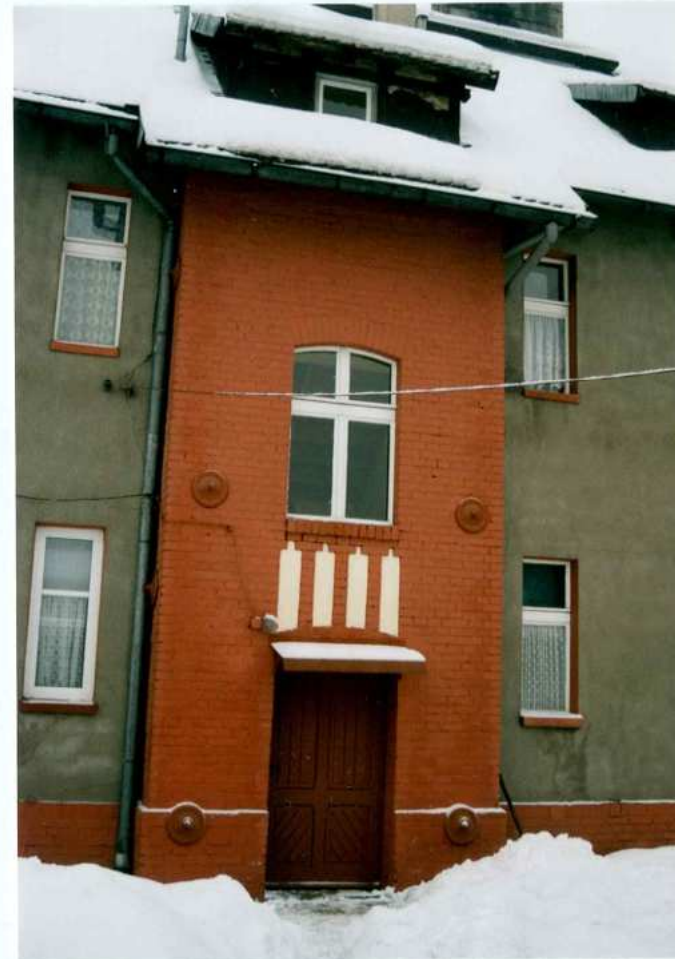
Fot. 13. Fragment elewacji wschodniej. Ryzalit.
