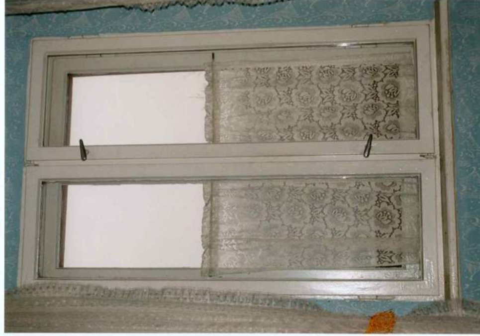
Fot. 21. Poddasze. Okno.
