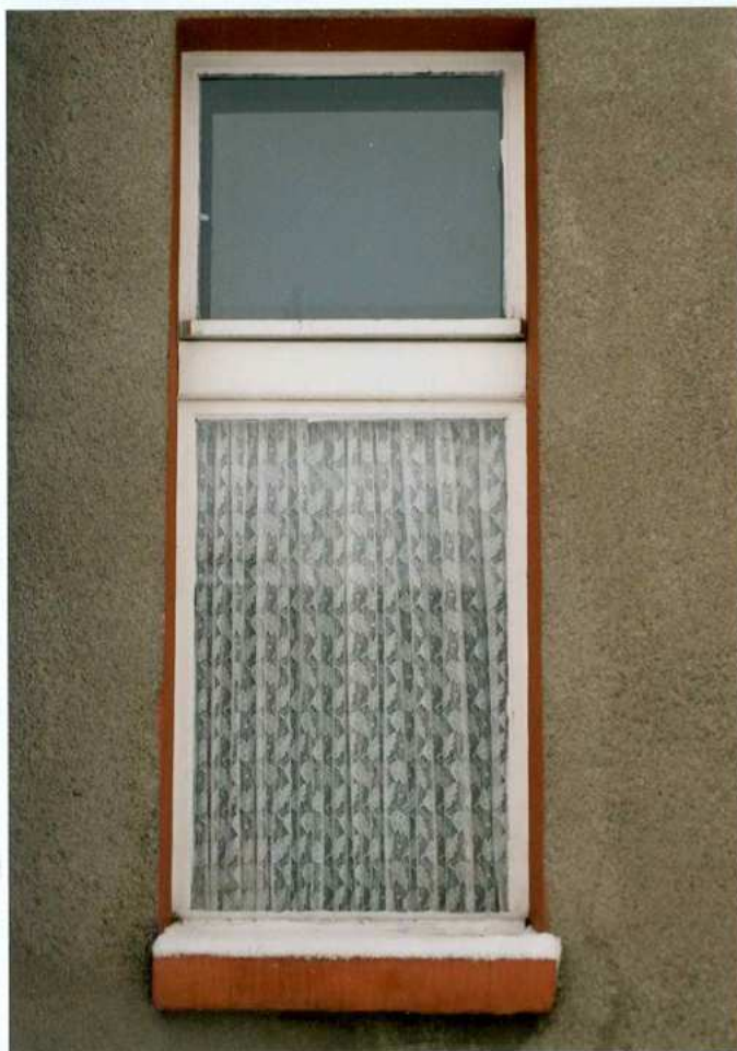
Fot. 17. Fragment elewacji wschodniej. Okno.
