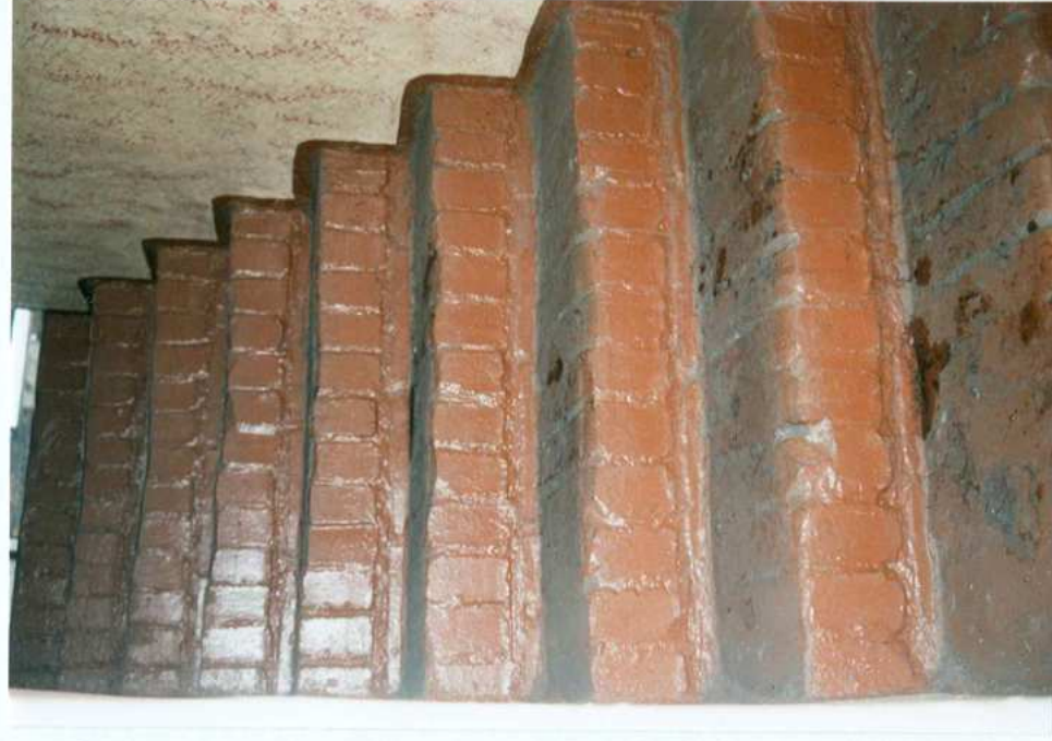
Fot. 22. Piwnica. Schody.
