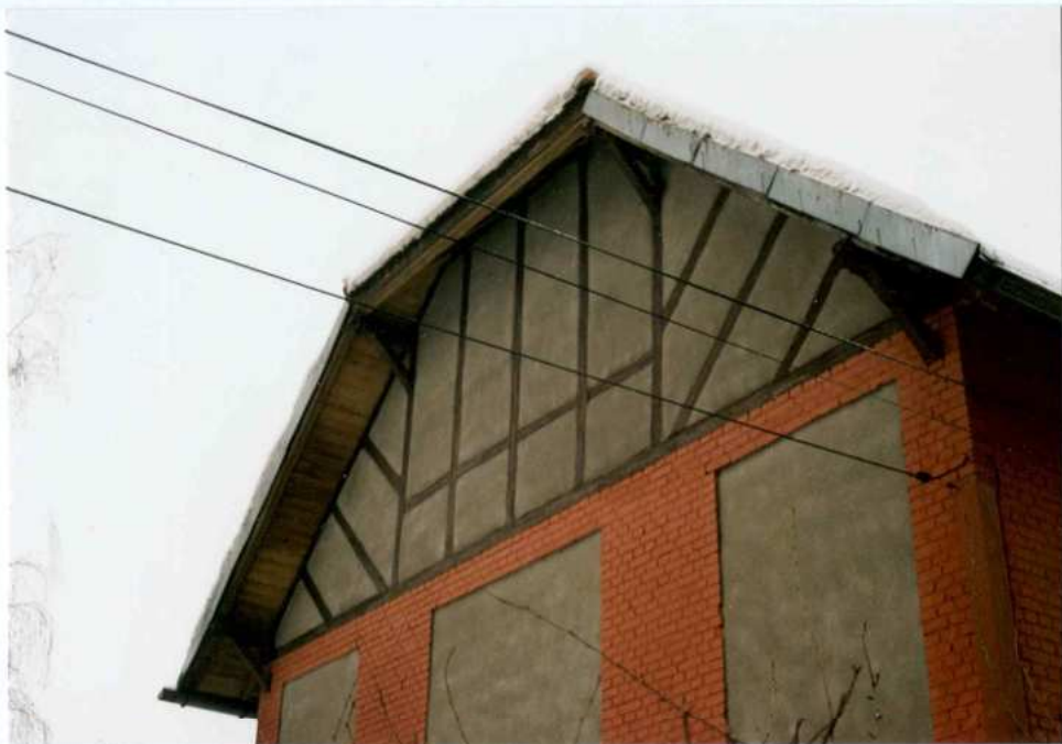
Fot. 9. Fragment elewacji północnej. Detal.
