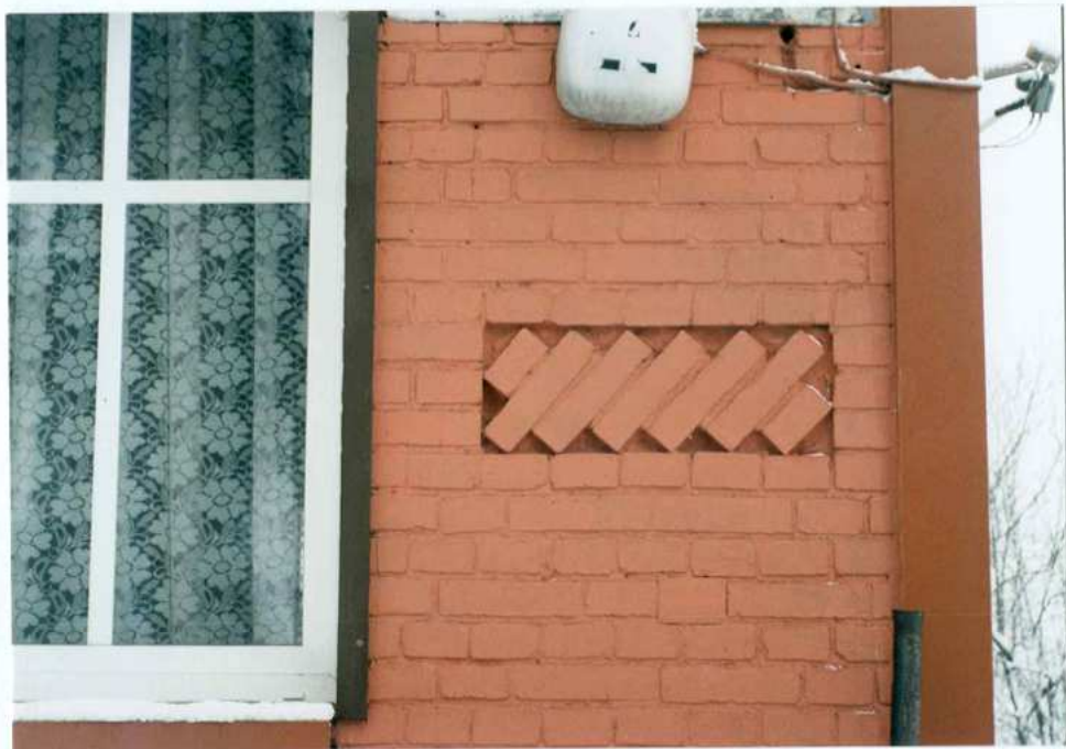
Fot.4. Fragment elewacji zachodniej. Detal.
