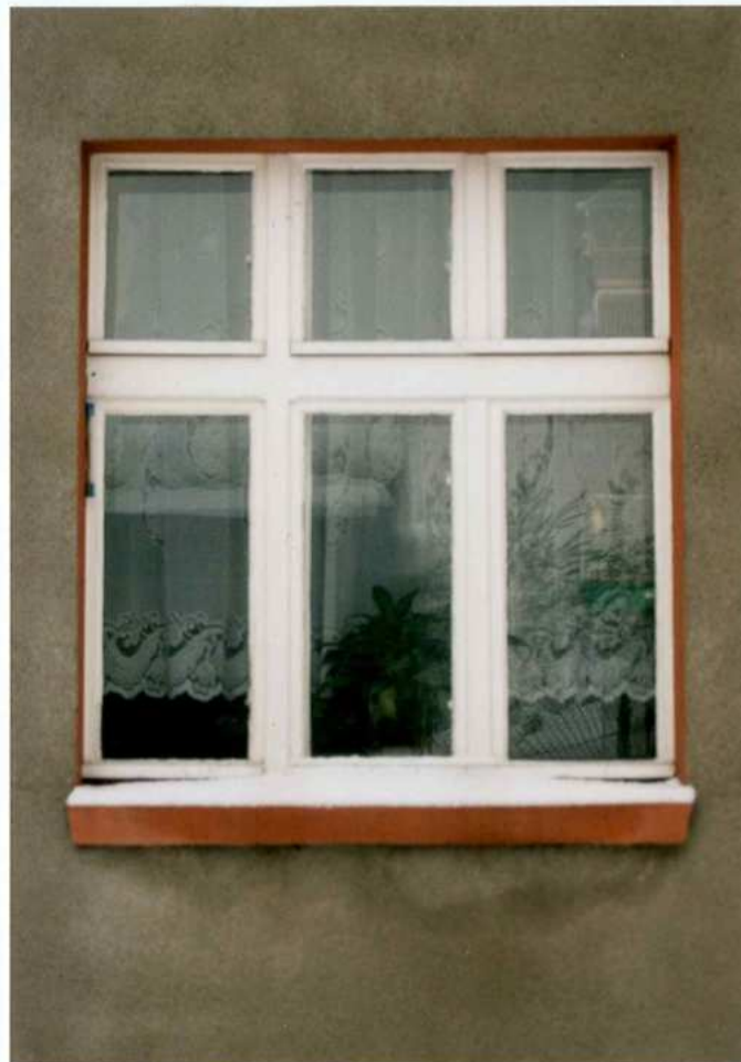
Fot. 18. Fragment elewacji wschodniej. Okno.
