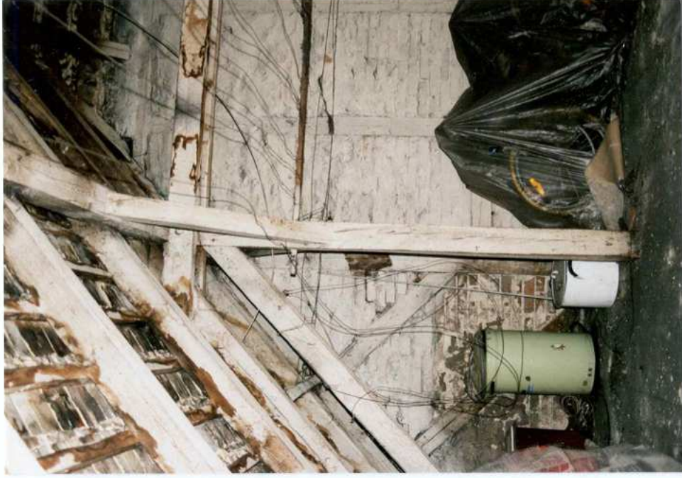
Fot. 32. Fragment więźby dachowej.
