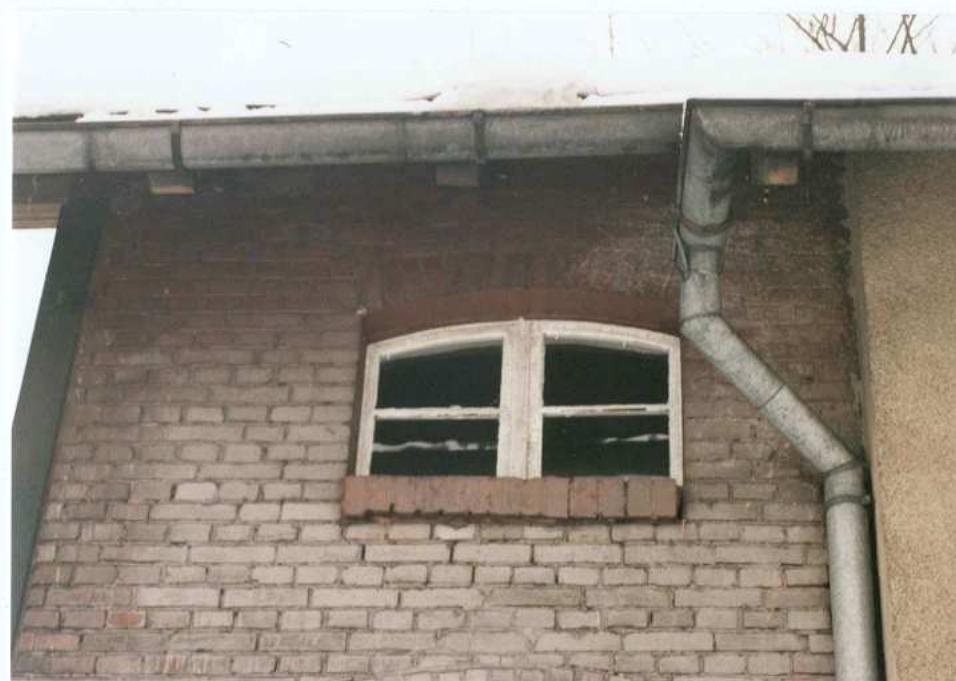
Fot. 13. Fragment elewacji wschodniej. Okno.
