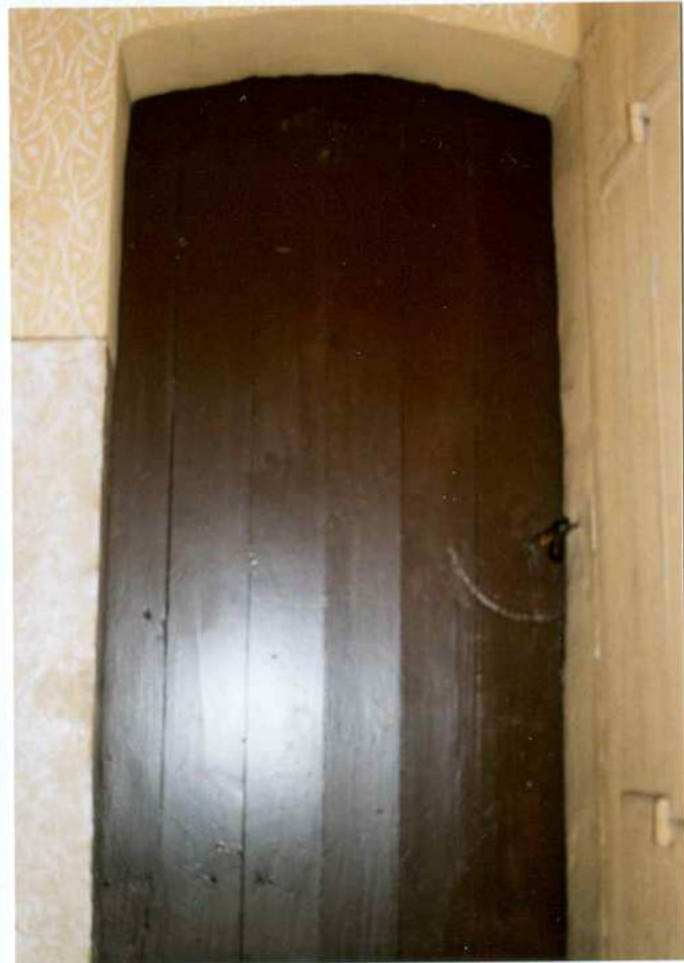
Fot. 27. Strych. Drzwi.
