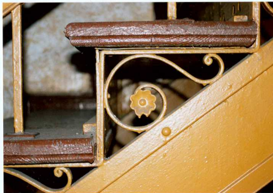
Fot. 24. Klatka schodowa. Schody – detal.
