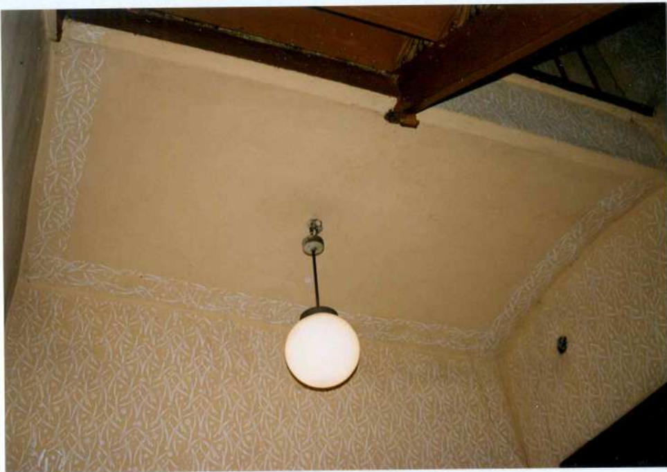
Fot. 25. Klatka schodowa. Strop.
