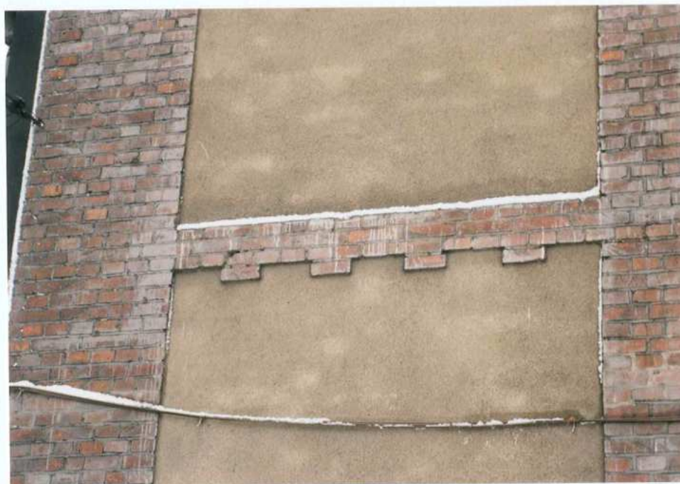
Fot. 19. Fragment elewacji południowej. Detal.
