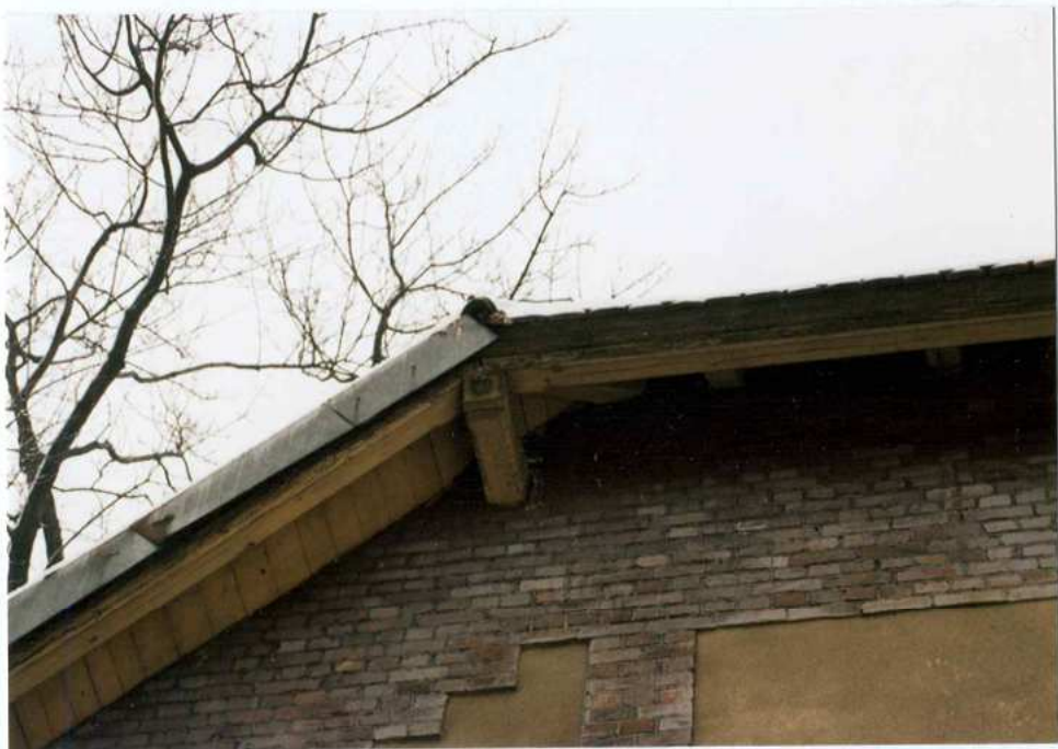
Fot. 21. Fragment elewacji południowej. Detal.
