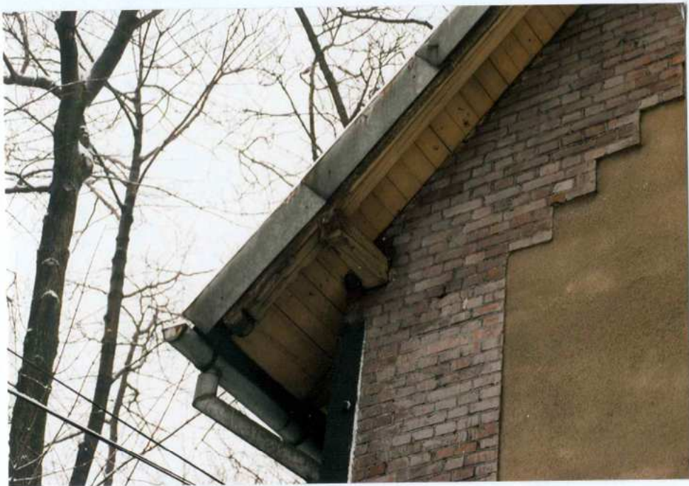
Fot. 20. Fragment elewacji południowej. Detal.
