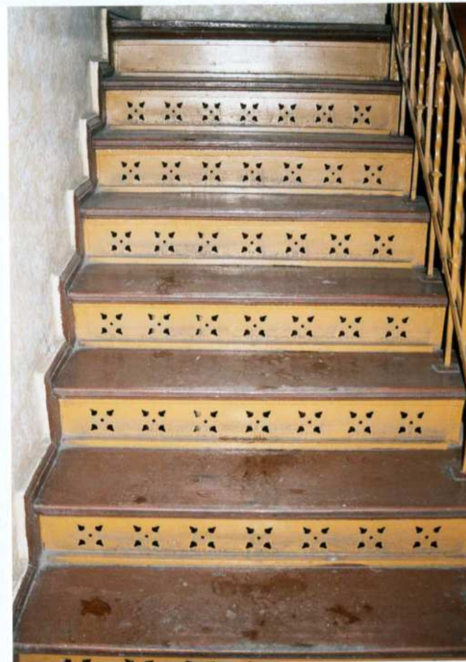
Fot. 22. Klatka schodowa. Schody.
