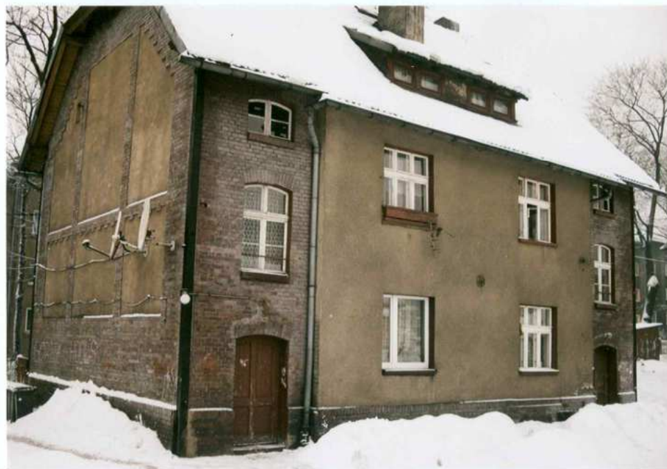
Fot. 7. Elewacja wschodnia. Widok od południowego – wschodu.
