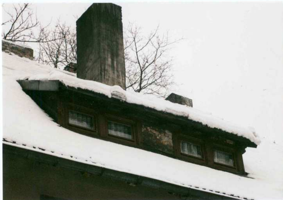
Fot. 15. Fragment elewacji wschodniej. Facjata.
