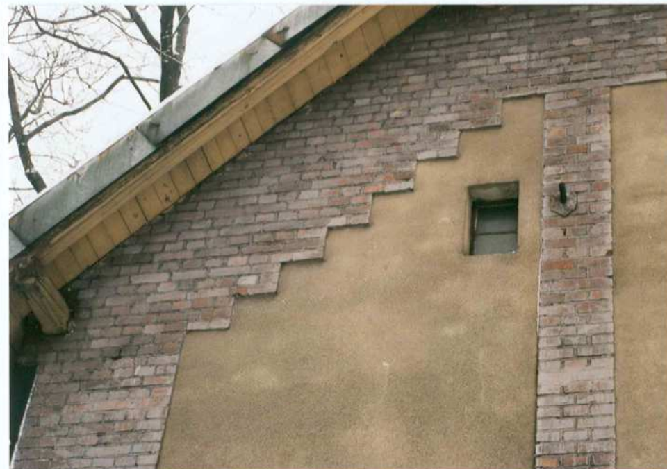
Fot. 17. Fragment elewacji południowej. Okno.
