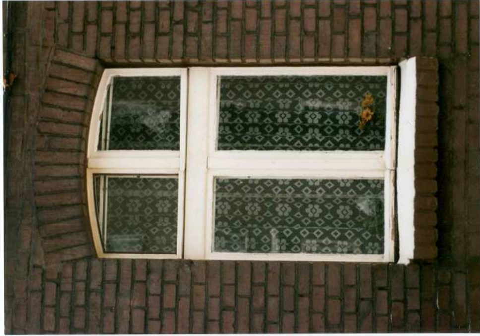
Fot. 3. Fragment elewacji zachodniej. Okno.
