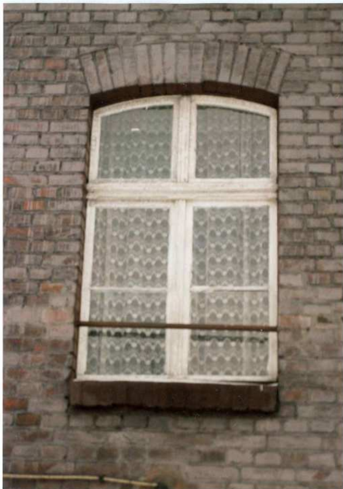
Fot. 12. Fragment elewacji wschodniej. Okno.
