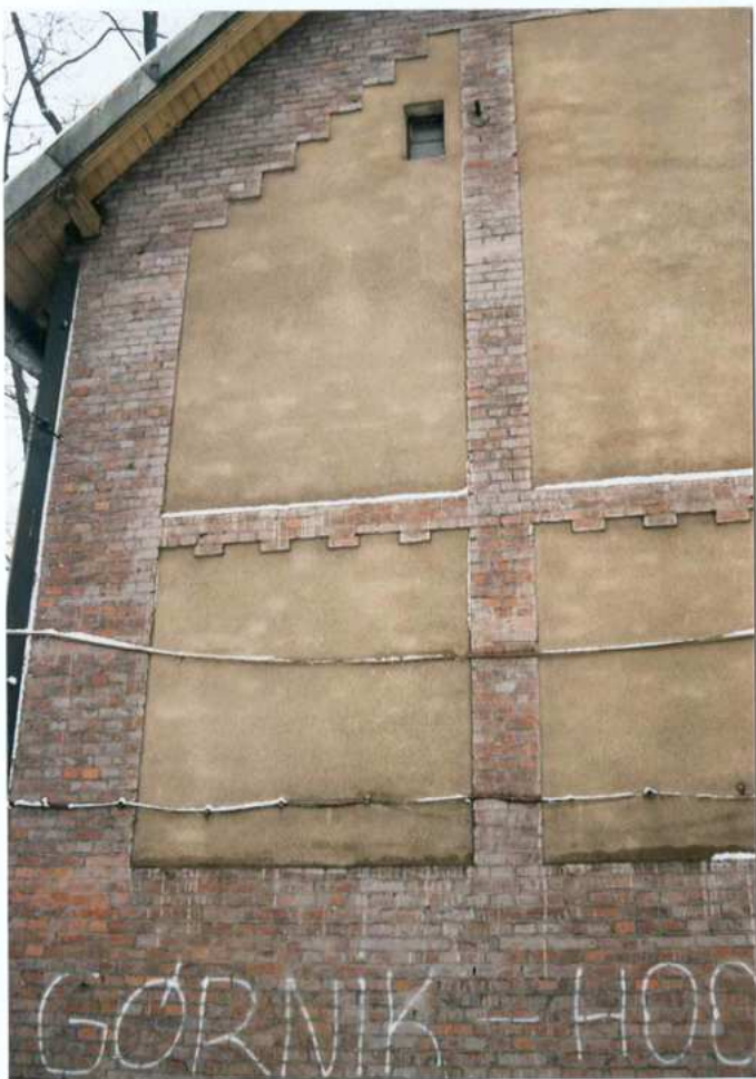
Fot. 18. Fragment elewacji południowej.
