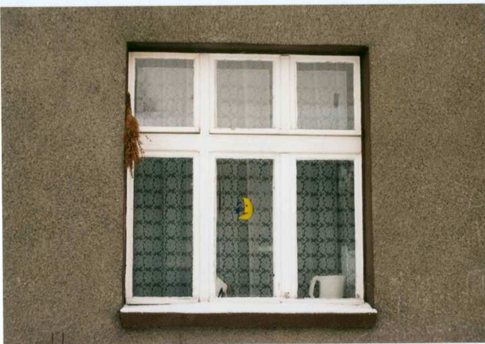
Fot. 14. Fragment elewacji wschodniej. Okno.
