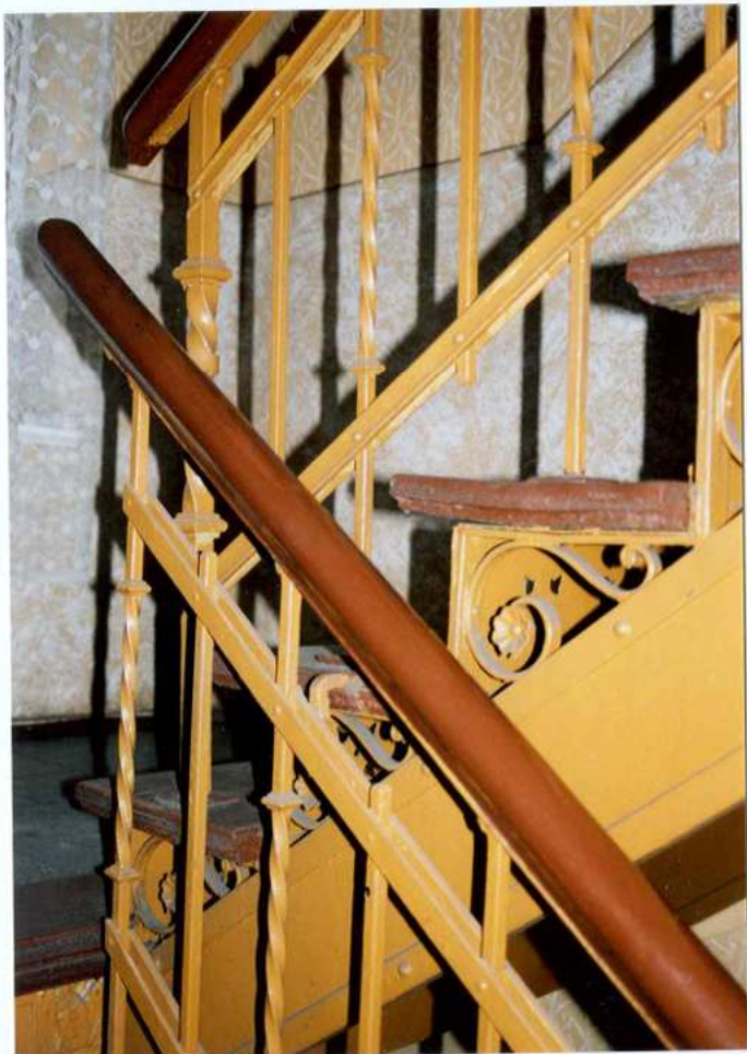
Fot. 23. Klatka schodowa. Schody, balustrada.
