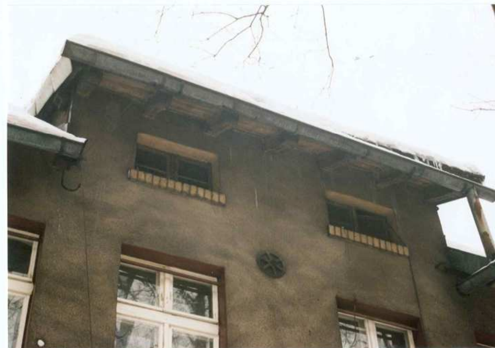
Fot. 2. Fragment elewacji zachodniej. Poddasze.
