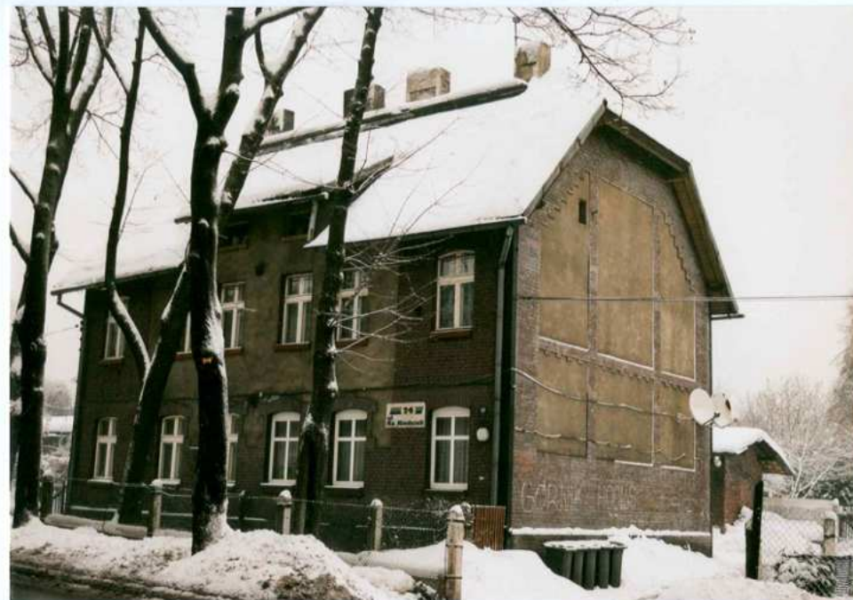
Fot. 16. Elewacja południowa. Widok od południowego – zachodu.
