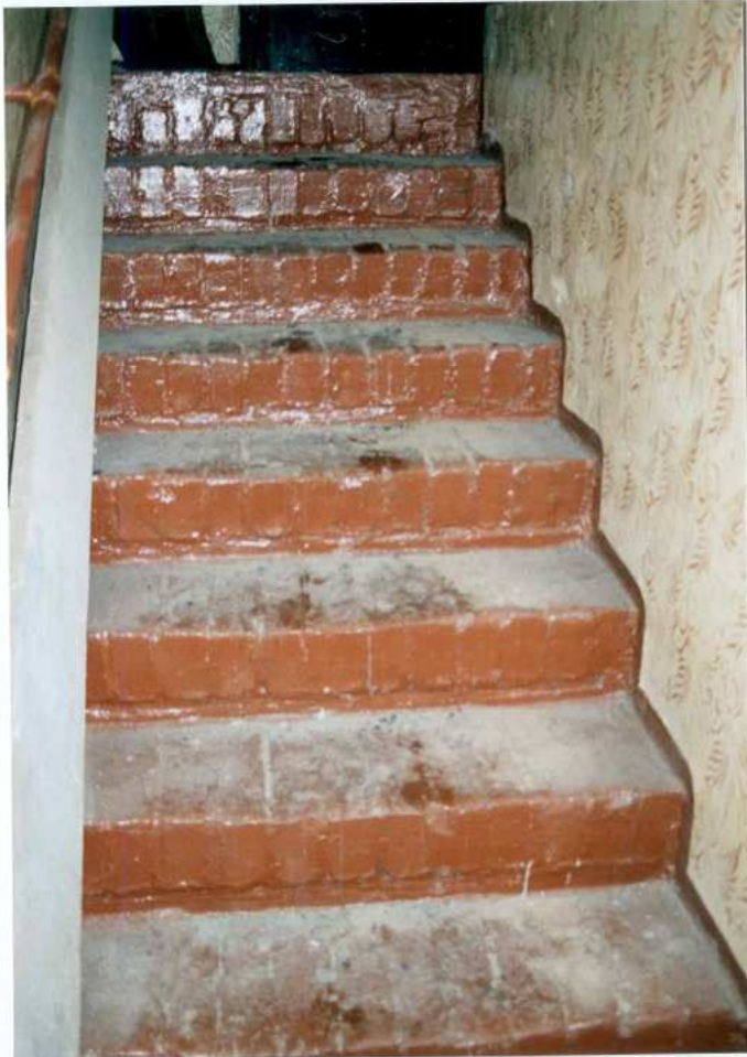
Fot. 17. Piwnica. Schody.
