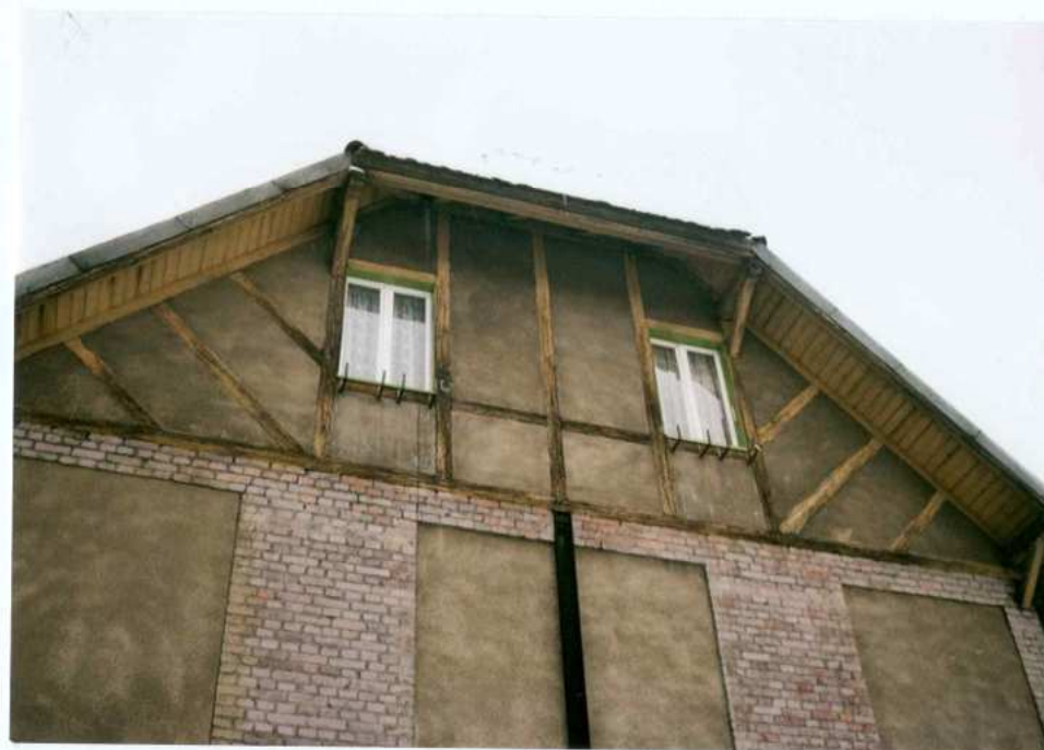
Fot. 13. Fragment elewacji południowej.
