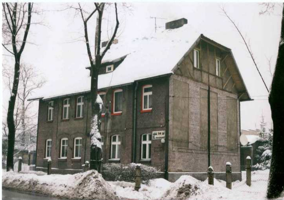
Fot. 12. Elewacja południowa. Widok od południowego – zachodu.
