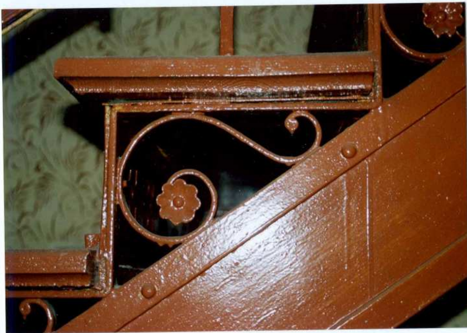
Fot. 20. Klatka schodowa. Detal.
