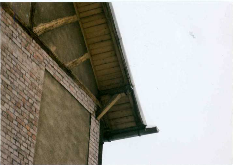
Fot. 15. Fragment elewacji południowej. Detal.
