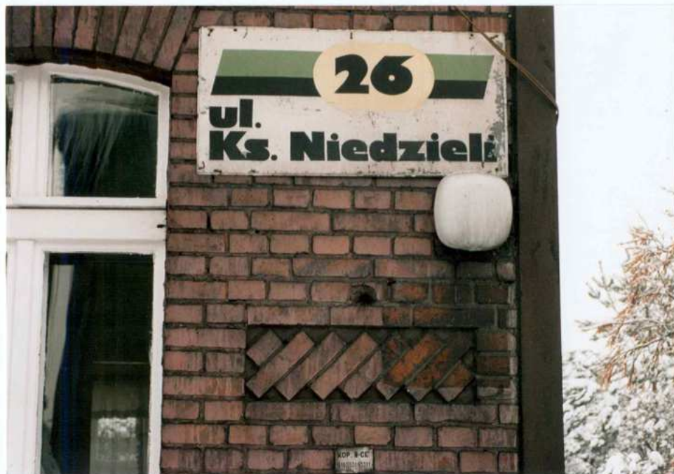
Fot. 4. Fragment elewacji zachodniej. Detal.
