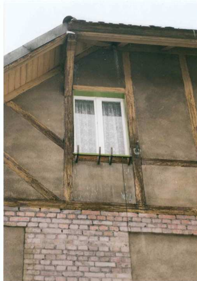
Fot. 16. Fragment elewacji południowej. Okno.
