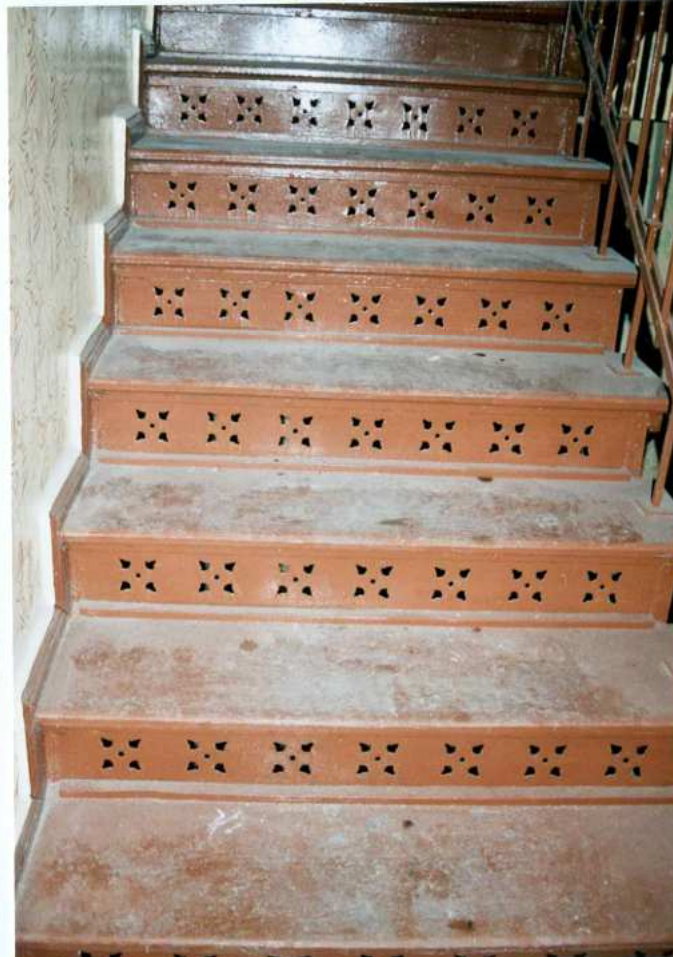
Fot. 18. Klatka schodowa. Schody.
