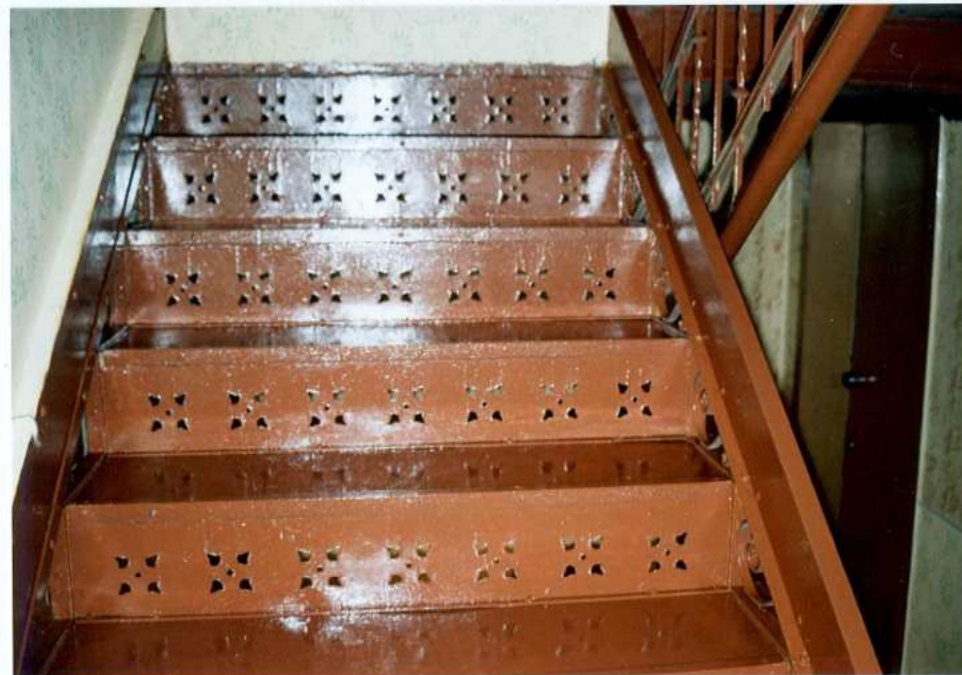
Fot. 21. Klatka schodowa. Detal.
