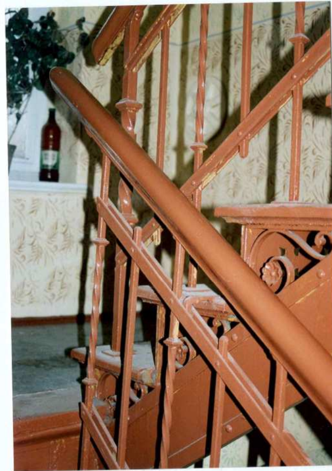
Fot. 22. Klatka schodowa. Detal.
