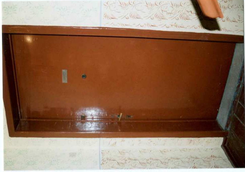
Fot. 27. Klatka schodowa. Drzwi.
