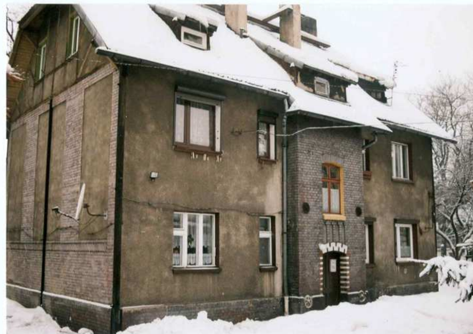
Fot. 7. Elewacja wschodnia. Widok od południowego – wschodu.
