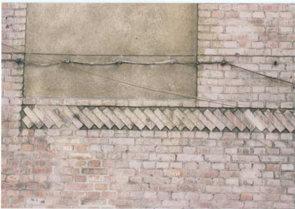
Fot. 14. Fragment elewacji południowej. Detal.
