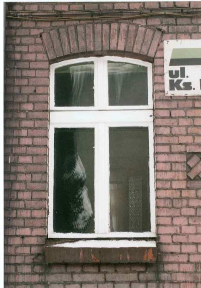
Fot. 5. Fragment elewacji zachodniej. Okno.
