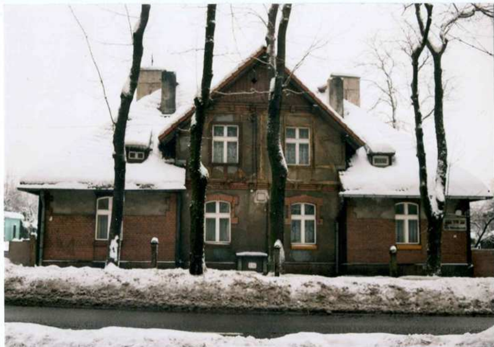
Fot. 1. Elewacja zachodnia.
