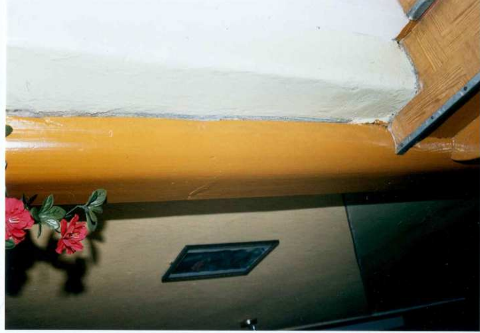
Fot. 28. Schody. Detal.
