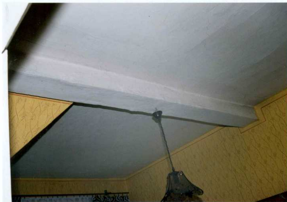
Fot. 36. Poddasze. Strop.
