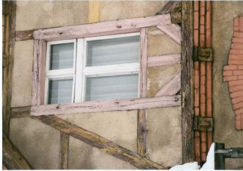
Fot. 20. Fragment elewacji wschodniej. Faciata - okno.
