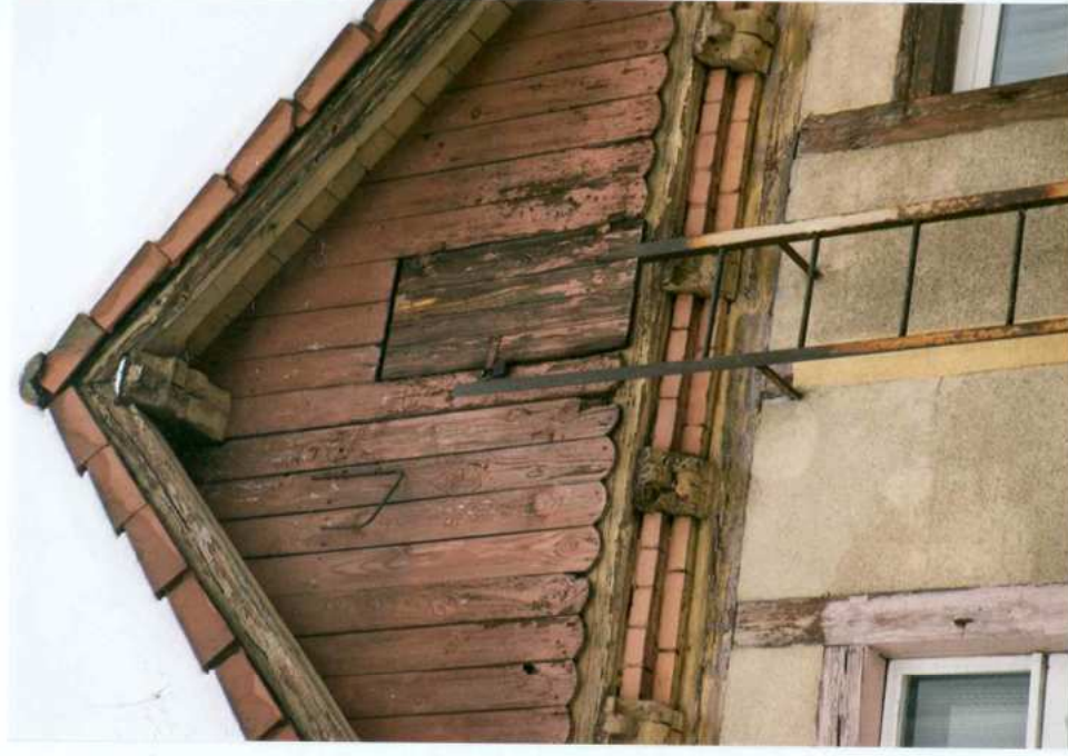
Fot. 21. Fragment elewacji wschodniej. Detal.
