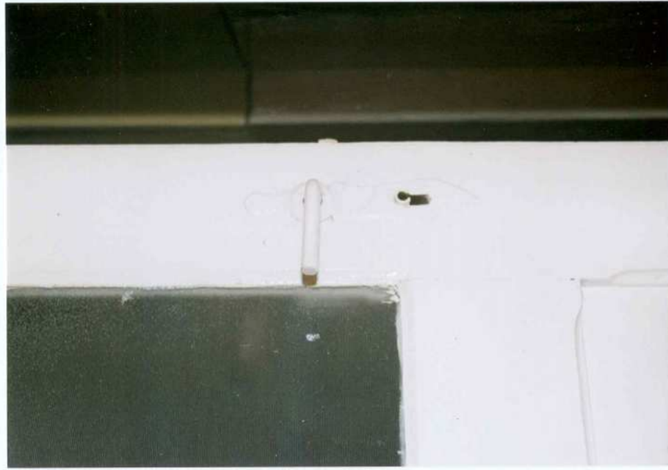
Fot. 32. Drzwi. Detal.
