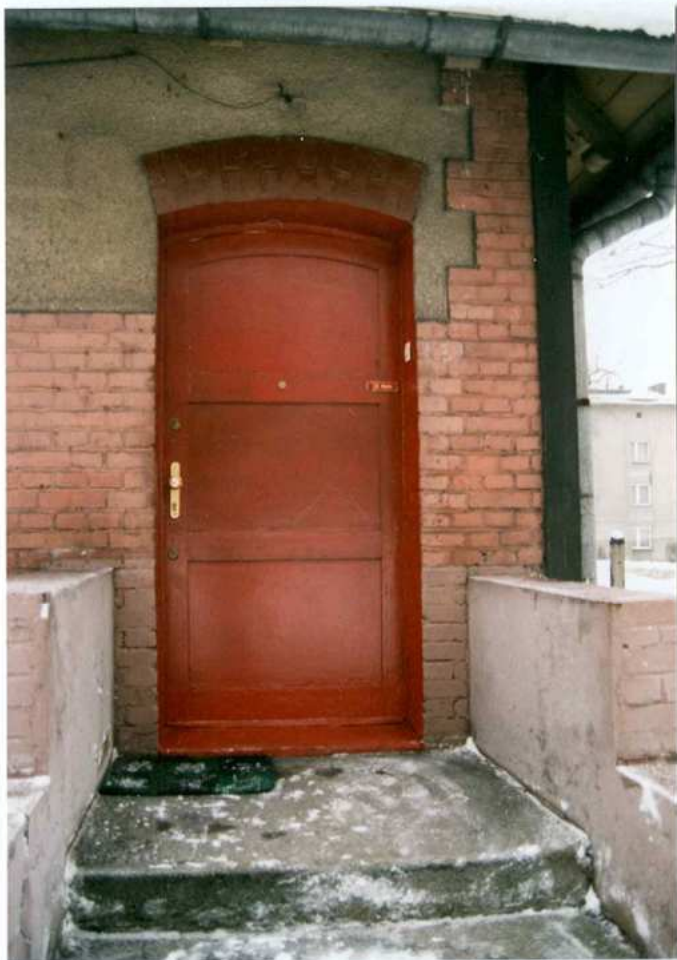
Fot. 14. Fragment elewacji północnej. Drzwi.
