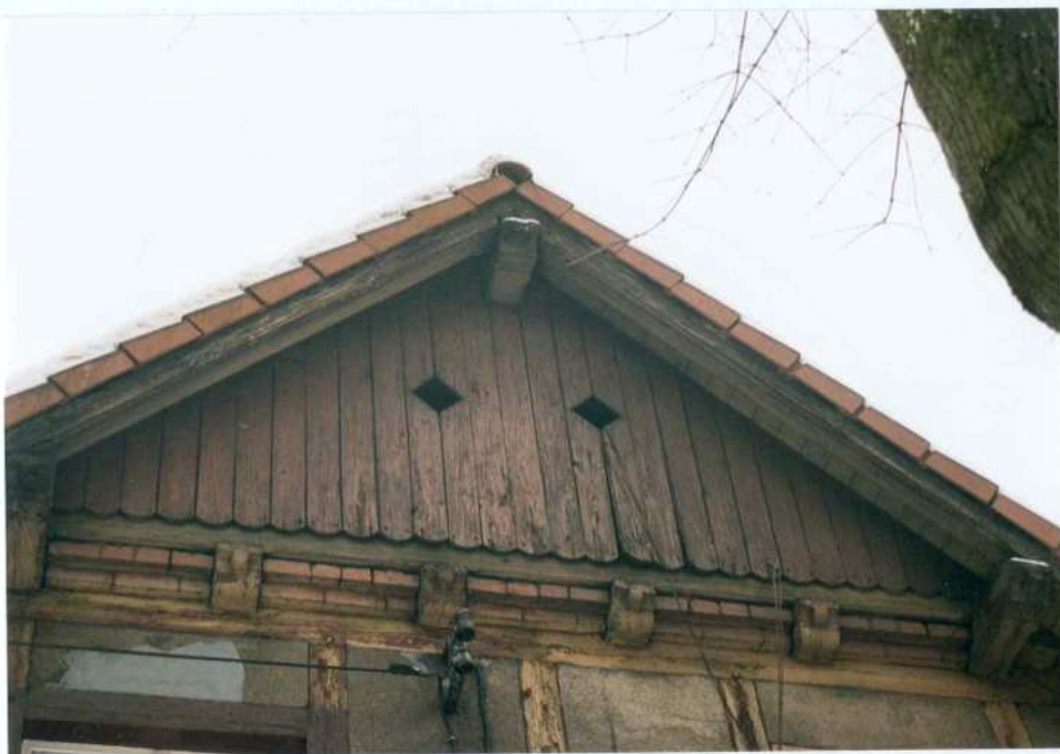
Fot. 9. Fragment elewacji zachodniej. Facjata – detal.
