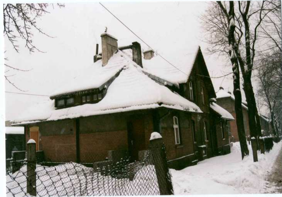
Fot. 13. Elewacja północna. Widok od północnego – zachodu.
