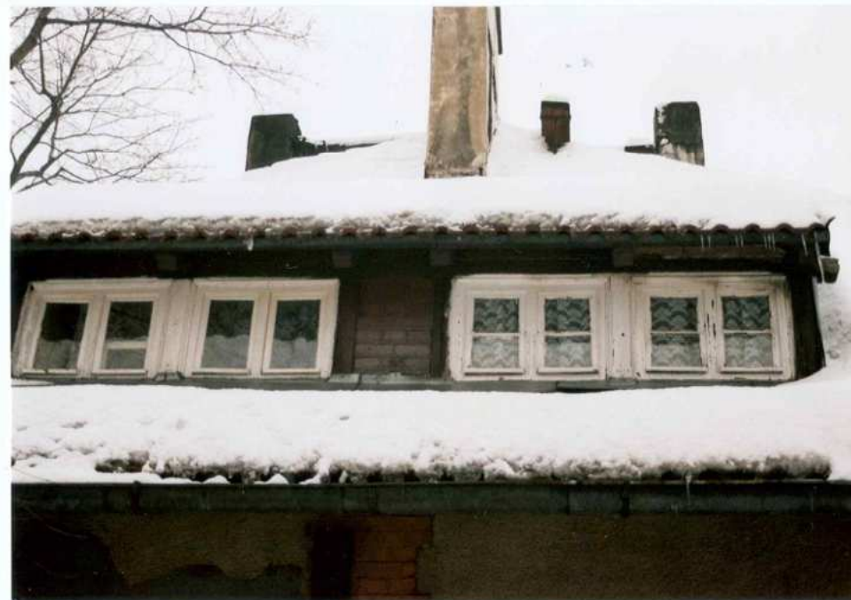
Fot. 24. Fragment elewacji południowej. Facjata.
