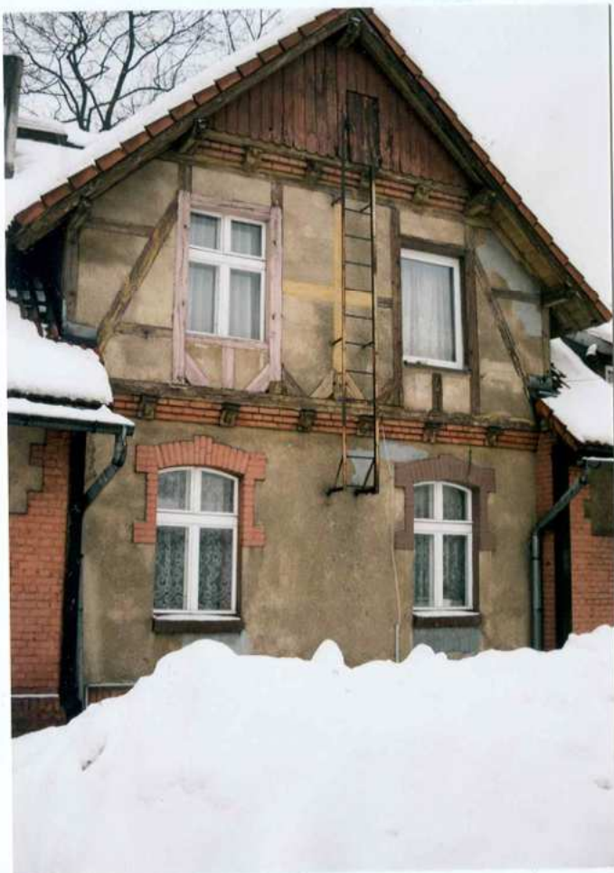
Fot. 17. Fragment elewacji wschodniej.
