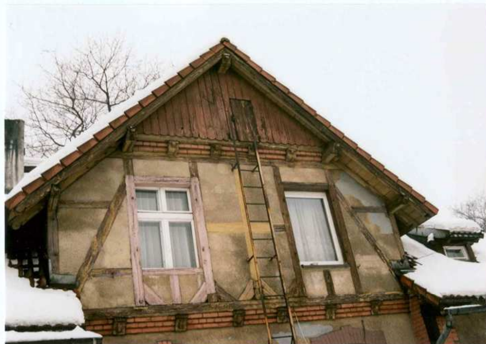
Fot. 16. Fragment elewacji wschodniej. Facjata.
