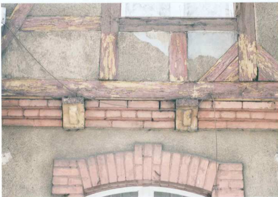
Fot. 10. Fragment elewacji zachodniej. Detal.
