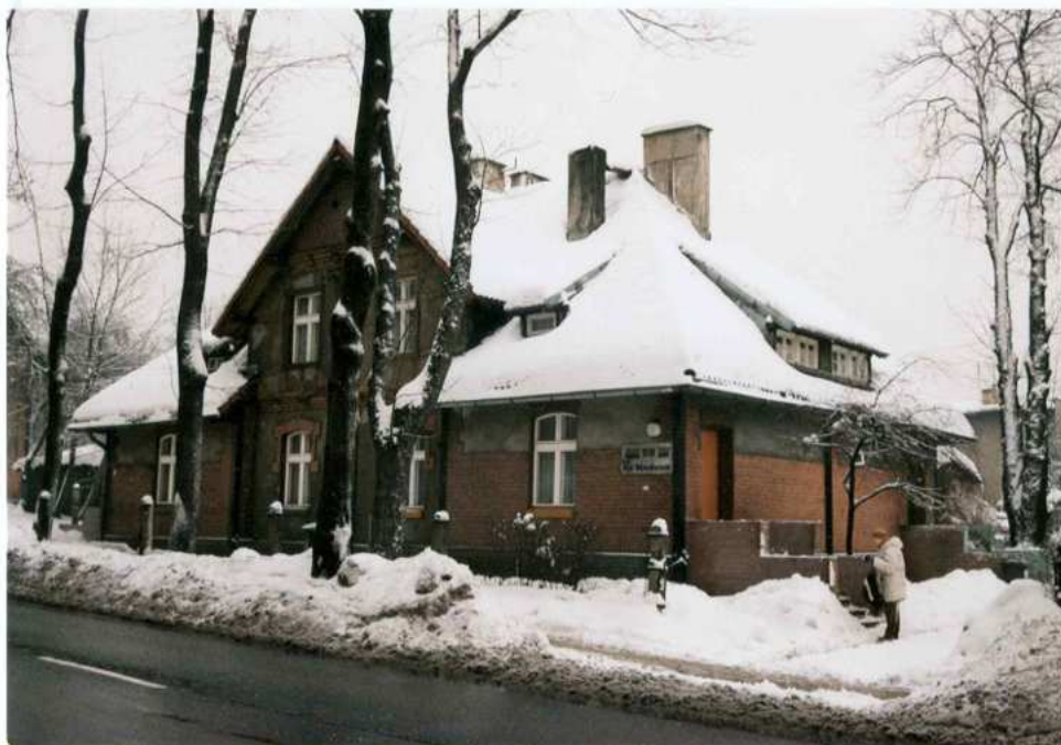
Fot. 23. Elewacja południowa. Widok ogólny od południowego zachodu.
