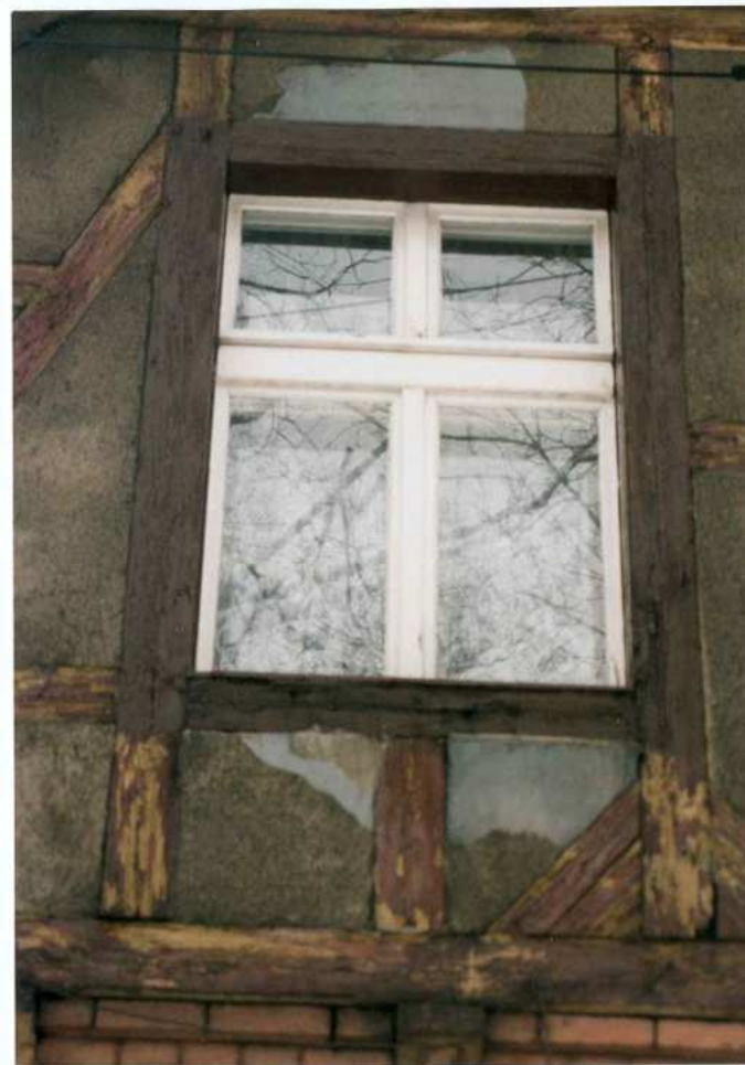
Fot. 11. Fragment elewacji zachodniej. Facjata – okno.
