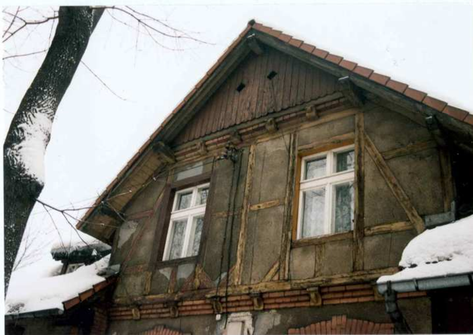
Fot. 7. Fragment elewacji zachodniej. Facjata.
