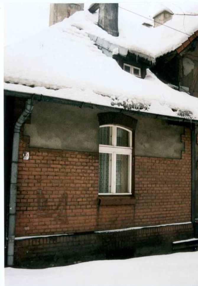
Fot. 2. Fragment elewacji zachodniej.
