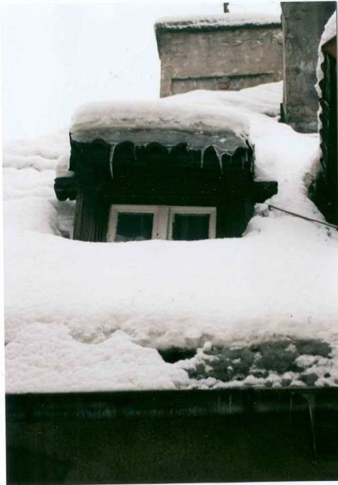
Fot. 12. Fragment elewacji zachodniej. Facjata.
