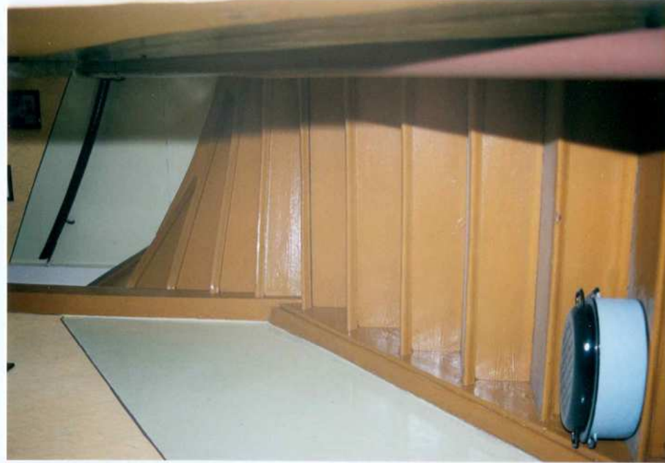
Fot. 27. Schody. Widok ogólny.
