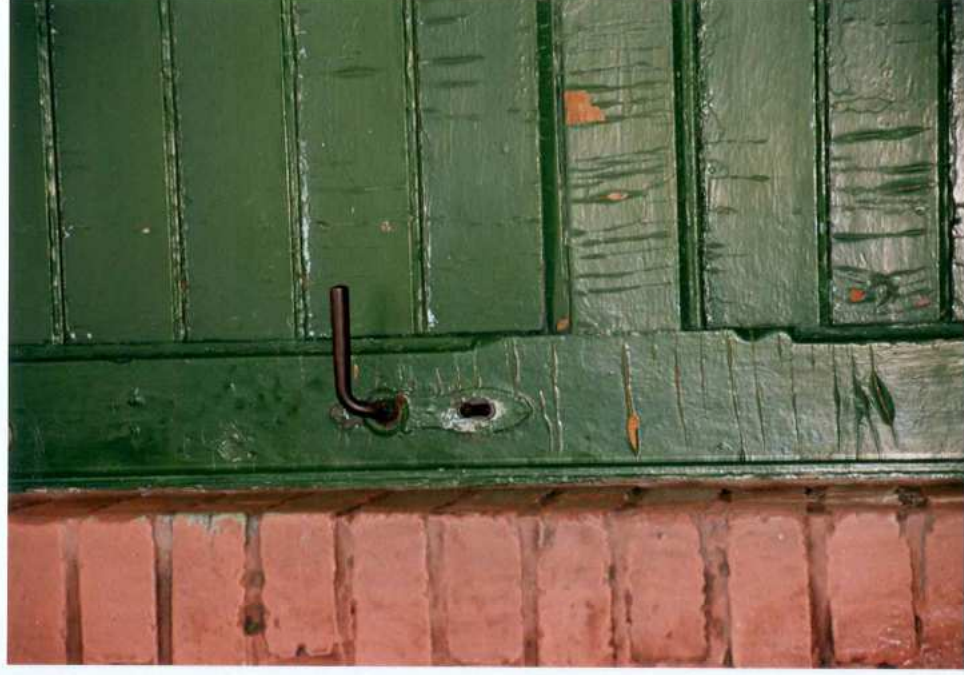
Fot. 26. Fragment elewacji południowej. Detal.
