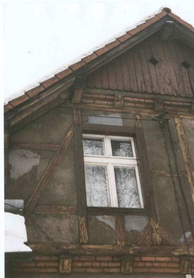
Fot. 8. Fragment elewacji zachodniej. Detal.
