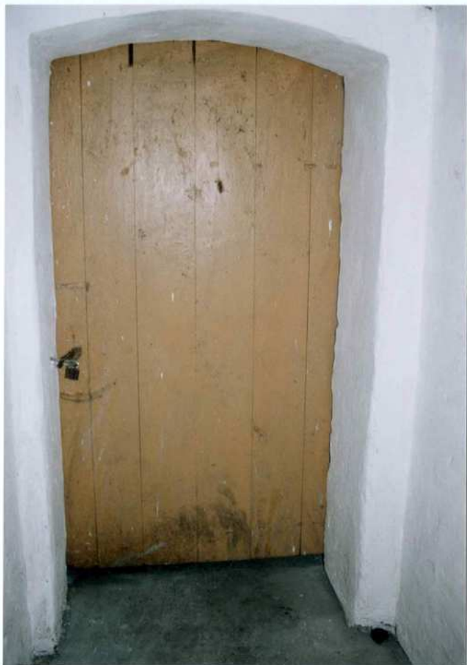
Fot. 23. Piwnica. Drzwi.
