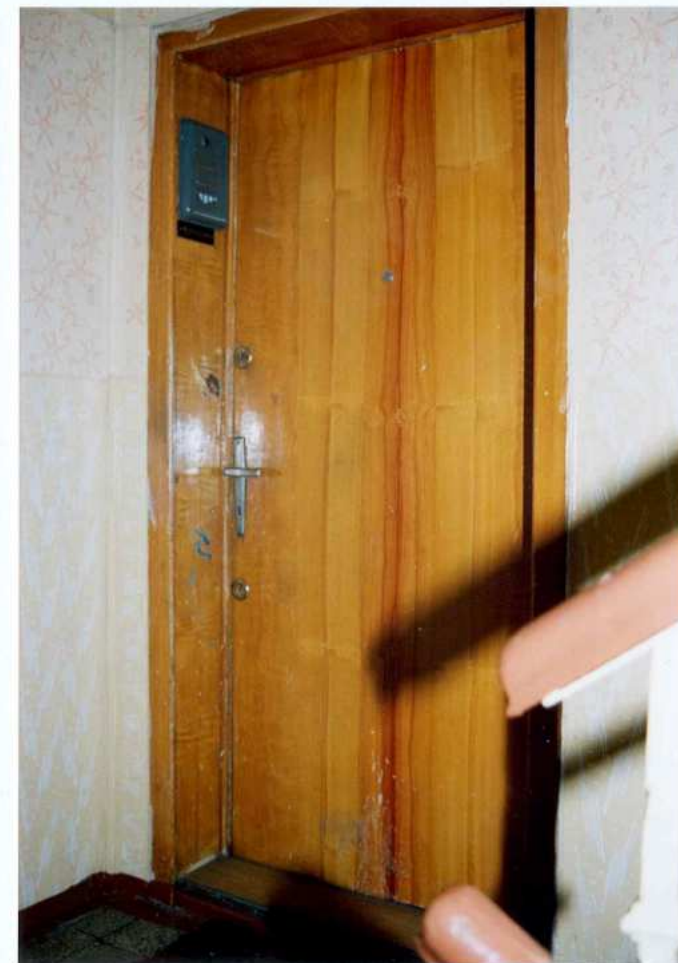
Fot. 25. Klatka schodowa. Drzwi.
