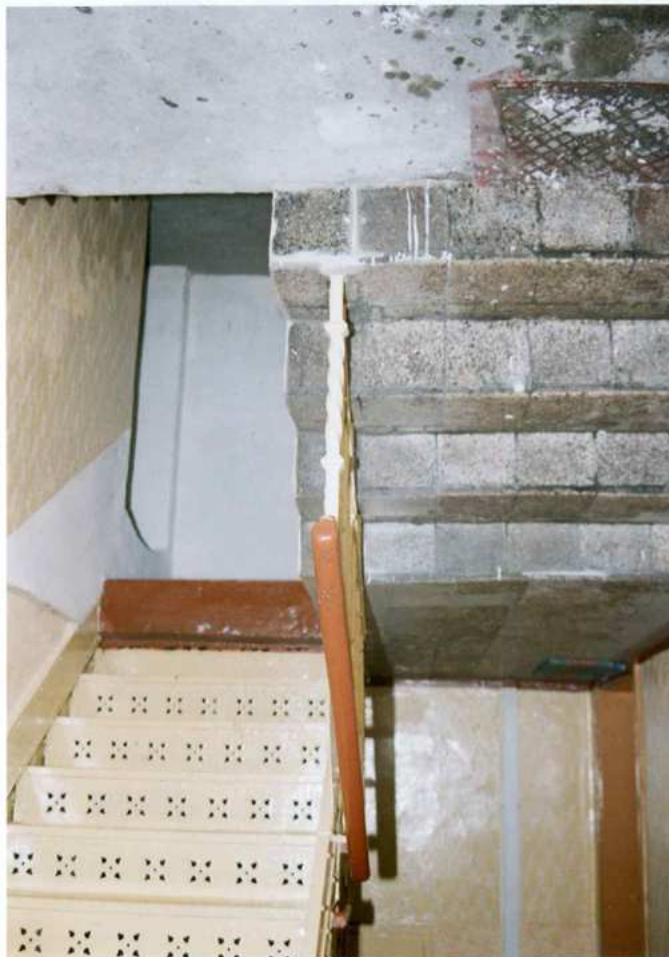
Fot. 17. Klatka schodowa. Schody.
