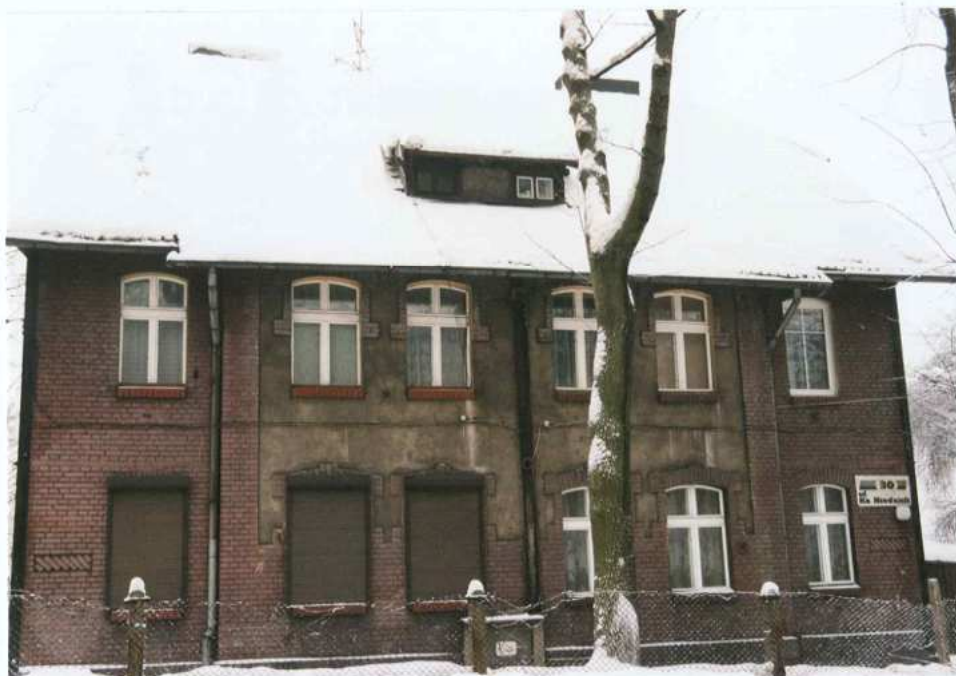
Fot. 1. Elewacja zachodnia.
