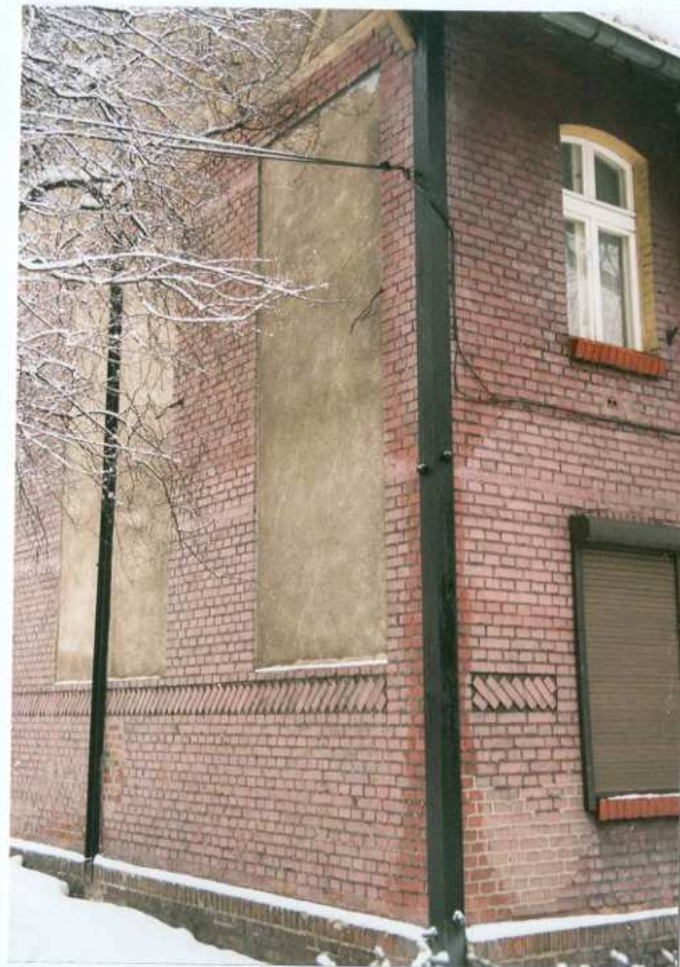
Fot. 7. Fragment elewacji północnej. Widok od północnego – zachodu. Detal.
