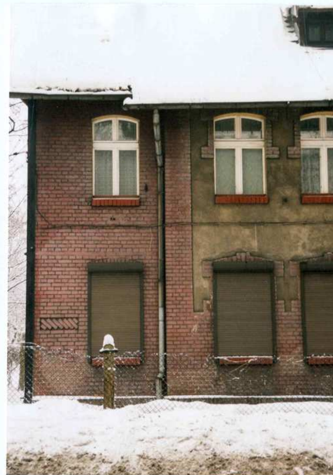
Fot. 2. Fragment elewacji zachodniej.
