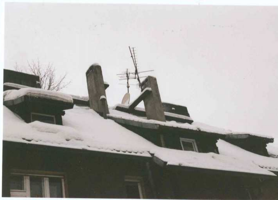
Fot. 12. Fragment elewacji wschodniej. Dach.
