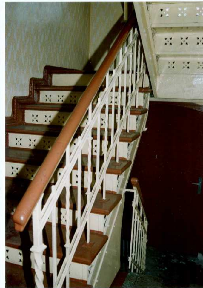
Fot. 18. Klatka schodowa. Schody.
