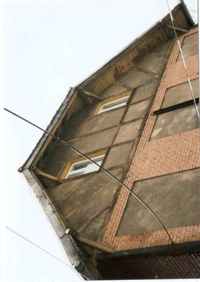
Fot. 15. Fragment elewacji południowej. Detal.
