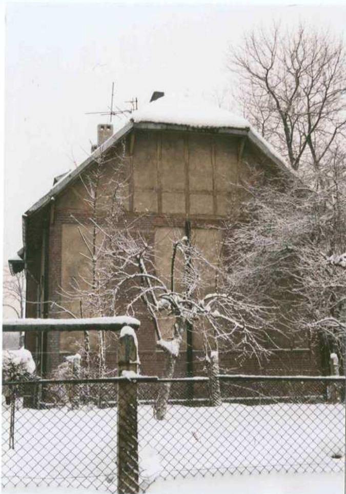
Fot. 6. Elewacja północna.
