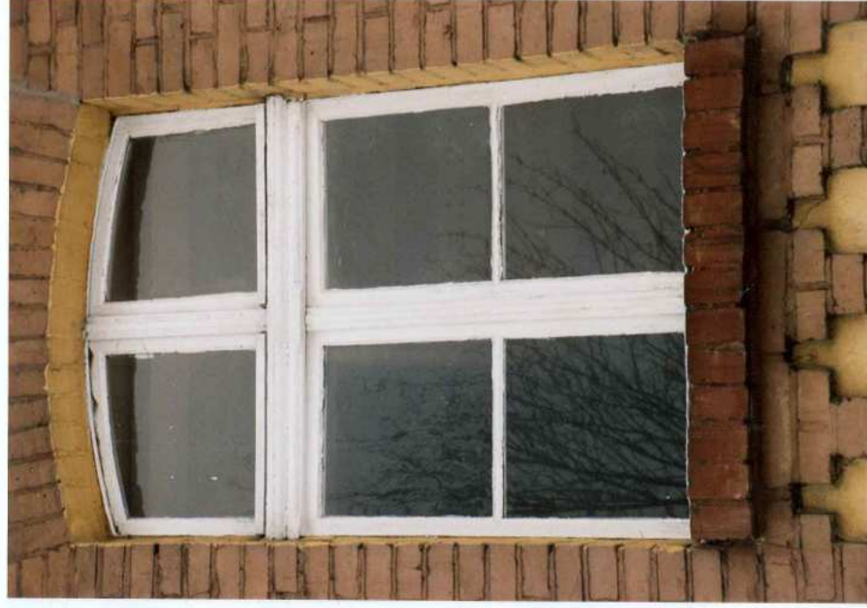
Fot. 10. Fragment elewacji wschodniej. Okno.
