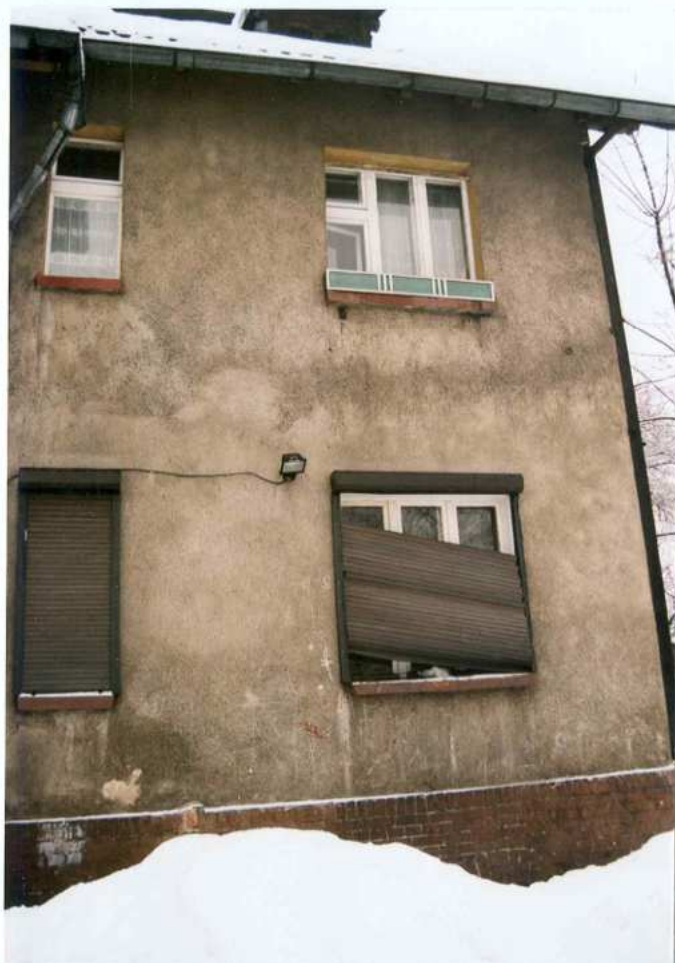
Fot. 11. Fragment elewacji wschodniej.
