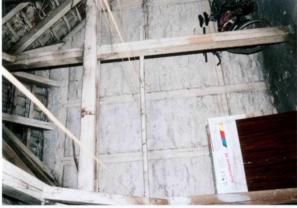
Fot. 27. Wieżba dachowa.
