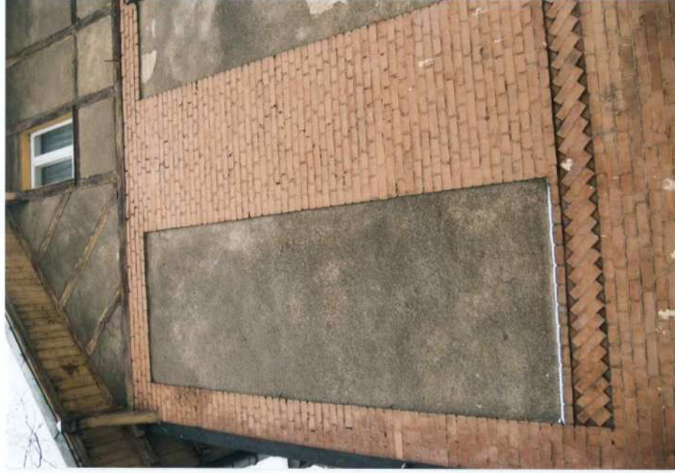
Fot. 14. Fragment elewacji południowej. Detal.
