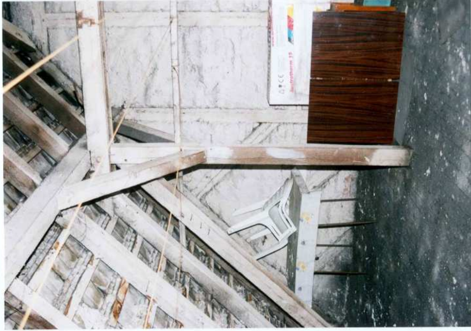
Fot. 26. Wieżba dachowa.
