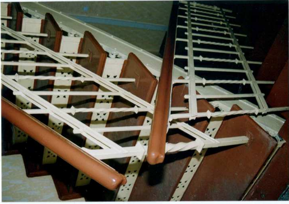
Fot. 20. Klatka schodowa. Schody – balustrada.
