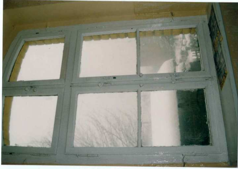
Fot. 22. Klatka schodowa. Okno.
