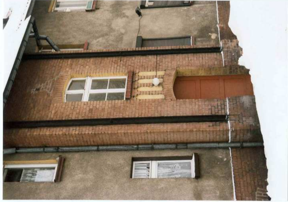
Fot. 9. Fragment elewacji wschodniej. Ryzalit.
