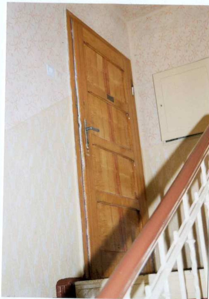
Fot. 24. Klatka schodowa. Drzwi.
