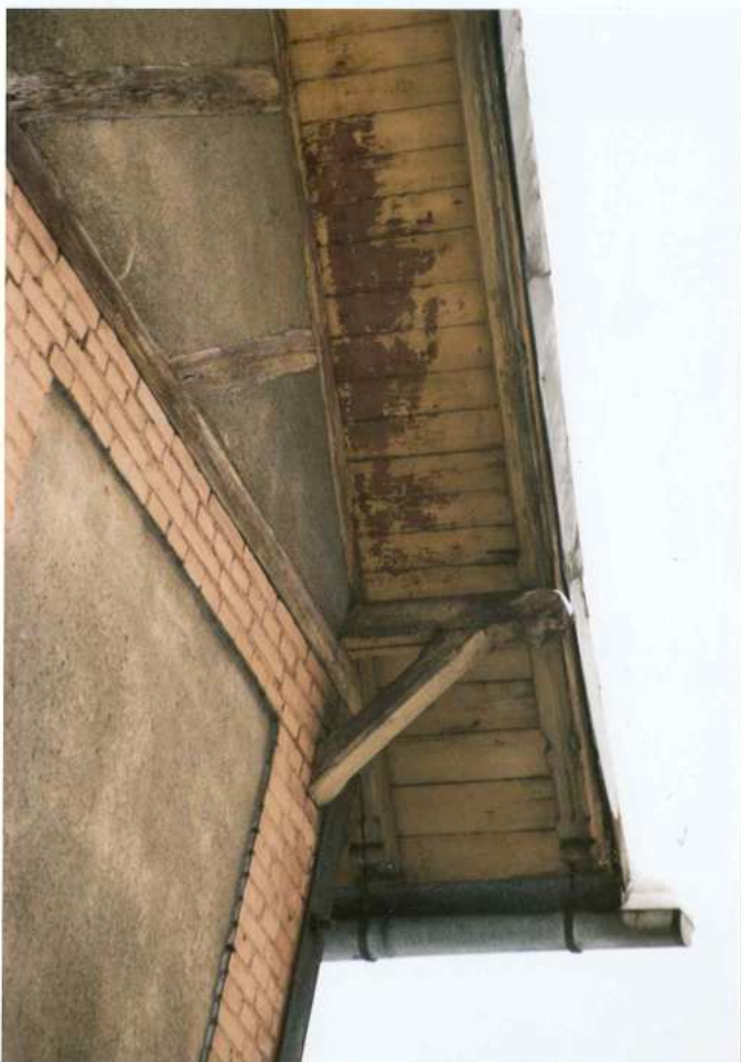
Fot. 16. Fragment elewacji południowej. Detal.
