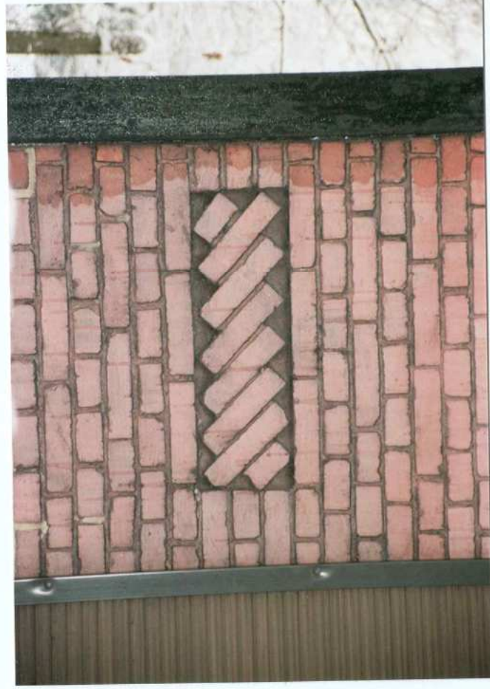
Fot. 5. Fragment elewacji zachodniej. Detal.
