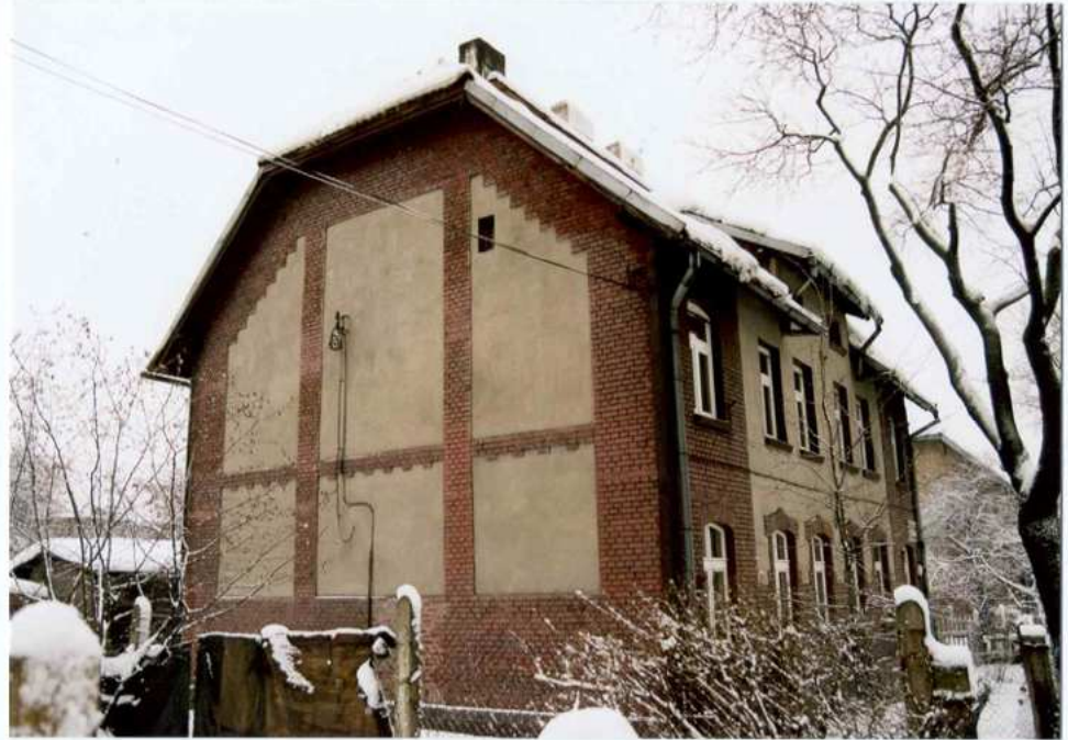
Fot. 5. Elewacja północna. Widok ogólny od północnego – zachodu.
