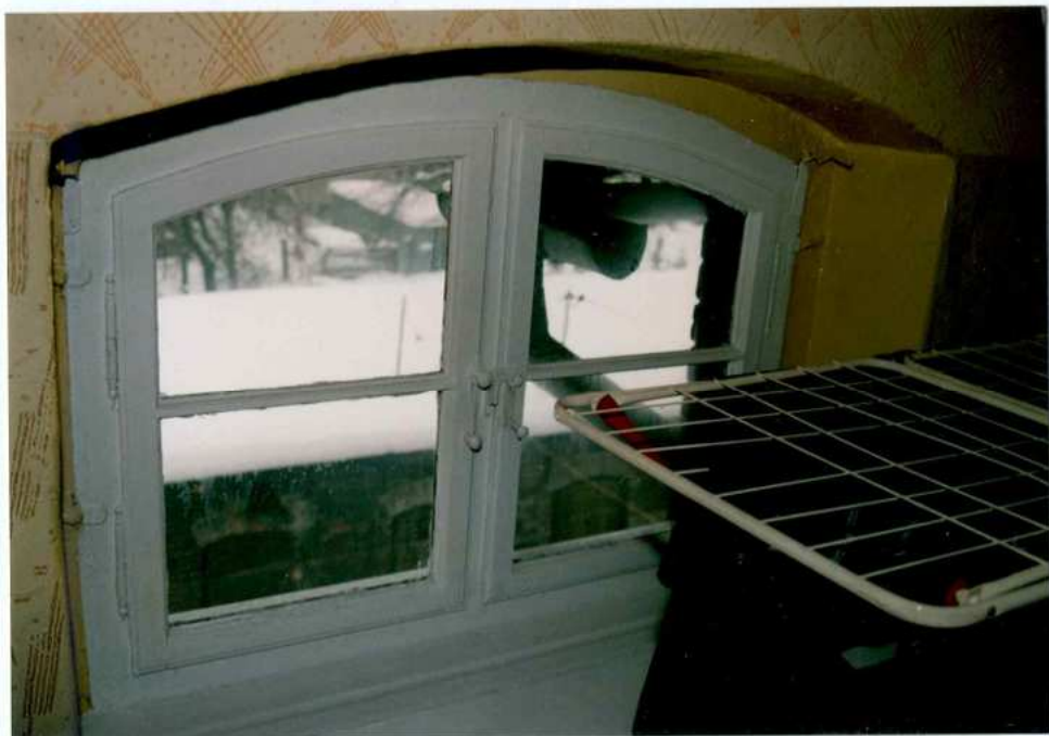
Fot. 24. Poddasze. Okno.
