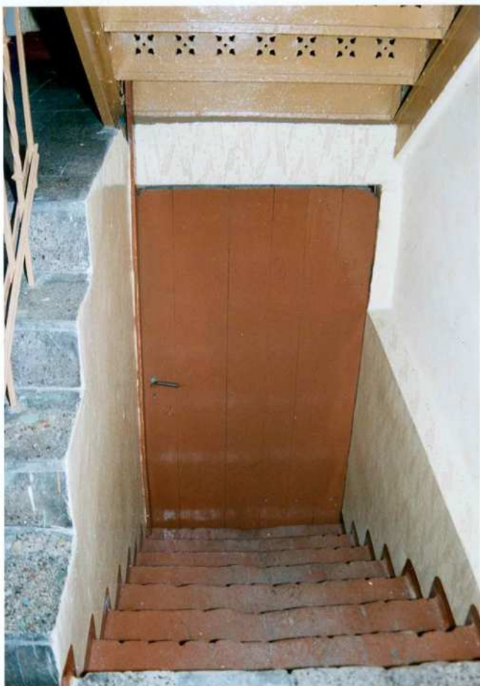
Fot. 19. Piwnica. Schody wraz z drzwiami.
