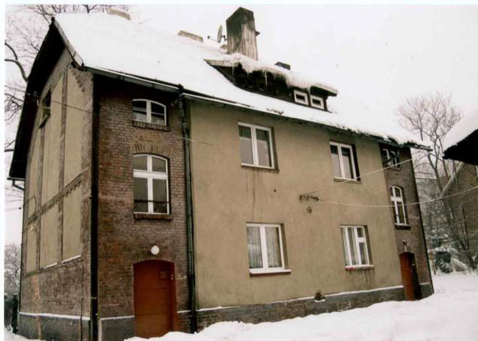
Fot. 7. Elewacja wschodnia. Widok od południowego – wschodu.
