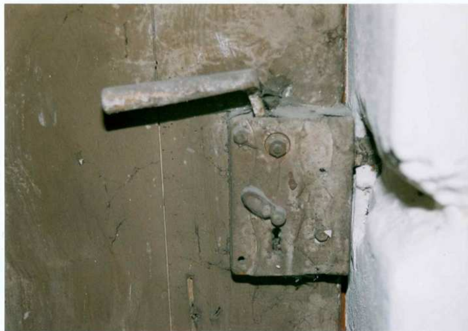
Fot. 20. Piwnica. Drzwi – zamek.
