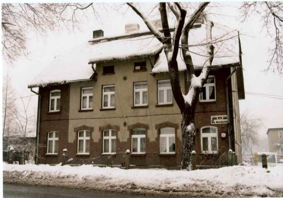
Fot. 1. Elewacja zachodnia.
