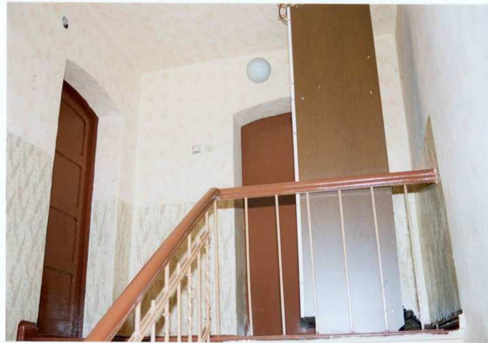
Fot. 18. Klatka schodowa. Widok ogólny.
