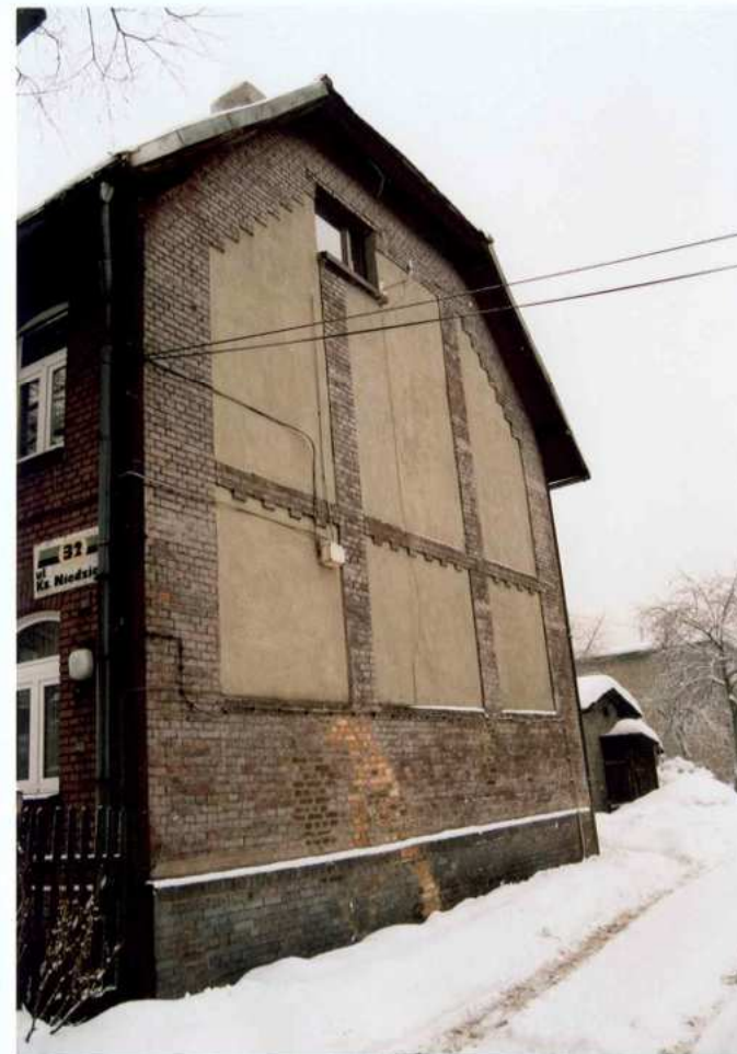
Fot. 13. Elewacja południowa.
