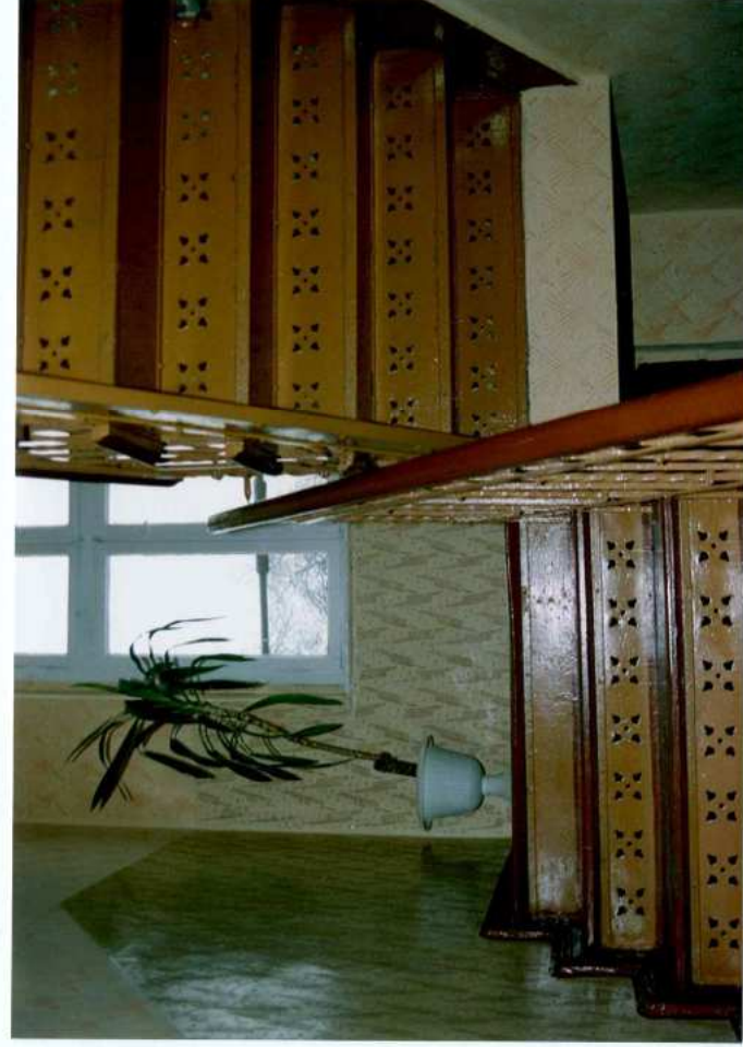
Fot. 16. Klatka schodowa. Schody.
