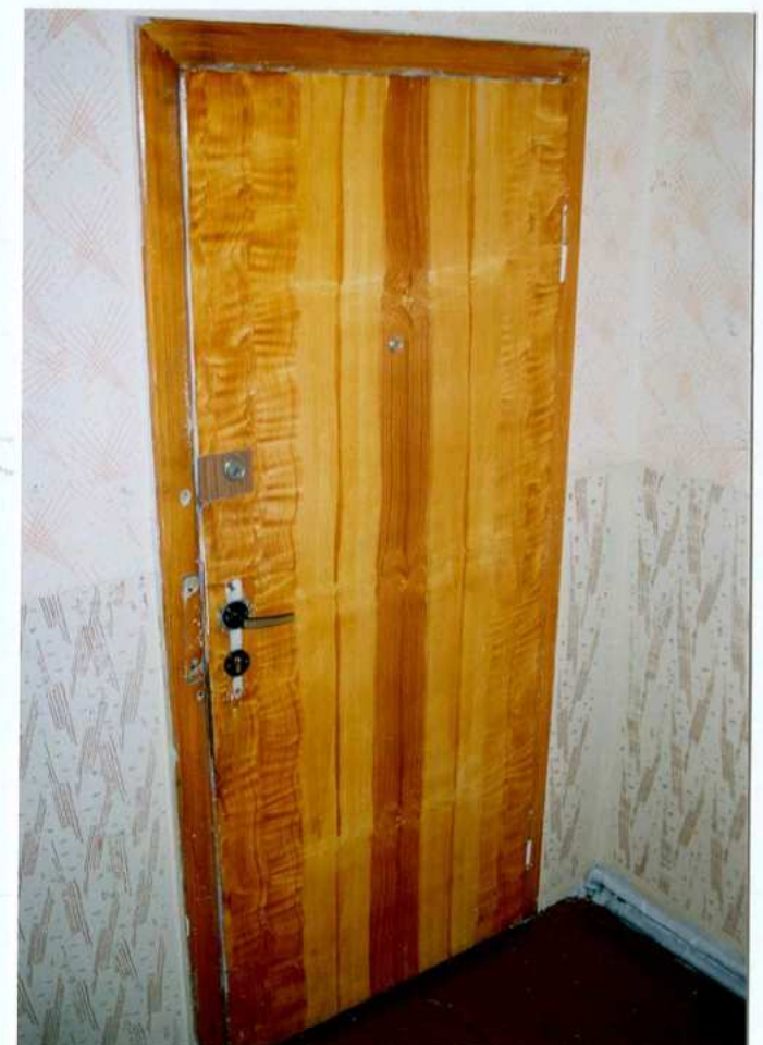
Fot. 23. Klatka schodowa. Drzwi.
