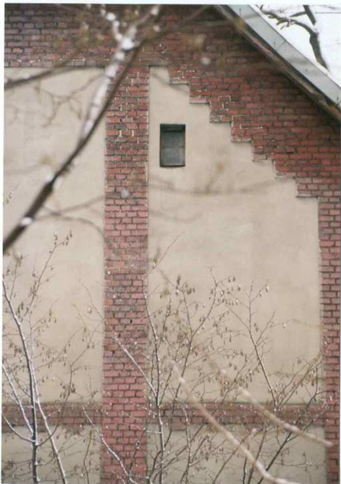
Fot. 6. Fragment elewacji północnej. Okno.
