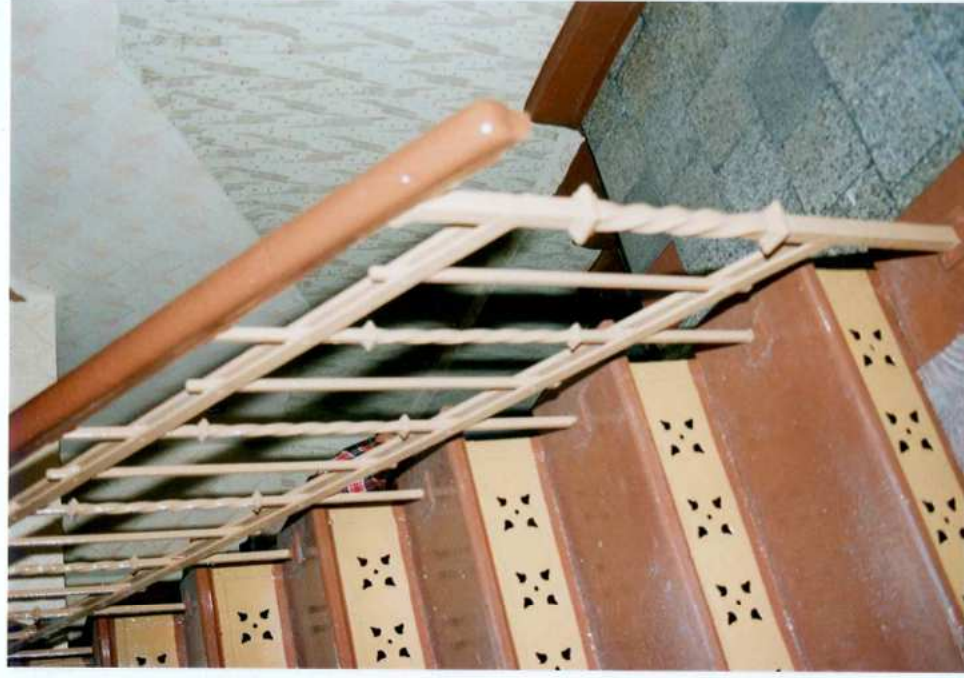
Fot. 15. Klatka schodowa. Schody.
