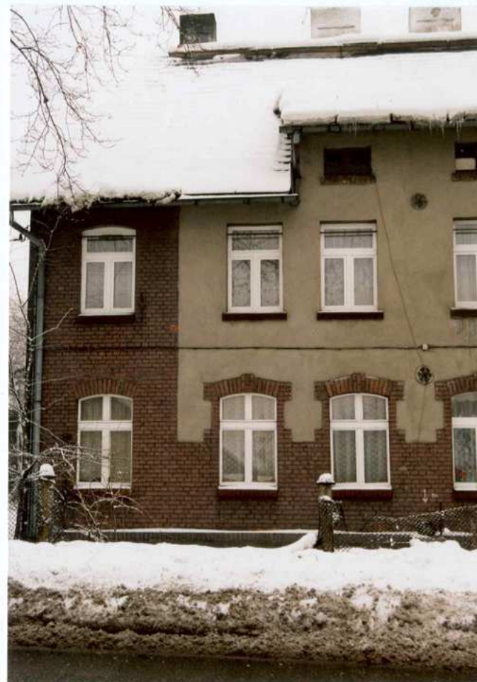
Fot. 2. Fragment elewacji zachodniej. Okna.
