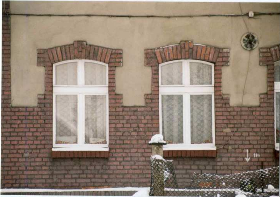
Fot. 3. Fragment elewacji zachodniej. Okna.
