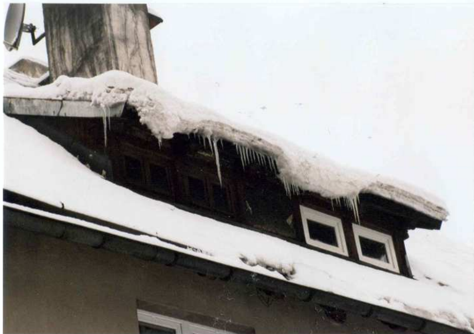
Fot. 12. Fragment elewacji wschodniej. Facjata.
