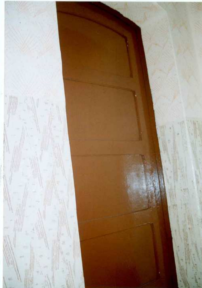
Fot. 22. Klatka schodowa. Drzwi.
