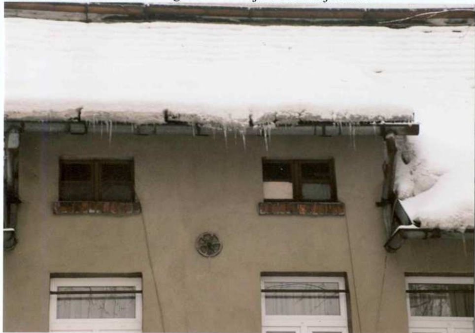
Fot. 4. Fragment elewacji zachodniej. Poddasze.
