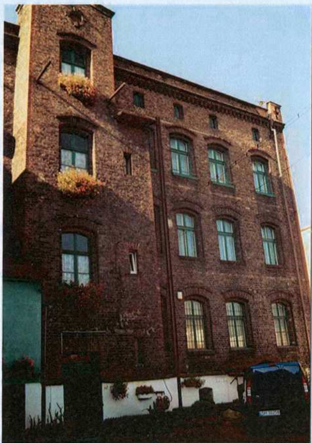
Kamienica. Frag. elewacji wschodniej.
