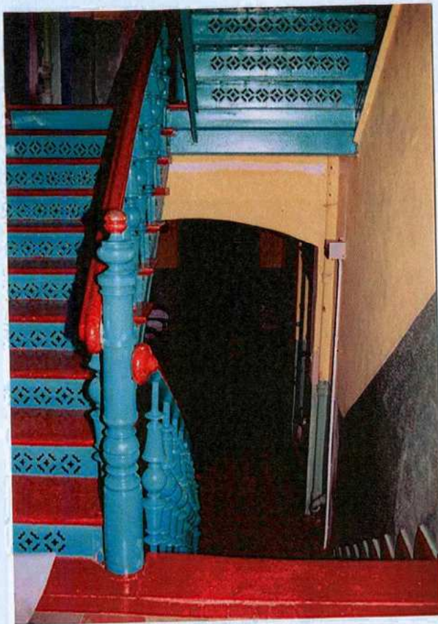
Kamienica. Klatka schodowa.
