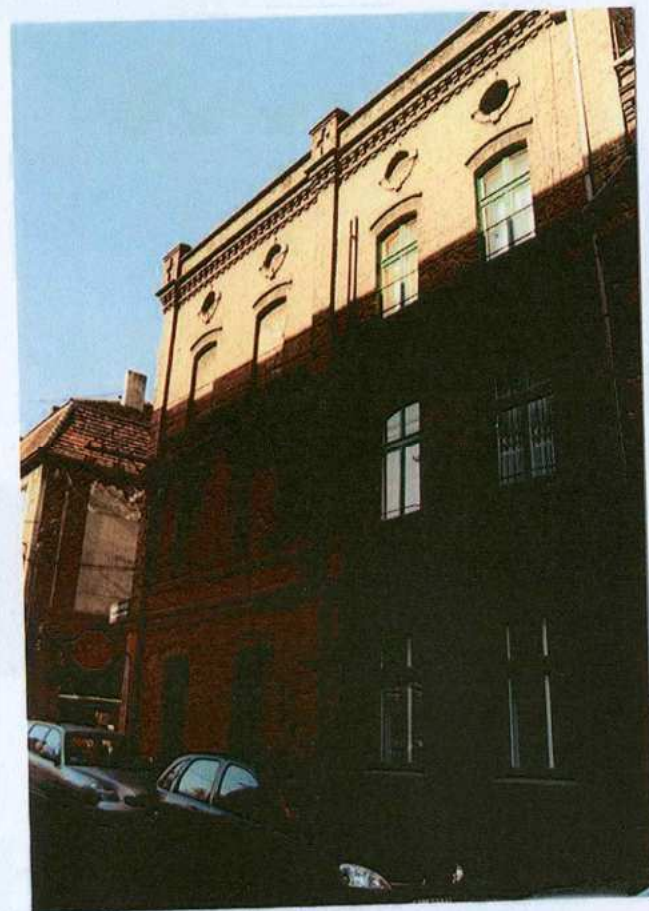
Kamienica. Elewacja południowa.
