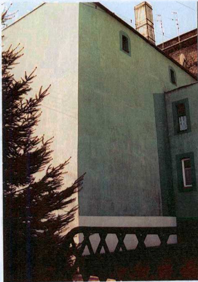
Oficyna. Widok od północnego-wschodu.
