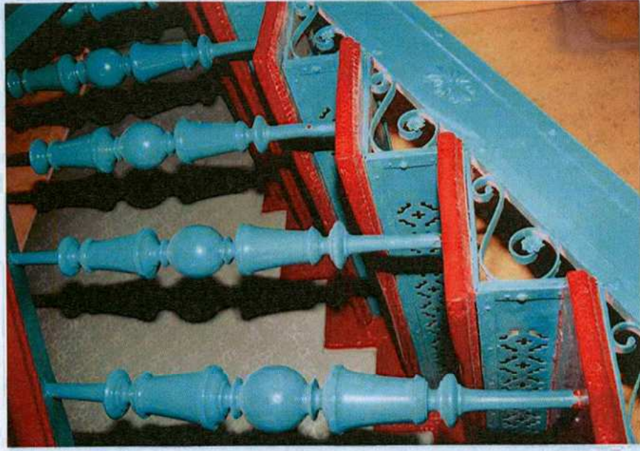
Kamienica. Klatka schodowa.
