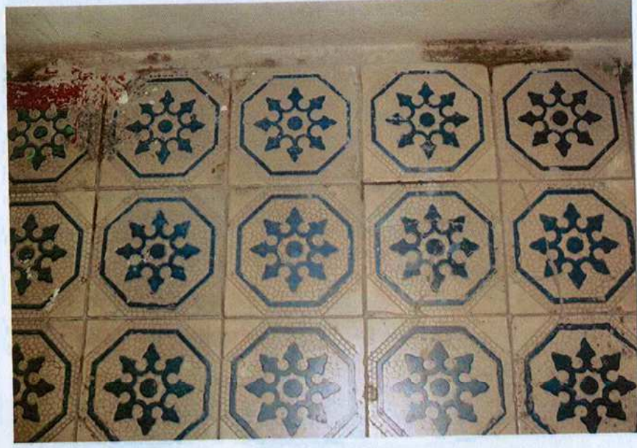
Kamienica – korytarz. Posadzka.
