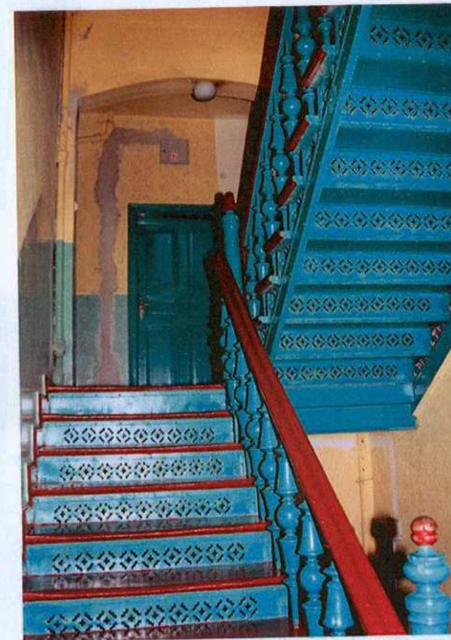
Kamienica. Klatka schodowa.
