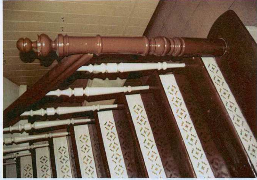
Oficyna. Klatka schodowa.
