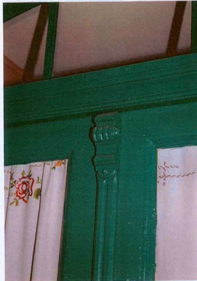
Klatka schodowa. Drzwi – detal.
