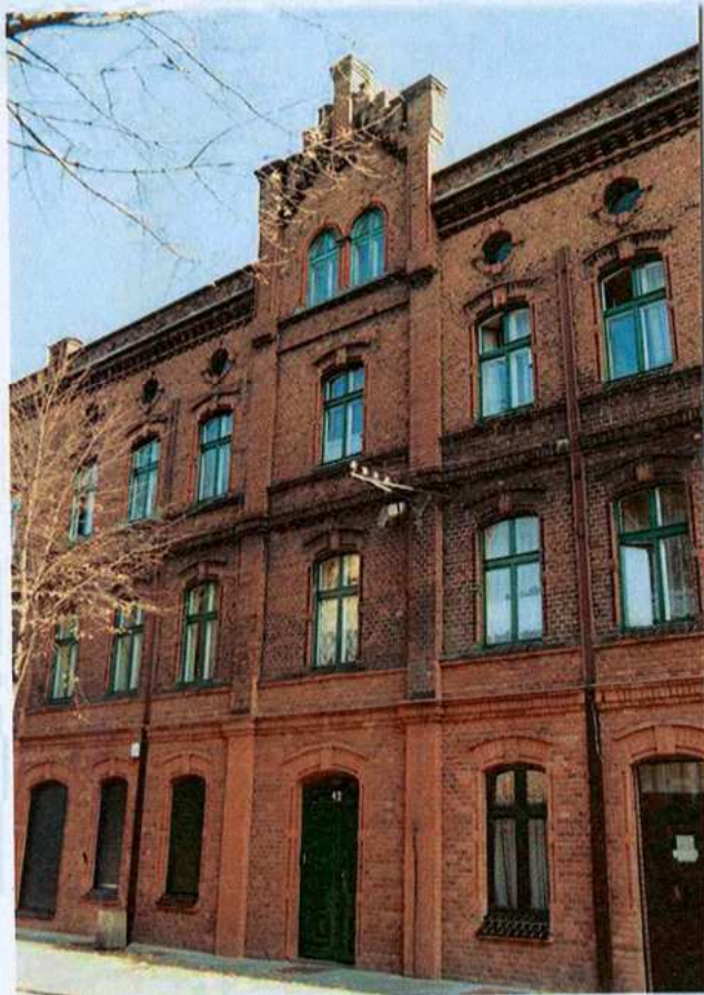
Kamienica. Frag. elewacji zachodniej.
