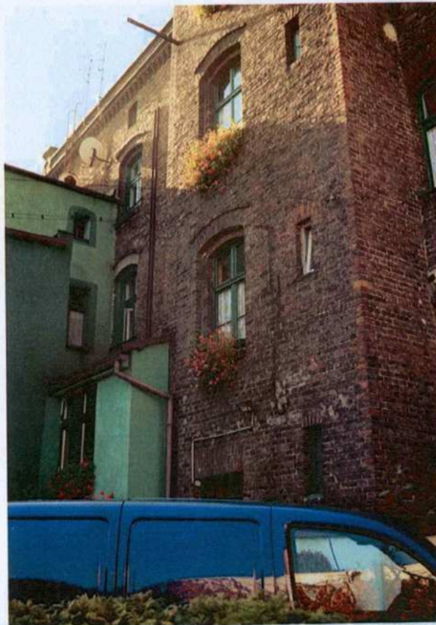
Kamienica. Frag. elewacji wschodniej.
