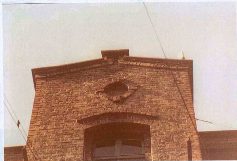
Kamienica. Frag. elewacji wschodniej. Szczyt.
