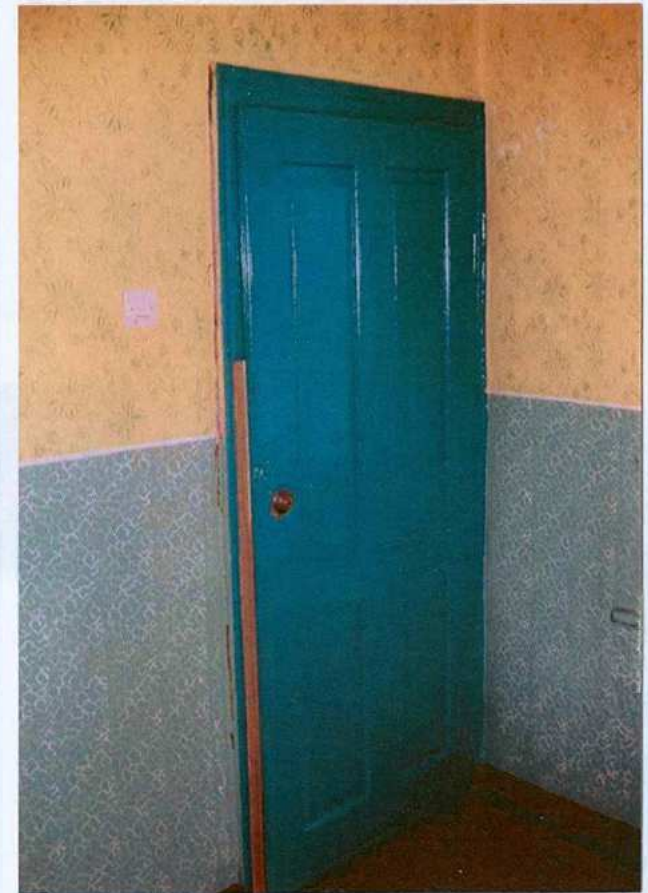
Klatka schodowa. Toaleta. Drzwi.
