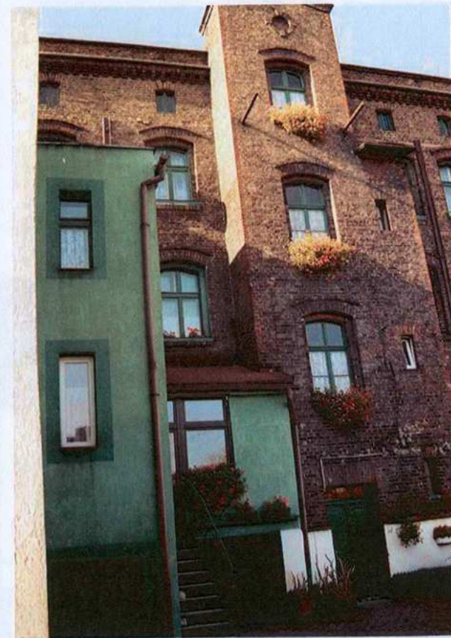
Kamienica. Frag. elewacji wschodniej.
