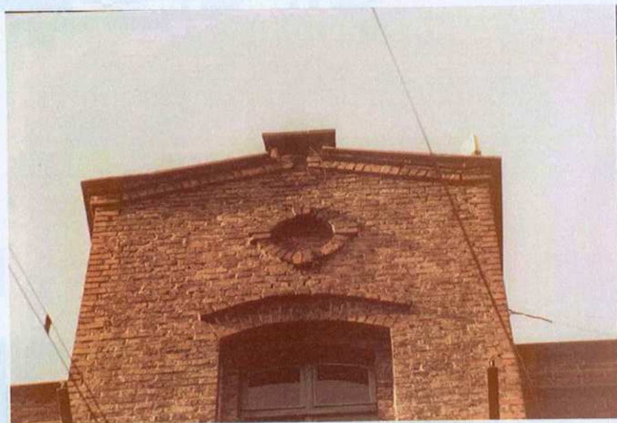
Kamienica. Frag. elewacji wschodniej. Szczyt.
