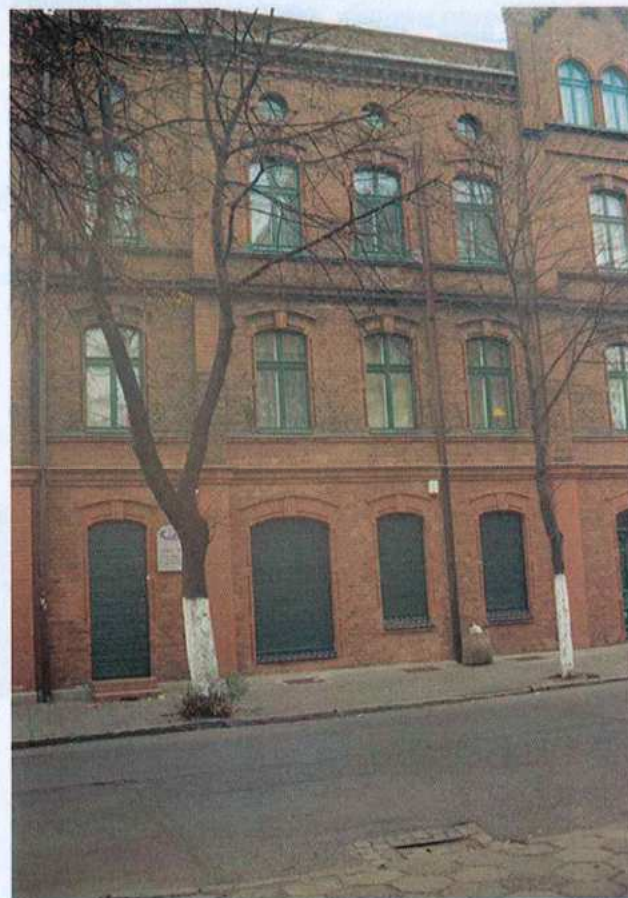
Kamienica. Frag. elewacji zachodniej.
