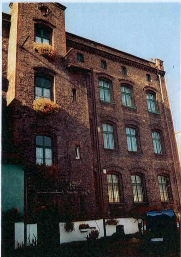
Kamienica. Frag. elewacji wschodniej.
