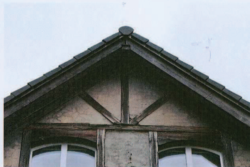
Ryc. 45. Szczyt ryzalitu elewacji zachodniej.
