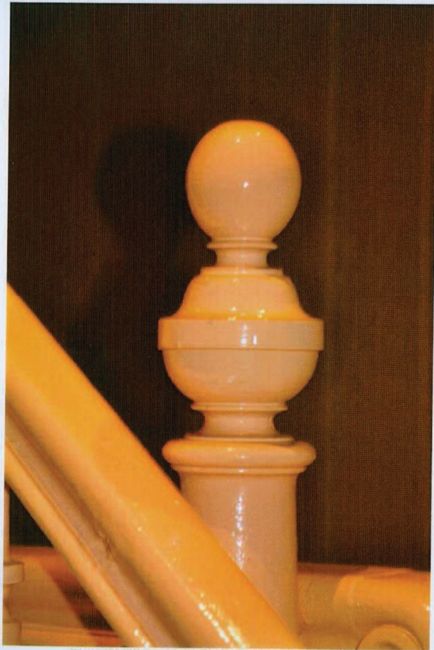
Ryc. 72. Górna partia słupka balustrady schodów.
