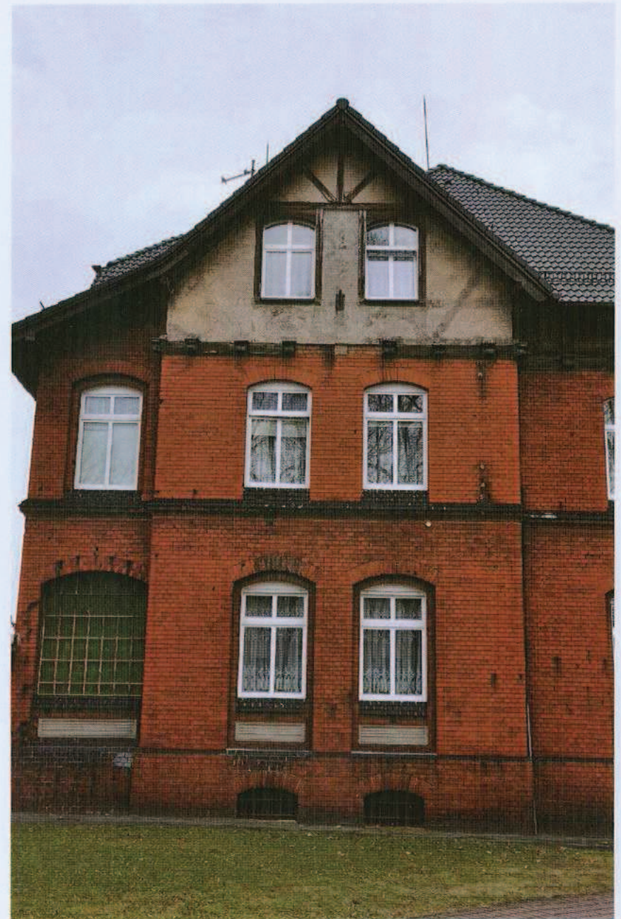
Ryc. 48. Ryzalit elewacji zachodniej.
