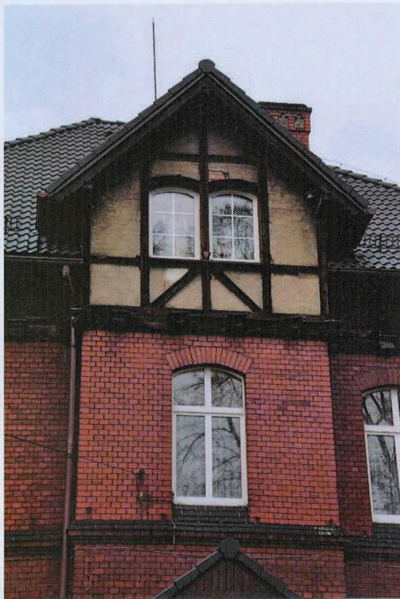
Ryc. 16. Górna partia ryzalitu – elewacja południowa.
