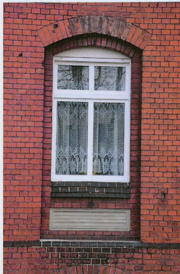
Ryc. 50. Okno na parterze elewacji zachodniej.
