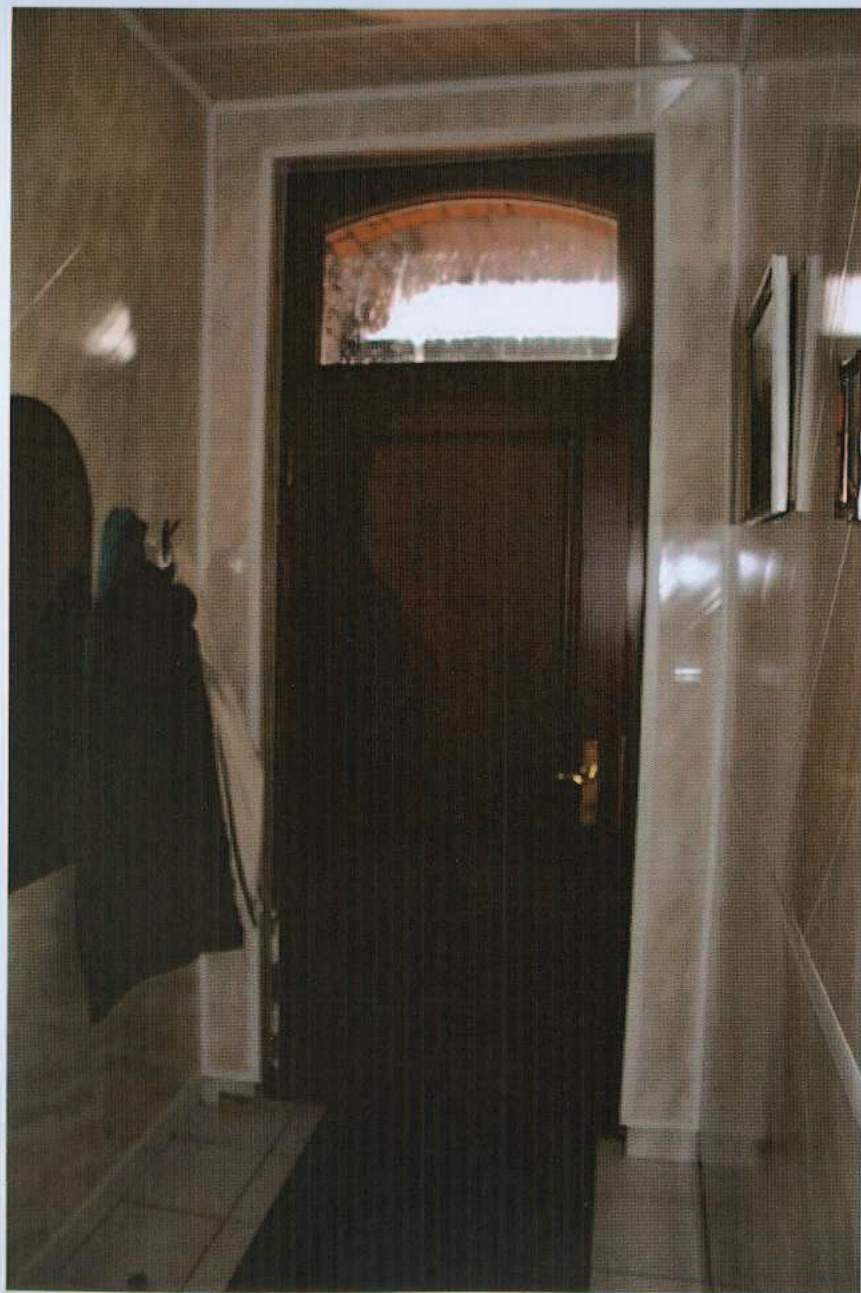
Ryc. 64. Drzwi zewnętrzne – wyjście boczne.
