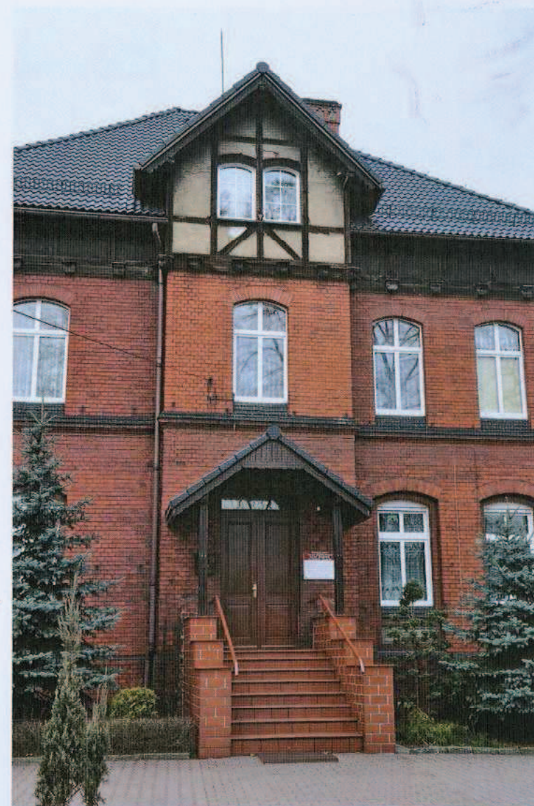
Ryc. 13. Główne wejście na probostwo – elewacja południowa.
