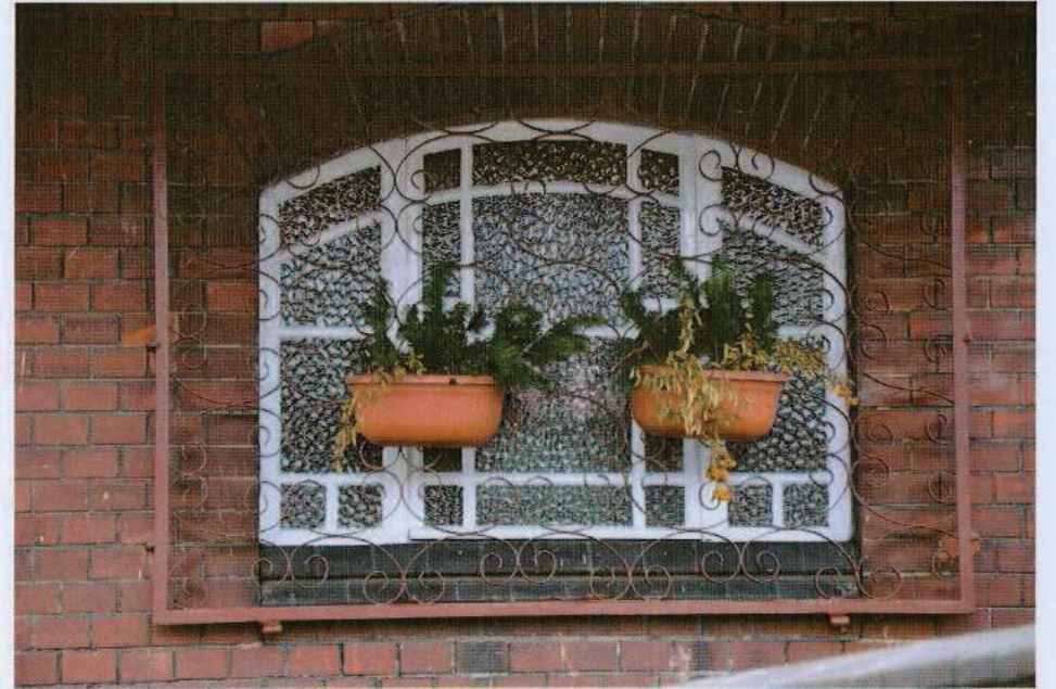
Ryc. 27. Okno parteru – elewacja wschodnia.
