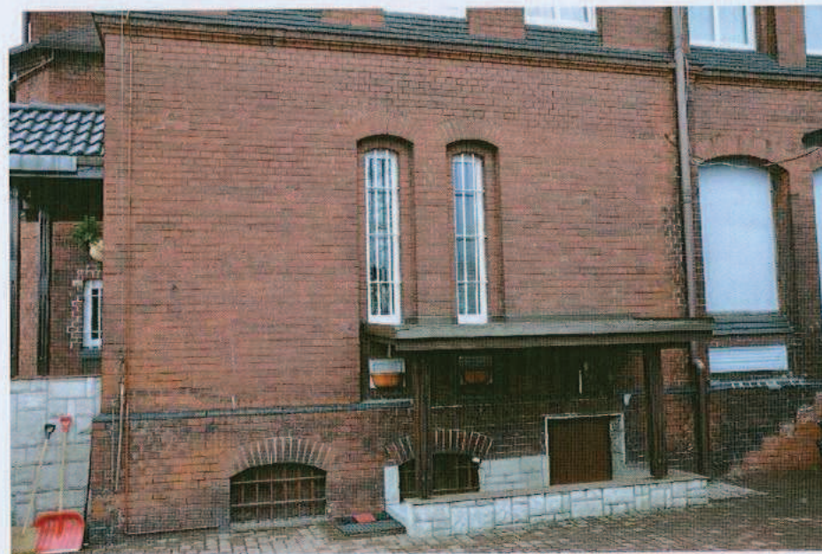
Ryc. 36. Okna na parterze – elewacja północna.
