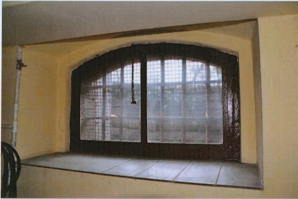
Ryc. 68. Okno z piwnicy.
