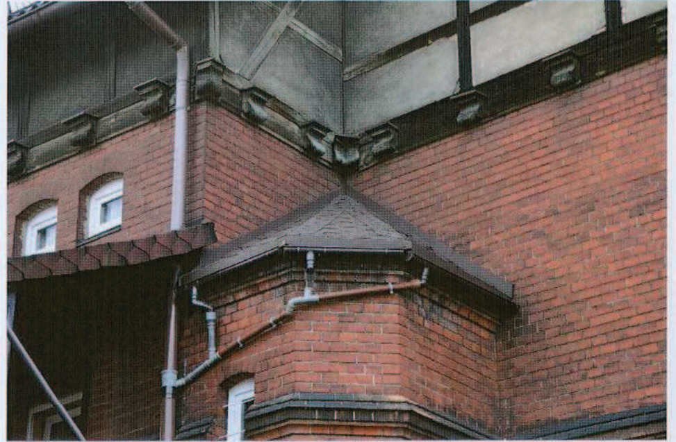
Ryc. 26. Elewacja wschodnia – dach nad toaletami.
