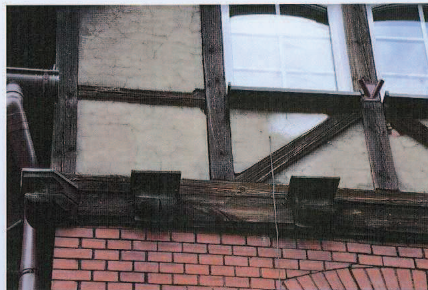
Ryc. 18. Fragment ściany z muru pruskiego.
