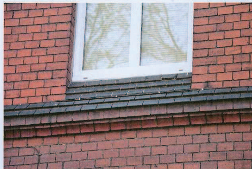
Ryc. 30. Parapet i gzyms podokienny.
