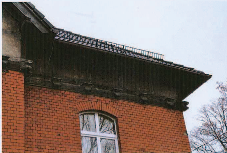
Ryc. 47. Górna partia południowego skrzydła elewacji zachodniej.
