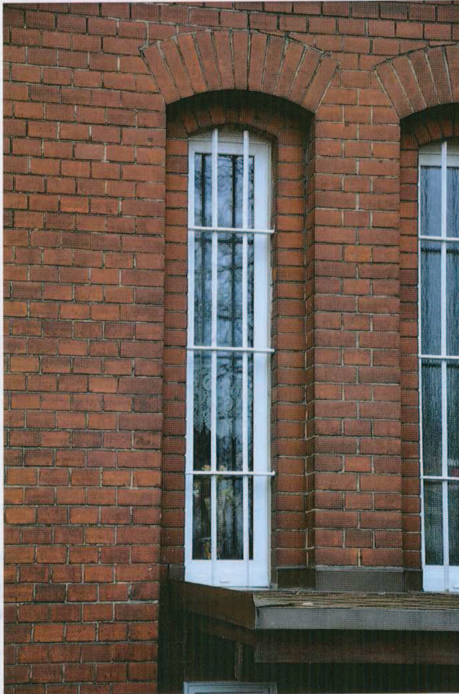
Ryc. 41. Okno na parterze – elewacja północna.
