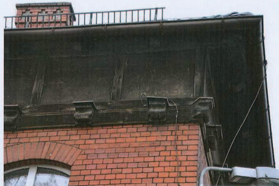
Ryc. 20. Górna partia budynku.
