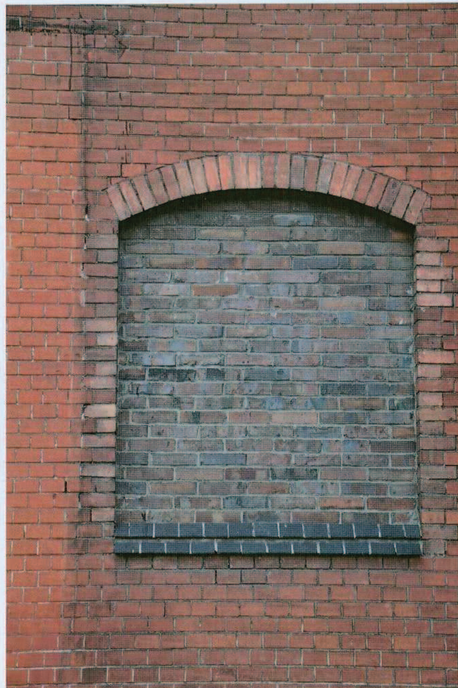
Ryc. 32. zamurowane okno w formie płyciny.
