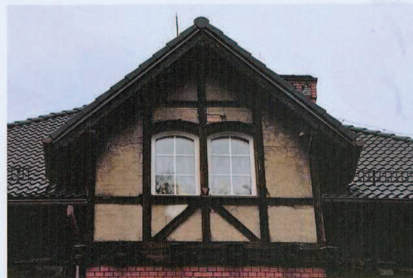
Ryc. 17. Górna partia ryzalitu – widoczny mur pruski.
