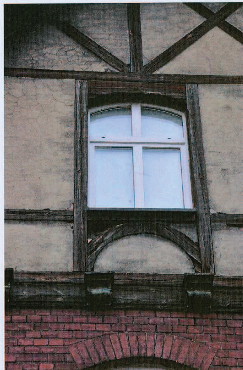
Ryc. 40. Okno – górna partia ryzalitu elewacji północnej.
