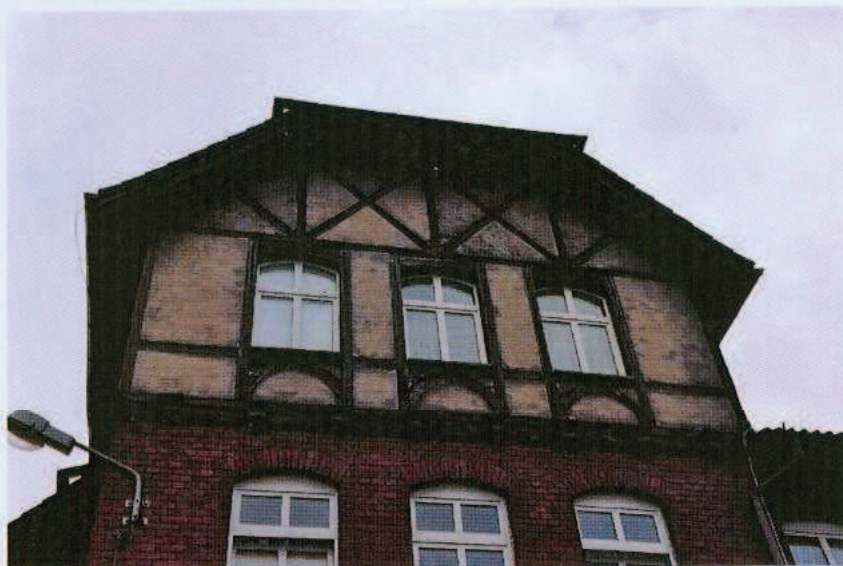
Ryc. 38. Górna partia ryzalitu elewacji północnej.
