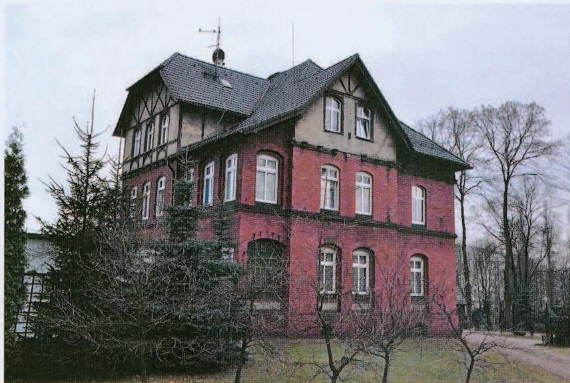
Ryc. 43. Widok na budynek od strony zachodniej.
