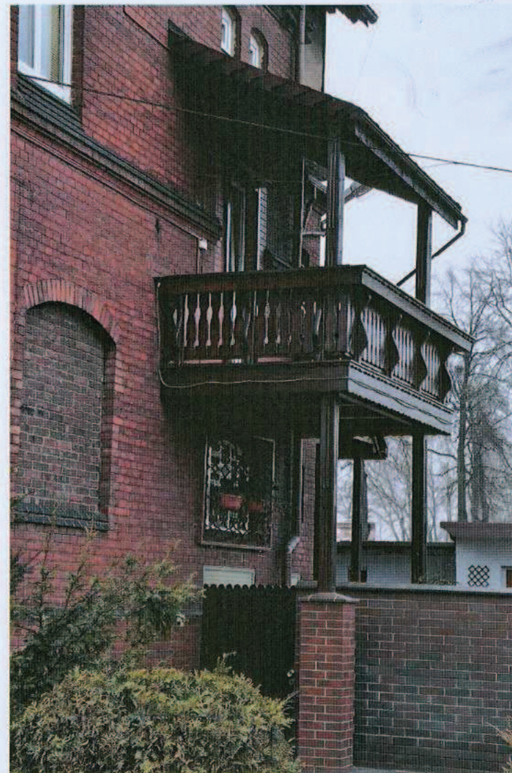
Ryc. 23. Balkon – elewacja wschodnia.
