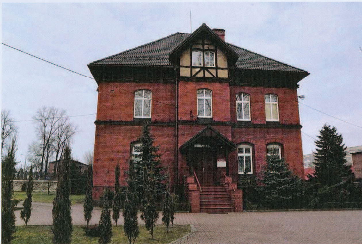
Ryc. 12. Widok na budynek od strony południowej.
