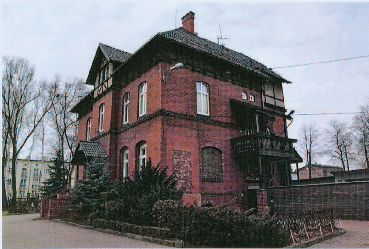
Ryc. 22. Widok na budynek od strony południowo – wschodniej.
