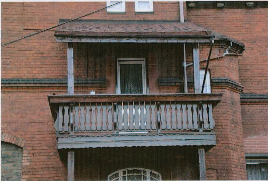
Ryc. 25. Balkon – elewacja wschodnia.
