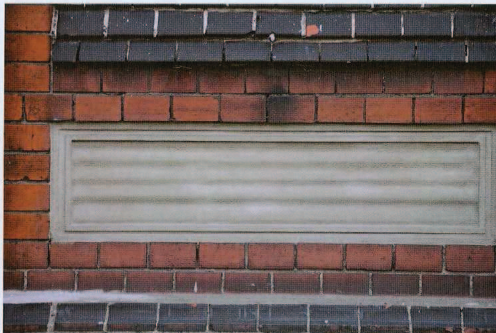
Ryc. 52. Płycina podokienna – elewacja zachodnia.
