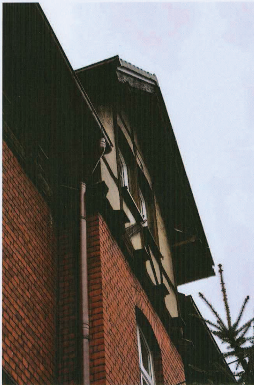
Ryc. 19. Widok na ryzalit elewacji południowej od strony zachodniej.
