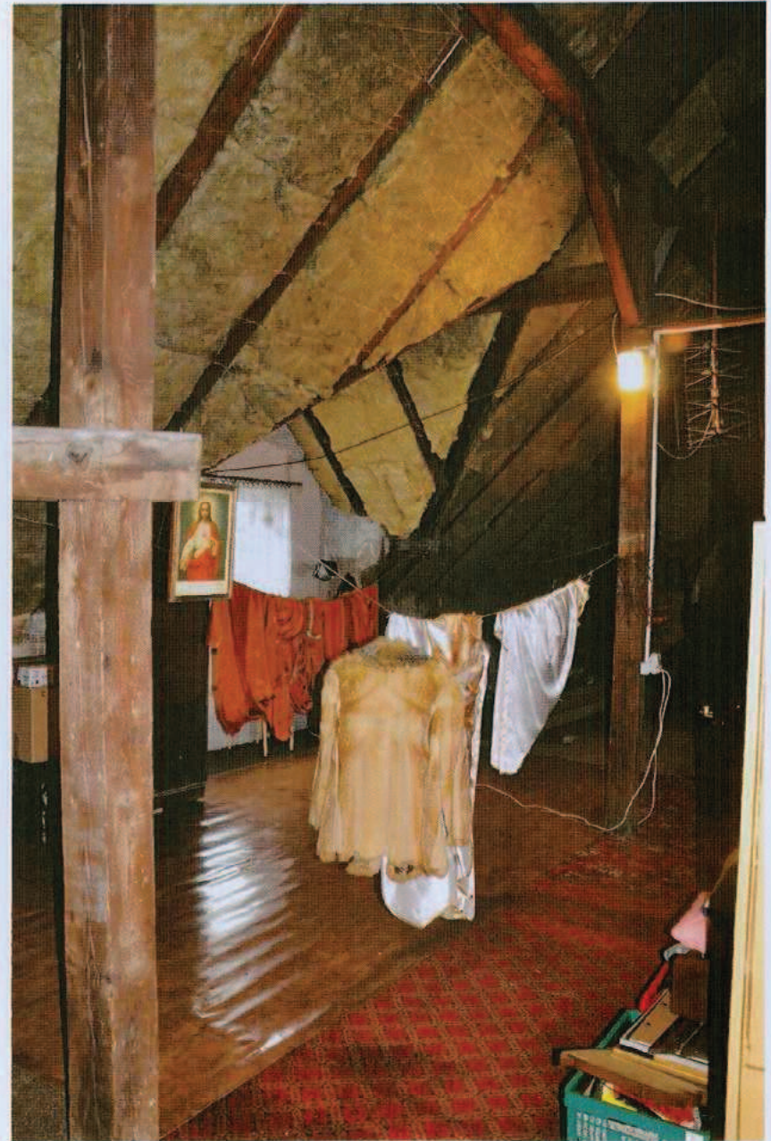
Ryc. 77. Pomieszczenie na strychu.
