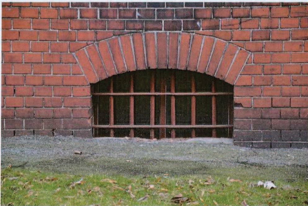
Ryc. 51. Okno piwnicy – elewacja zachodnia.
