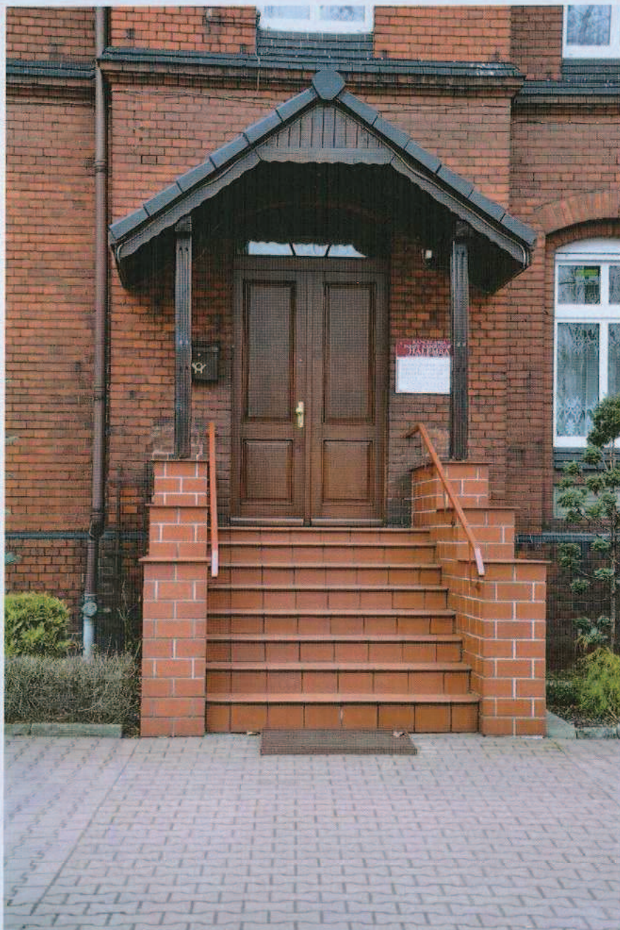
Ryc. 14. Wejście na probostwo –elewacja południowa.
