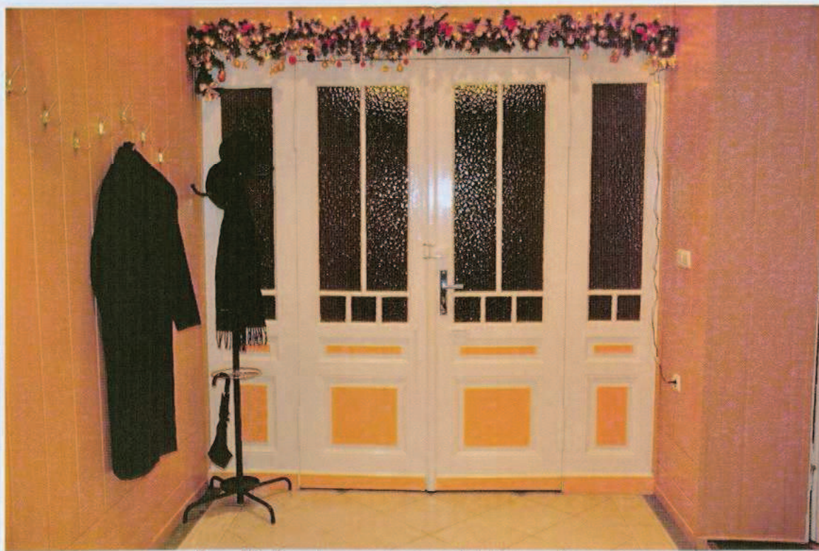
Ryc. 53. Drzwi wewnętrzne z wiatrolapem na korytarz.
