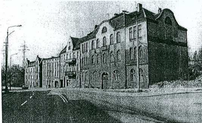
Ryc.1. Ul. 1-go Maja 207, 205, 203, 201, budynki mieszkalne, około 1910 r., widok od strony płn.-wsch.
