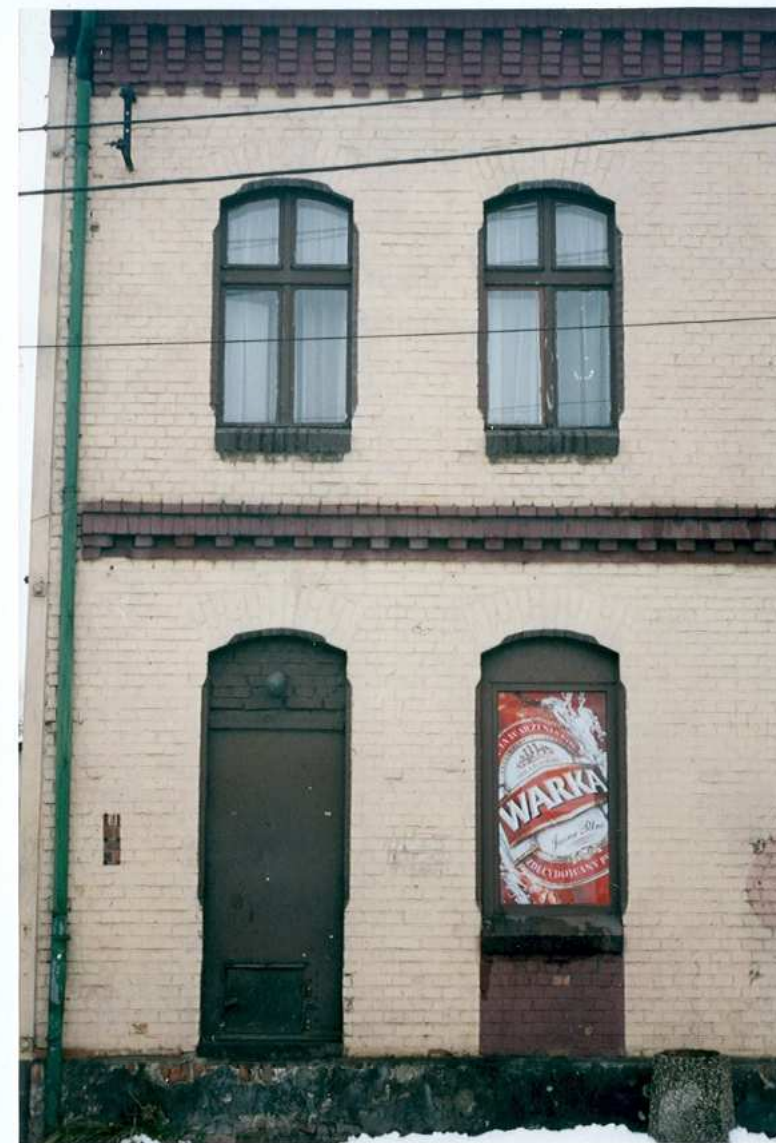
Ryc.16. Fragment elewacji północnej.
