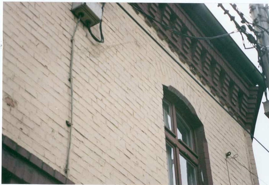
Ryc.20. Widok na fragment gzymsu wieńczącego.
