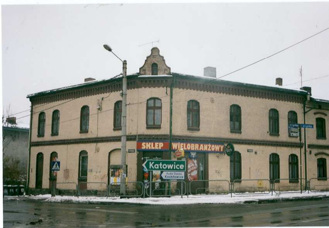
Ryc.11. Widok na narożnik budynku – widok od strony płn. – zach.
