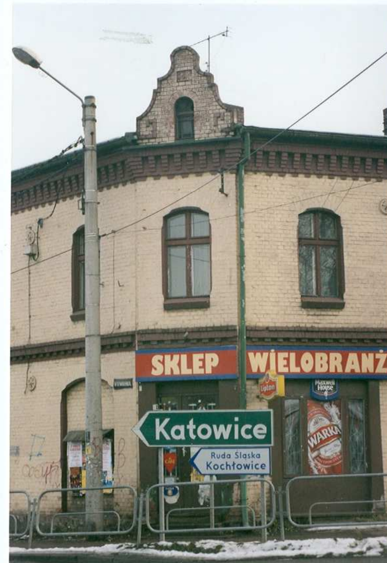
Ryc.12. Narożnik budynku – widok od strony płn. – zach.
