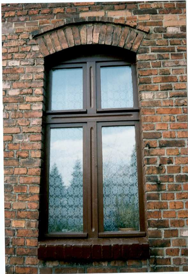
Ryc.23. Okno na elewacji wschodniej.
