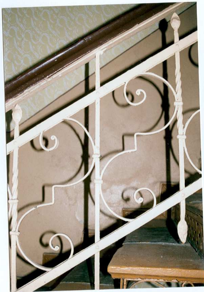
Ryc.26. Schody wewnętrzne – fragment balustrady.
