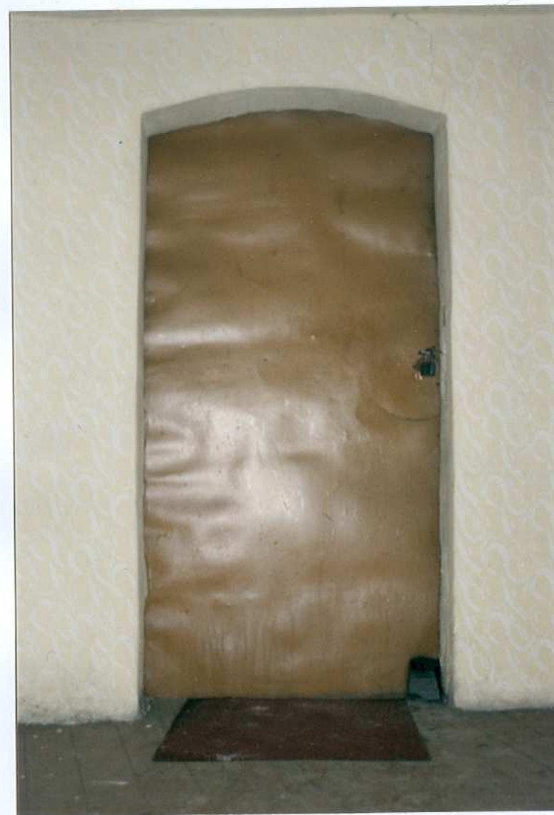
Ryc.32. Drzwi na strych.
