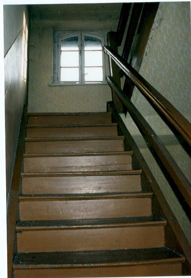
Ryc.28. Schody na strych.
