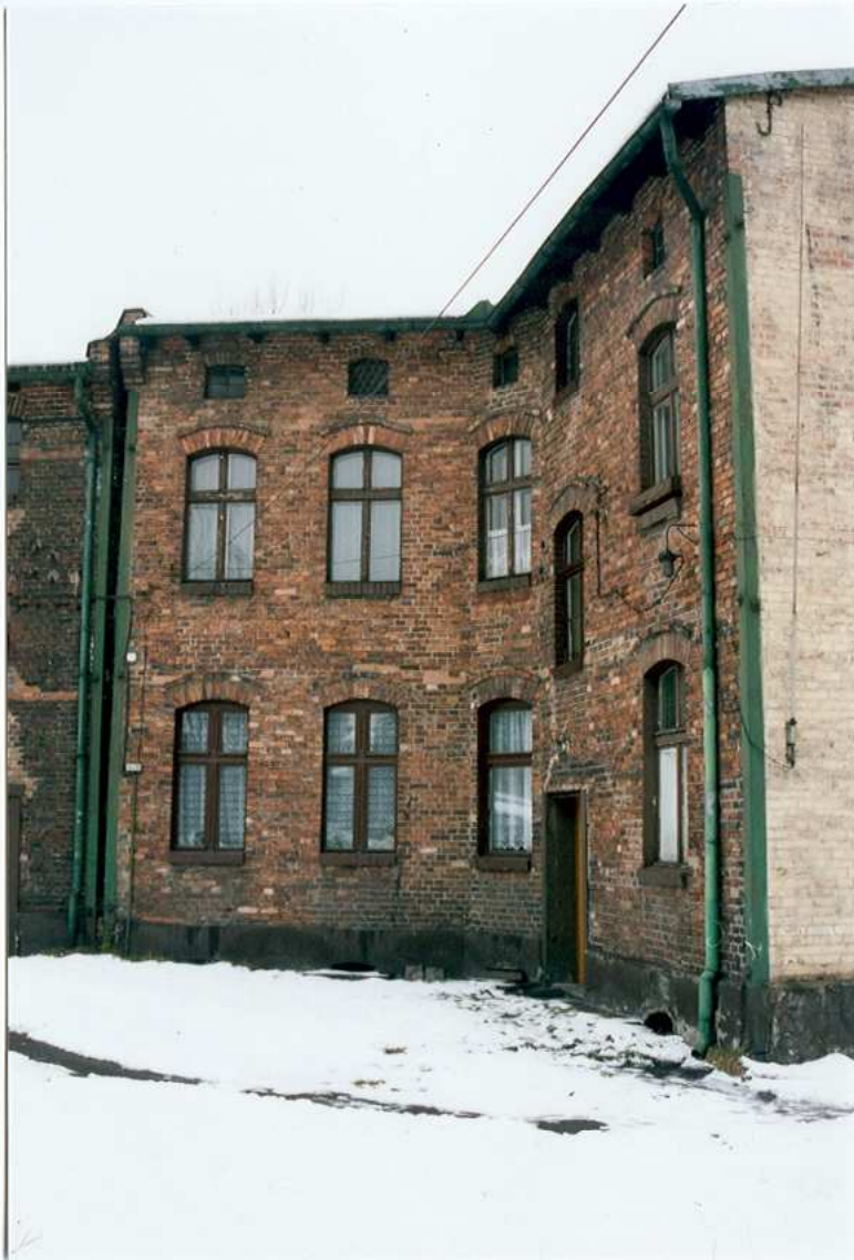
Ryc.21. Widok na elewację od strony wschodniej.
