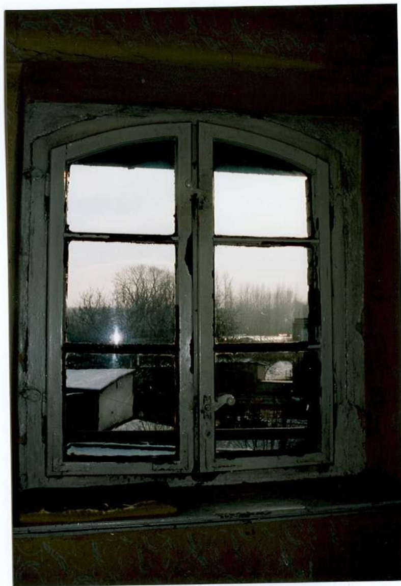
Ryc.24. Okno – elewacja wschodnia. Widok od wewnątrz.
