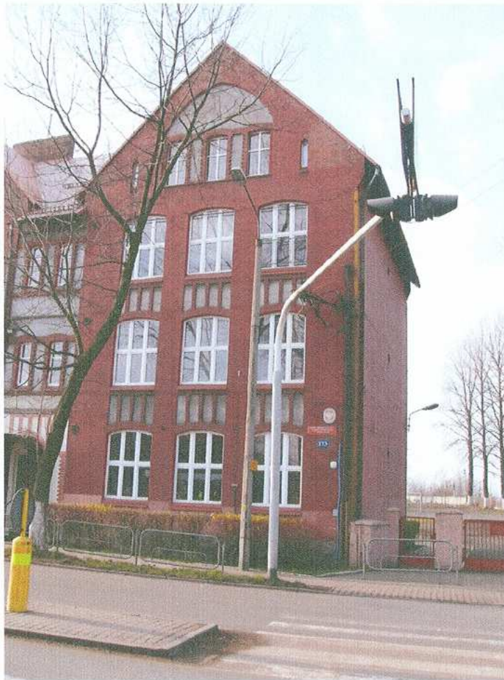
3. Skrzydło północne - fragment elewacji wschodniej
