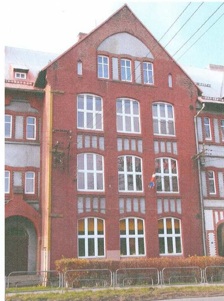
4. Skrzydło północne - fragment elewacji wschodniej
