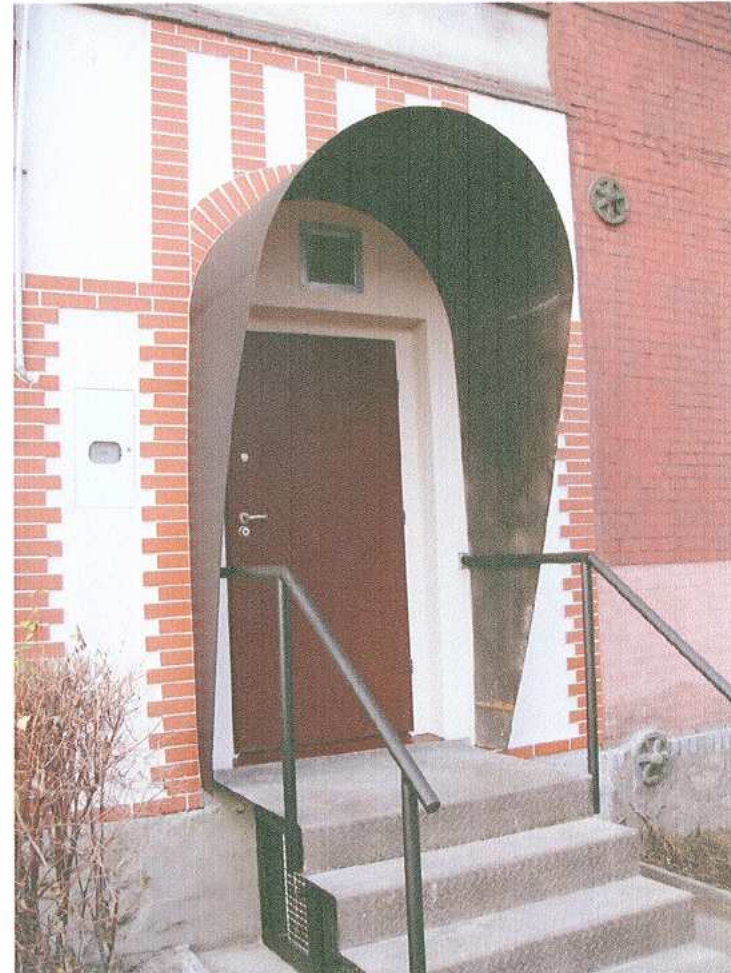
18. Skrzydło północne – fragment elewacji wschodniej - drzwi
