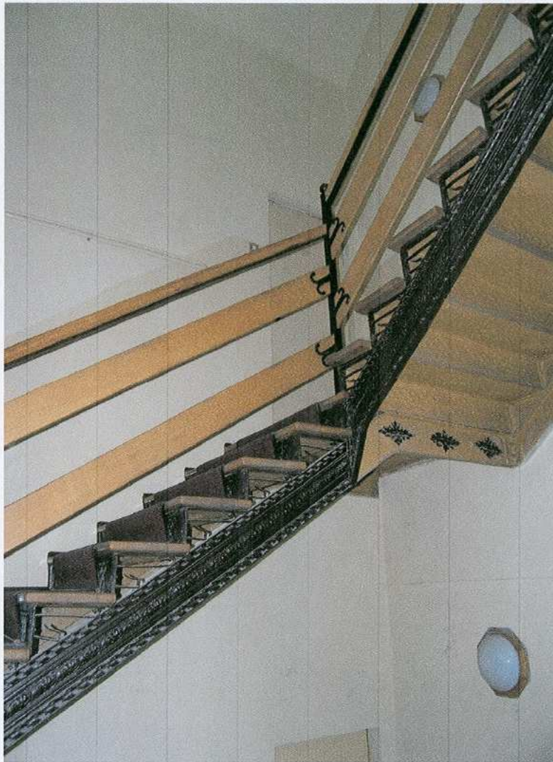
17. Główna klatka schodowa
