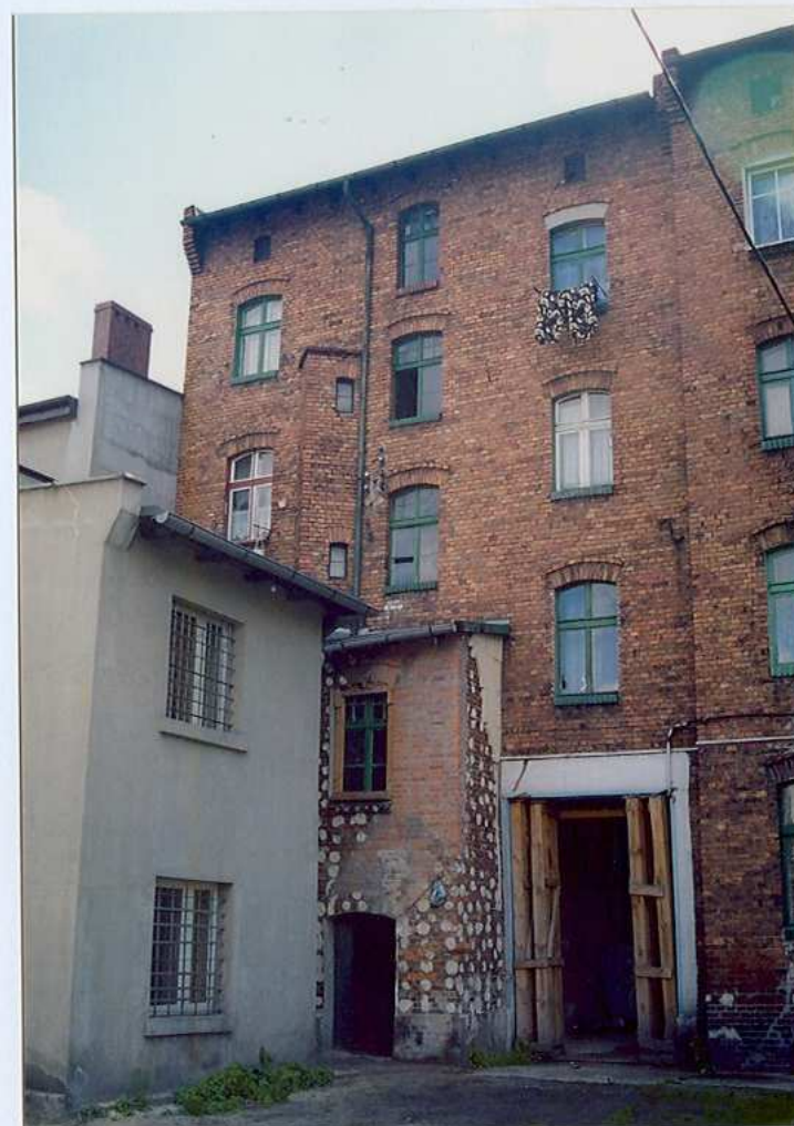
Fot. 8. Widok na elewację zachodnią.
