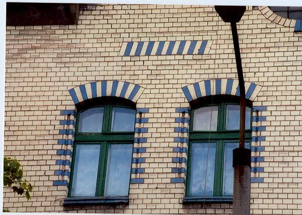
Fot. 6. Okna II piętra – elewacja wschodnia.
