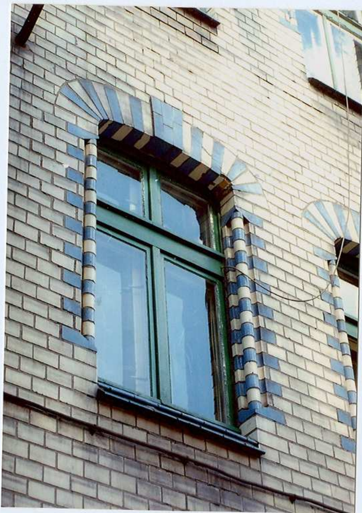
Fot. 5. Okno na piętrze – elewacja wschodnia.
