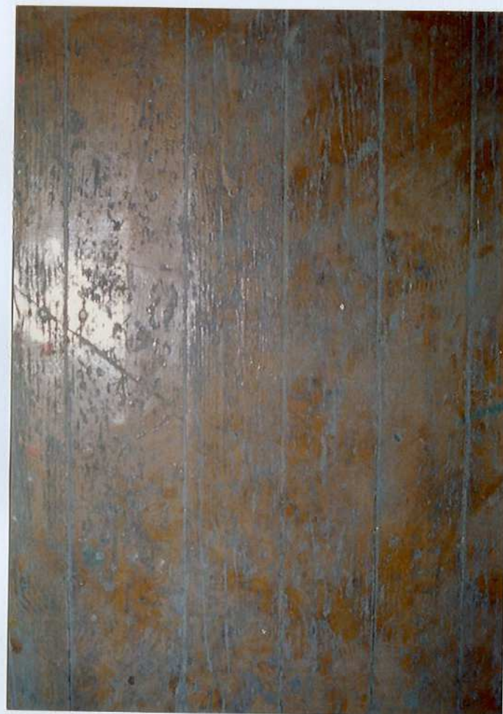
Fot. 17. Posadzka na opocznikach schodów.
