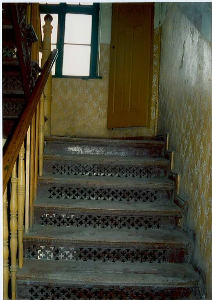
Fot. 9. Klatka schodowa.
