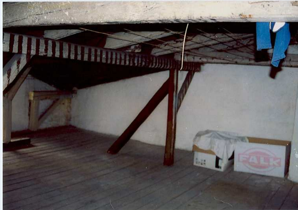
Fot. 22. Wnętrze strychu i widok na wieżbę dachową.
