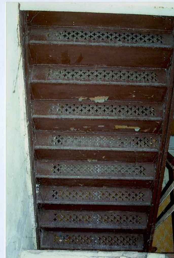
Fot. 11. Widok na spód schodów.
