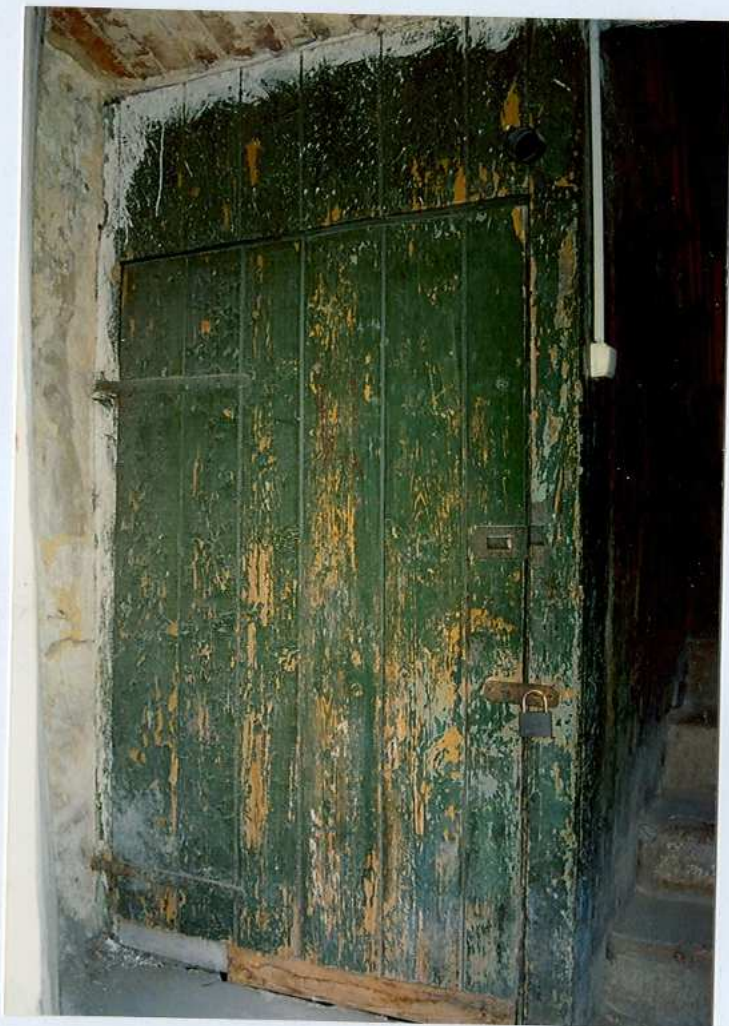
Fot. 18. Drzwi do piwnicy.
