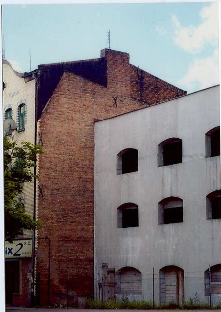
Fot. 7. Widok na ścianę szczytową od strony północno – wschodniej.
