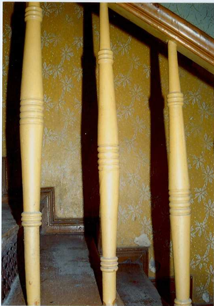
Fot. 14. Balustrada schodów.
