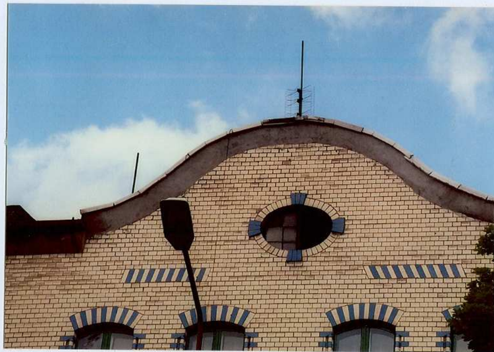
Fot. 4. Widok na szczyt z eliptycznym oknem – elewacja frontowa.
