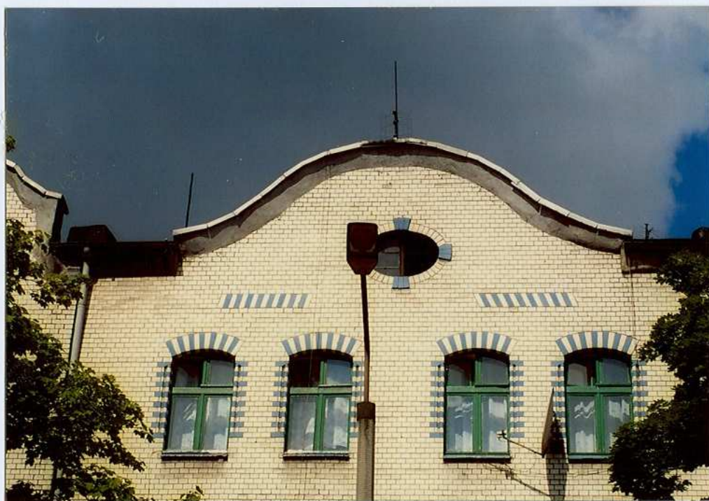
Fot. 3. Widok na szczyt – elewacja frontowa.
