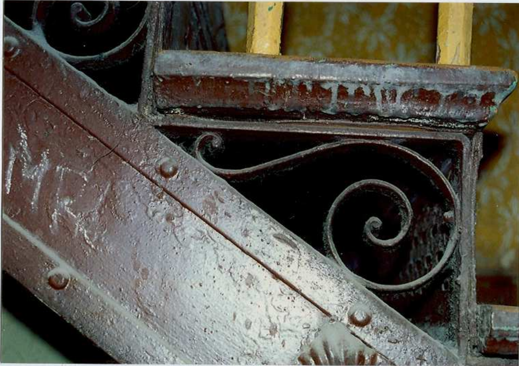
Fot. 12. Widok na stopnie schodów.
