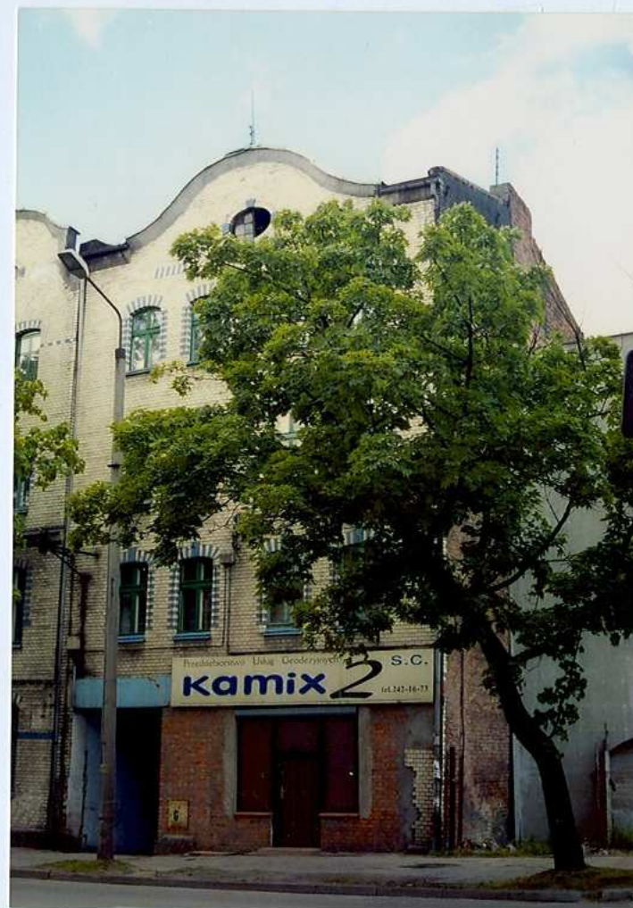
Fot. 2. Widok od północnego – wschodu na elewację frontową.
