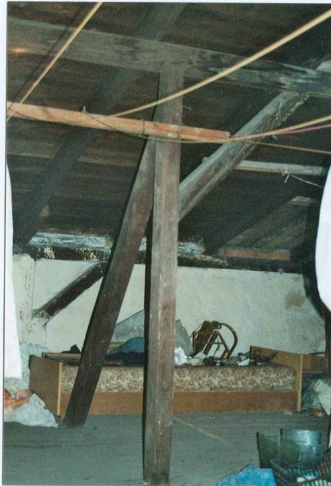
Fot. 45. Widok na więźbę dachową
