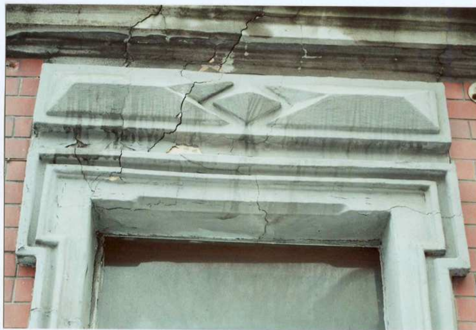
Fot. 4. Naczótek okna.
