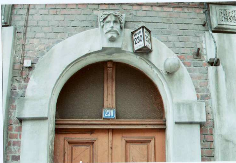
Fot. 13. Nadświetle drzwi wraz z tynkowaną opaską.
