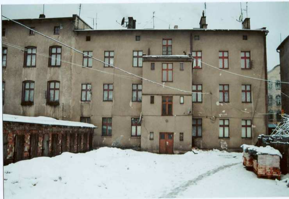
Fot. 27. Elewacja wschodnia – widok ogólny.
