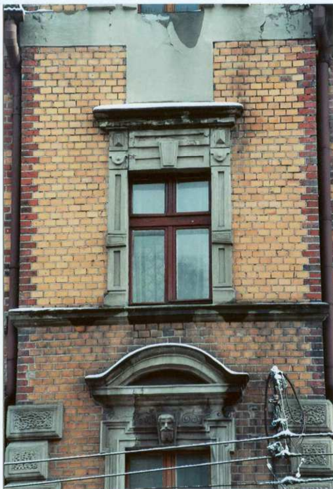
Fot. 18. Okno II piętra – ryzalit elewacji zachodniej.
