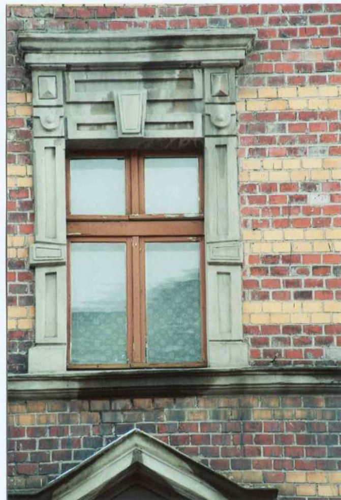
Fot. 26. Okno II piętra – elewacja zachodnia.
