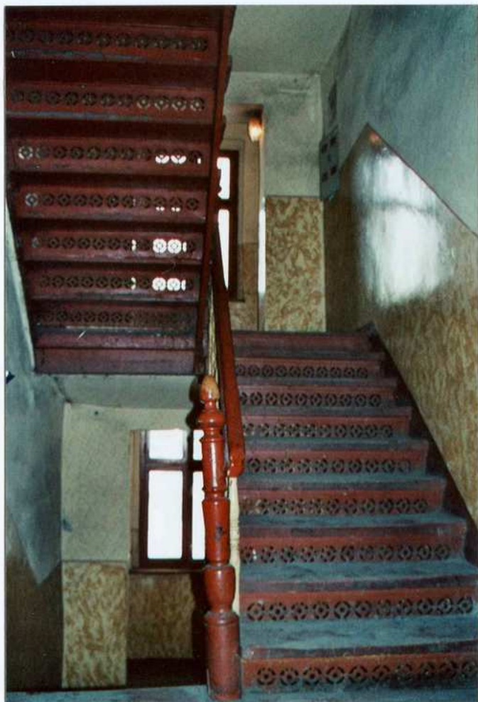
Fot. 35. Klatka schodowa – widok ogólny.
