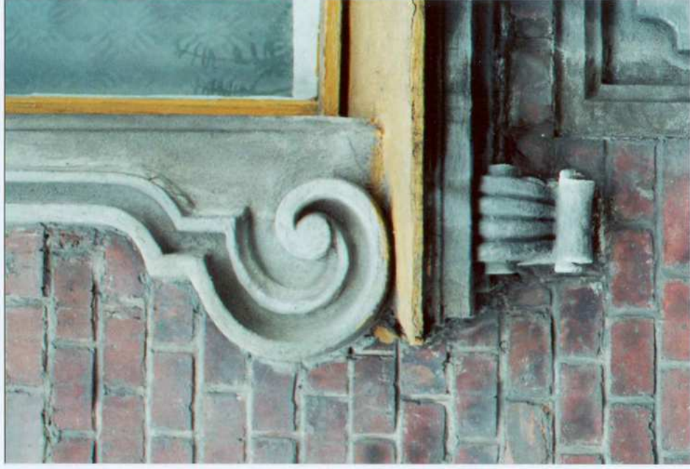
Fot. 21. Detal - dolna partia obramowania okna.
