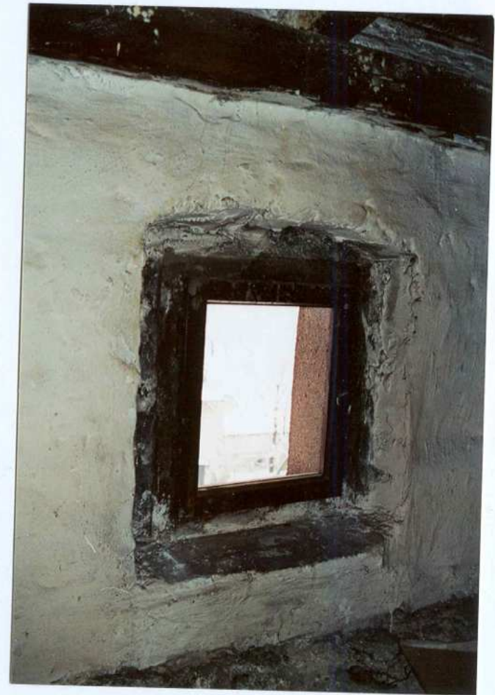
Fot. 46. Okno na strychu.
