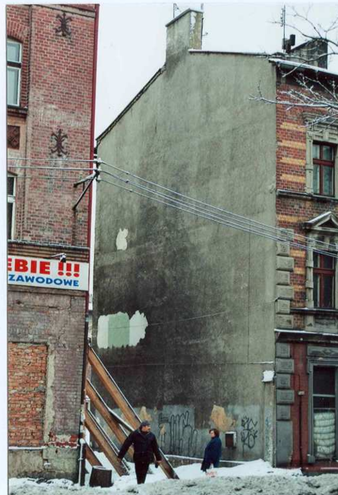
Fot. 24. Elewacja północna – widok od północnego zachodu..
