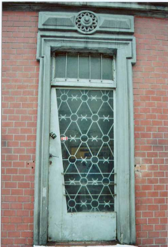
Fot. 5. Drzwi do pomieszczenia usługowego – 2 oś elewacji zachodniej.
