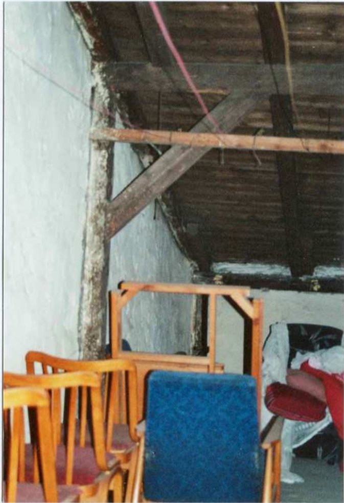
Fot. 44. Widok na więźbę dachową.
