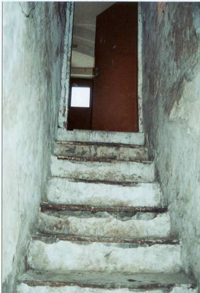
Fot. 41. Schody do piwnicy.
