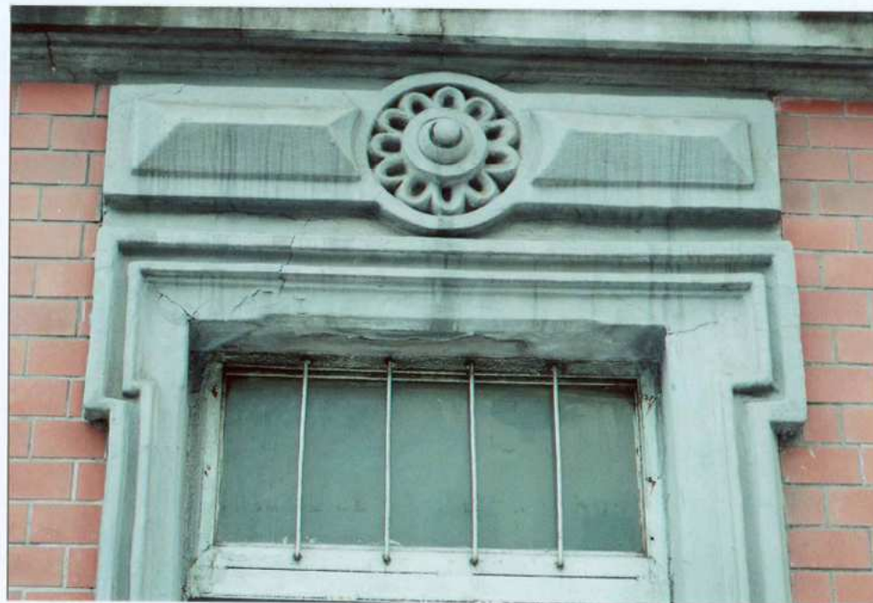
Fot. 6. Naczólek drzwi.
