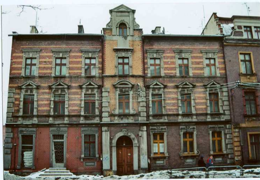
Fot. 1. Elewacja zachodnia.
