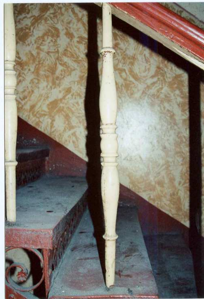
Fot. 37. Detal – tralkowa balustrada schodów.
