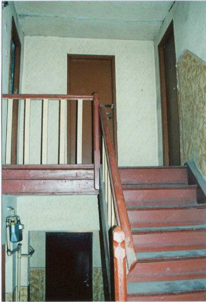
Fot. 39. Drewniane schody prowadzące na poddasze.
