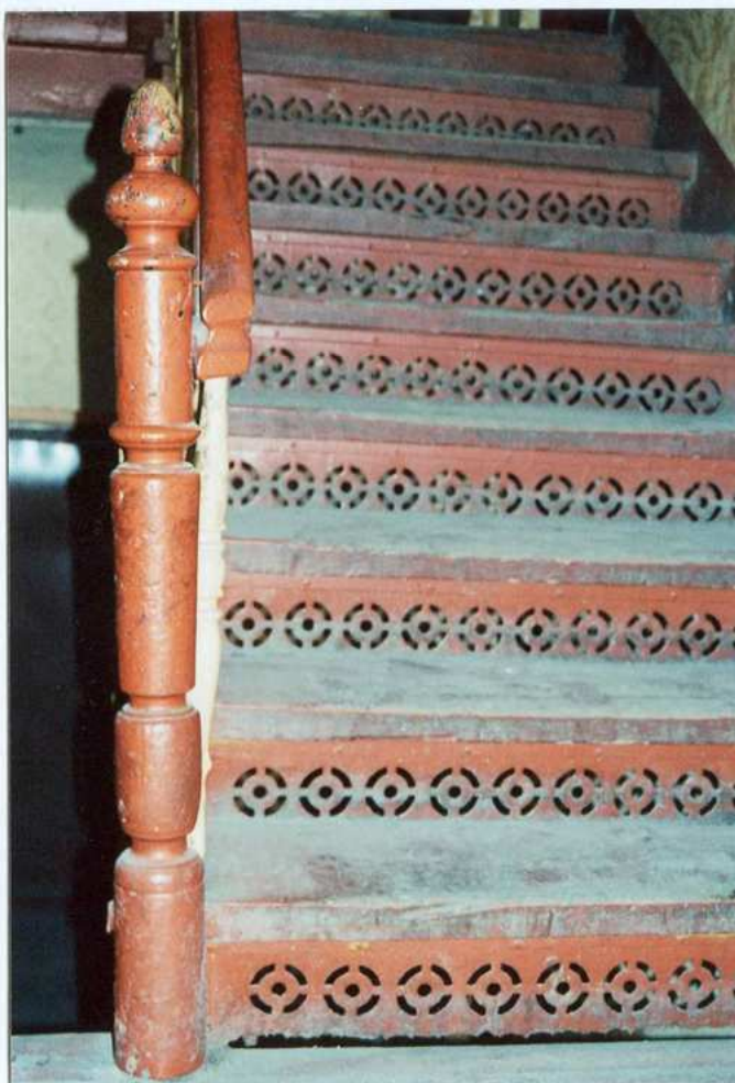
Fot. 36. Słupek balustrady zwieńczony formą szyszki i widok na podstopnice.
