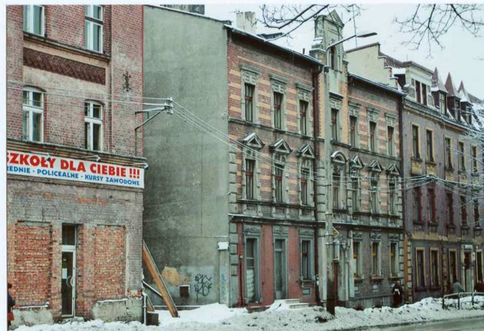
Fot. 2. Widok od strony północno – zachodniej.
