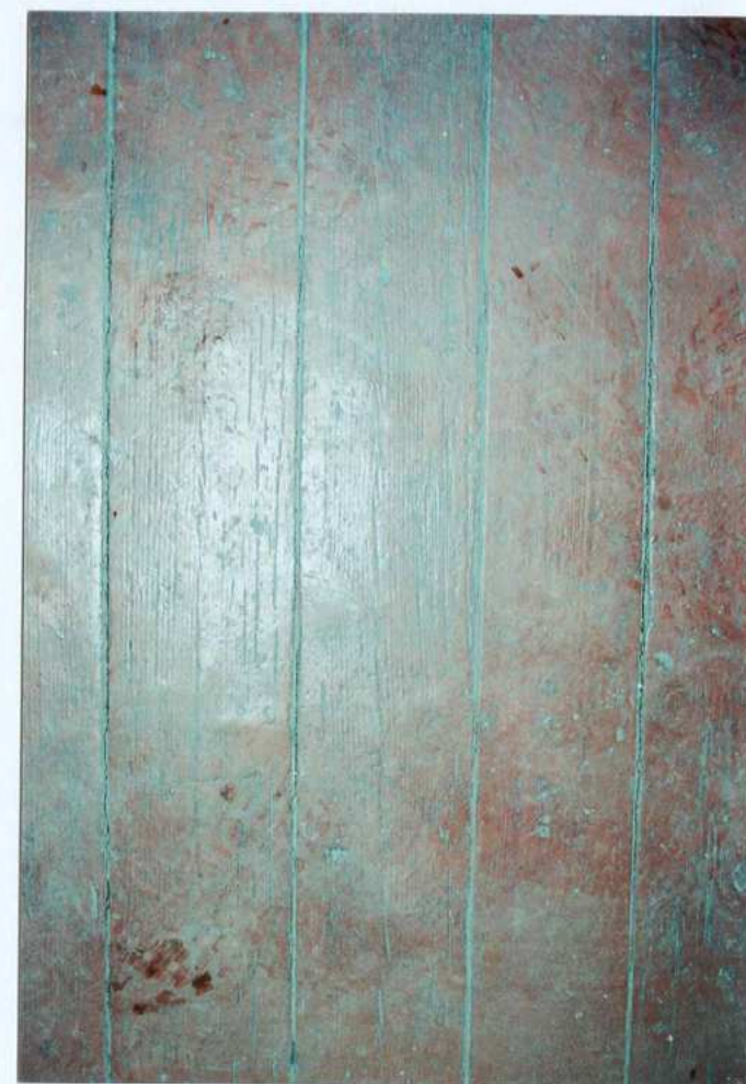
Fot. 34. Podest – deski.
