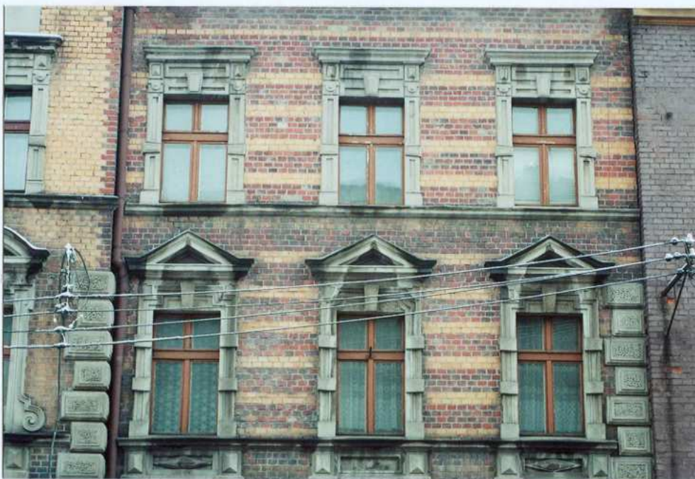
Fot. 23. Fragment elewacji zachodniej.
