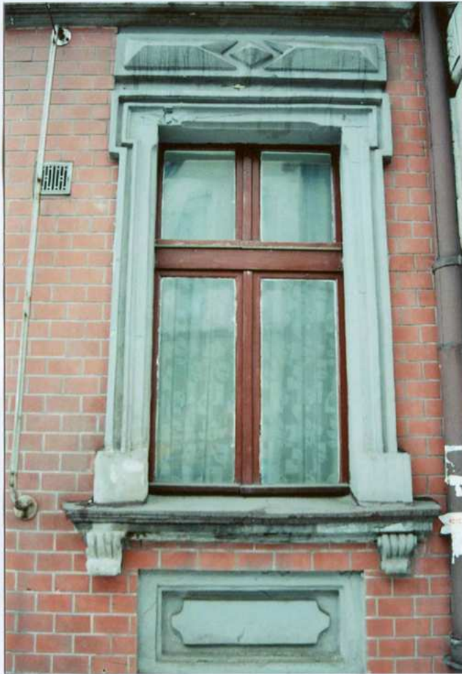
Fot. 7. Okno parteru – 3 oś elewacji zachodniej.
