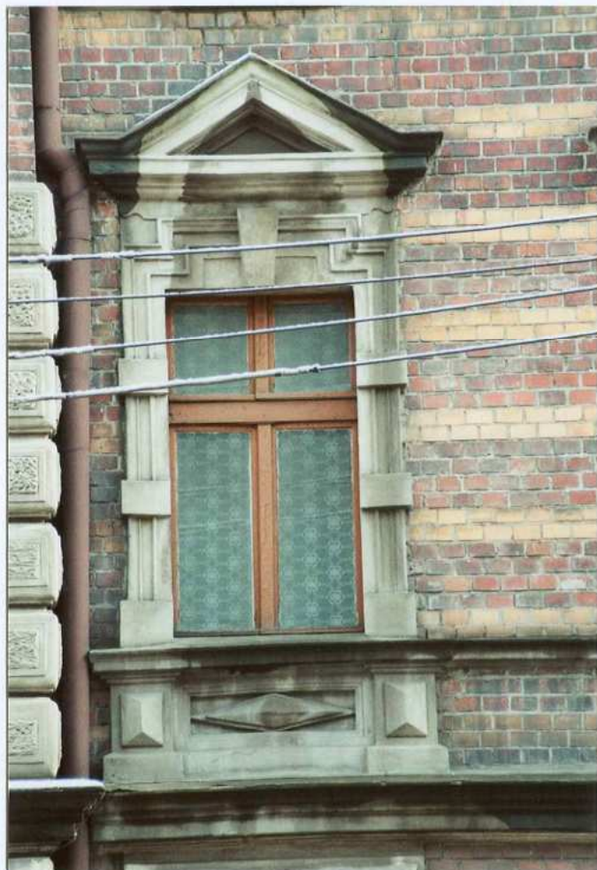
Fot. 25. Okno I piętra – elewacja zachodnia
