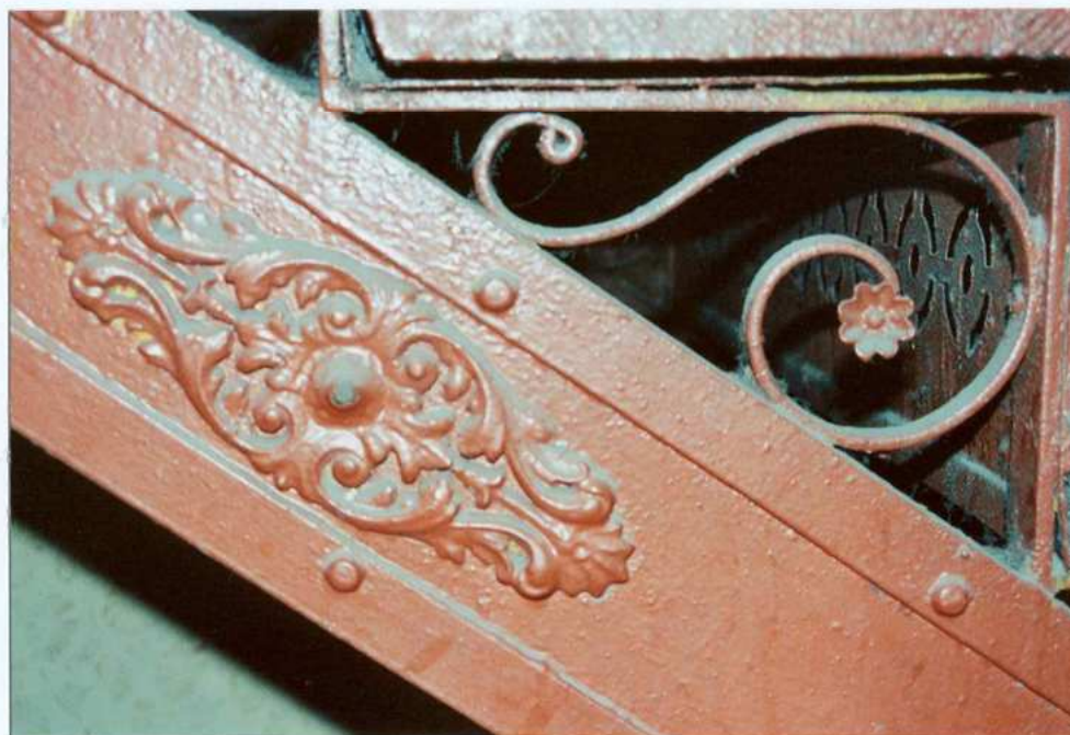
Fot. 38. Belka policzkowa schodów.
