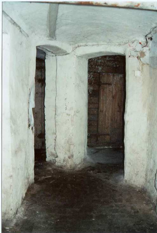
Fot. 42. Piwnica – korytarz.
