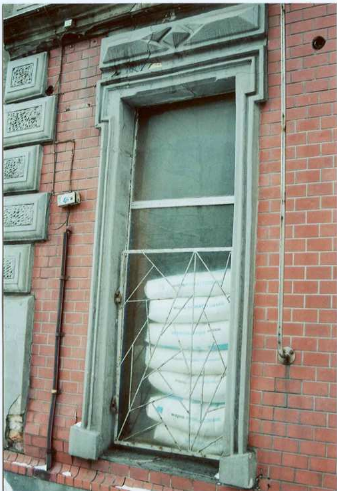
Fot. 3. Okno parteru – 1 oś elewacji zachodniej.
