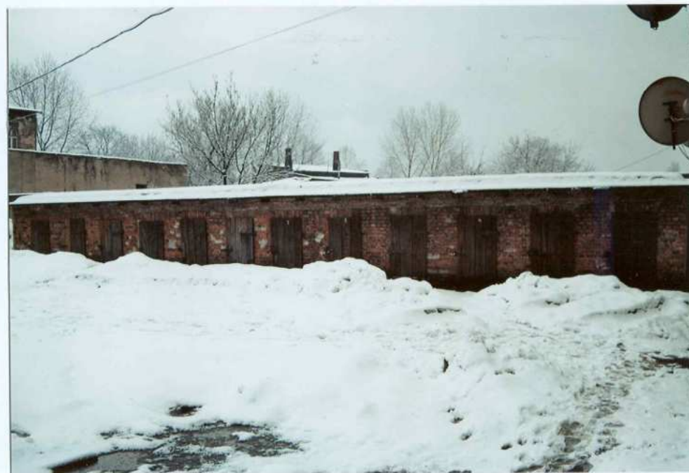
Fot. 28. Widok na zabudowania gospodarcze.
