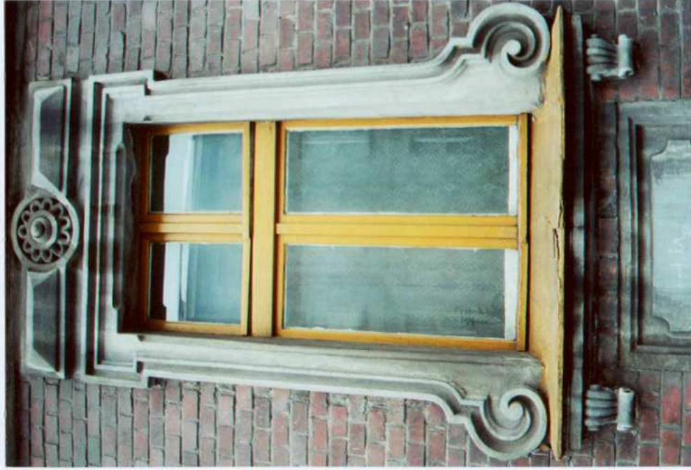
Fot. 20. Okno na parterze – 6 ós elewacji zachodniej.
