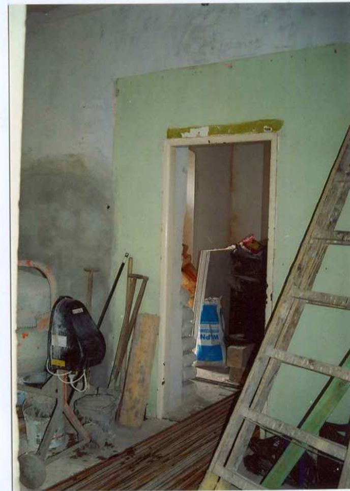
Fot. 28. Wnętrze mieszkalne.
