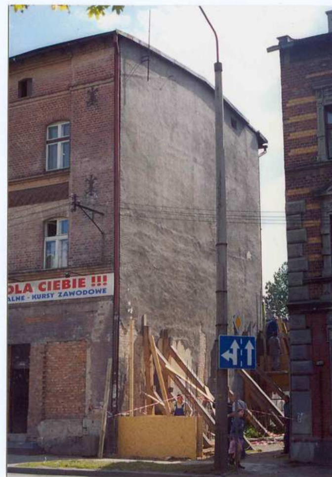
Fot. 2. Widok na ścianę szczytową od południowego – zachodu.
