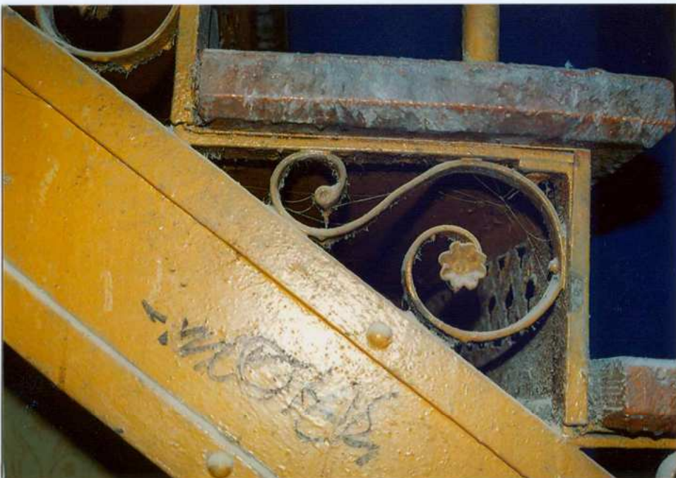
Fot. 17. Widok na stopnie schodów.
