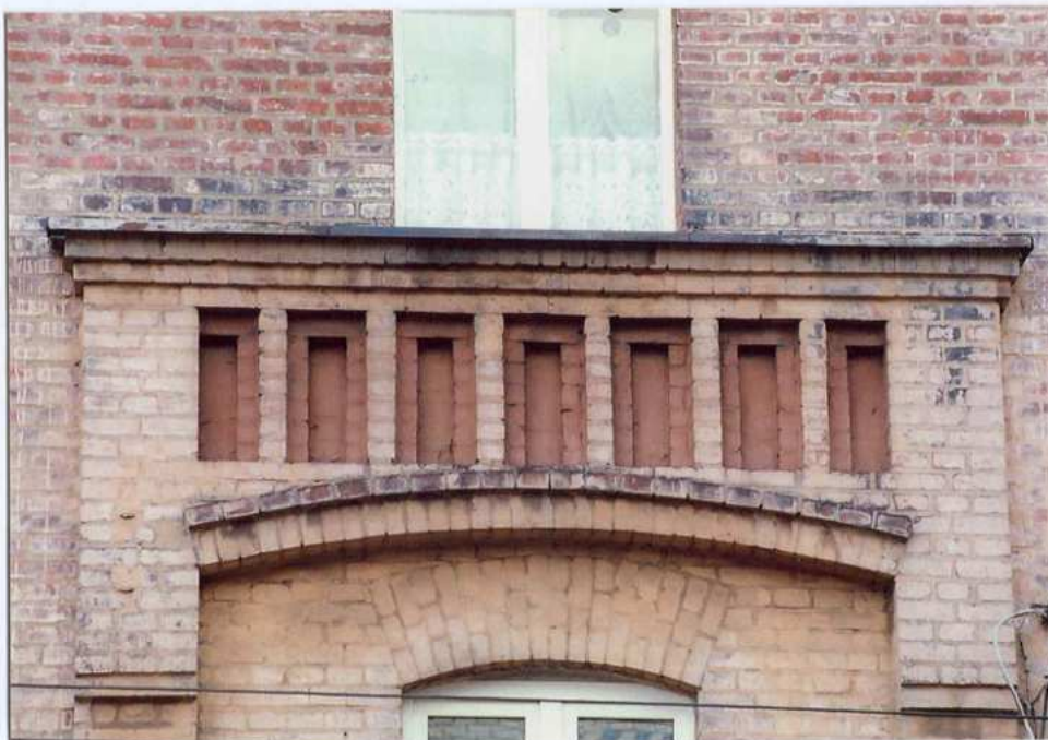
Fot. 4. Widok na pseudobalkon – elewacja frontowa.
