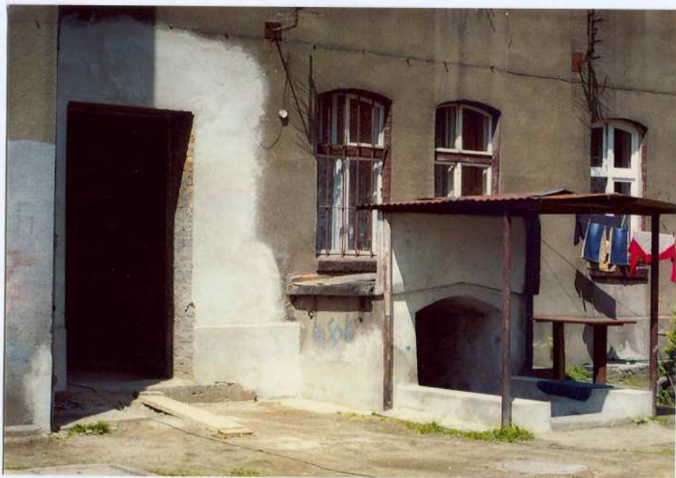
Fot. 12. Brama przejazdowa oraz zejście do piwnicy – elewacja tylna.
