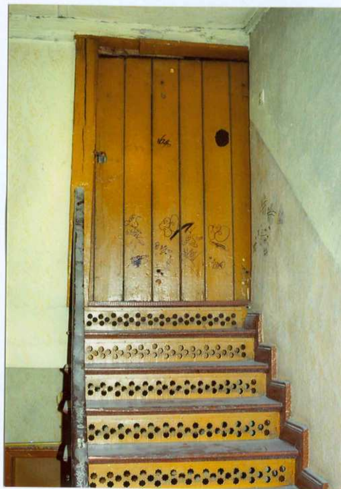
Fot. 30. Drzwi na strych.
