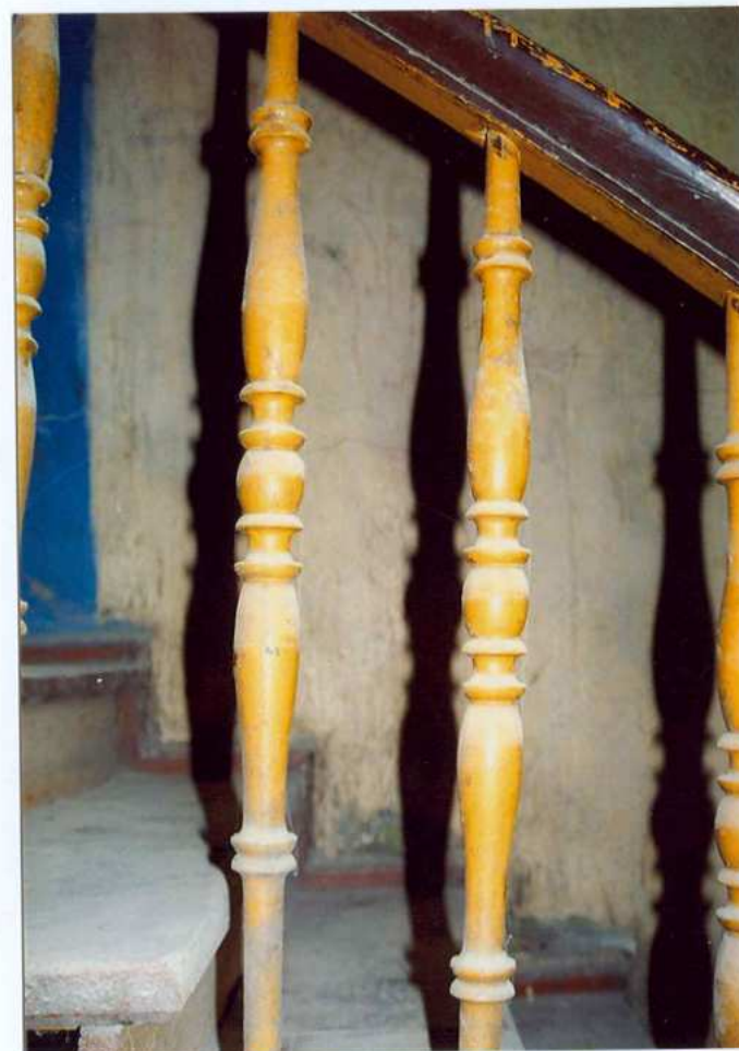
Fot. 15. Balustrada schodów.
