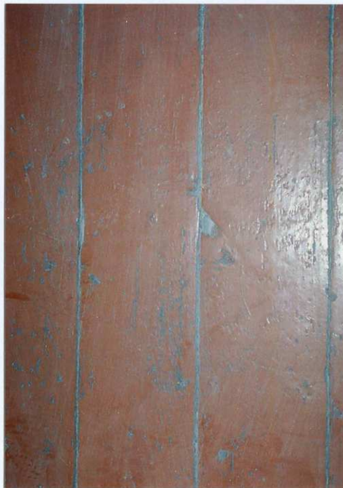
Fot. 23. Posadzka na spocznikach schodów.
