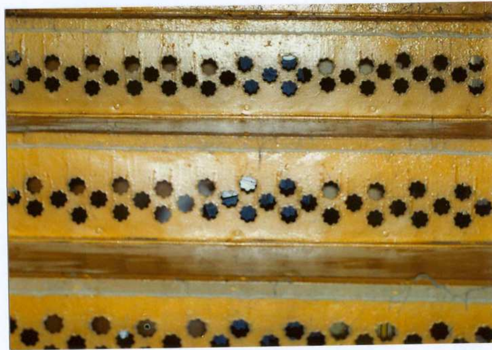
Fot. 21. Ozdobne podstopnice – schody na strych.
