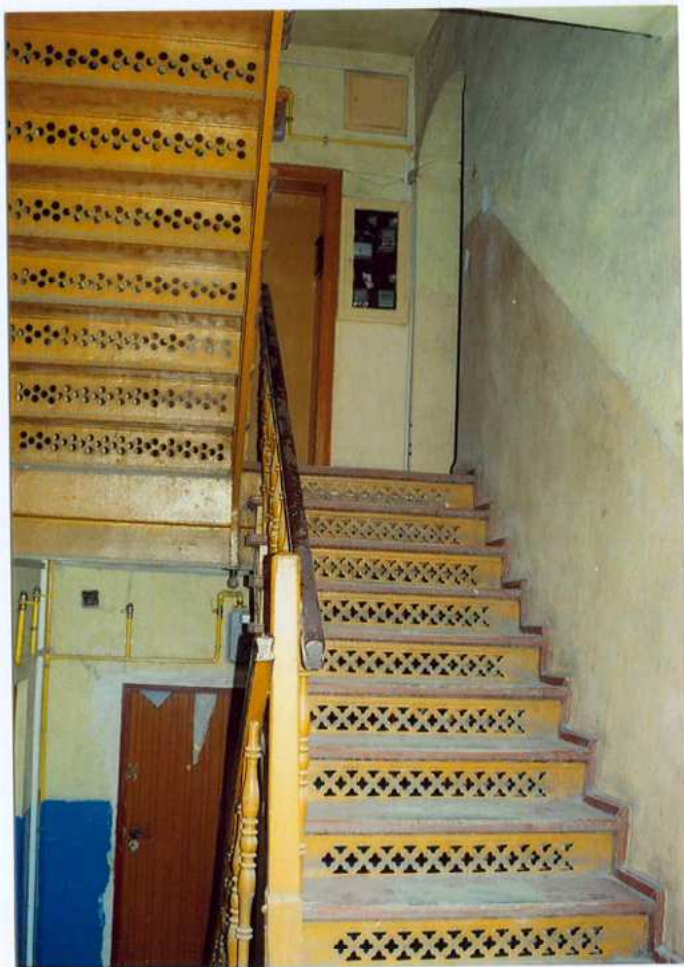
Fot. 14. Widok na klatkę schodową.
