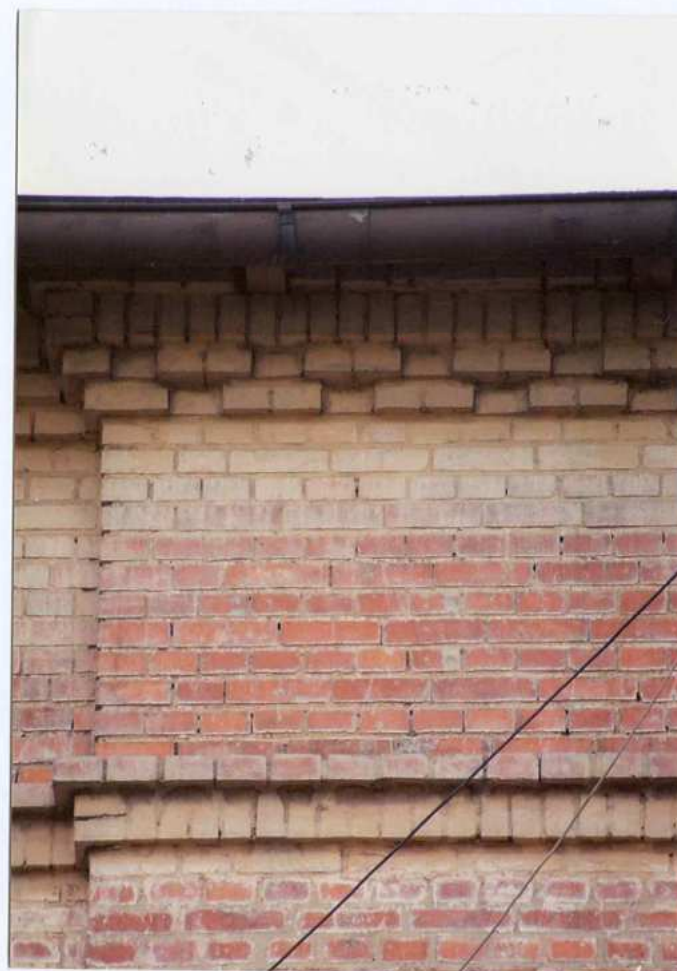
Fot. 9. Widok na gzyms wieńczący.
