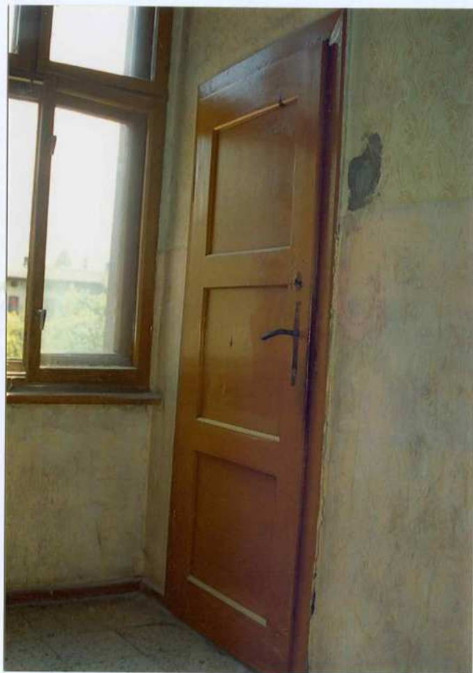
Fot. 29. Drzwi do toalety.
