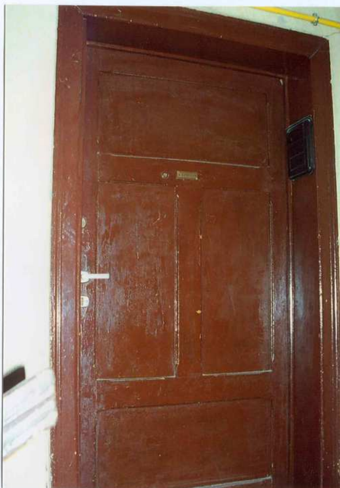
Fot. 27. Drzwi do mieszkania jednoskrzydłowe.
