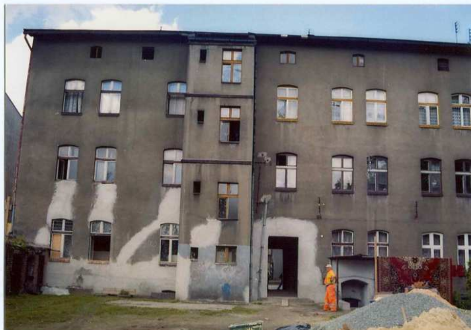
Fot. 10. Elewacja tylna – wschodnia.
