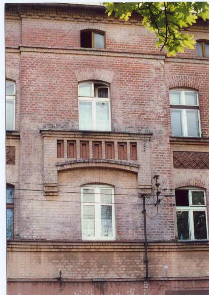
Fot. 5. Widok na pseudobalkon – elewacja frontowa.
