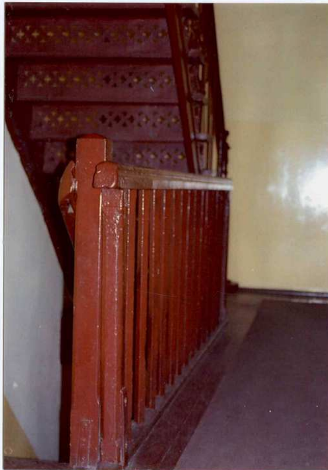
Fot. 21. Balustrada schodów i widok na schody prowadzące na strych.
