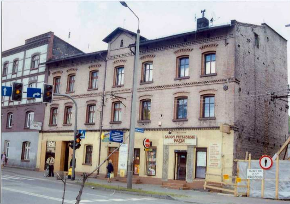
Ryc. 1. Widok ogólny od południowego – zachodu.
