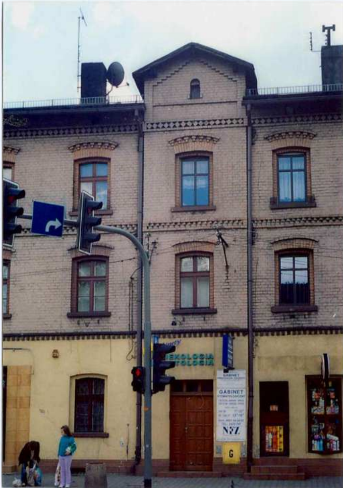
Fot. 3. Widok na ryzalit – elewacja zachodnia.
