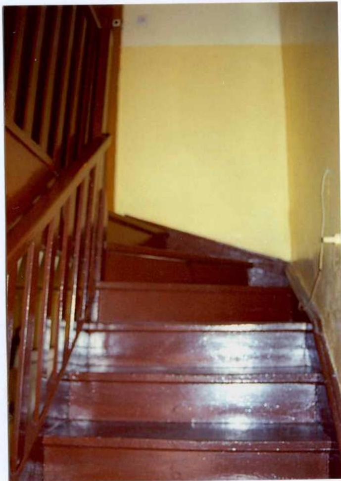
Fot. 20. Widok na górną partię schodów prowadzących z Pierwszego piętra na drugie.
