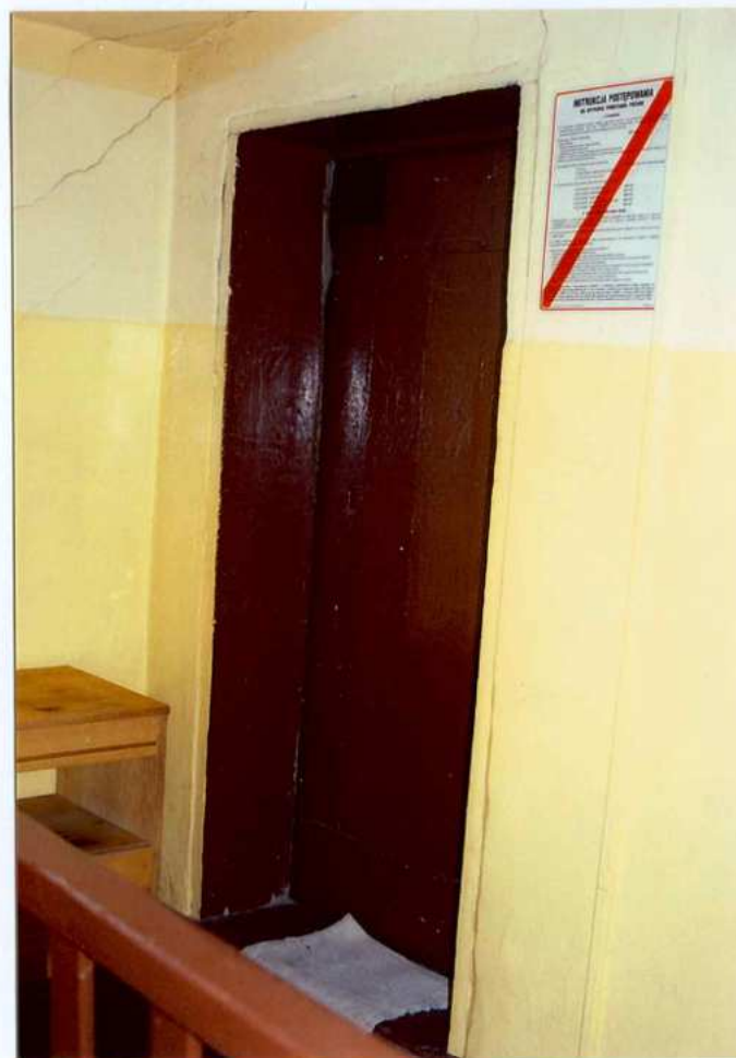
Fot. 31. Drzwi na strych.
