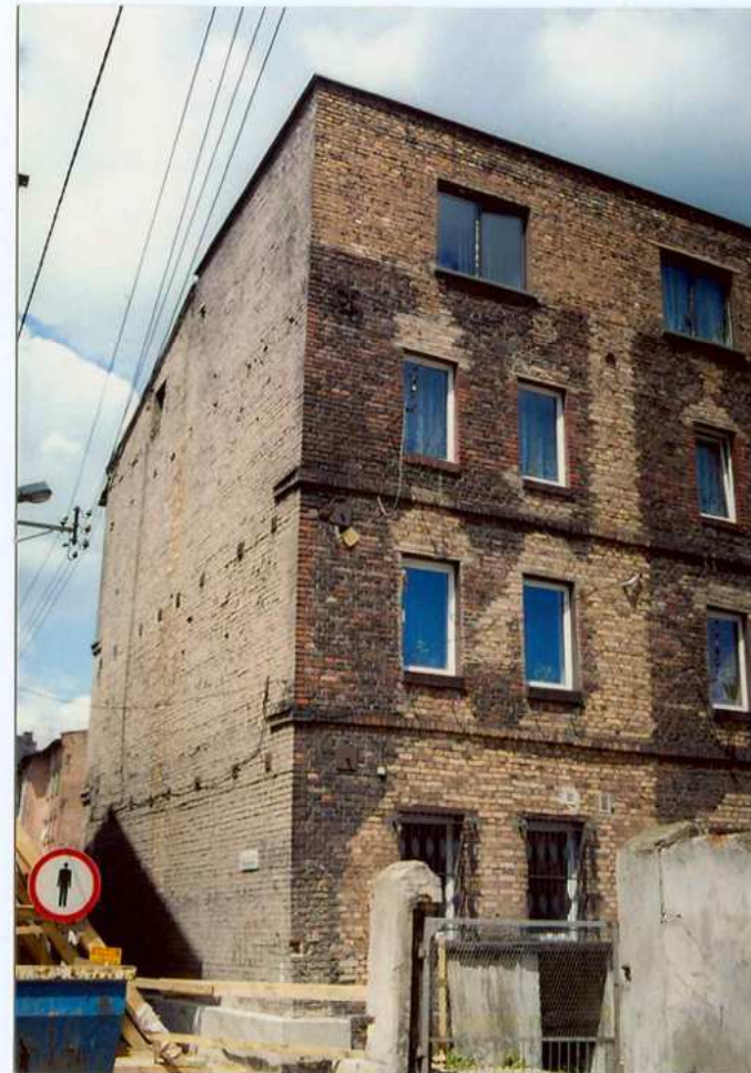
Fot. 10. Widok na ścianę szczytową od południowego – wschodu.
