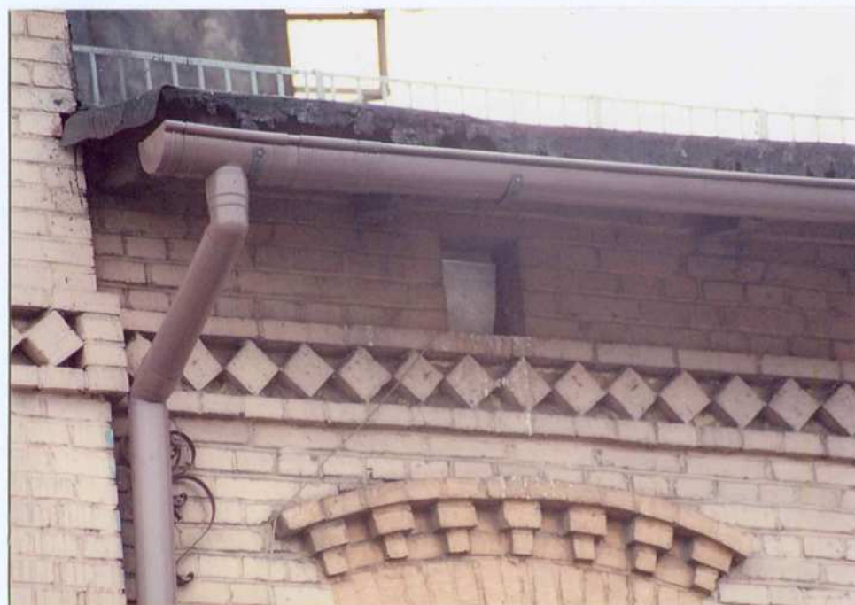
Fot. 8. Widok na gzyms wieńczący.
