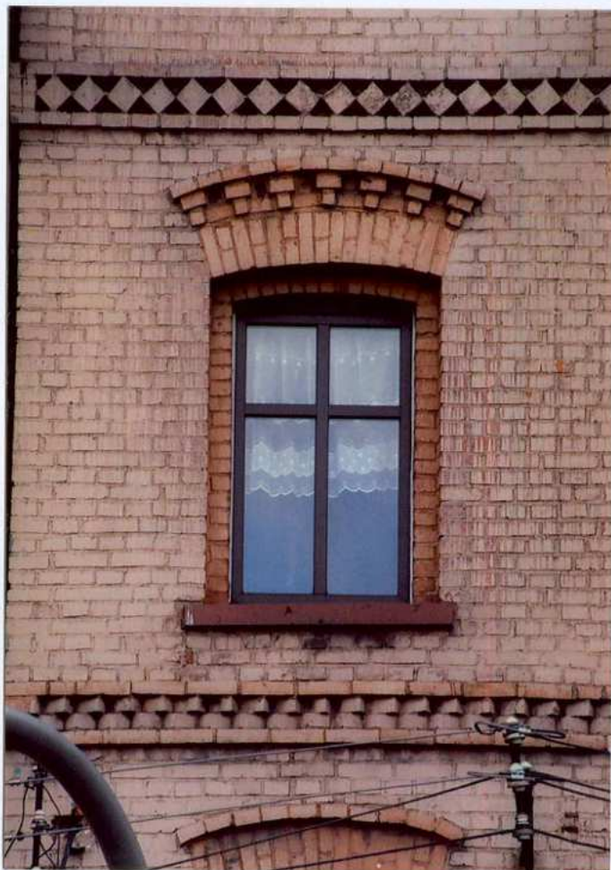
Fot. 7. Okno – elewacja frontowa.
