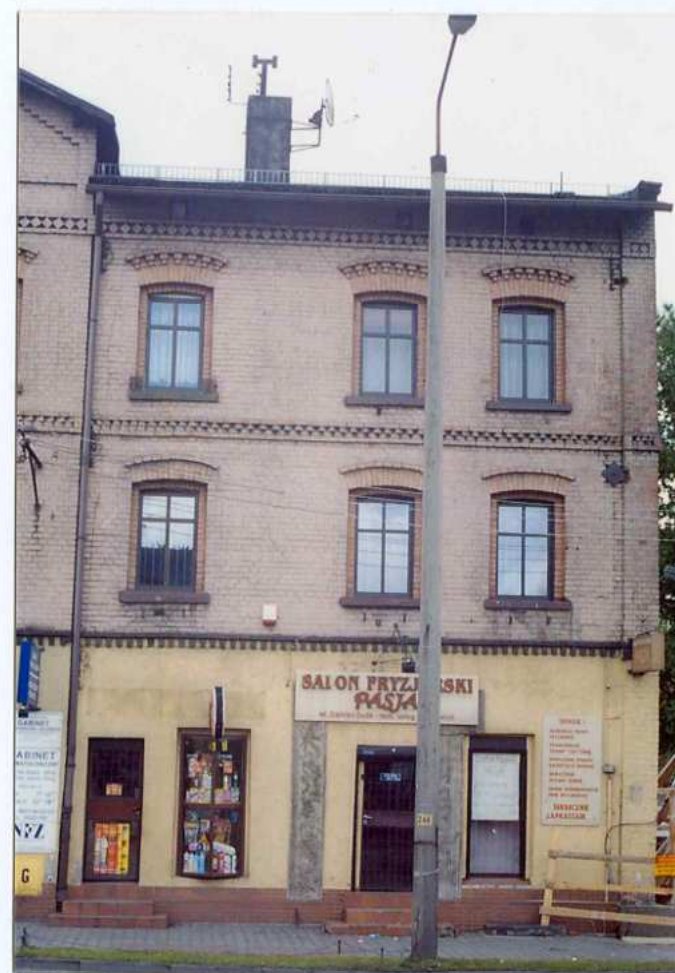
Fot. 6. Południowa strona elewacji zachodniej.
