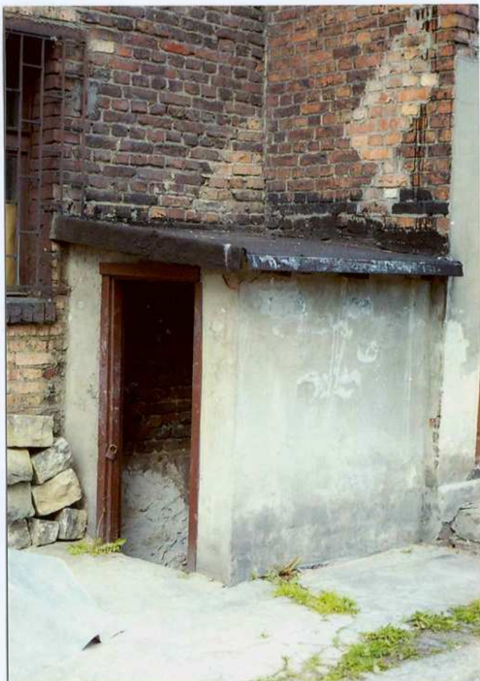
Fot. 15. Zejście do piwnicy – elewacja tylna, część środkowa.
