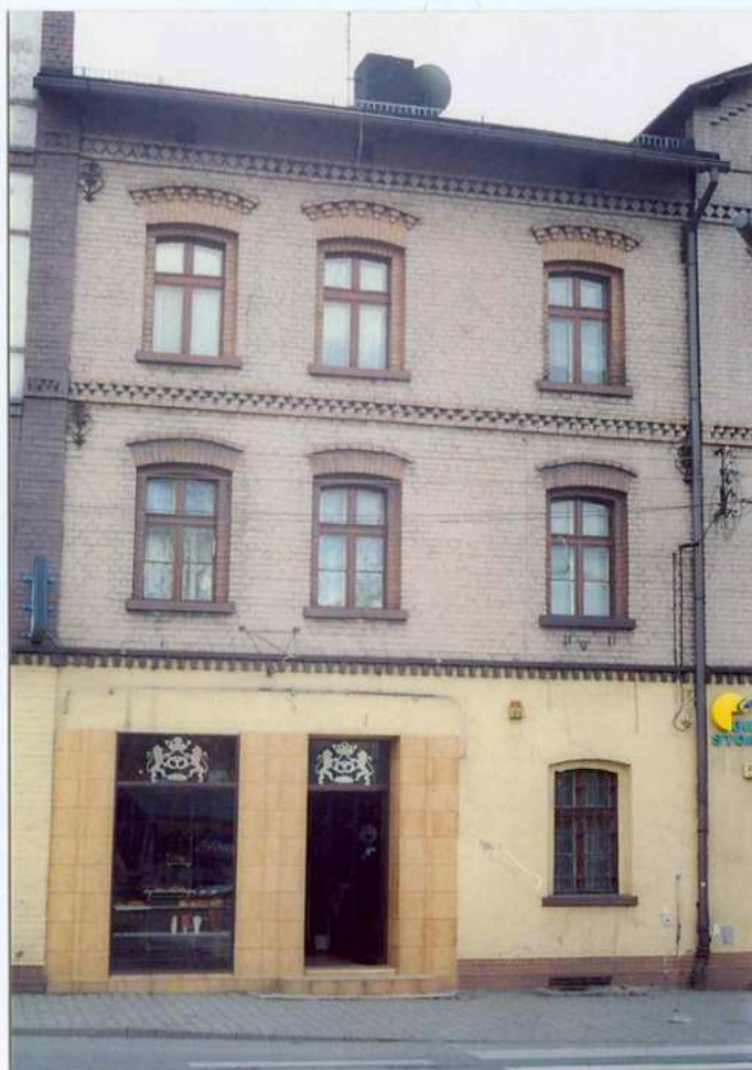
Fot. 5. Północna strona elewacji zachodniej.
