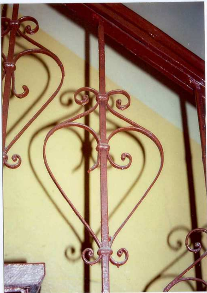
Fot. 25. Balustrada schodów prowadzących na strych.
