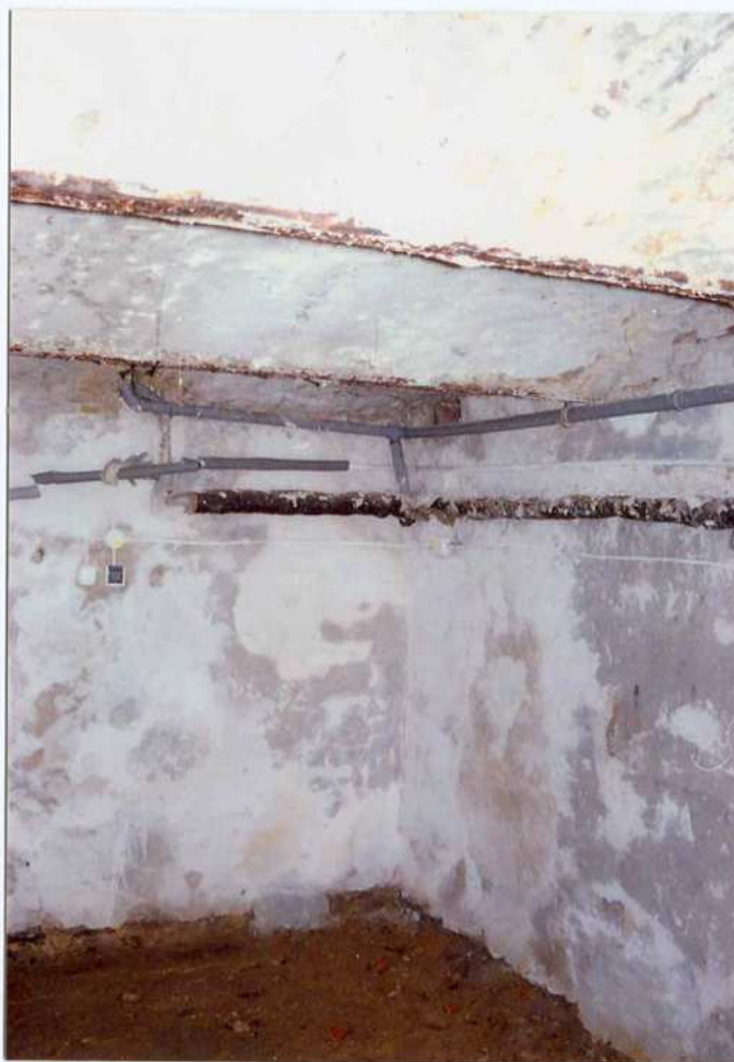
Fot. 28. Wnętrze w piwnicy.
