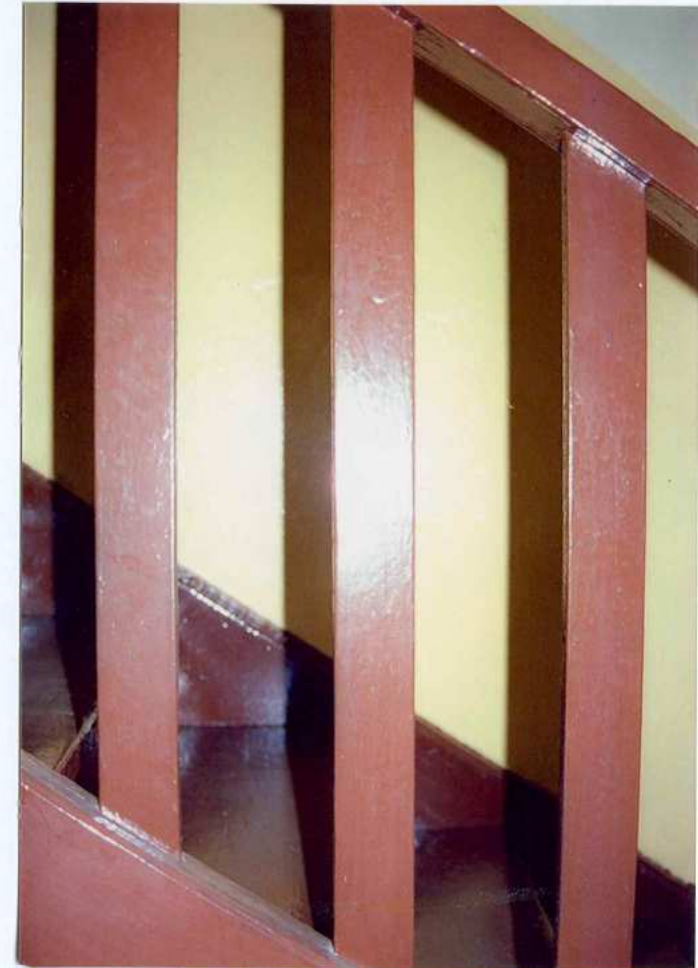
Fot. 19. Balustrada schodów.
