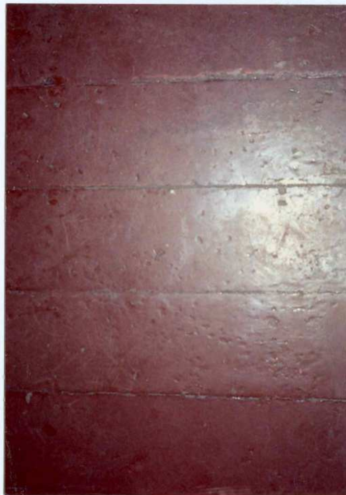
Fot. 26. Podłoga na opocznikach.
