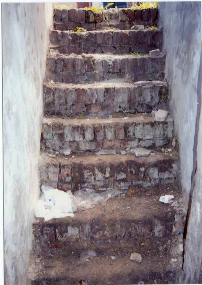
Fot. 27. Schody do piwnicy.
