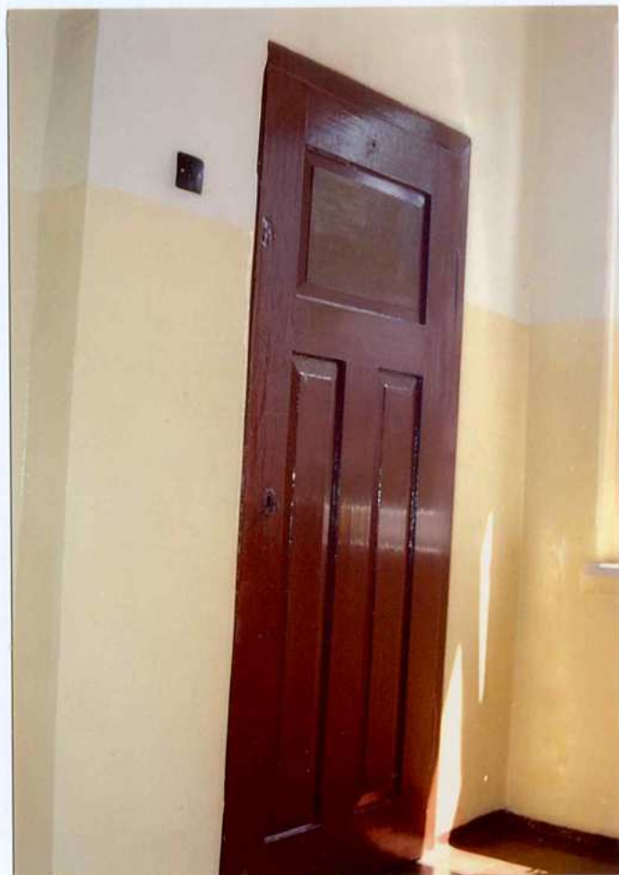
Fot. 30. Drzwi do toalety..
