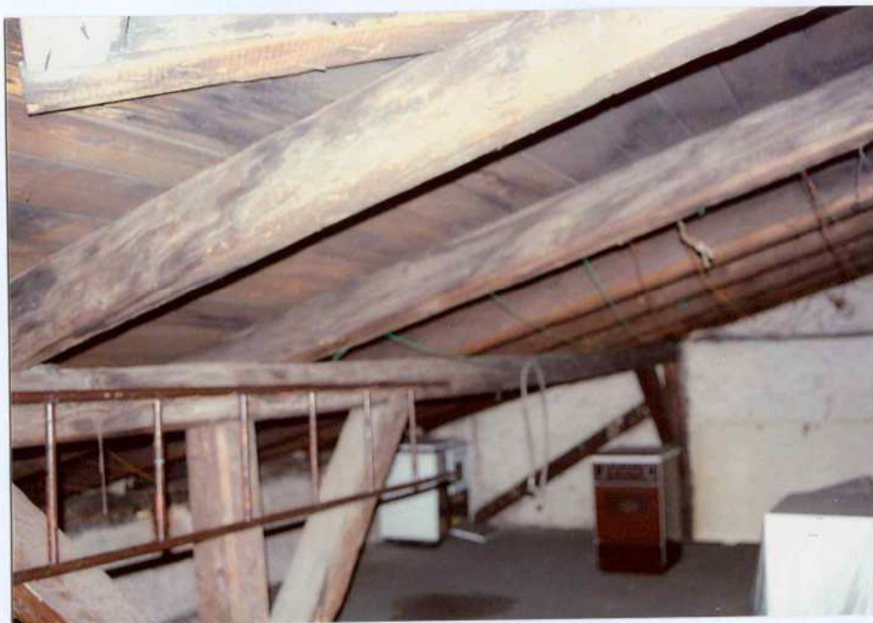
Fot. 32. Strych – widok na więźbę dachową.
