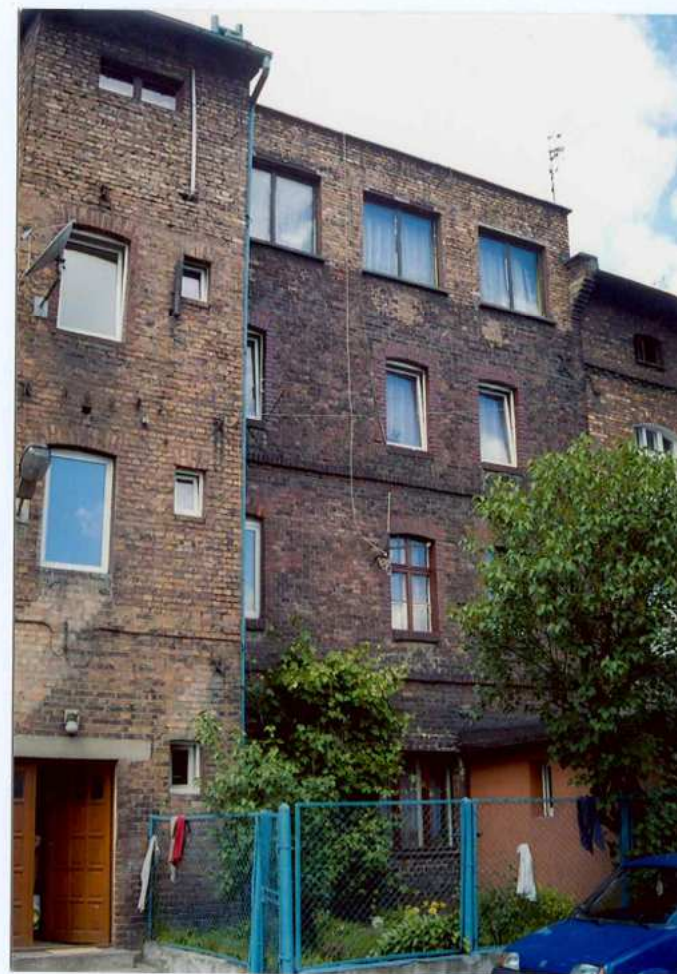
Fot. 14. Strona północna elewacji wschodniej.
