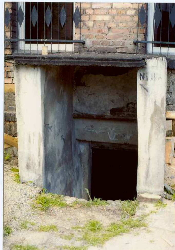
Fot. 16. Zejście do piwnicy – elewacja tylna, strona południowa.
