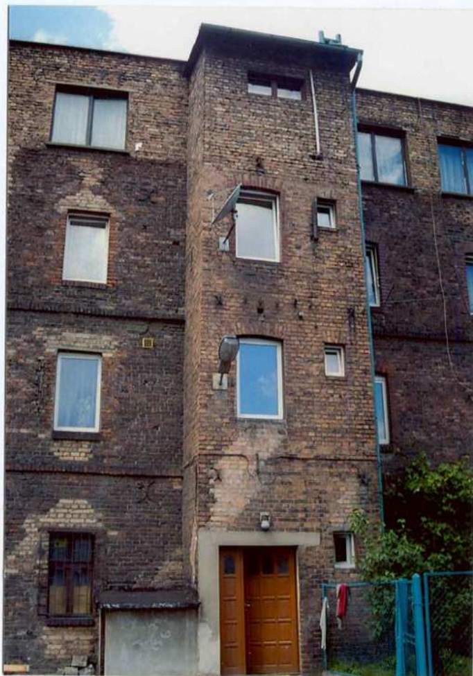
Fot. 13. Ryzalit – elewacja tylna.
