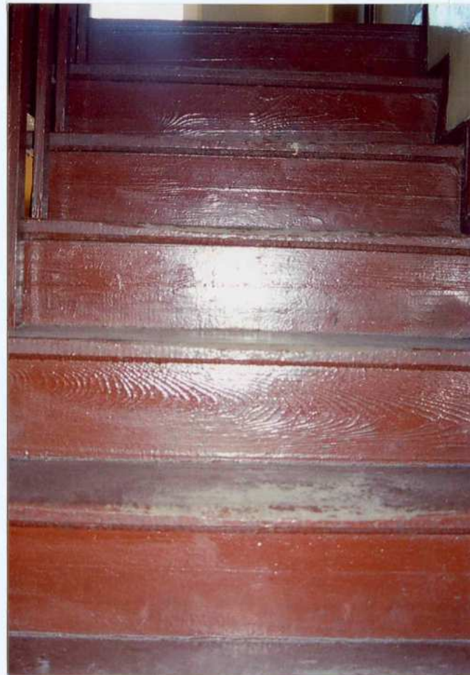
Fot. 18. Stopnie klatki schodowej.
