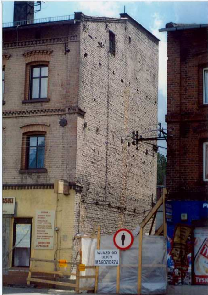
Fot. 9. Widok na ścianę szczytową od południowego – zachodu.
