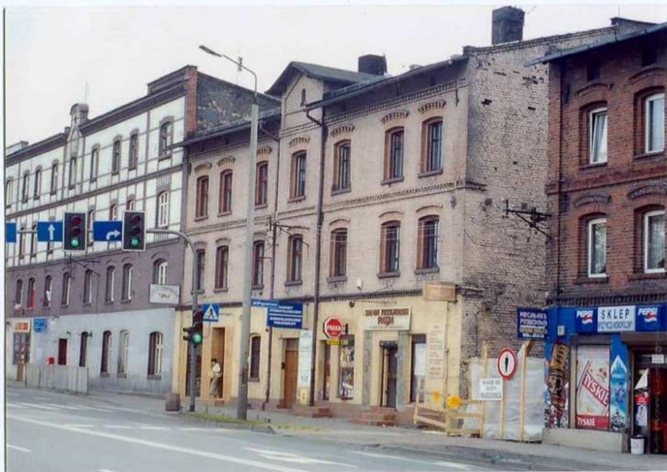
Fot. 1. Widok ogólny od południowego zachodu na elewację frontową.
