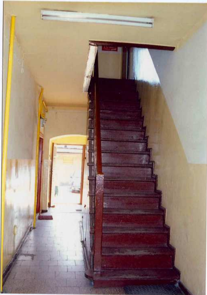
Fot. 17. Widok na klatkę schodową.
