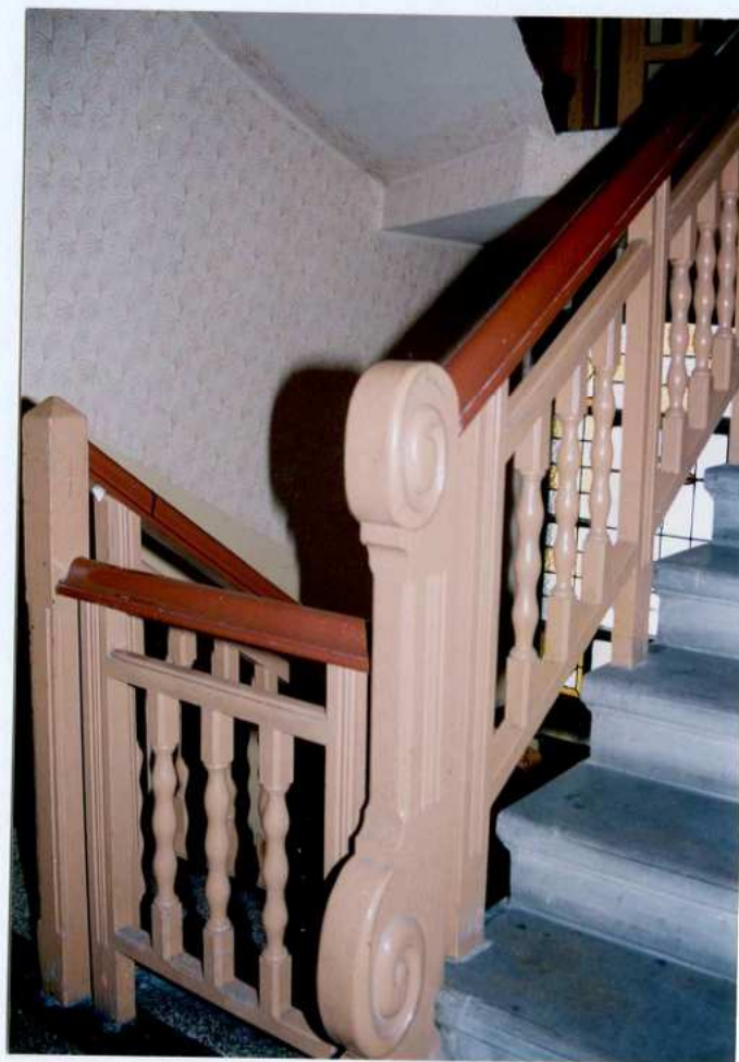
Fot. 38. Balustrada schodów – widok na słupek.
