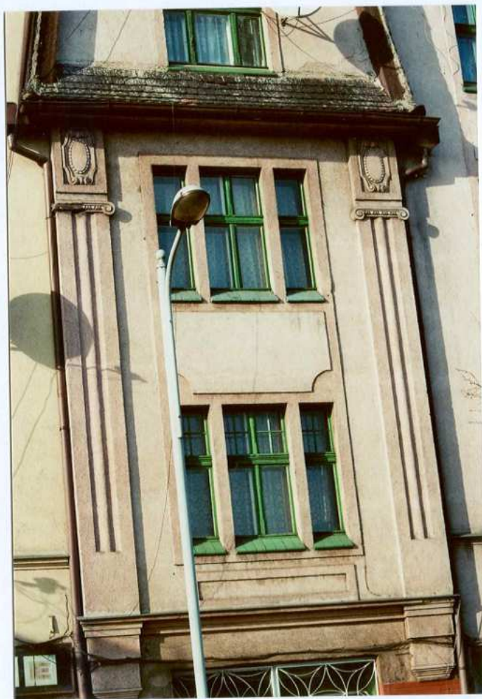
Fot. 25. Okna w wysunięciu w środkowej partii elewacji południowej, skrzydła pld.
