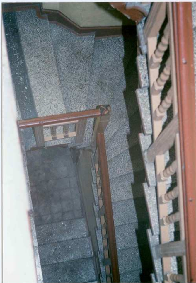
Fot. 37. Klatka schodowa – widok z góry.
