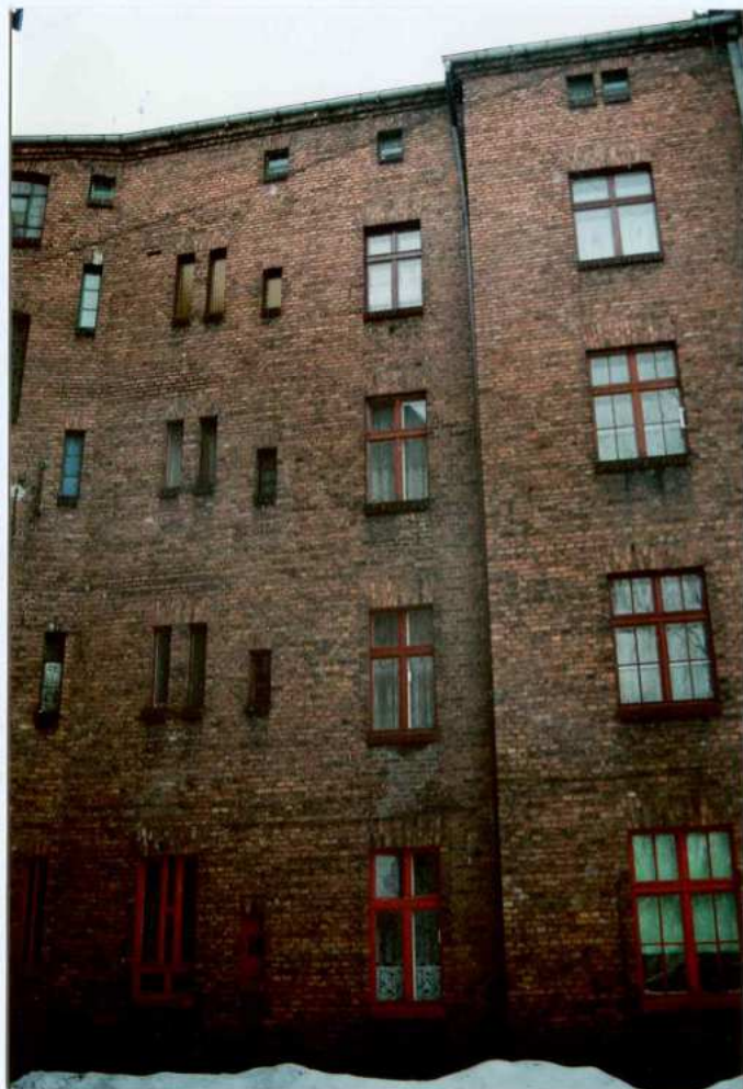
Fot. 30. Elewacja wschodnia, skrzydło północne.
