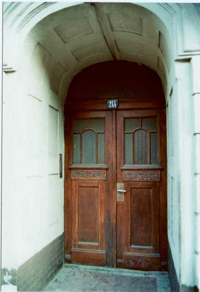
Fot. 13. Drzwi wejściowe – elewacja zachodnia, skrzydło północne.
