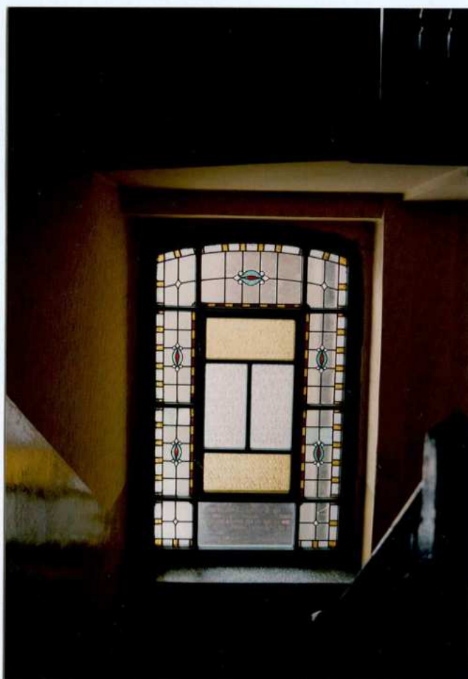
Fot. 35. Okno pomiędzy I i II piętrem z częściowo zachowanym witrażem.
