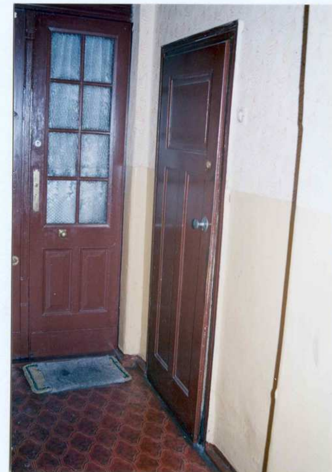
Fot. 45. Drzwi do toalety.
