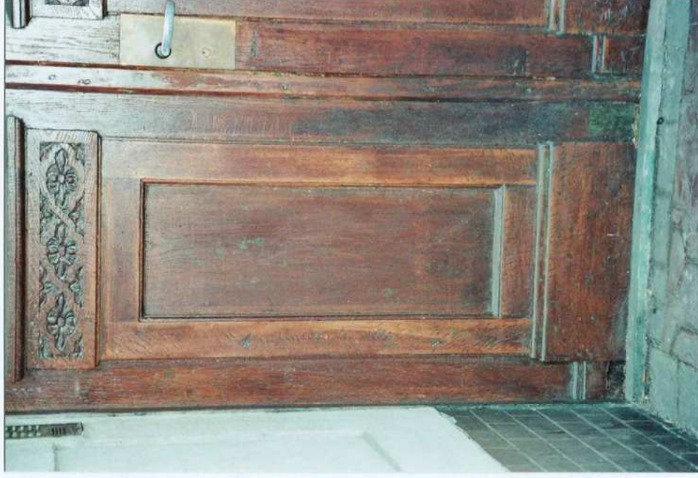
Fot. 16. Płycazna drzwi - partia dolna.
