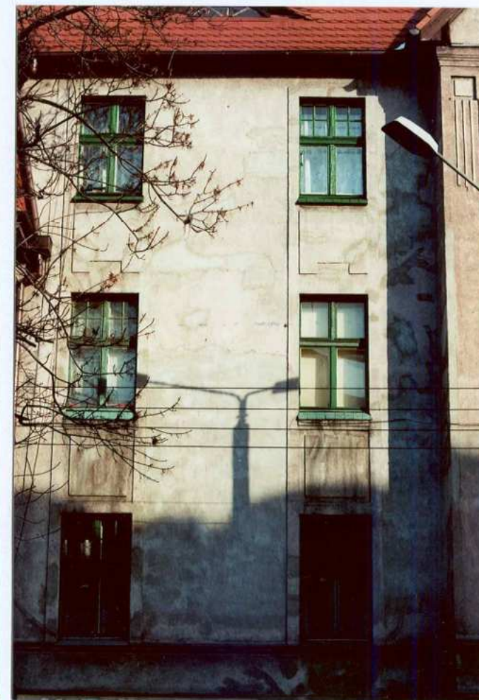
Fot. 9. Środkowa część elewacji zachodniej.
