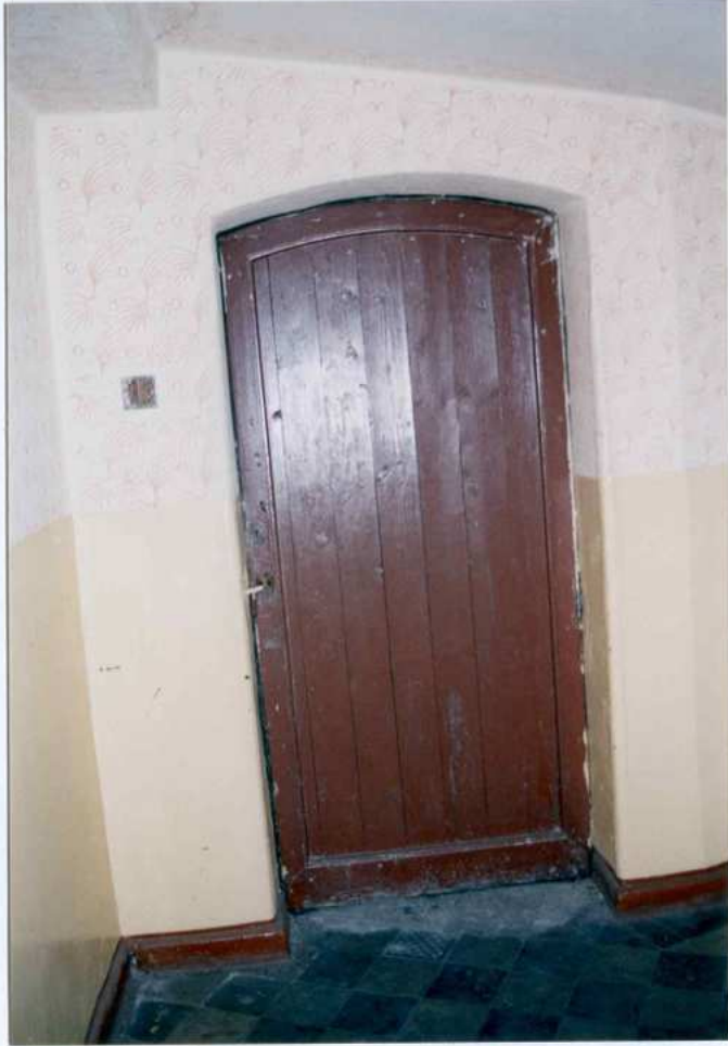
Fot. 46. Drzwi na strych.
