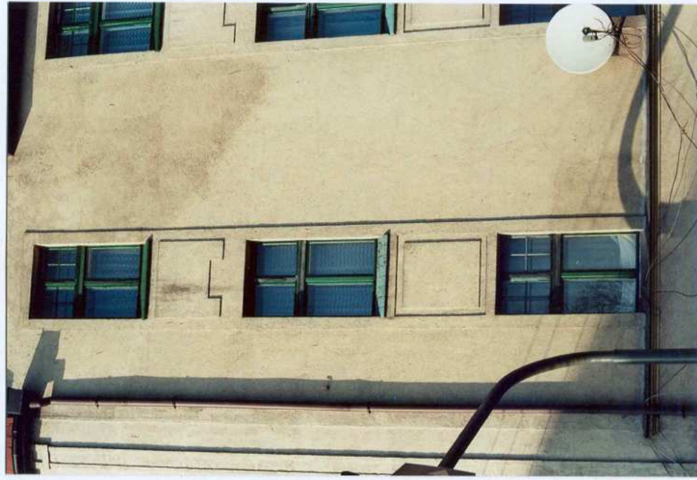
Fot. 24. Okna - 1 i 2 os elewacji płd., skrzydło płd.
