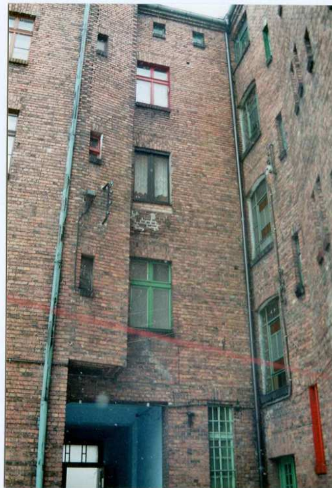
Fot. 33. Fragment elewacji północnej, skrzydło południowe.
