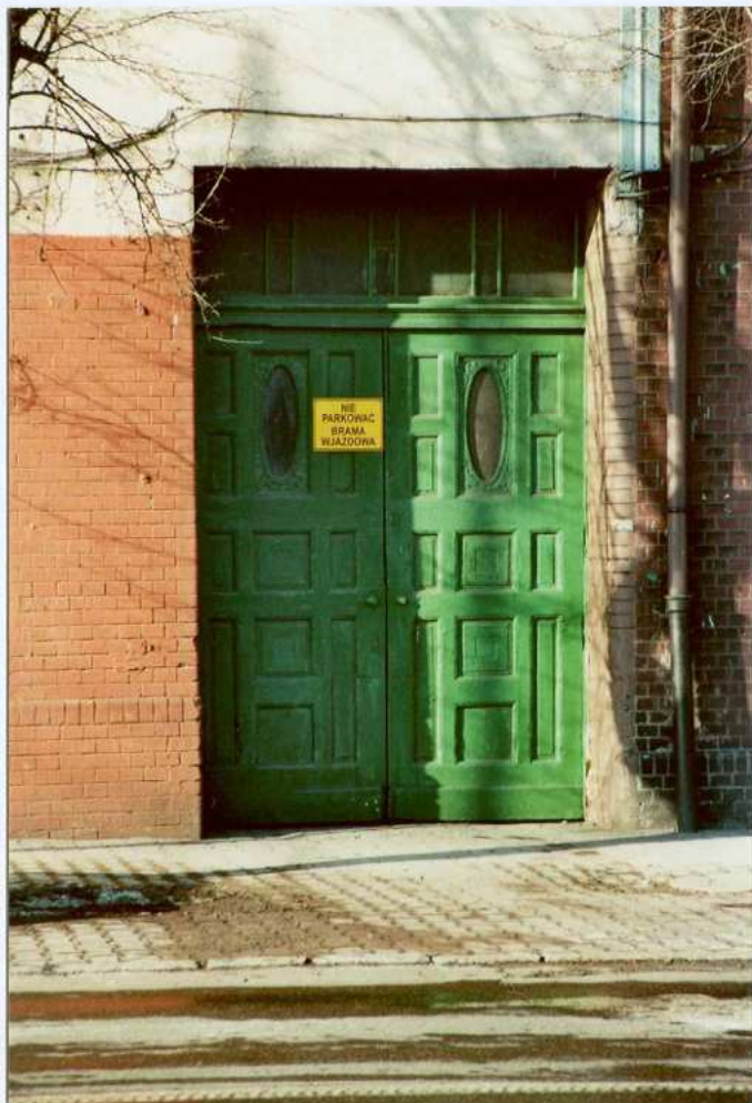
Fot. 28. Brama –elewacja południowa, skrzydło południowe.
