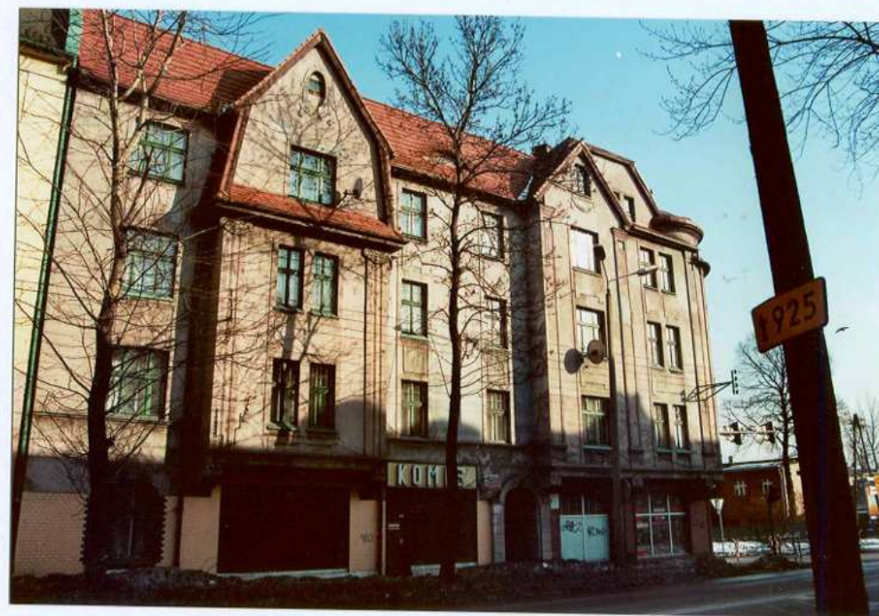
Fot. 2. Elewacja południowa, skrzydło południowe.
