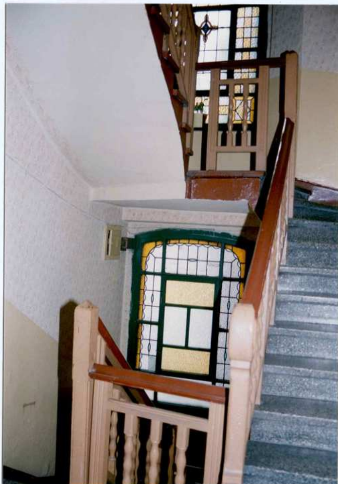
Fot. 34. Klatka schodowa - widok ogólny. W tle widoczne okno witrażowe.
