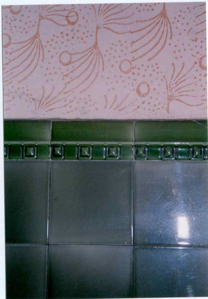
Fot. 41. Górna partia płytek ściennych.
