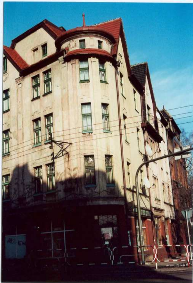
Fot. 18. Widok na narożnik budynku – styk elewacji zachodniej i południowej.
