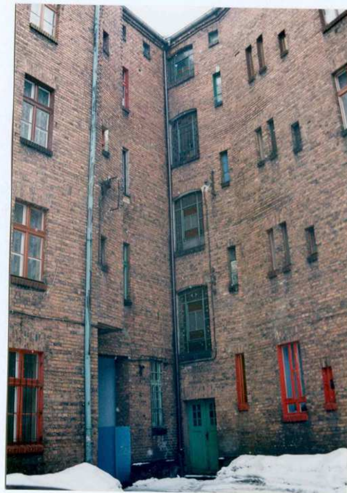
Fot. 31. Styk elewacji wschodniej (skrzydło północne) i elewacji północnej (skrzydło południowe).
