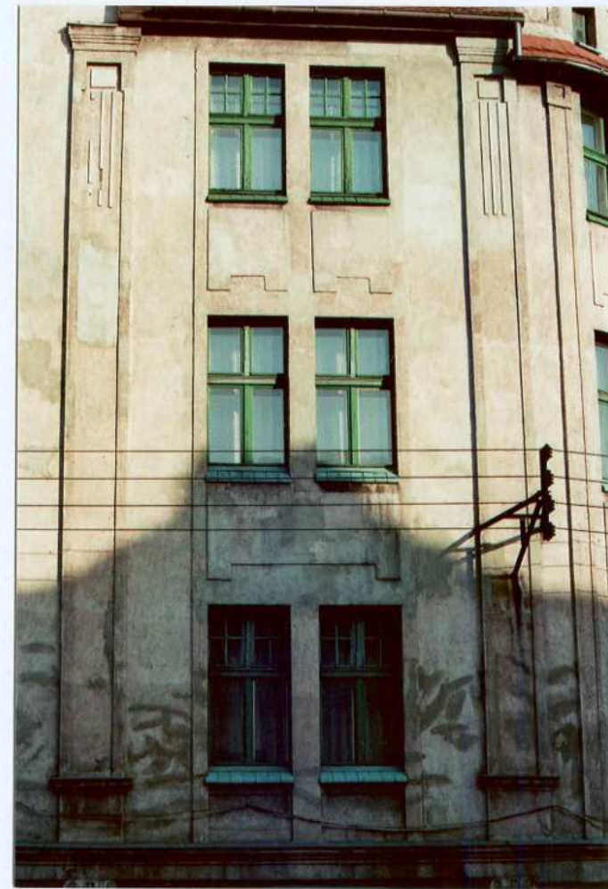
Fot. 12. Okna w 8 i 9 osi – elewacja zachodnia, skrzydło północne
