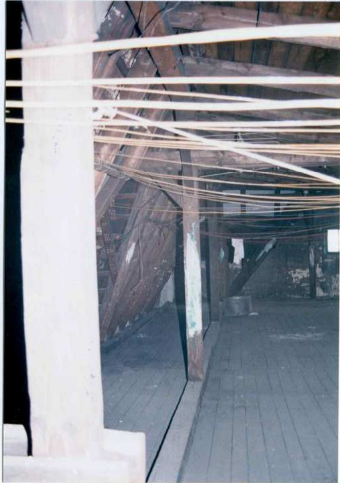
Fot. 47. Widok na więźbę dachową.
