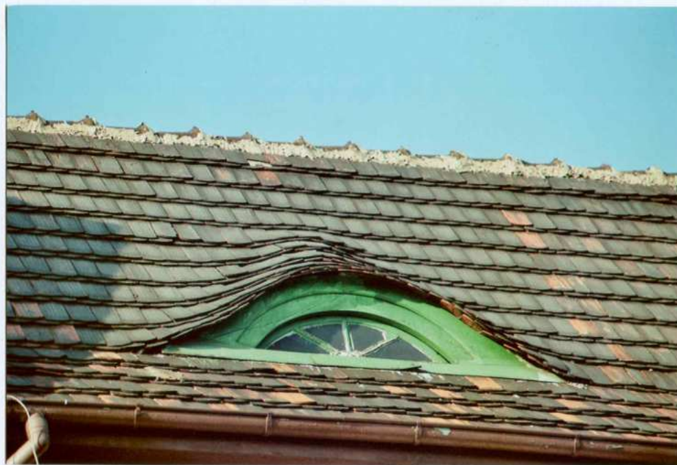
Fot. 29. Lukarna w kształcie powieki.
