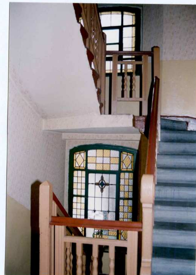
Fot. 36. Widok na okna witrażowe pomiędzy II i III piętrem oraz III piętrem i poddaszem.
