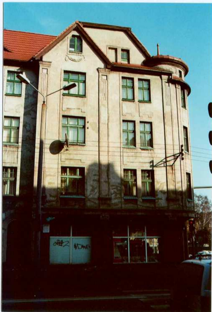
Fot. 10. Elewacja zachodnia, skrzydło północne – południowa strona elewacji.
