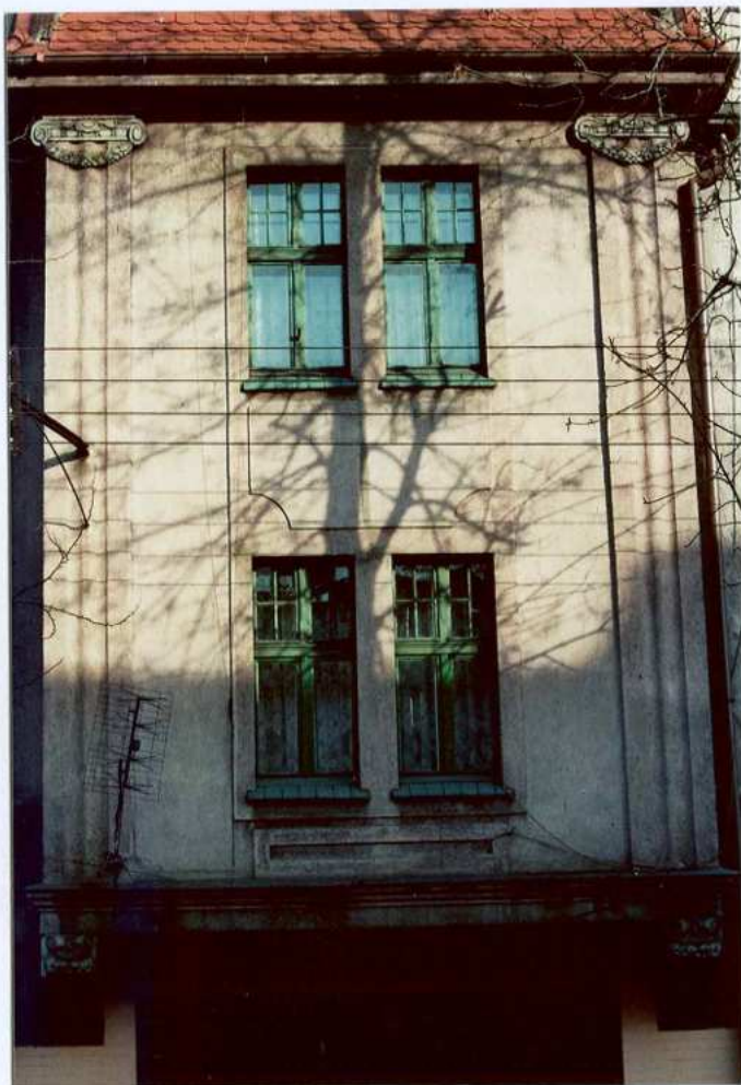
Fot. 7. Okna w 2 i 3 osi – elewacja zachodnia, skrzydło północne.
