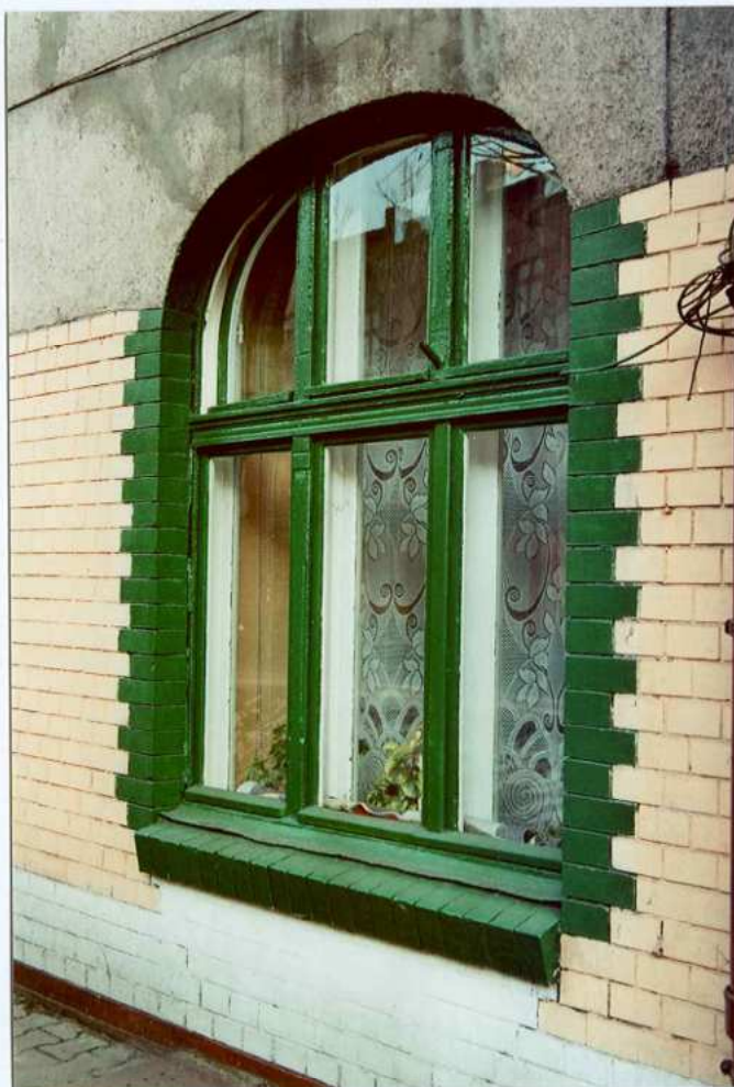
Fot. 8. Okno na parterze.
