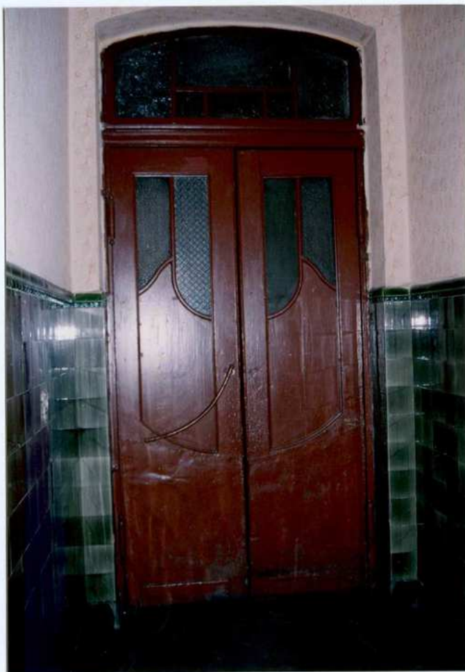
Fot. 43. Drzwi dwuskrzydłowe wewnętrzne pomiędzy przedsiönkiem i klatką schodową.
