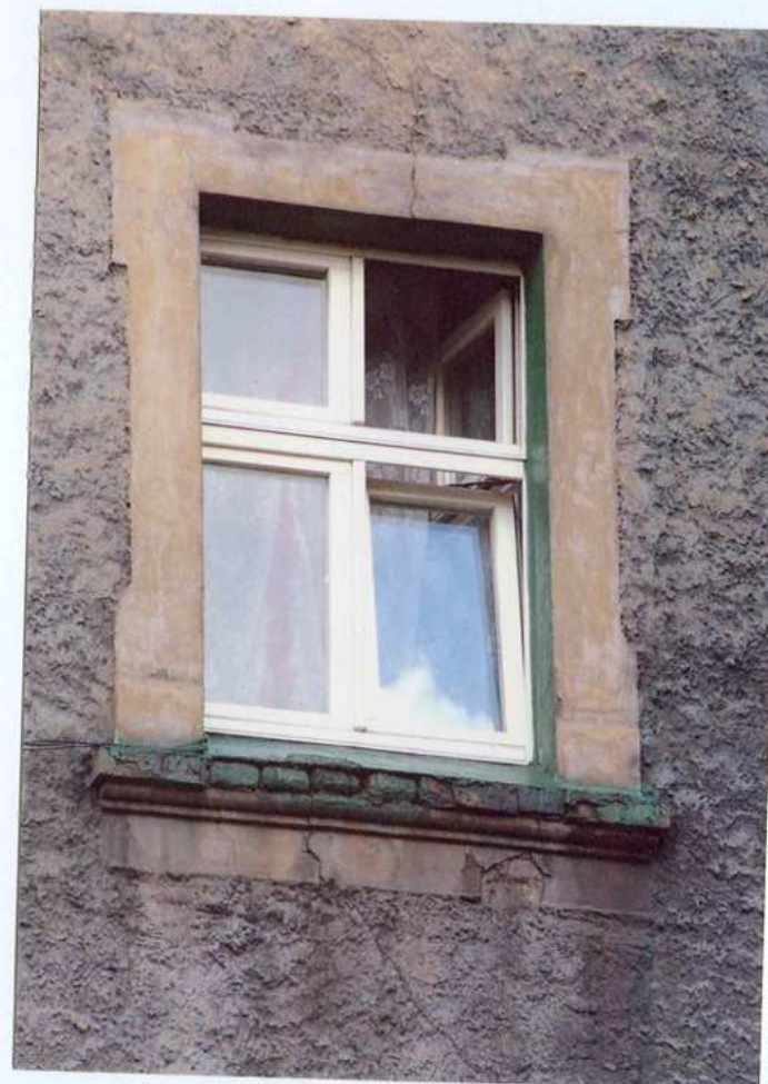
Fot. 14. Okno – III piętro, 7 oś – elewacja frontowa.
