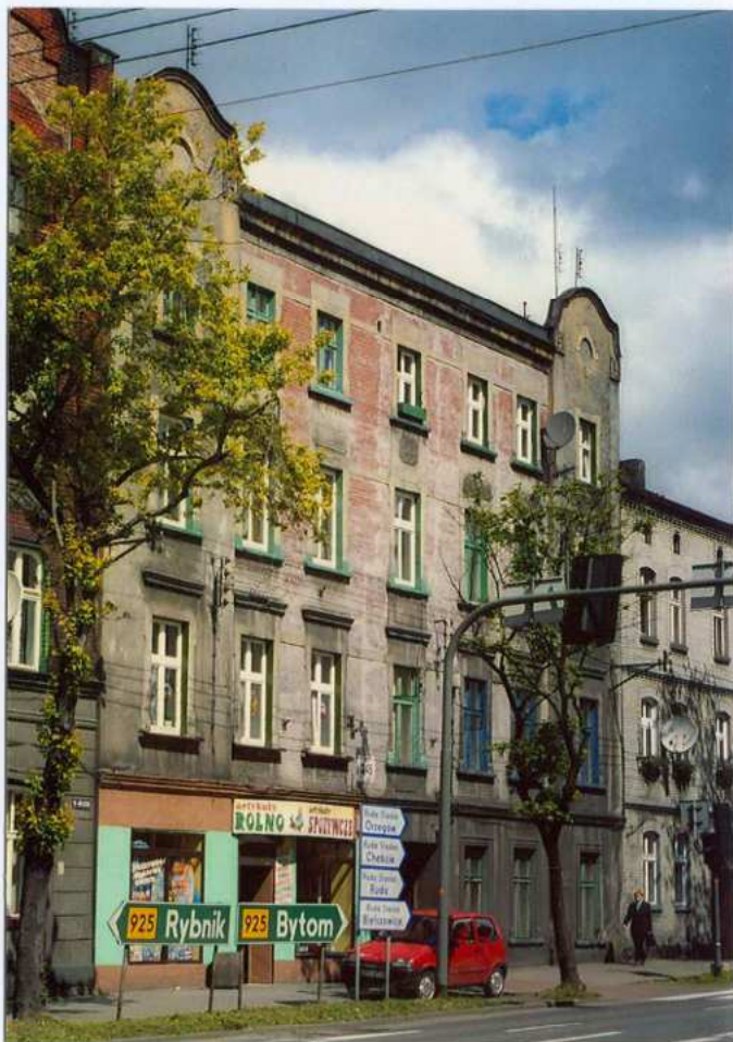
Fot. 1. Widok ogólny od południowego – wschodu.
