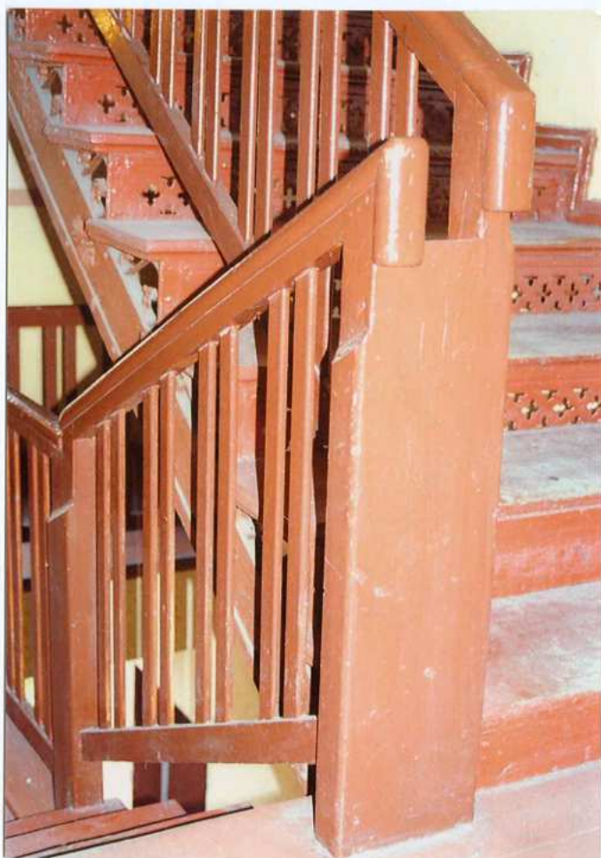
Fot. 20. Widok na balustradę.
