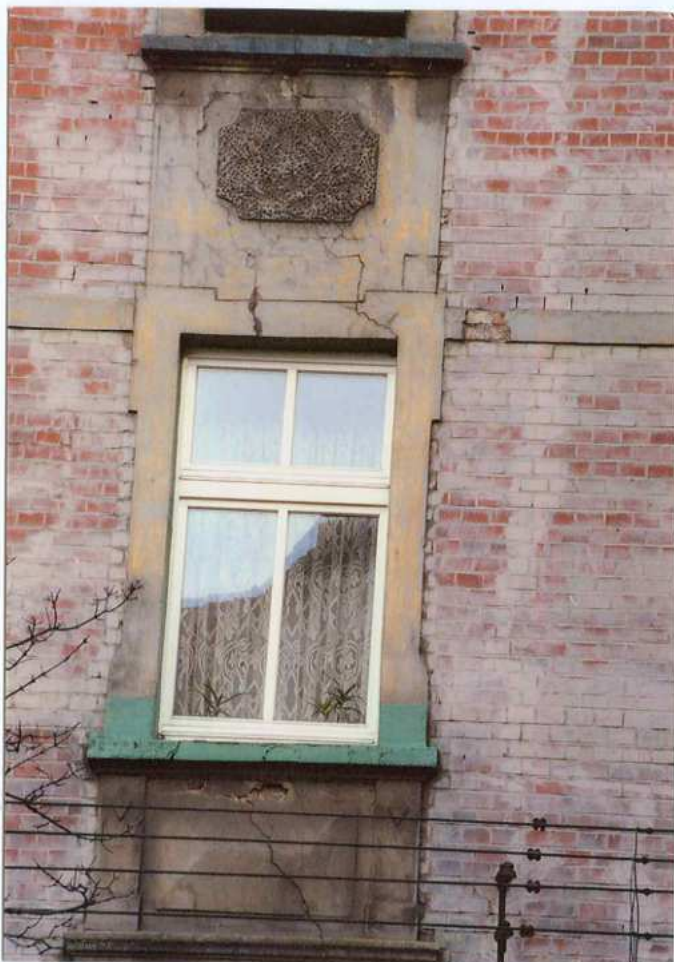
Fot. 10. Okno - II piętro, 4 ós - elewacja frontowa.
