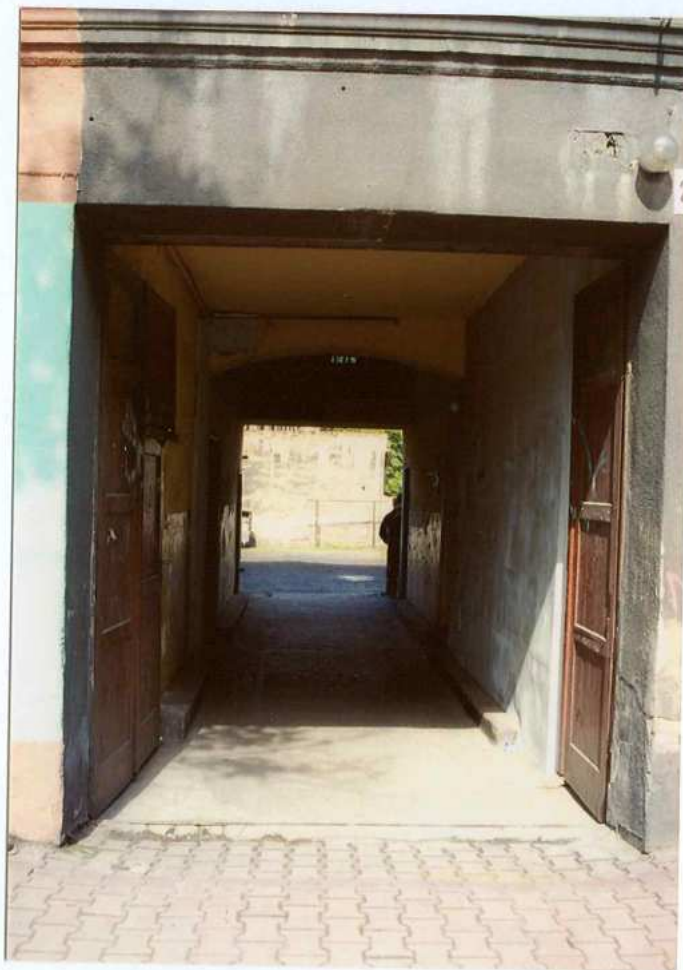
Fot. 15. Przejazd bramny.
