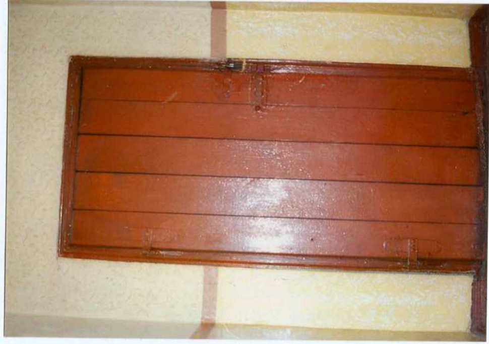
Fot. 33. Drzwi na strych.
