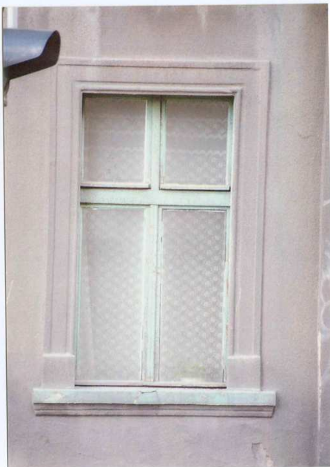
Fot. 7. Okno – parter, 6 oś - elewacja frontowa.
