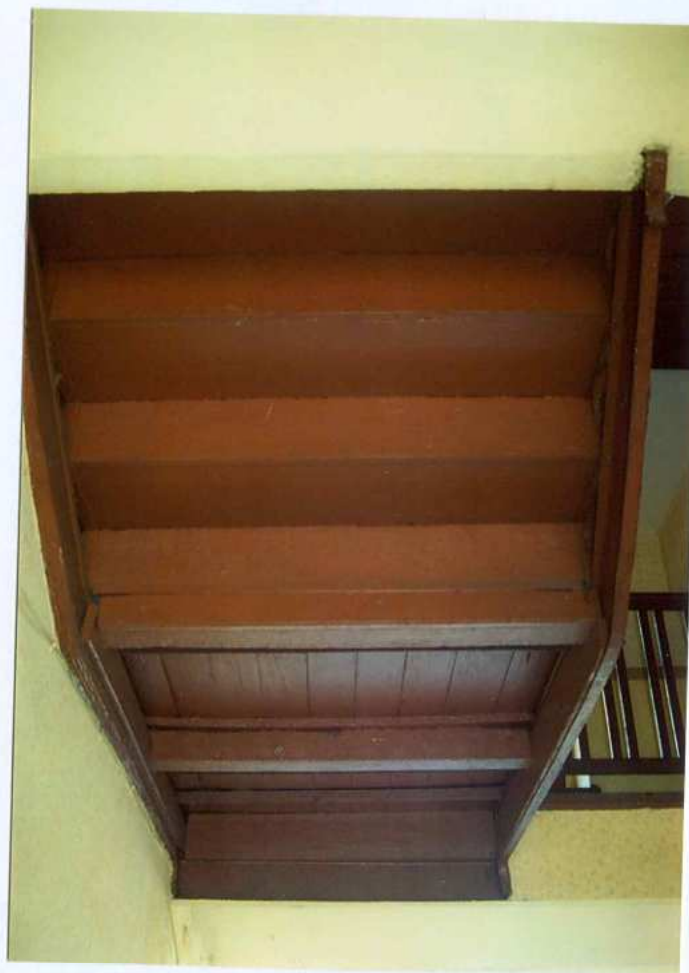
Fot. 18. Spód schodów.
