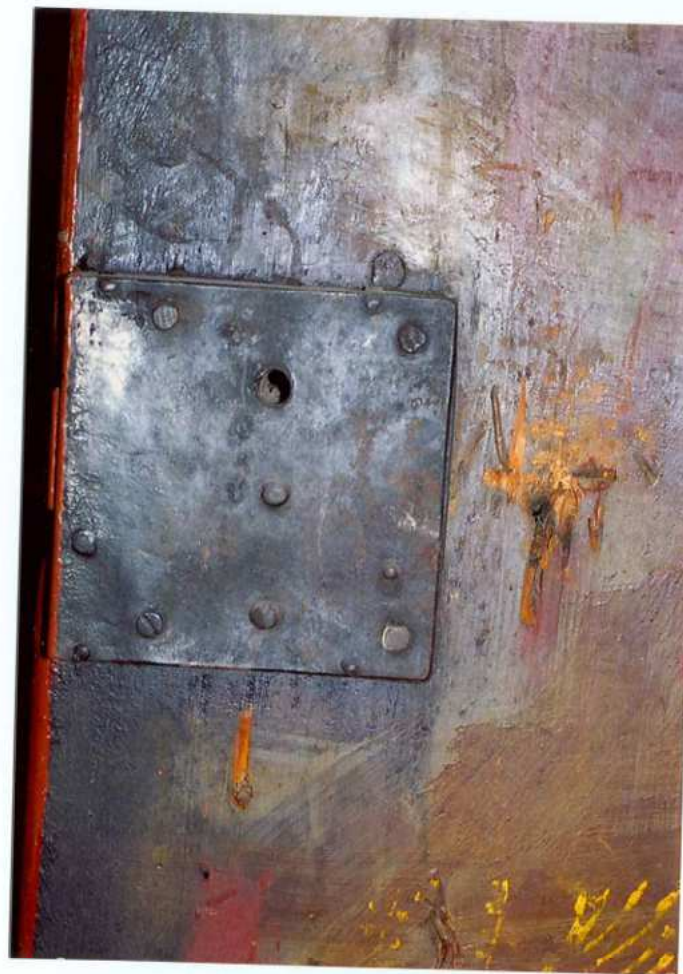
Fot. 33. Oryginalny zamek i klamka - widok od strony strychu.
