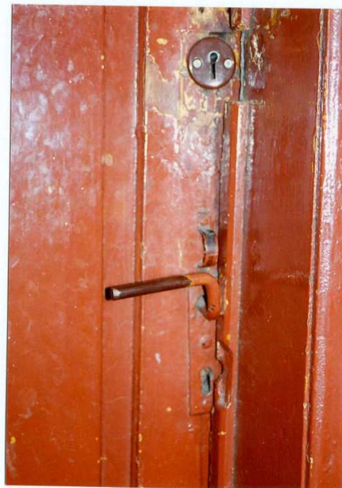
Fot. 31. Oryginalny zamek i klamka - widok od strony klatki schodowej – drzwi na strych.
