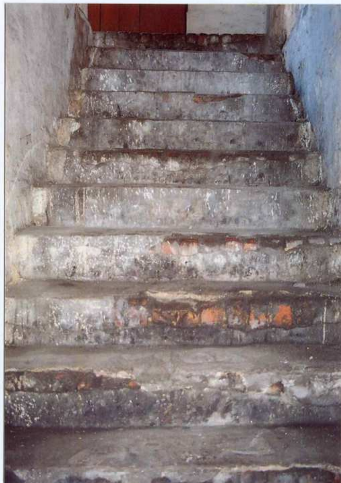
Fot. 28. Schody do piwnicy.
