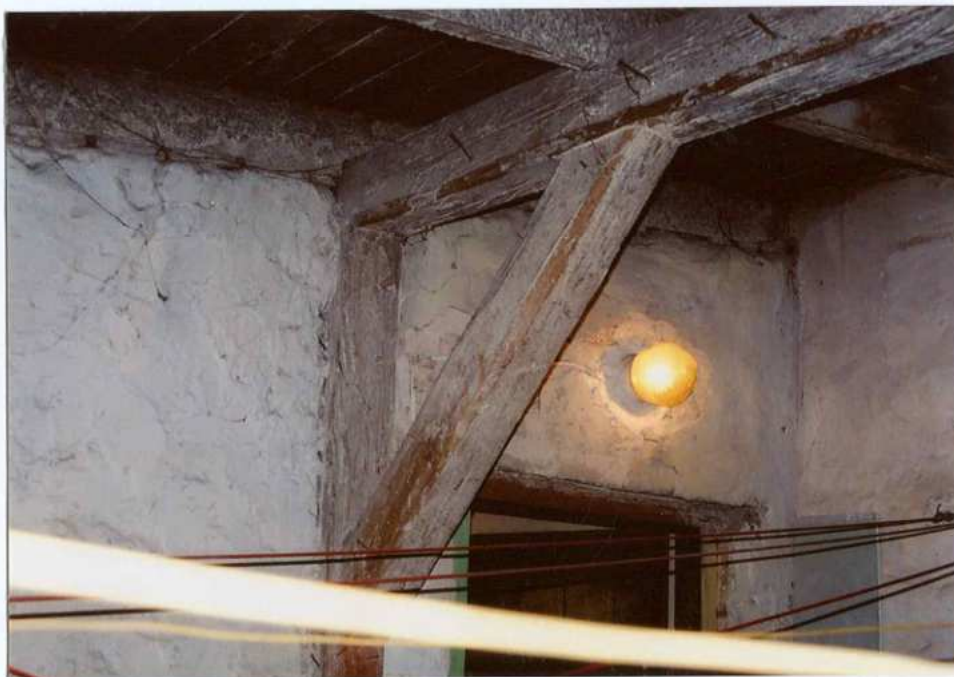
Fot. 36. Fragment więźby dachowej.
