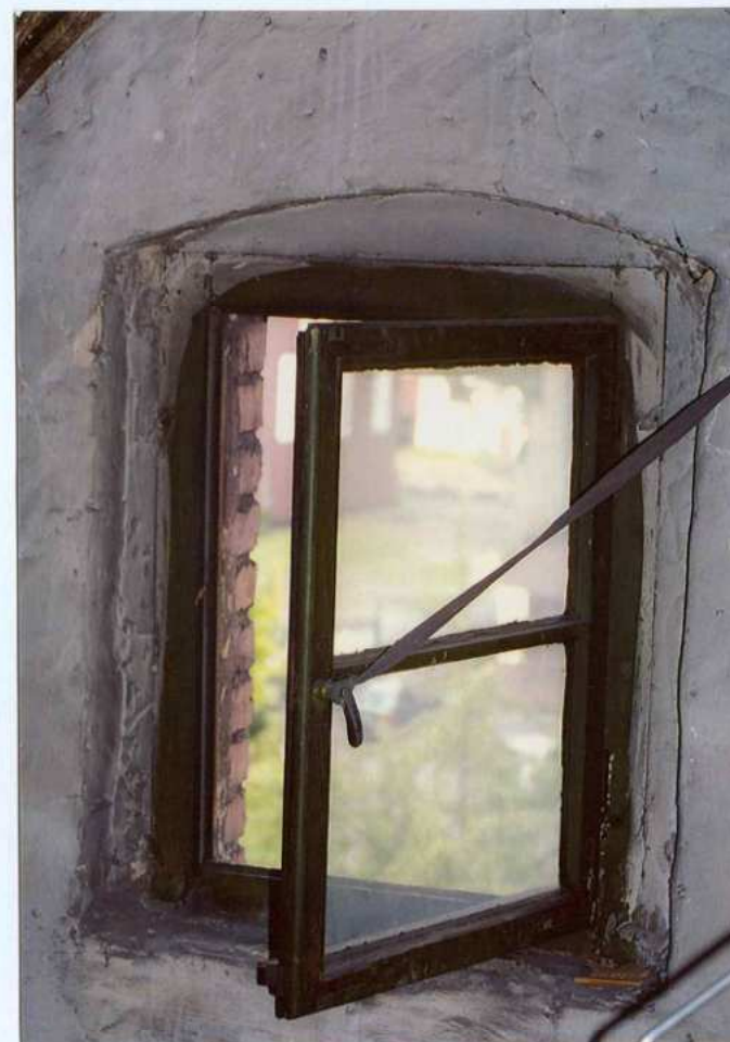
Fot. 37. Okno na strych.
