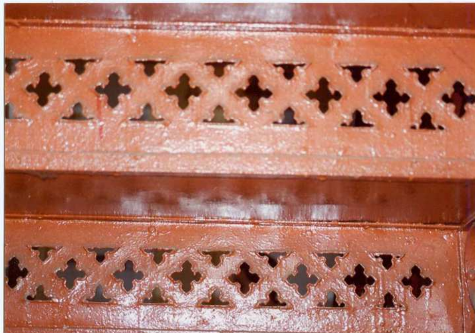
Fot. 27. Podstopnice schodów.
