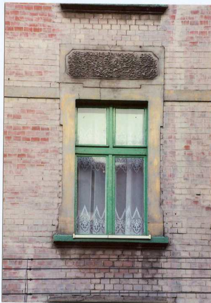
Fot. 11. Okno - II piętro, 6 ós - elewacja frontowa.
