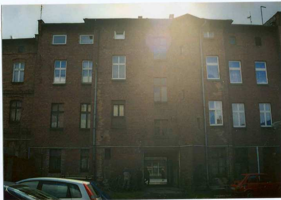
Fot. 15. Elewacja tylna – zachodnia.
