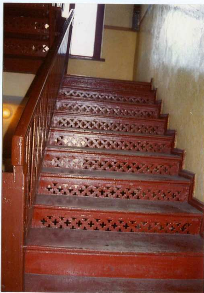
Fot. 21. Schody dwubiegowe.
