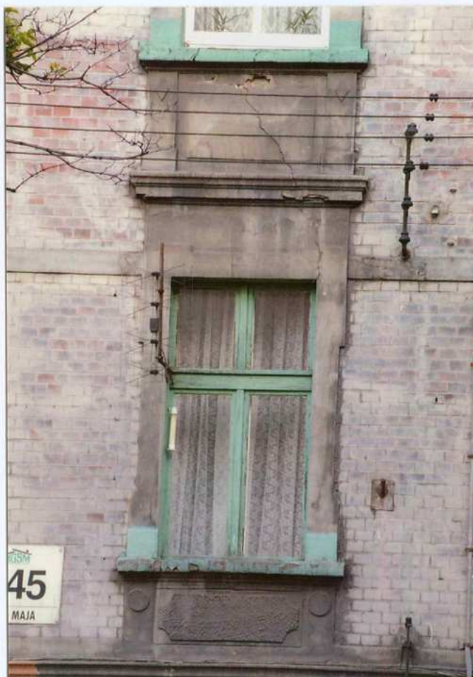
Fot. 8. Okno - I piętro, 4 oś - elewacja frontowa.
