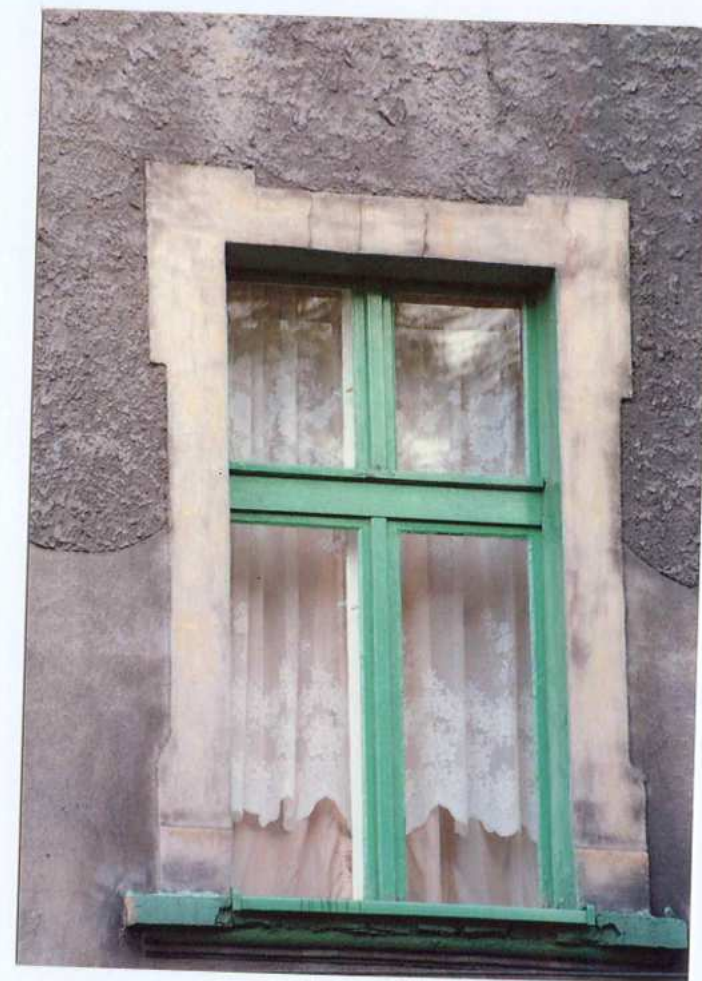
Fot. 12. Okno - II piętro, 7 ós - elewacja frontowa.
