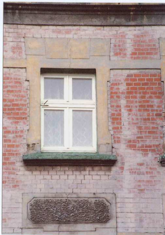
Fot. 13. Okno – III piętro, 4 oś – elewacja frontowa.
