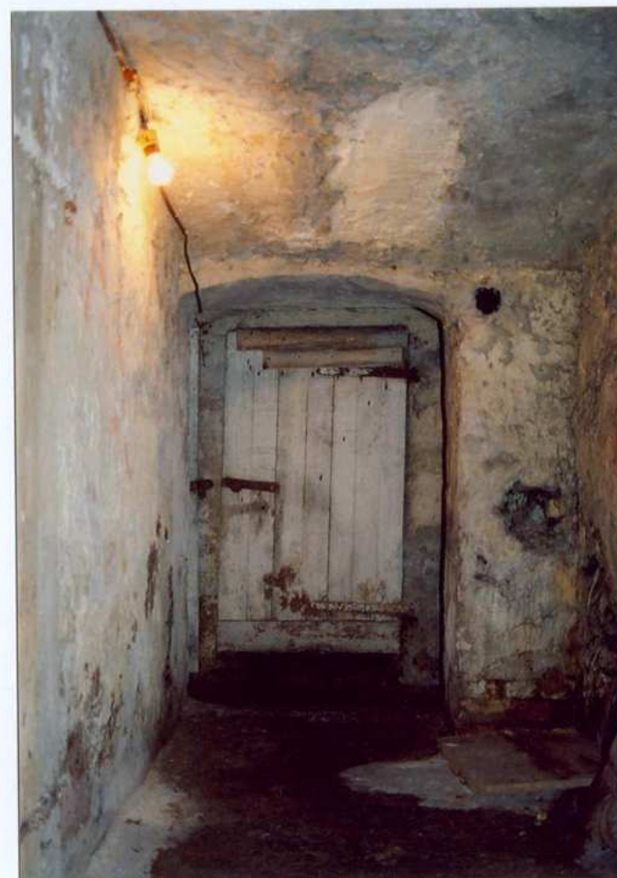
Fot. 29. Wnętrze piwnicy.
