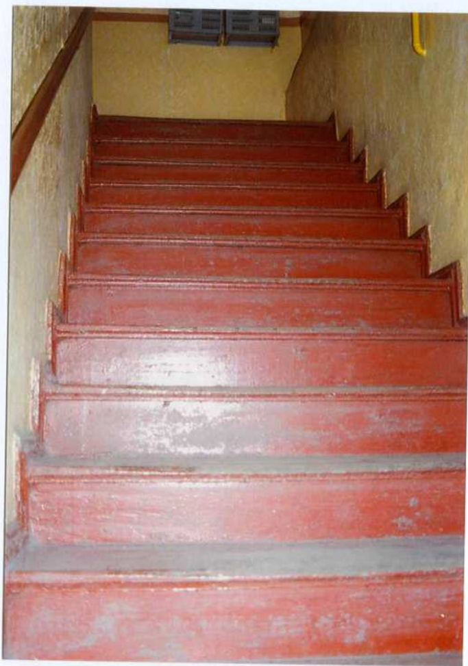
Fot. 17. Schody jednobiegowe z parteru na I piętro.
