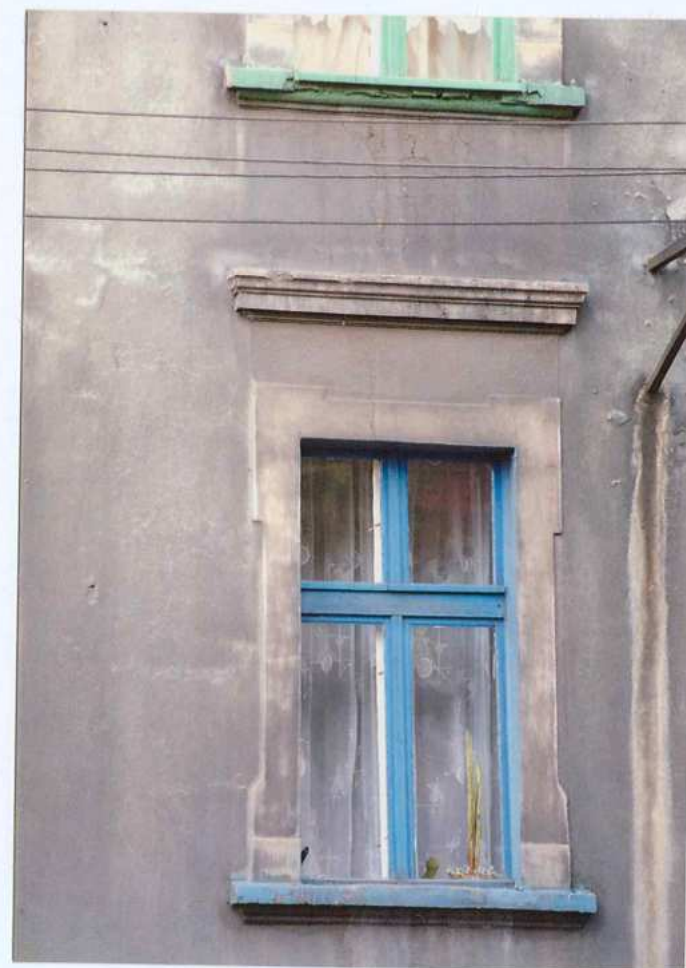
Fot. 9. Okno - I piętro, 7 oś - elewacja frontowa.
