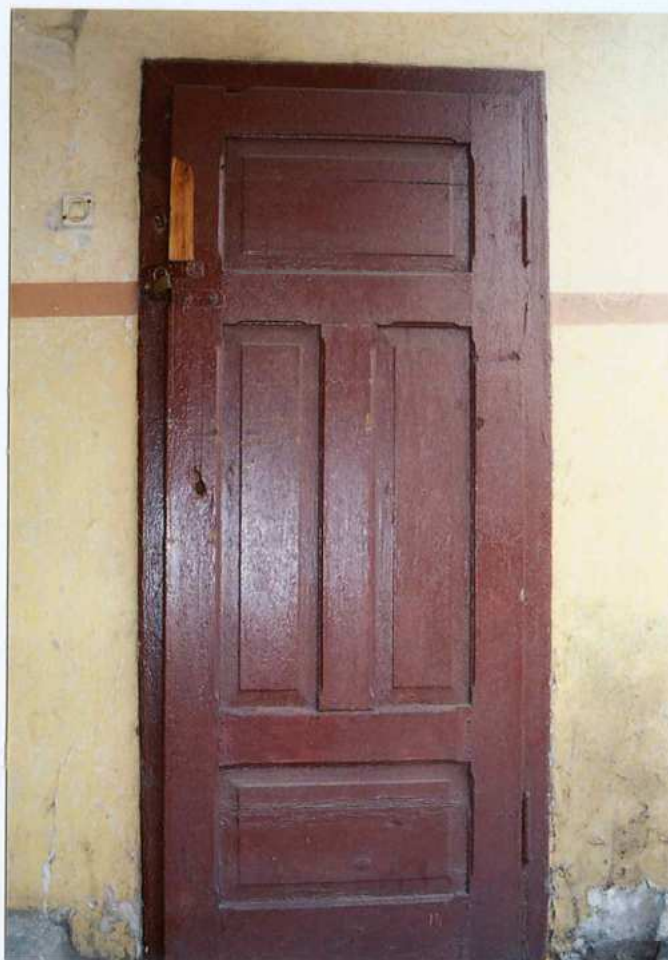
Fot. 31. Drzwi do toalety.
