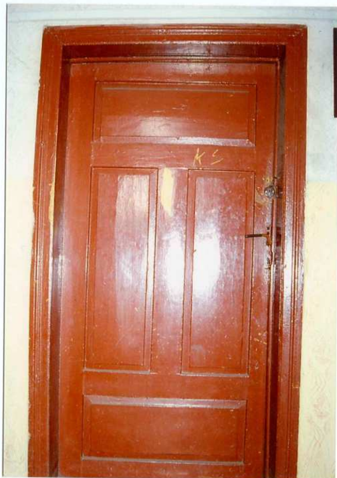
Fot. 30. Drzwi na strych.
