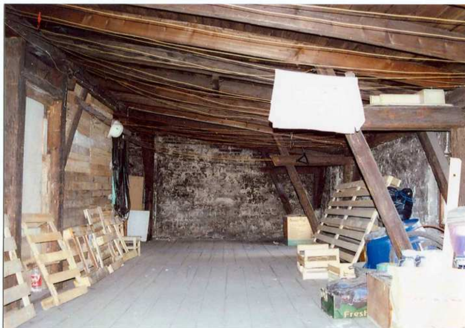
Fot. 36. Strych. Widok na więźbę dachową.
