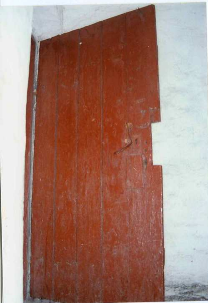
Fot. 30. Drzwi do piwnicy.
