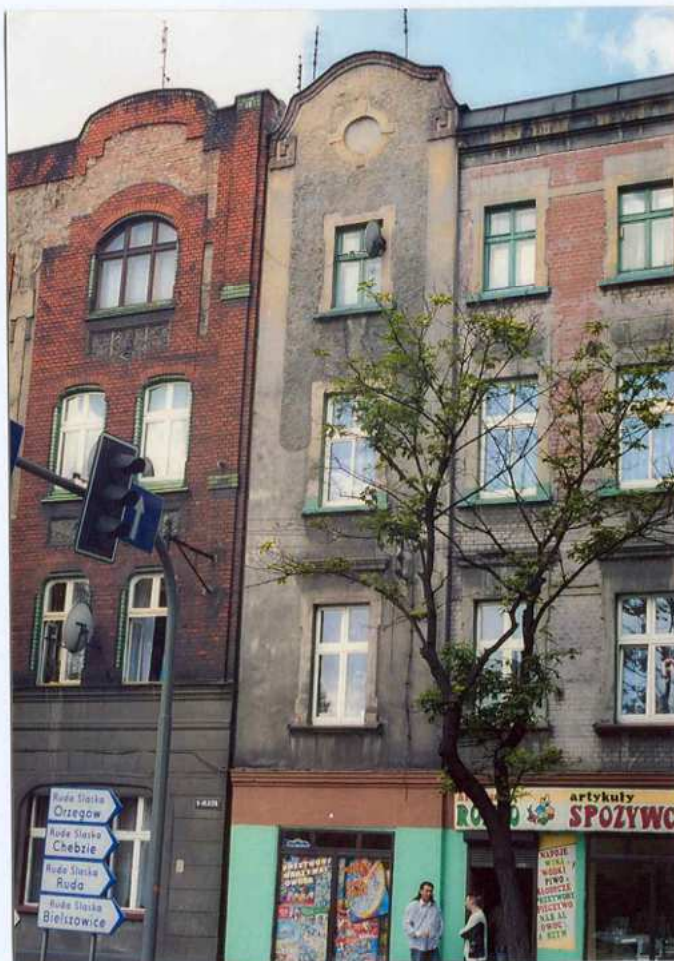
Fot. 2. Południowa strona elewacji frontowej.
