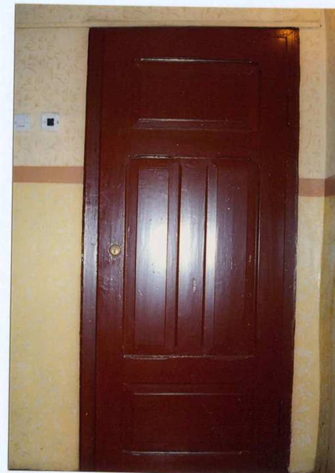
Fot. 32. Drzwi do toalety.
