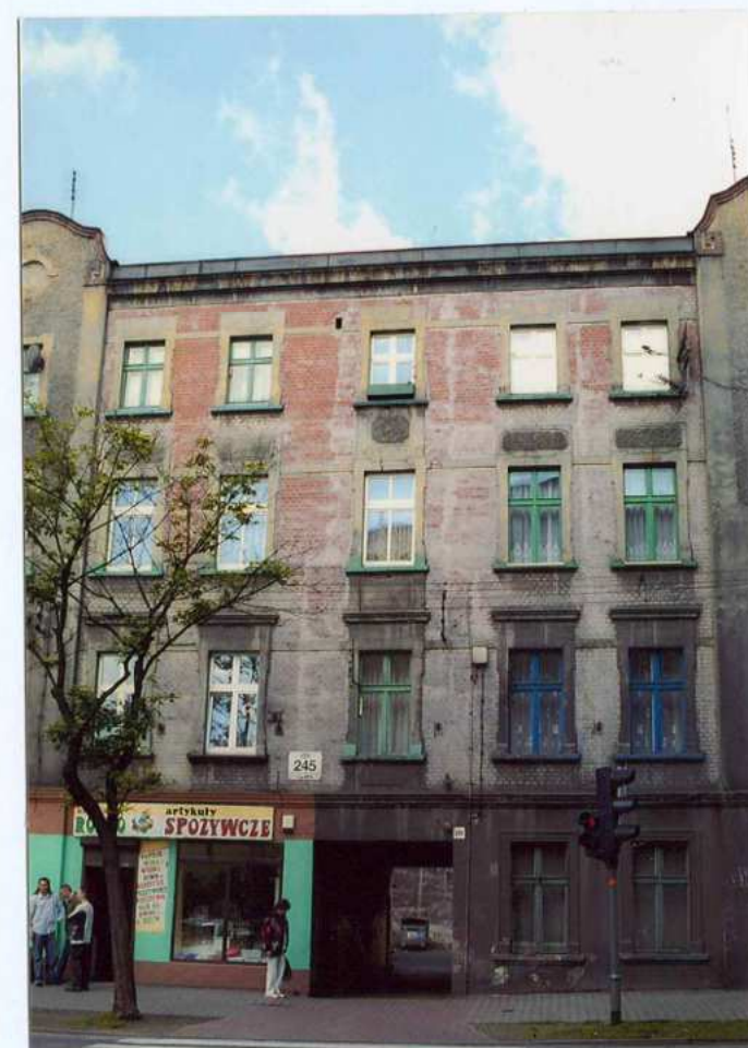
Fot. 3. Środkowa część elewacji frontowej.
