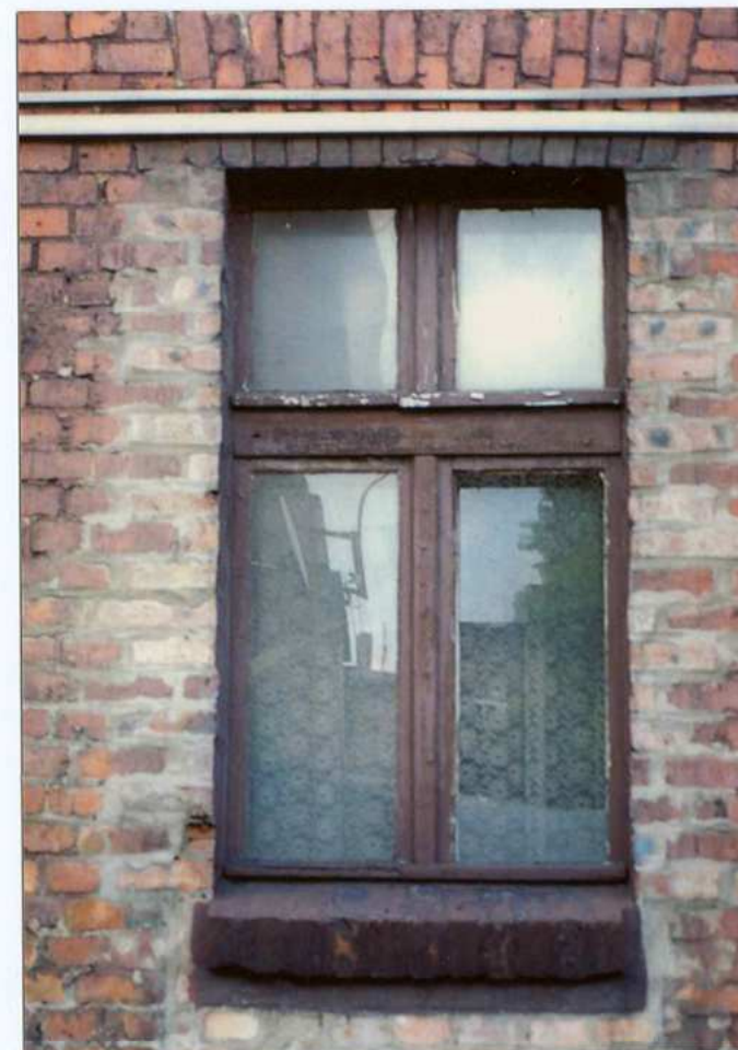
Fot. 16. Okno – elewacja tylna.
