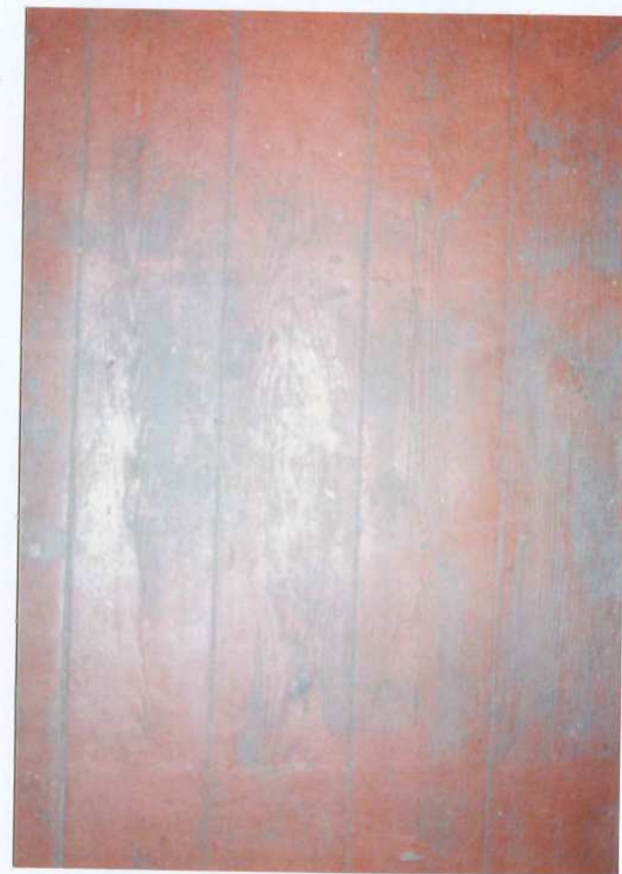
Fot. 22. Posadzka spoczników.
