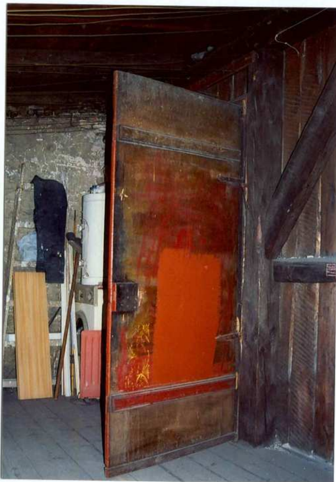
Fot. 32. Drzwi na strychu.
