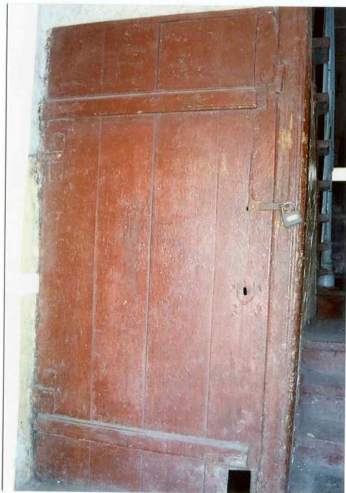
Fot. 28. Drzwi do piwnicy.
