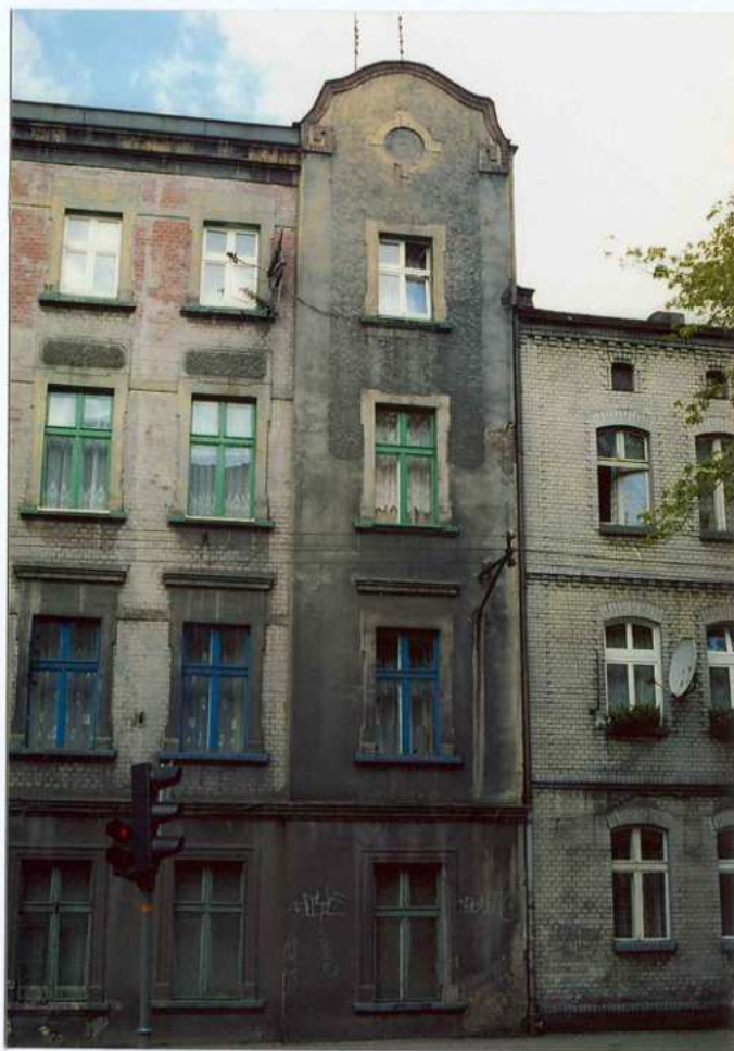
Fot. 4. Północna strona elewacji frontowej.
