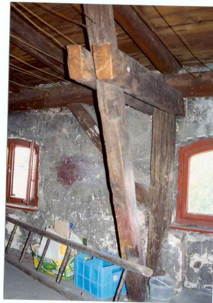
Fot. 37. Strych. Widok na więźbę dachową.
