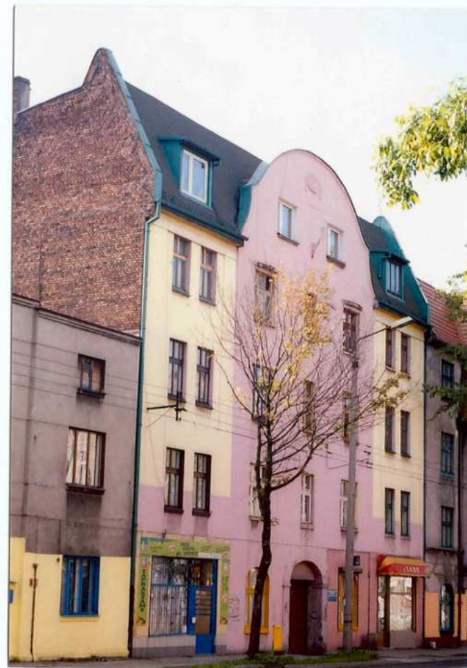
Fot. 2. Widok ogólny od północnego – zachodu.
