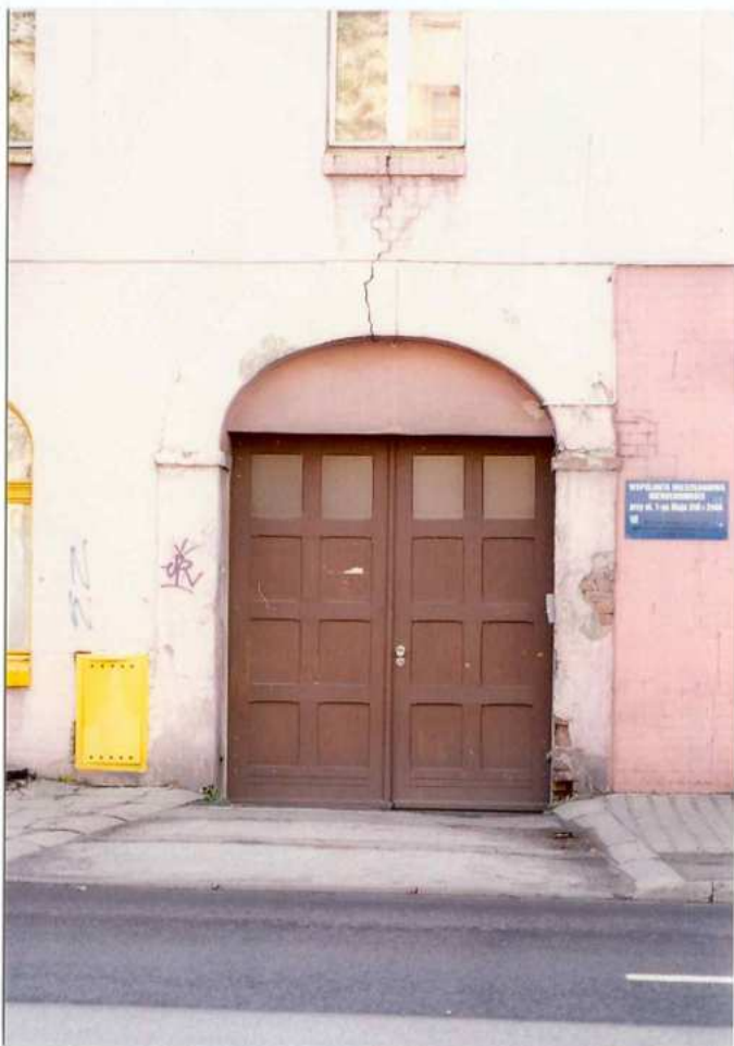
Fot. 8. Drzwi bramne zamykające przejazd – elewacja zachodnia.
