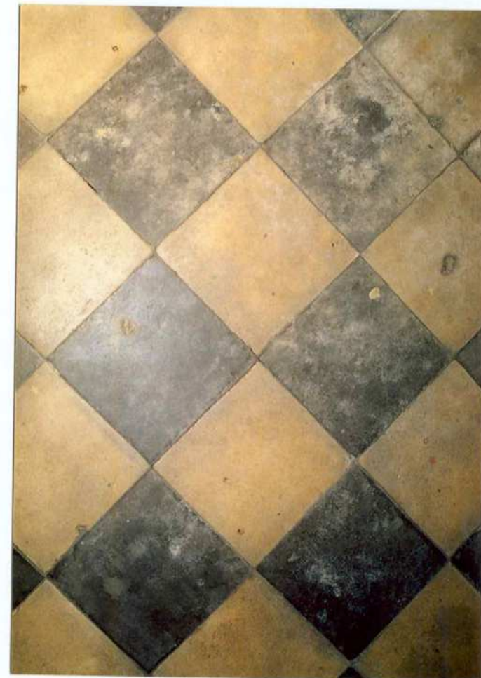
Fot. 20. Posadzka na podestach.
