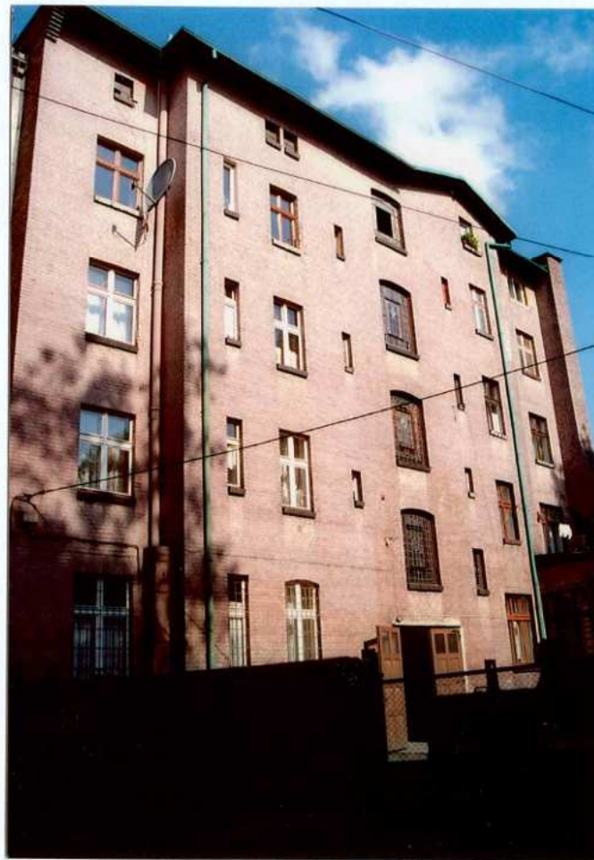
Fot. 12. Elewacja tylna – wschodnia.
