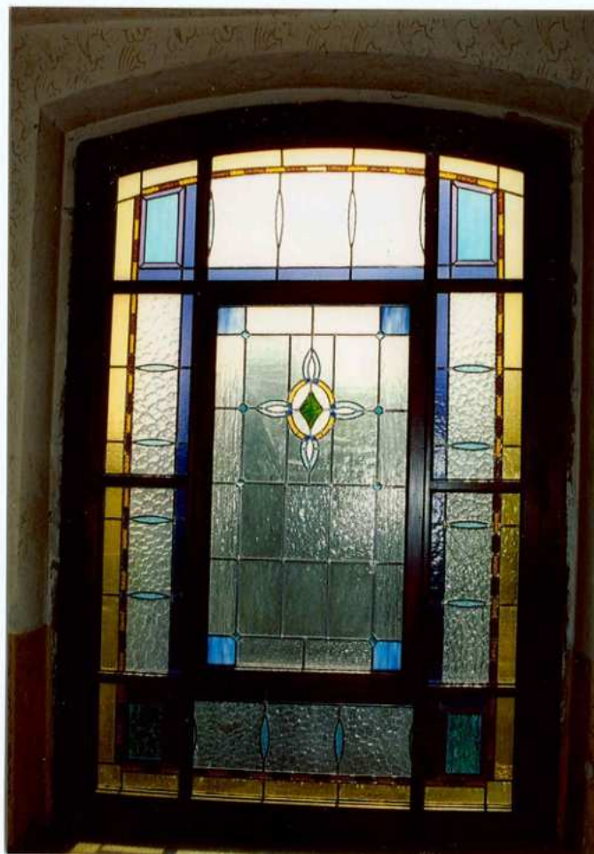
Fot. 32. Okno witrażowe – III piętro.
