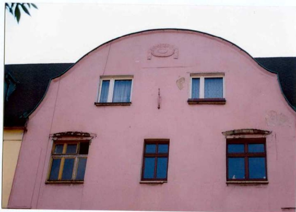
Fot. 6. Szczyt nad częścią środkową elewacji zachodniej.
