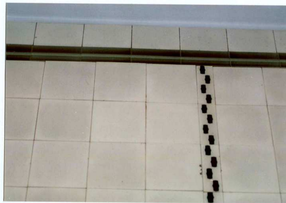
Fot. 38. Płytki ściennie we wnętrzu Łodziarni.
