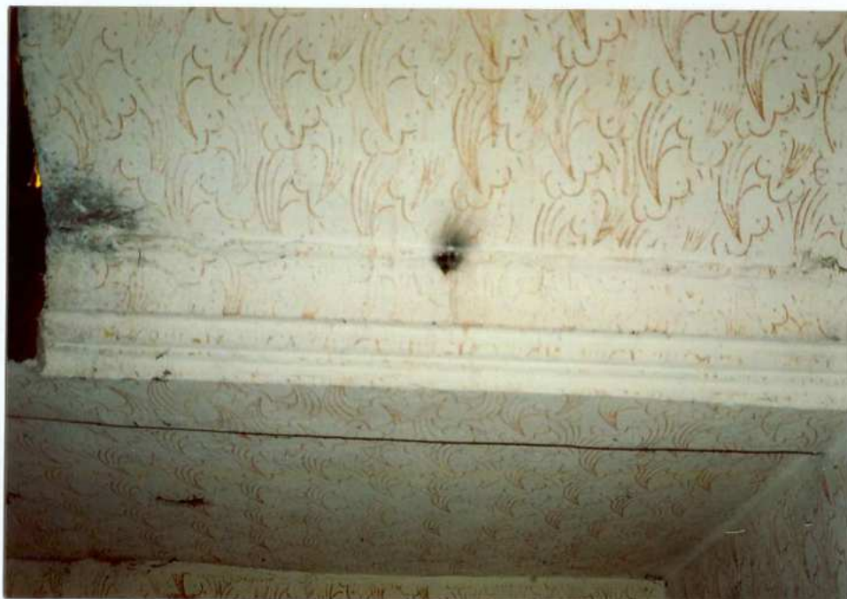
Fot. 27. Fragment stropu opocznika schodów.
