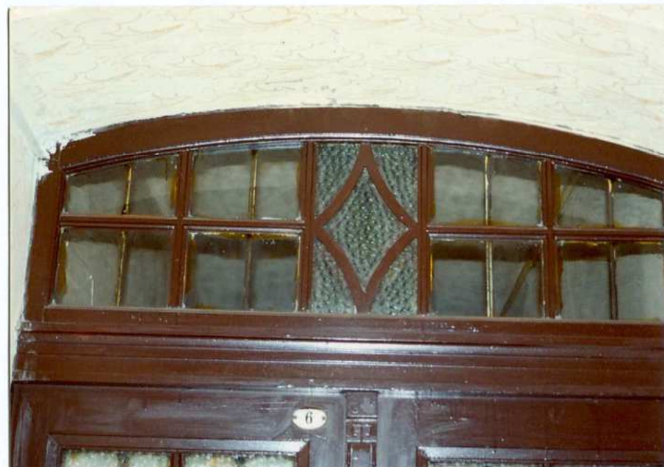
Fot. 35. Nadświetle drzwi.
