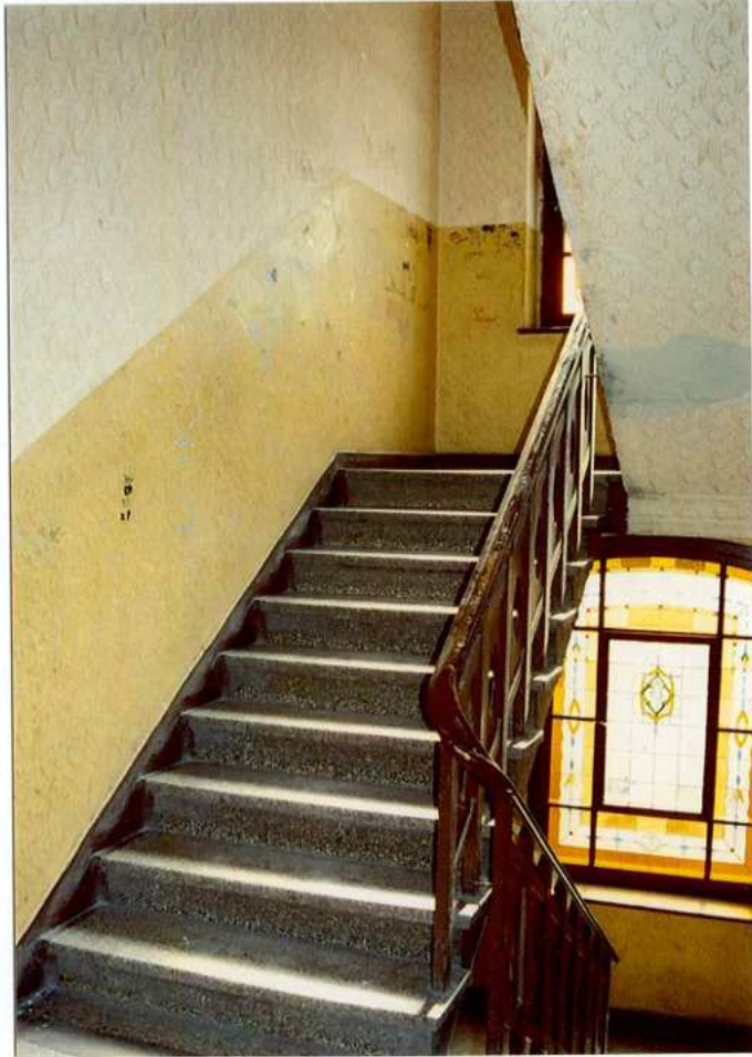
Fot. 24. Widok na klatkę schodową dwubiegową.
