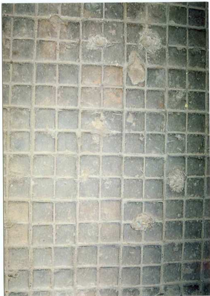
Fot. 18. Posadzka – przejazd.
