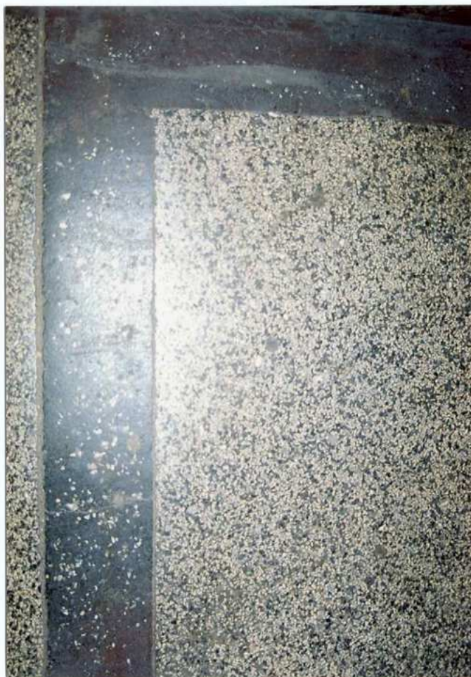
Fot. 19. Posadzka na parterze.
