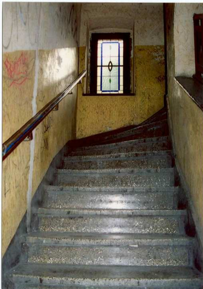
Fot. 22. Klatka schodowa jednobiegowa – widok z poziomu parteru.
