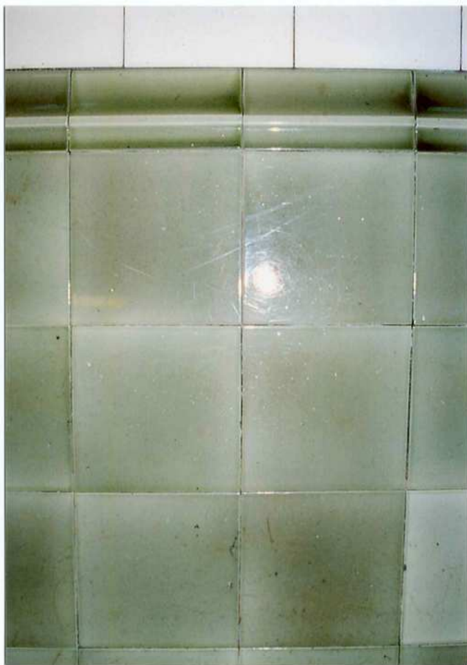
Fot. 43. Płytki ściennie we wnętrzu Lodziarni.
