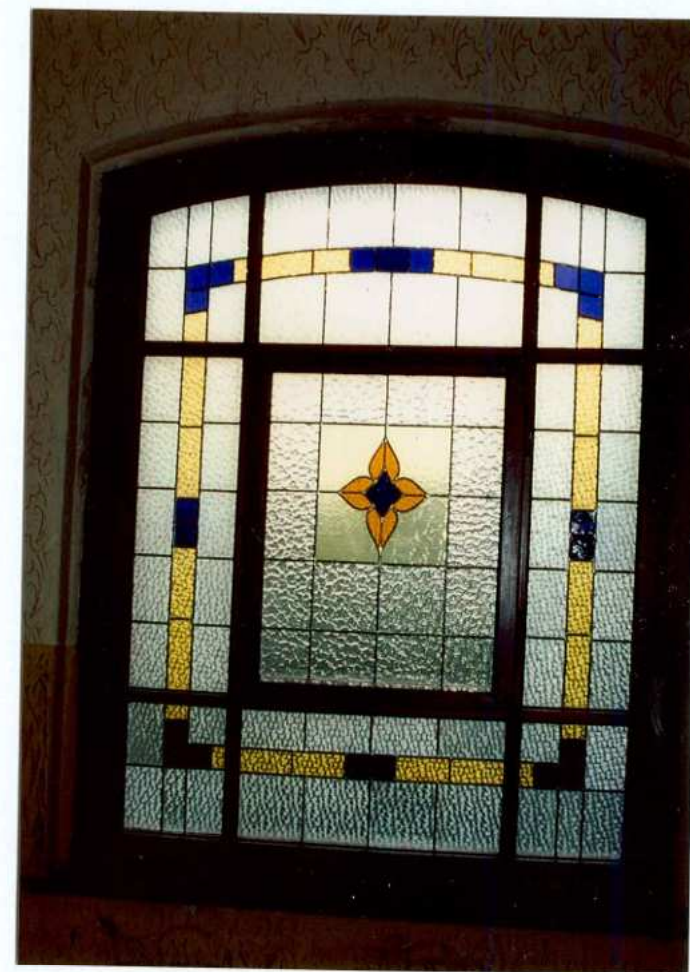
Fot. 33. Okno witrażowe – IV piętro.
