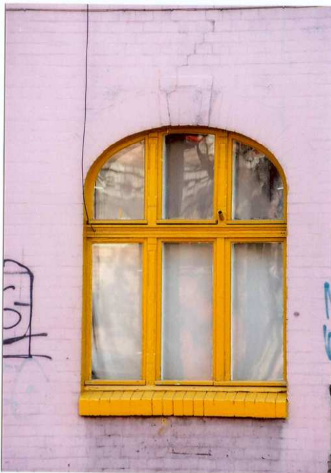
Fot. 9. Okno – parter, 2 oś – elewacja zachodnia.
