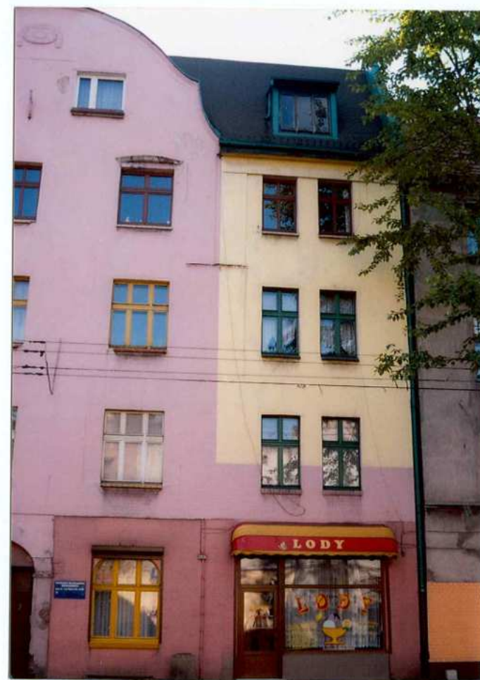
Fot. 5. Południowa część elewacji frontowej.
