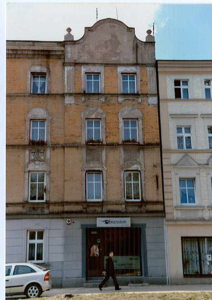
Fot. 7. Część południowa – elewacja frontowa.
