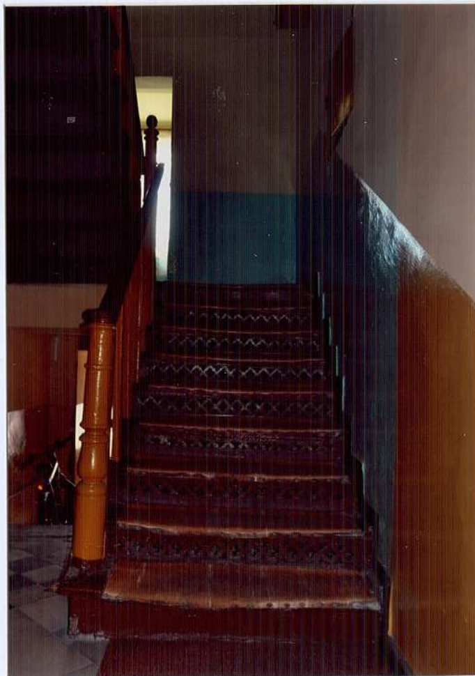
Fot. 43. Klatka schodowa.
