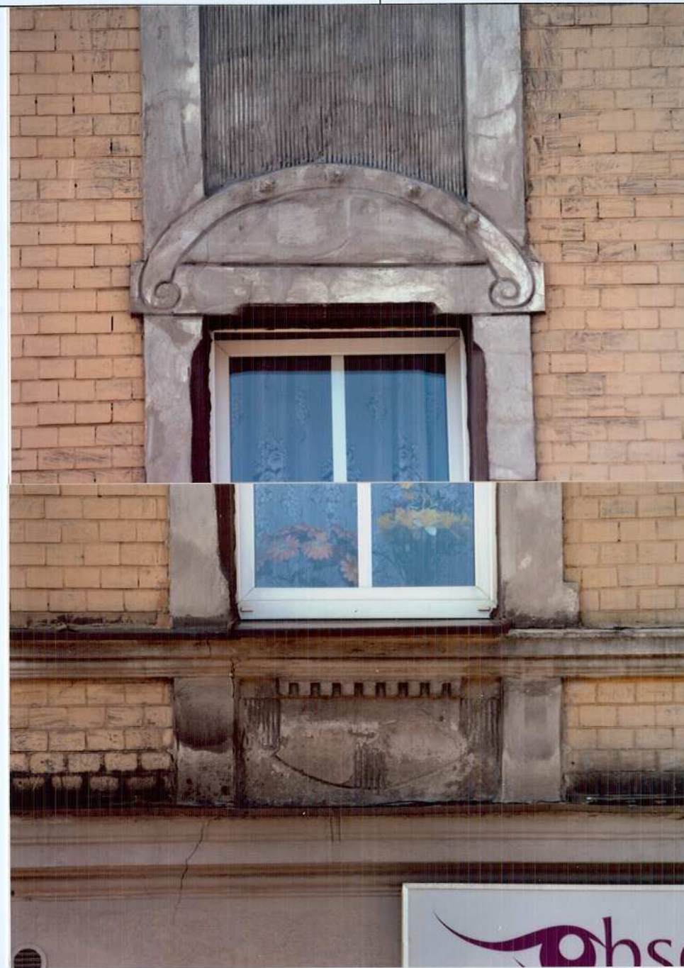
Fot. 21. Nadproże okna.
