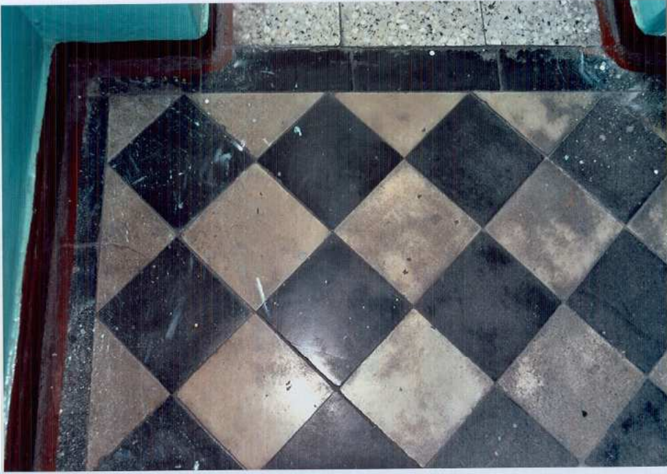
Fot. 47. Posadzka na opoczniku.
