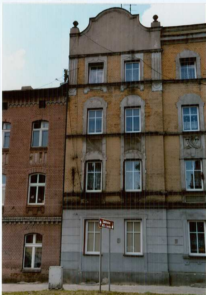
Fot. 5. Część północna – elewacja frontowa.
