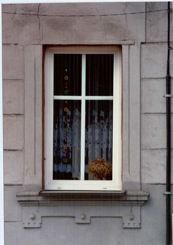
Fot. 8. Okno na parterze – oś 3.
