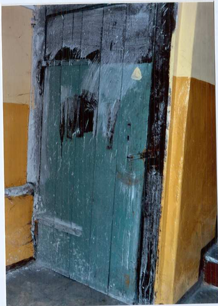
Fot. 53. Drzwi do piwnicy.
