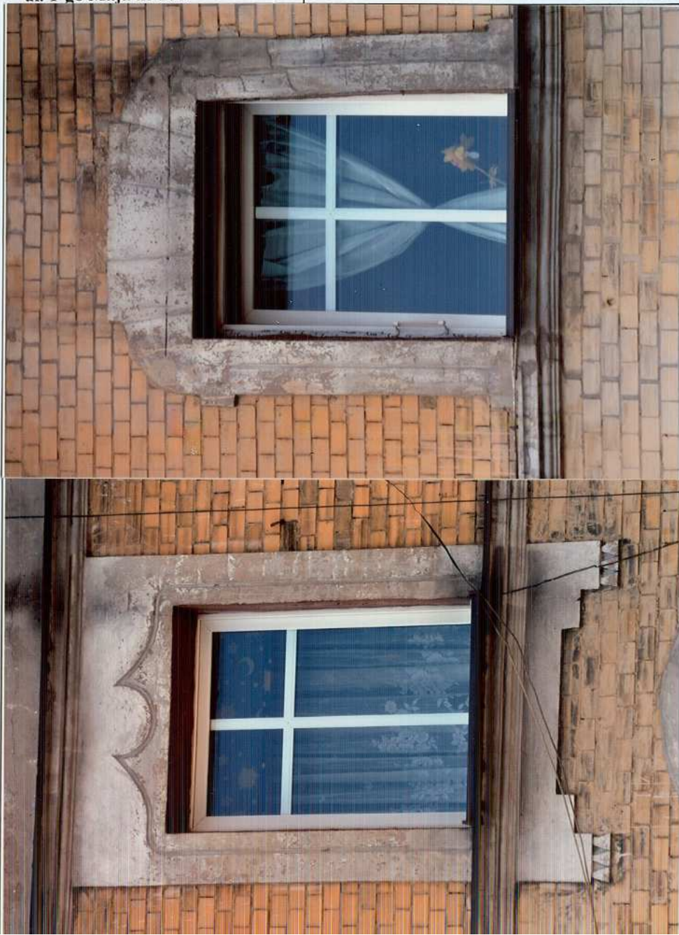
Fot. 26. Okno poddasza – oś 1, 2 i 7, 8.
