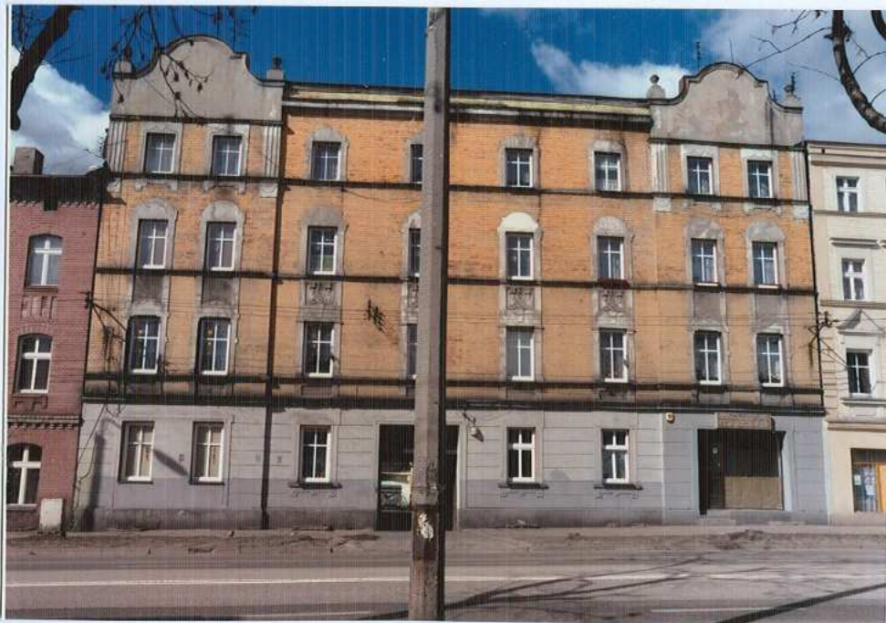
Ryc. 1. Widok na budynek od strony wschodniej.
