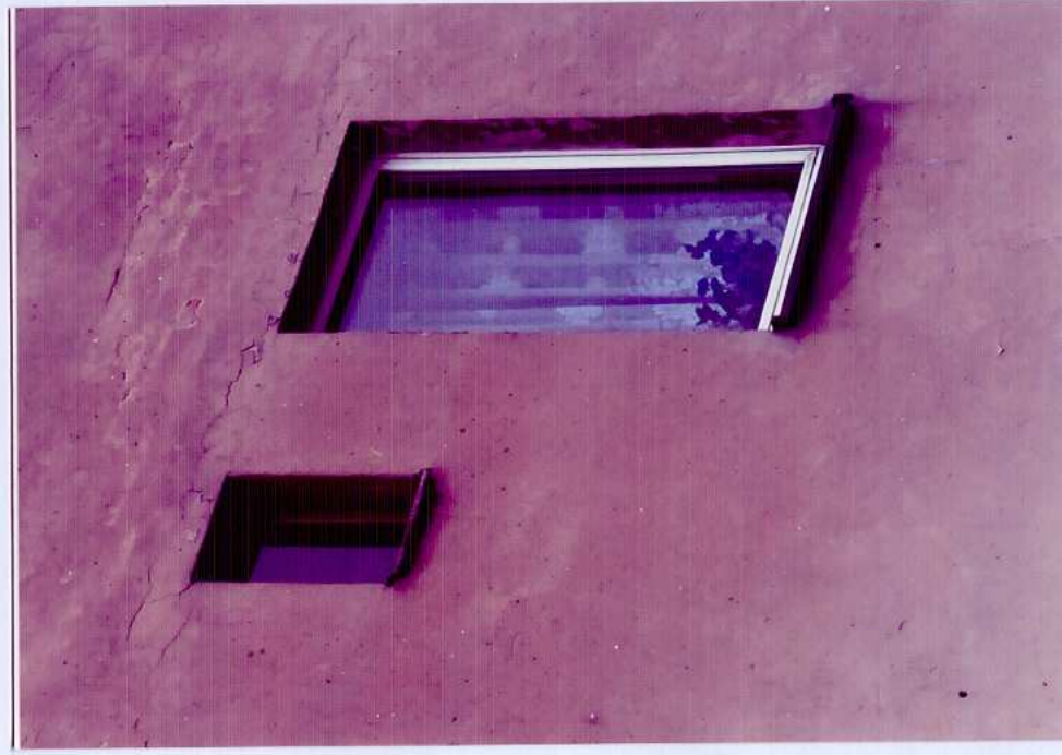
Fot. 37. Okno klatki schodowej i toalet – elewacja tylna.
