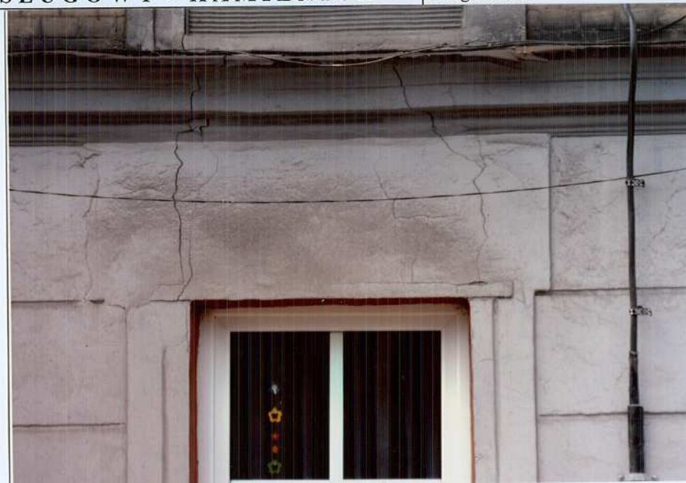
Fot. 9. Górna partia okna.
