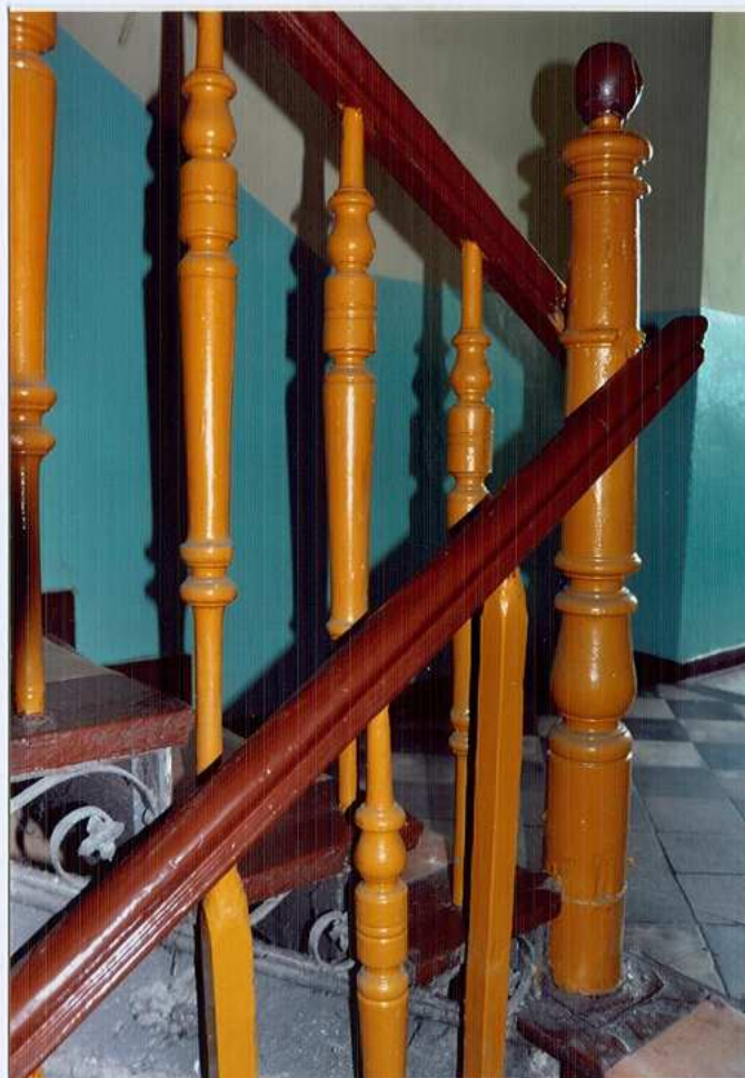
Fot. 44. Słupek i tralki balustrady.
