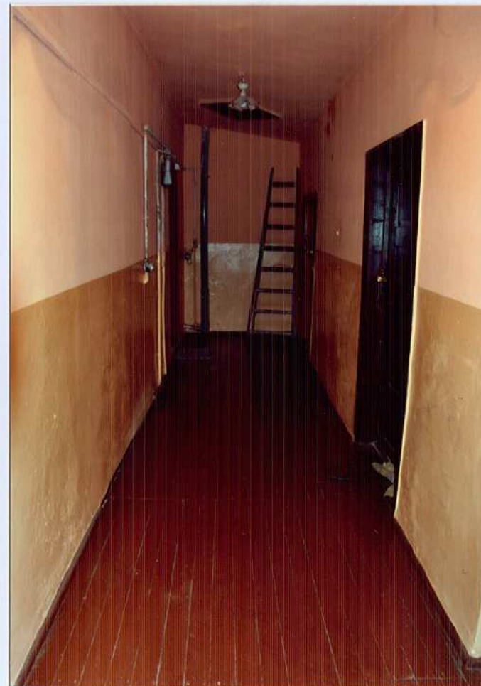
Fot. 52. Korytarz na poddaszu.
