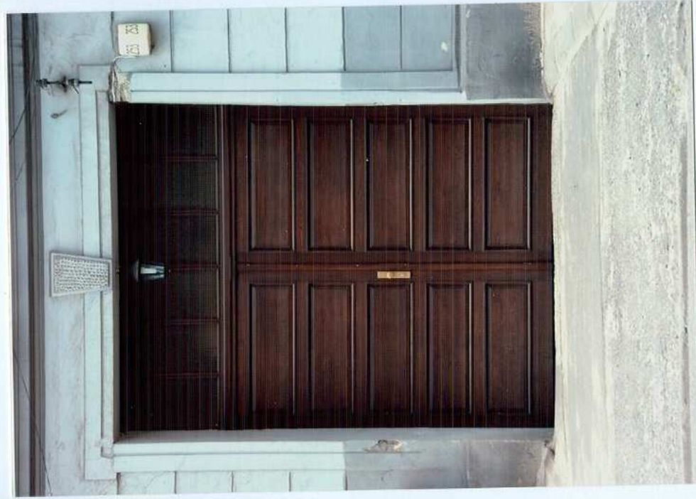
Fot. 11. Przejazd bramny – elewacja wschodnia.
