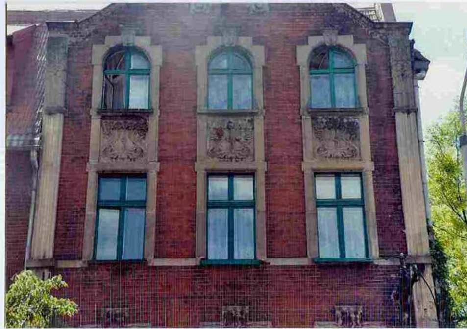
Fot. 4. Część środkowa ryzalitu.
