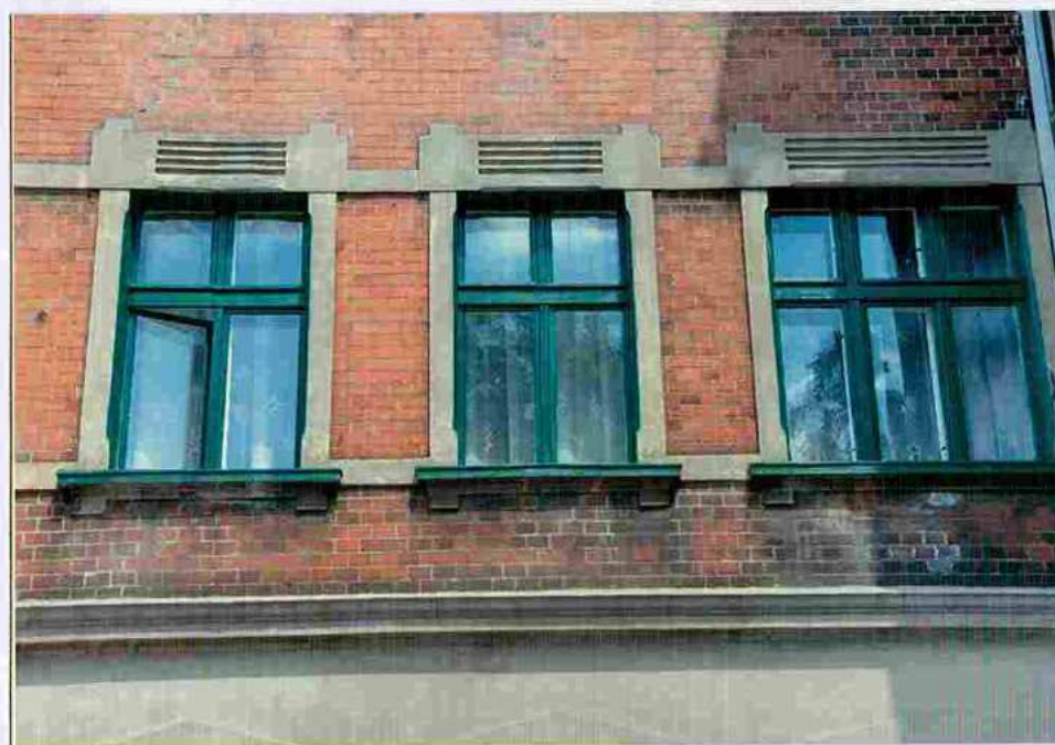
Fot. 72. Okna I piętra.
