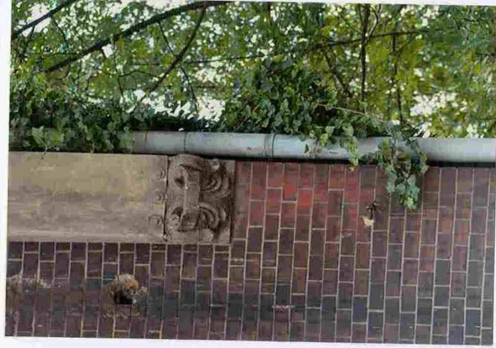
Fot. 8. Dolna partia pilastra.
