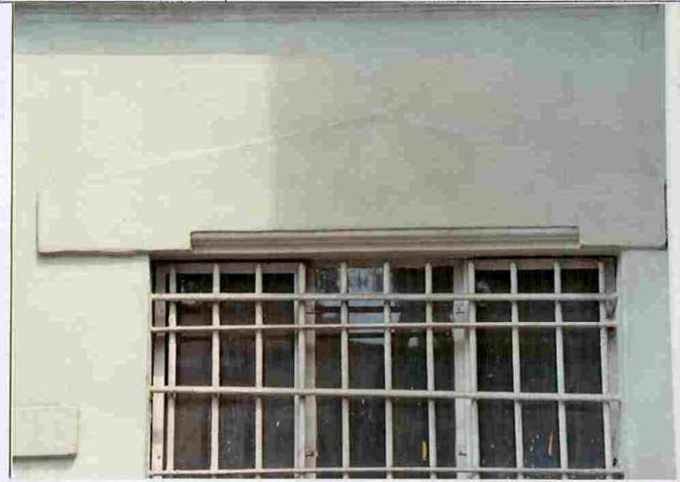
Fot. 71. Nadproże okna parteru.
