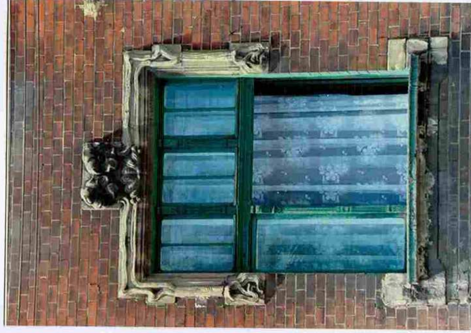
Fot. 46. Okno I piętra.
