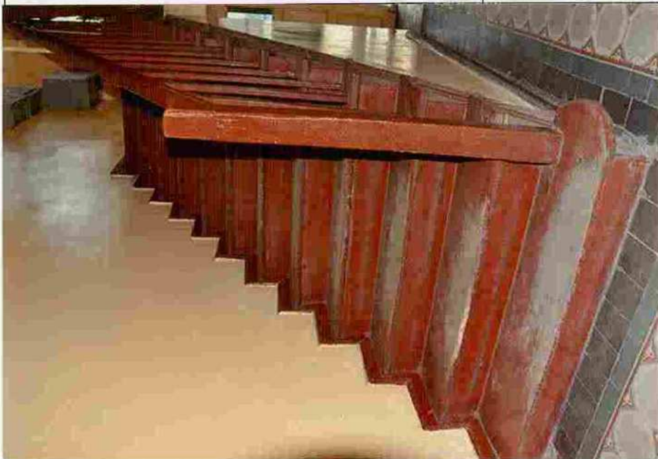
Fot. 78. Klatka schodowa.
