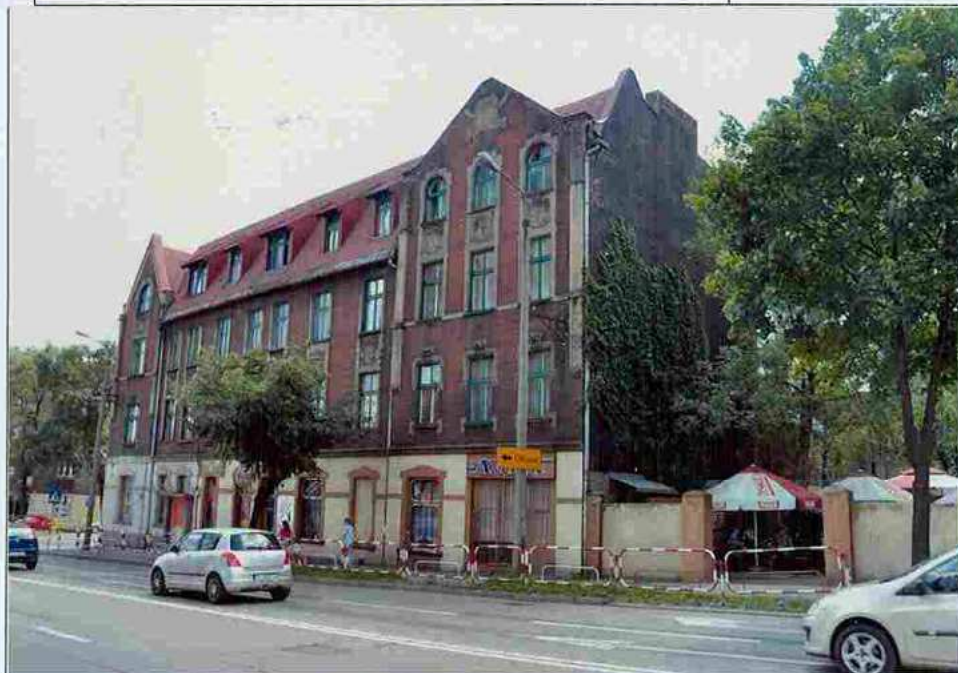
Fot. 1. Widok od strony północnej.
