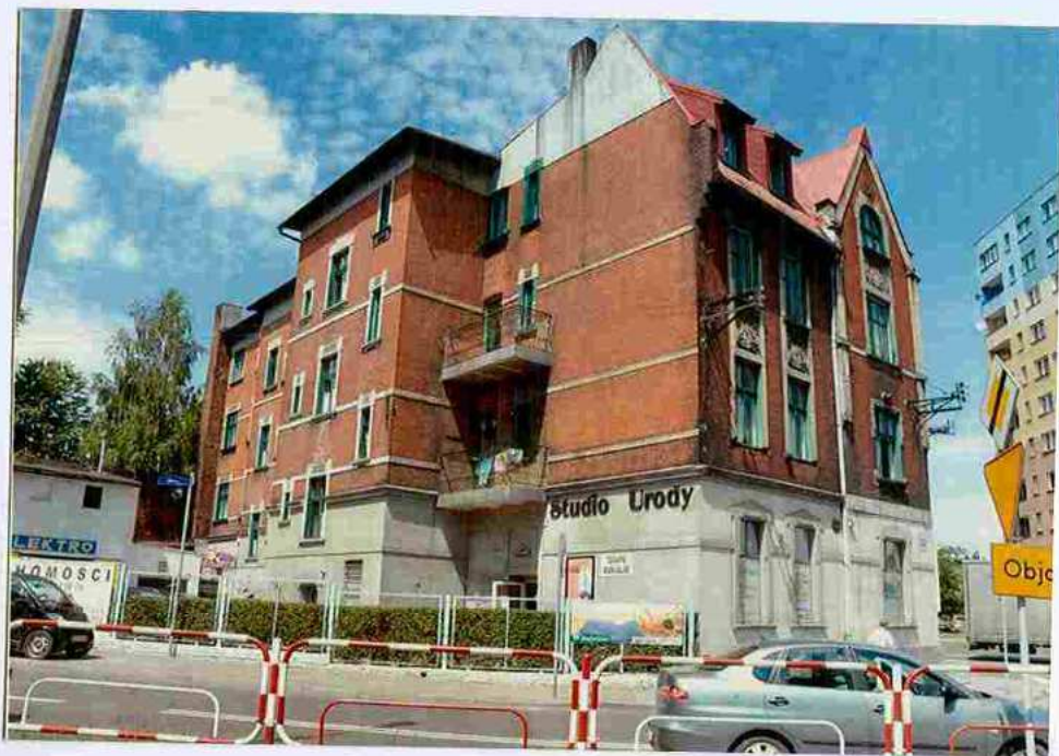
Fot. 52. Widok od strony południowo – zachodniej.
