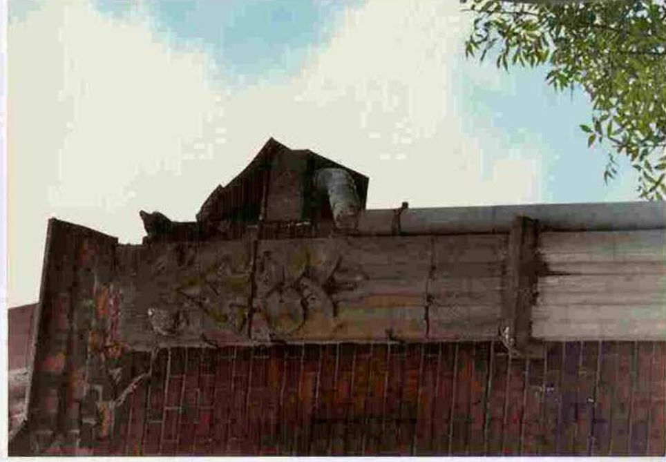
Fot. 6. Szczyt pilastra.
