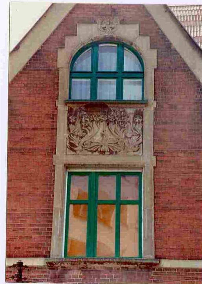
Fot. 31. Okno 2 i 3 piętra.
