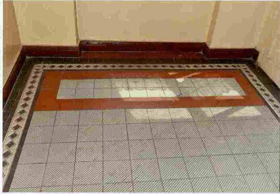
Fot. 88. Posadzka – podest schodów.
