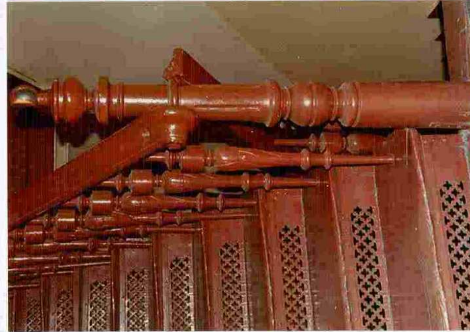
Fot. 79. Słupek balustrady.
