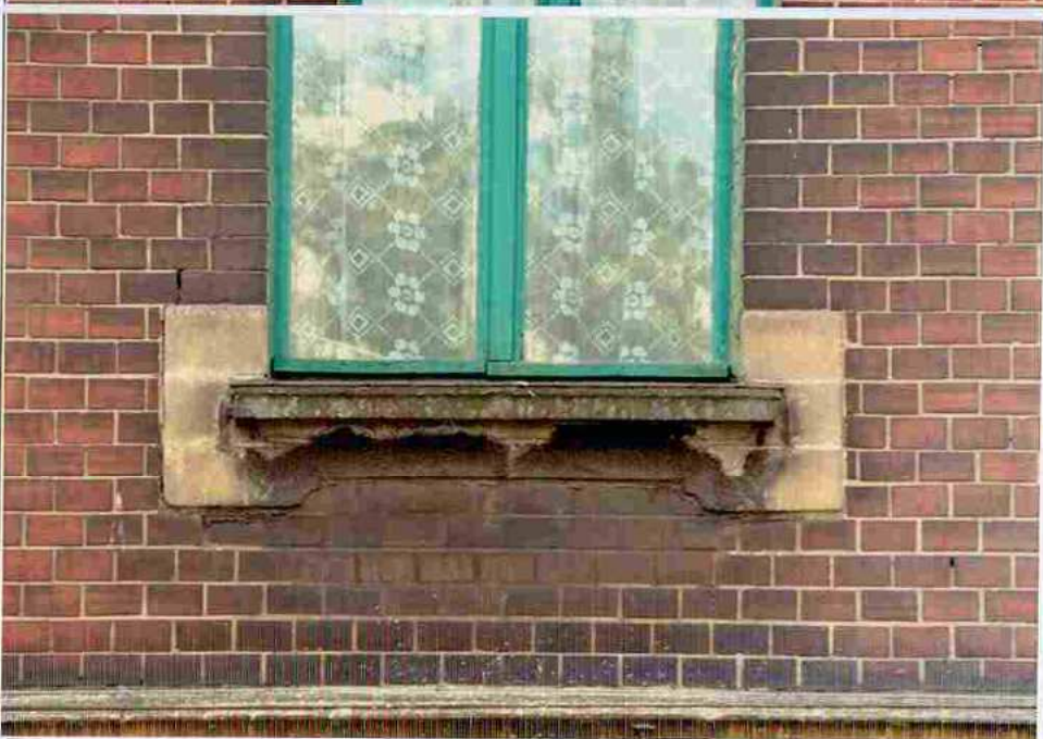
Fot. 17. Parapet okna 1 piętra.
