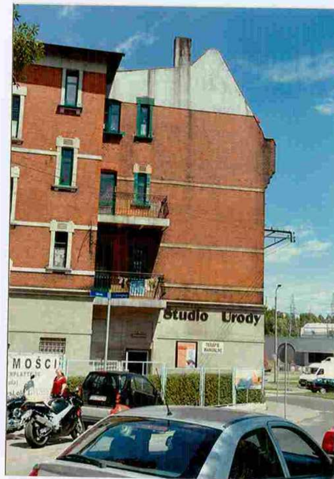
Fot. 54. Elewacja zachodnia – strona południowa.
