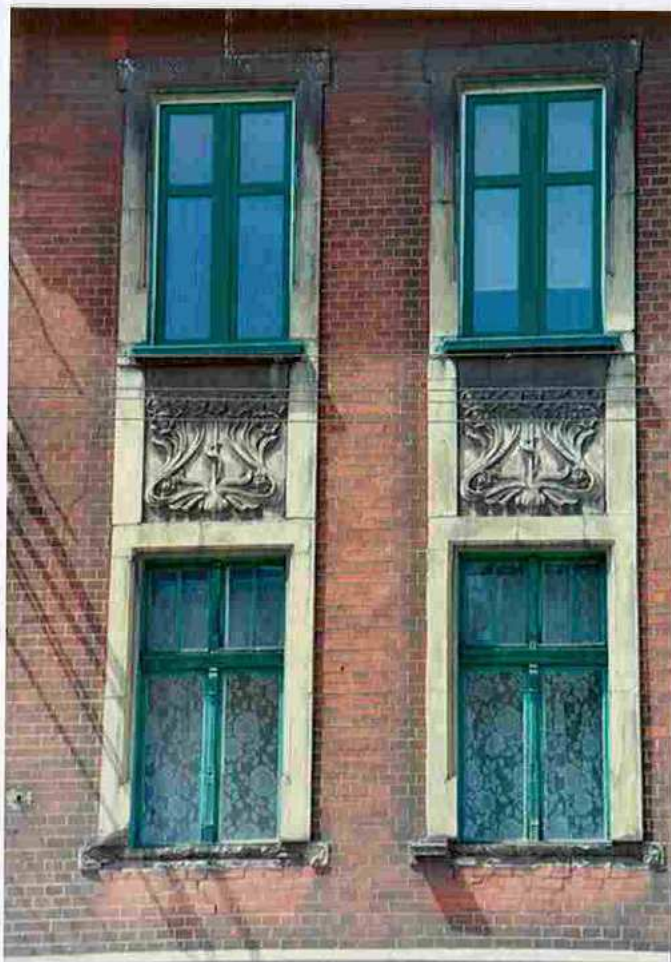
Fot. 49. Okna 2 i 3 piętra – elewacja południowa.
