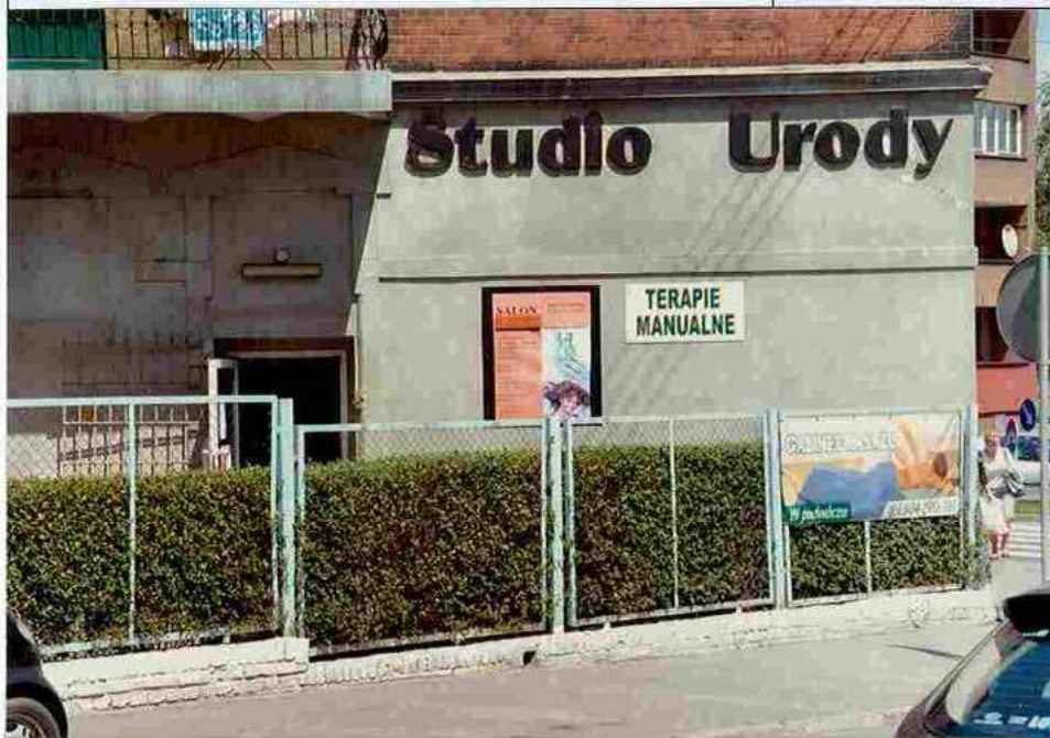
Fot. 55. Parter – elewacja zachodnia.
