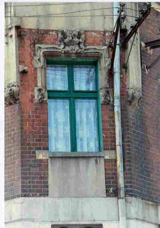
Fot. 34. Okno 1 piętra – narożnik.
