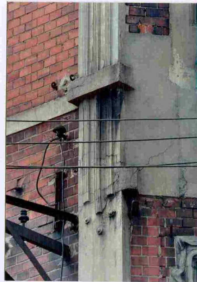
Fot. 37. Pilaster – partia środkowa.
