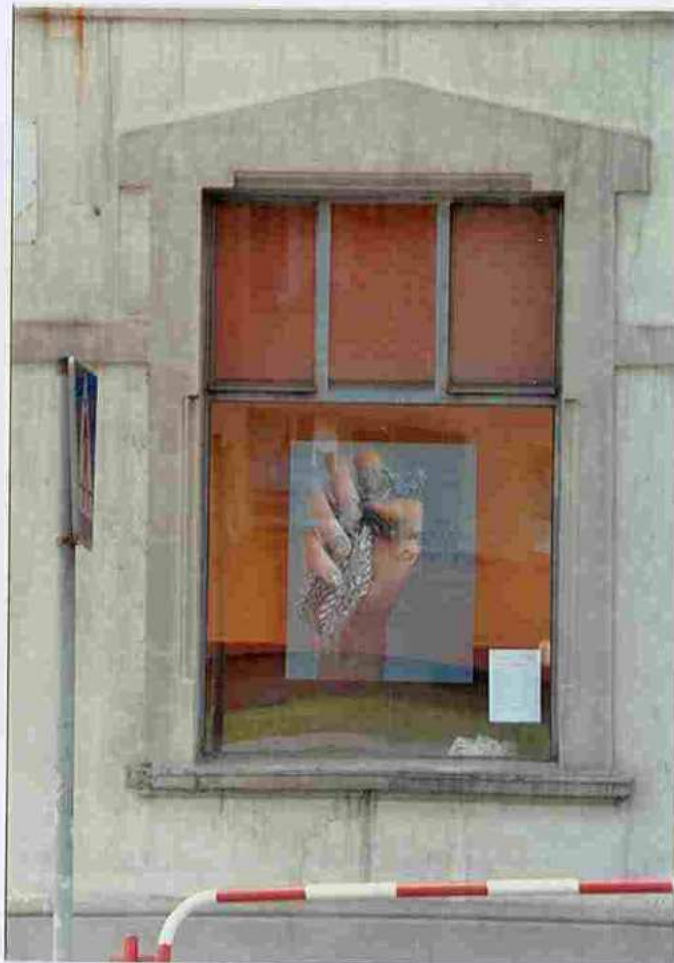
Fot. 29. Okno parteru – ryzalit po stronie południowej.
