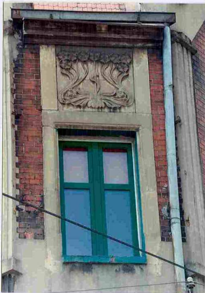
Fot. 35. Okno 2 piętra – narożnik.
