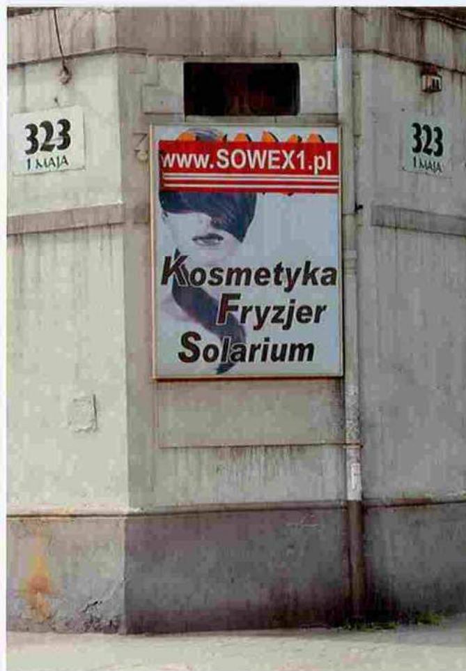
Fot. 33. Okno parteru – narożnik.
