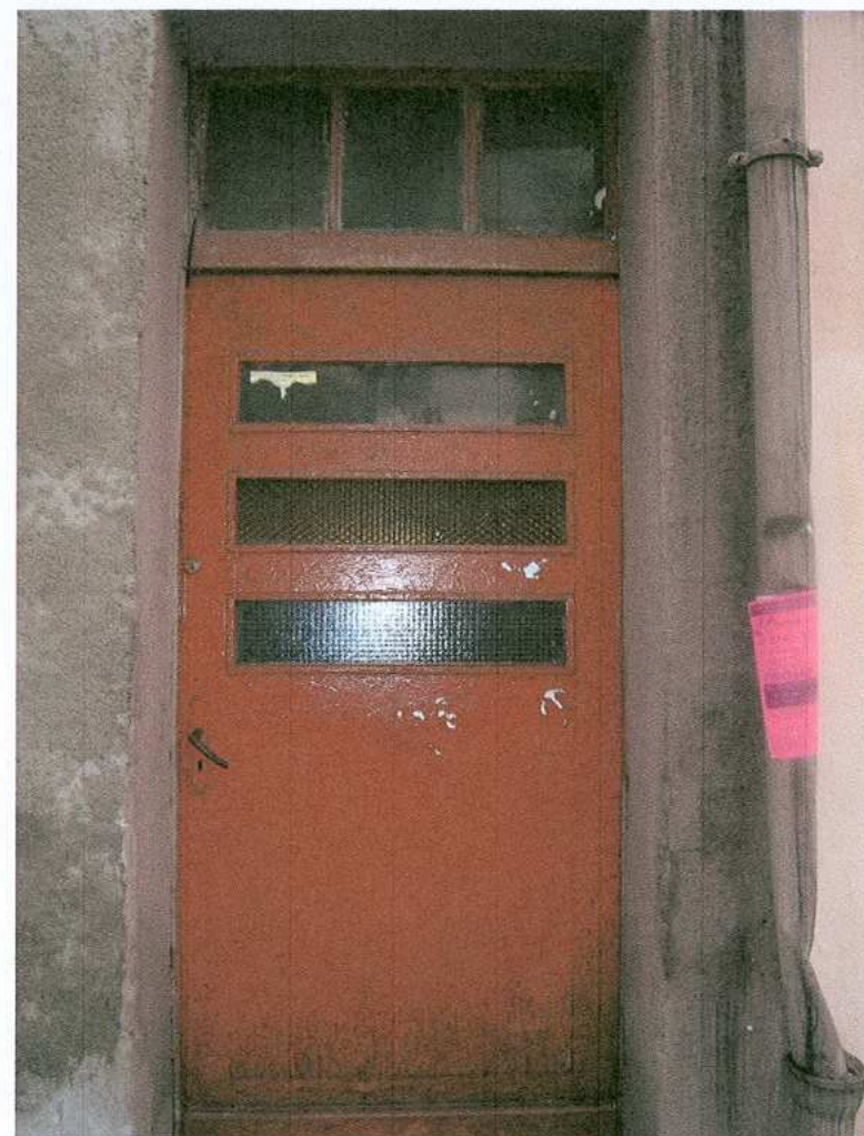
14. Drzwi wejściowe – strona zewnętrzna
