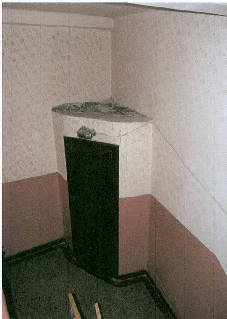
9. Sanitariat na podeście schodów
