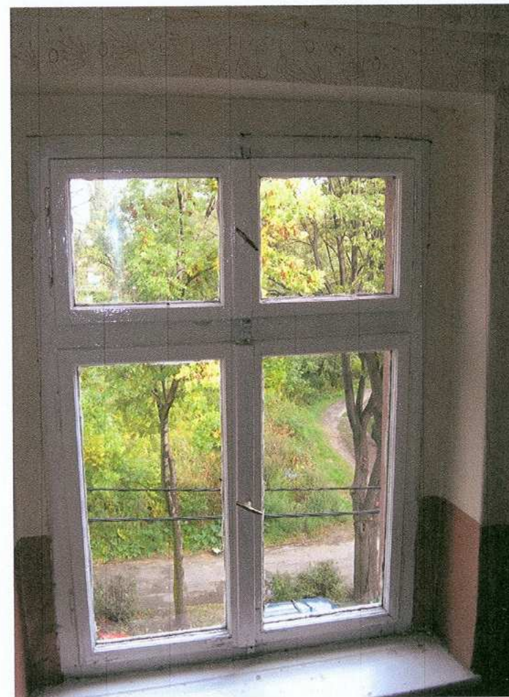
8. Okno w klatce schodowej
