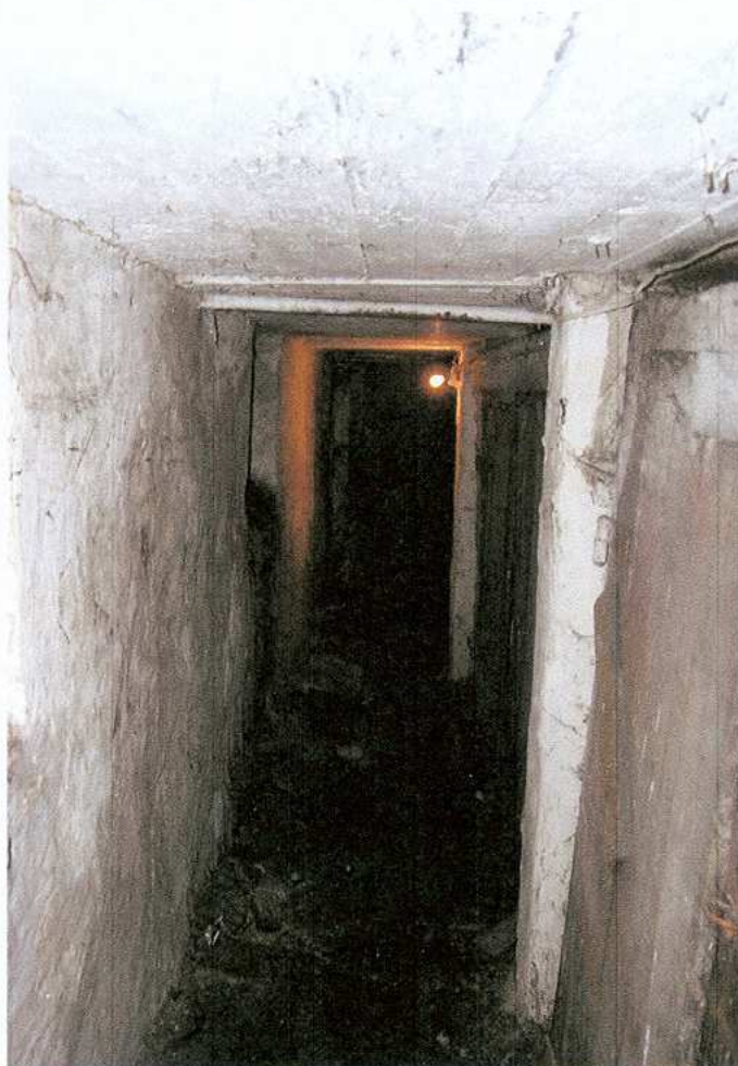
25. Strop w piwnicy
