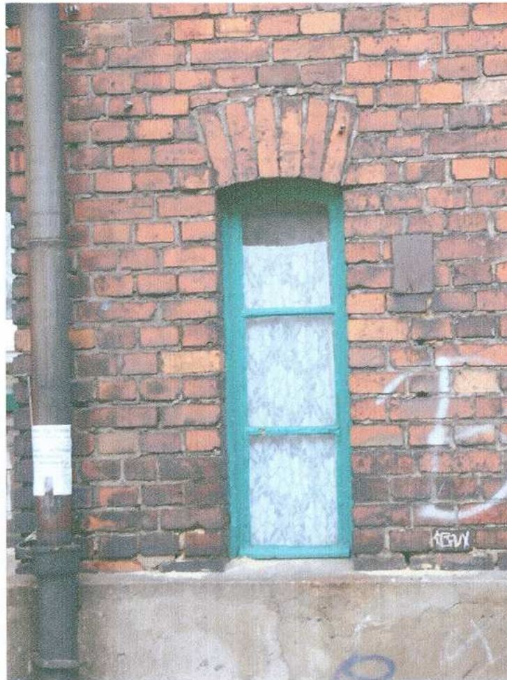
15. Fragment elewacji południowej - okno
