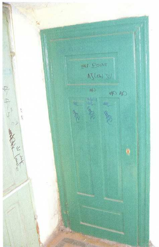
59. Stolarka drzwiowa - toaleta
