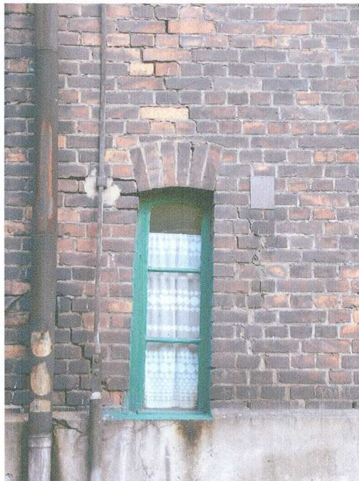
55. Fragment elewacji południowej - okno
