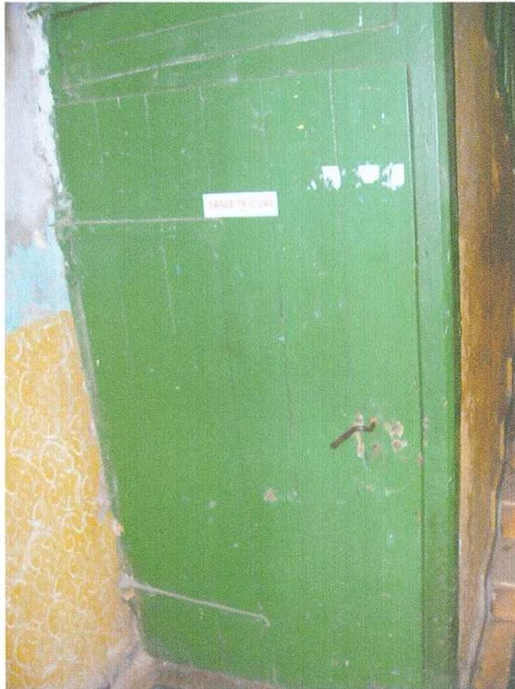
34. Klatka schodowa - piwnica
