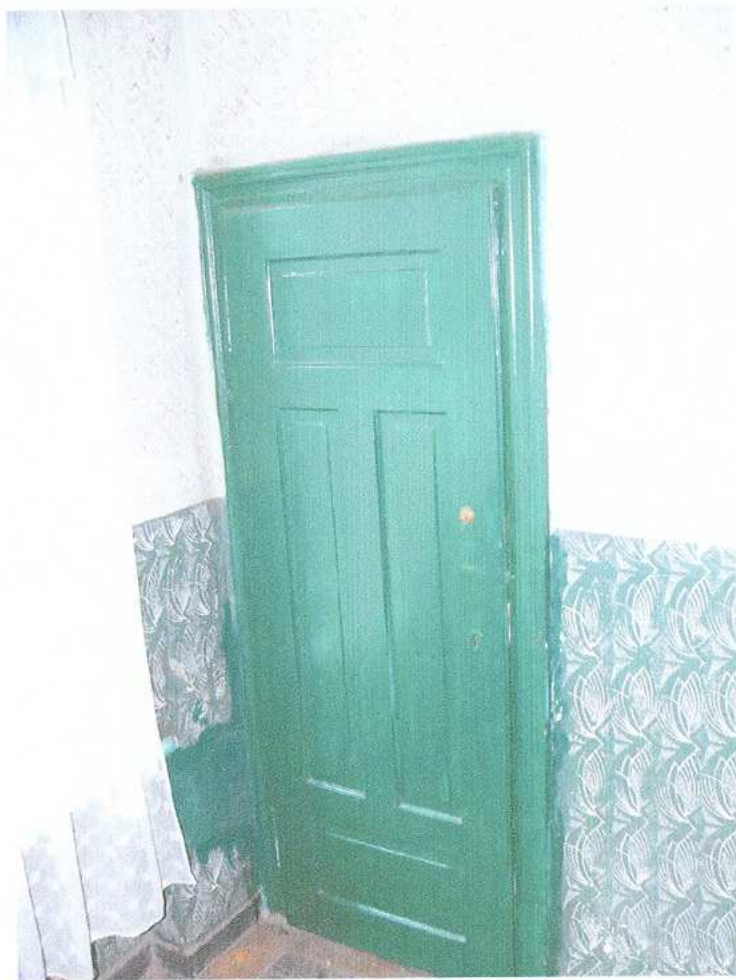
25. Klatka schodowa – stolarka drzwiowa - toaleta
