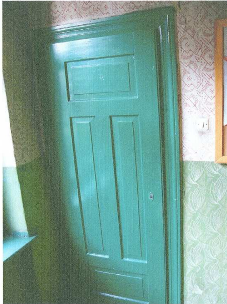
52. Stolarka drzwiowa - toaleta
