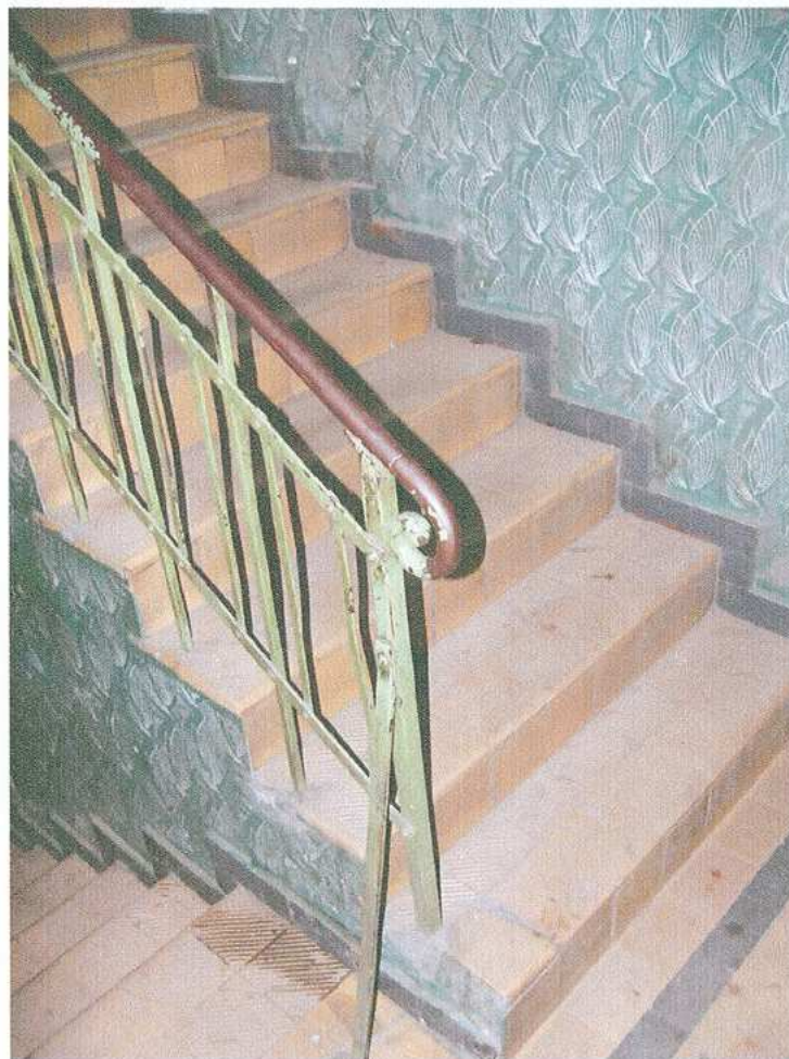
21. Klatka schodowa - bariera
