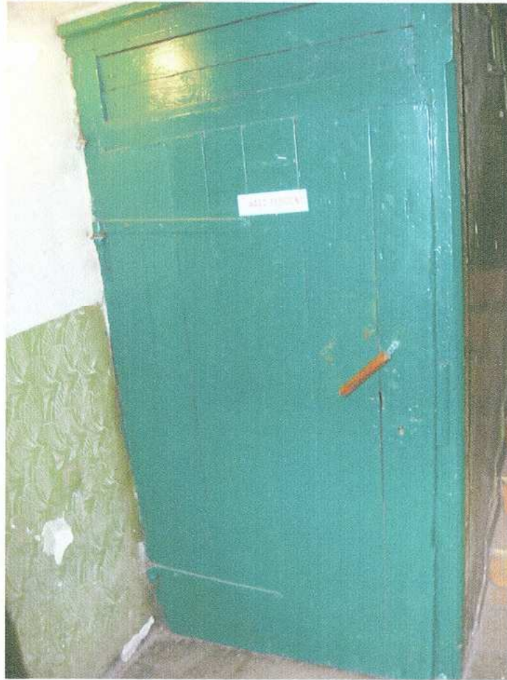
41. Stolarka drzwiowa - piwnica
