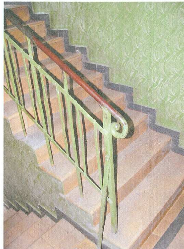
38. Klatka schodowa - bariera
