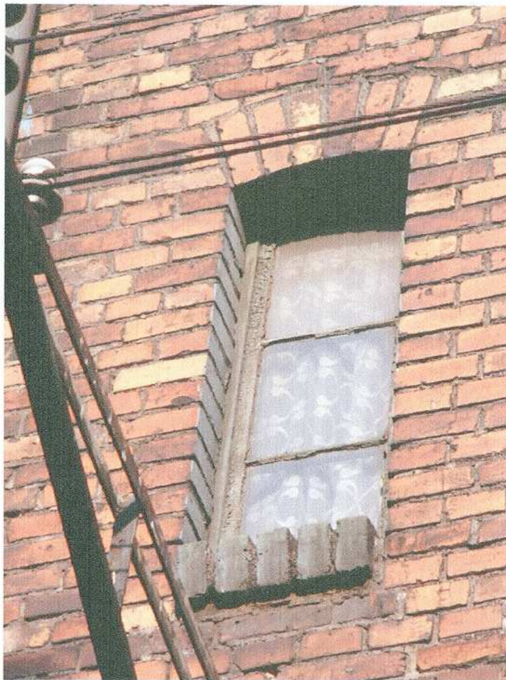
37. Fragment elewacji południowej - okno
