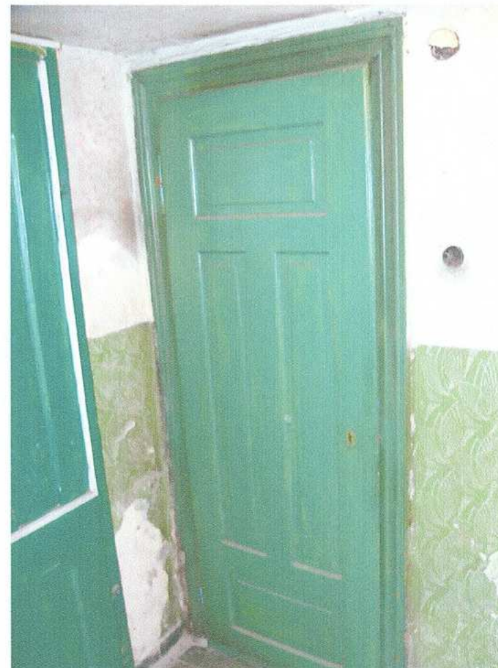
40. Stolarka drzwiowa - toaleta
