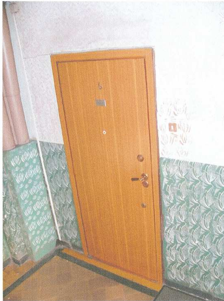
23. Klatka schodowa – stolarka drzwiowa
