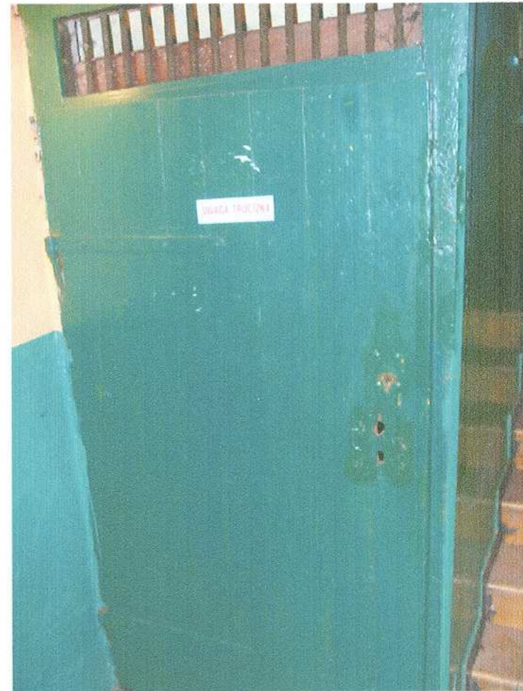
51. Stolarka drzwiowa - piwnica
