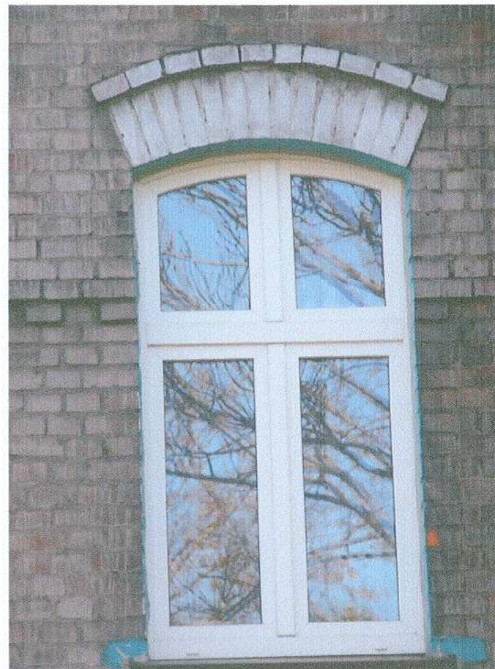
12. Fragment elewacji północnej - okno
