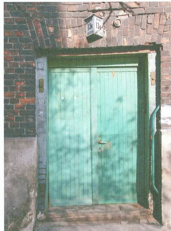
54. fragment elewacji południowej - drzwi
