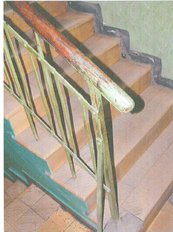
49. Klatka schodowa - bariera
