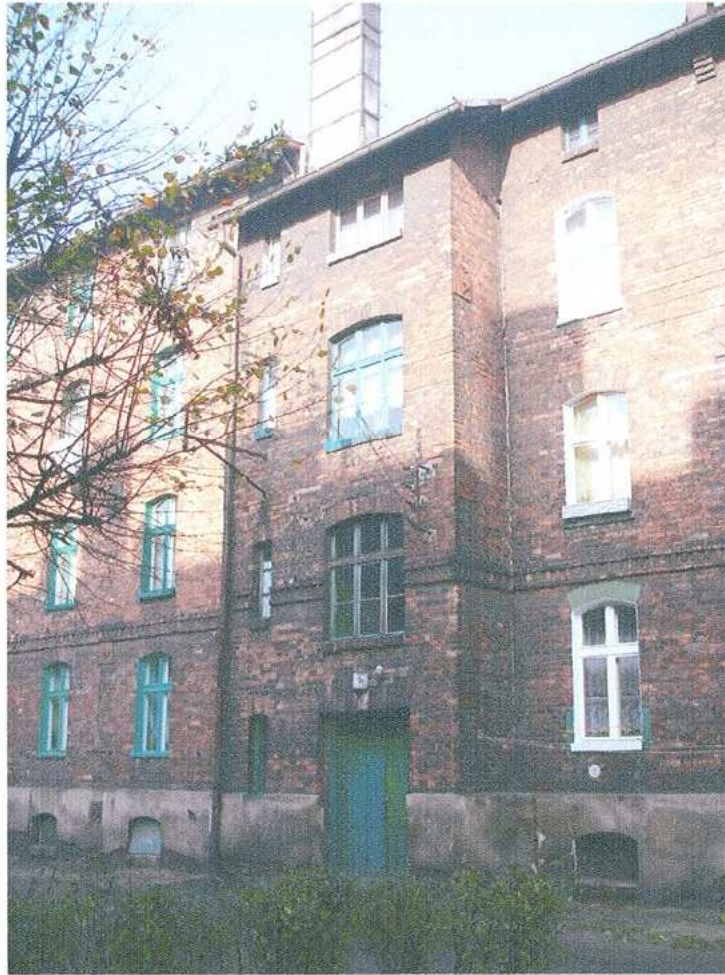
42. Fragment elewacji południowej
