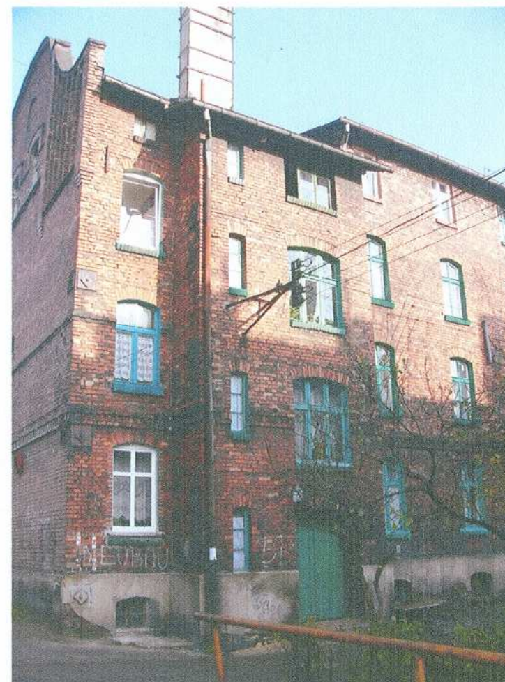
14. Fragment elewacji południowej
