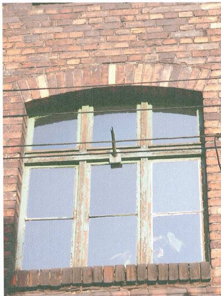
28. Fragment elewacji południowej - okno
