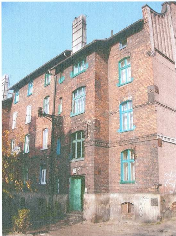
53. fragment elewacji południowej
