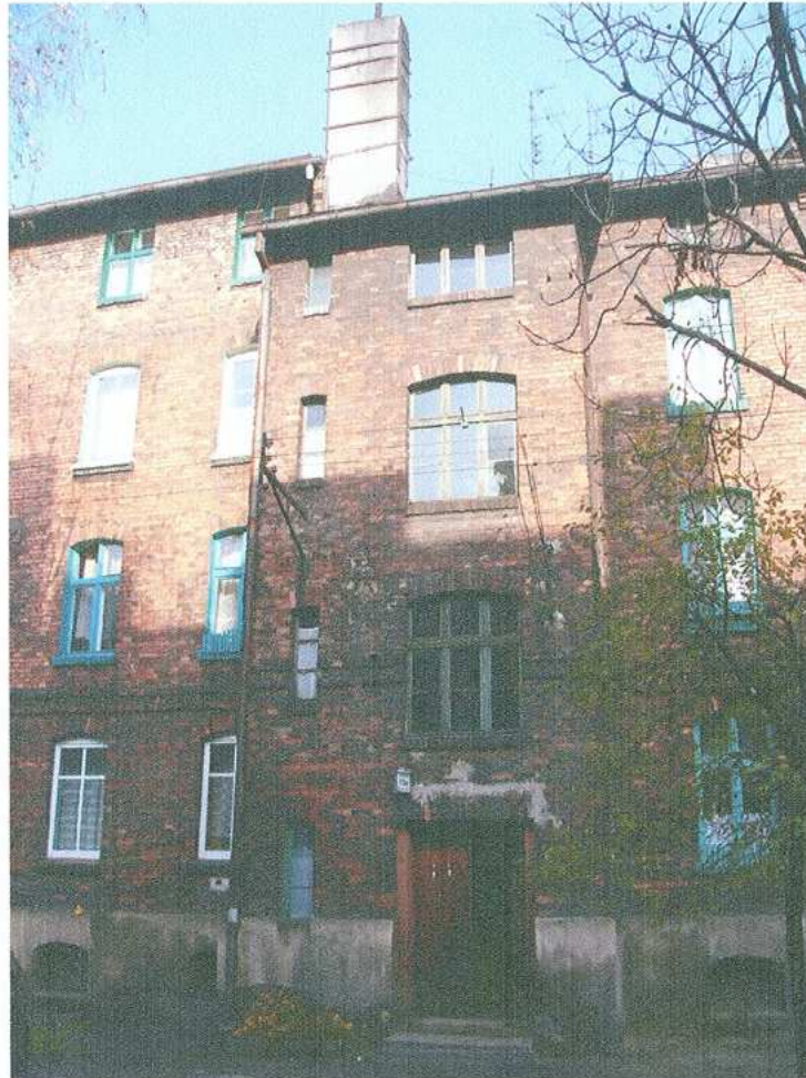
26. fragment elewacji południowej
