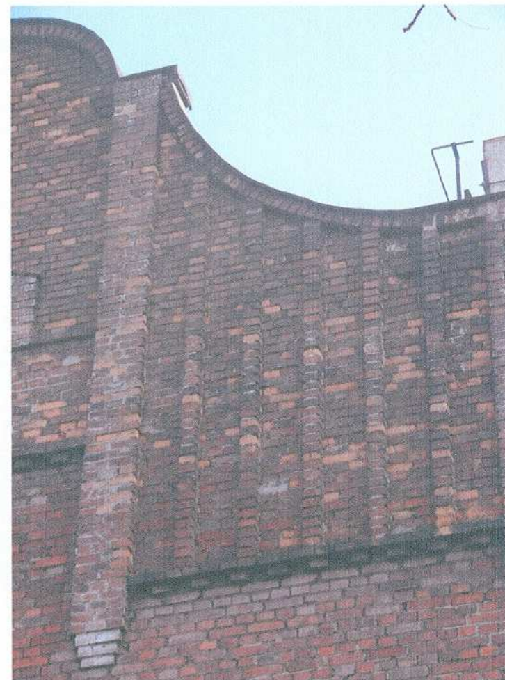
8. Fragment elewacji zachodniej – szczyt - detal
