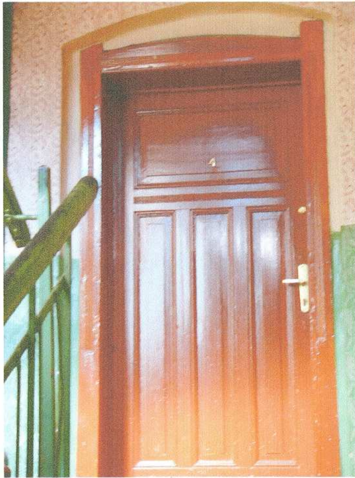
50. Klatka schodowa - stolarka drzwiowa
