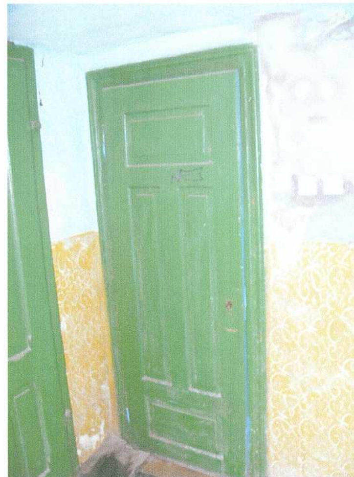
33. Klatka schodowa - Toaleta
