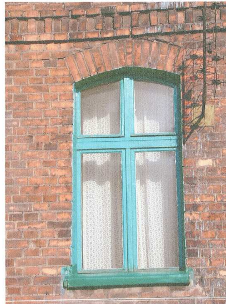
56. Fragment elewacji południowej - okno
