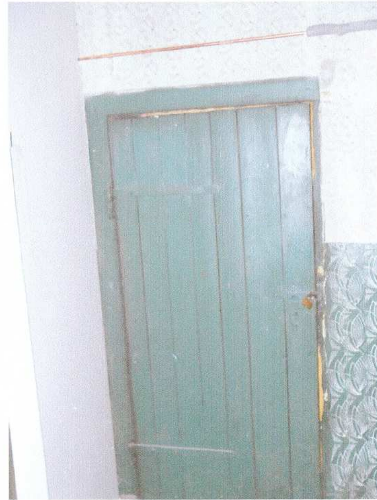
24. Klatka schodowa – stolarka drzwiowa - strych
