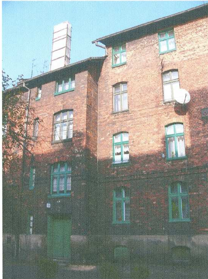
35. Fragment elewacji południowej
