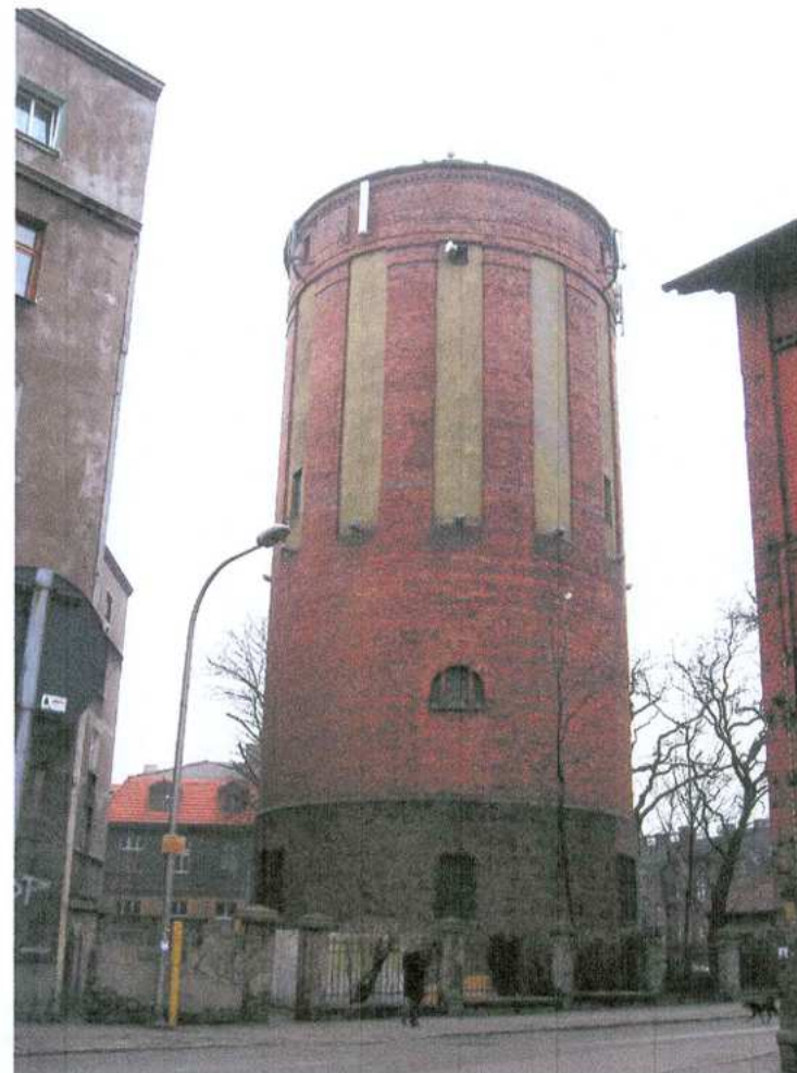
2. Widok od strony północnej
