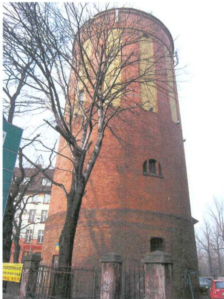
1. Widok od strony południowej
