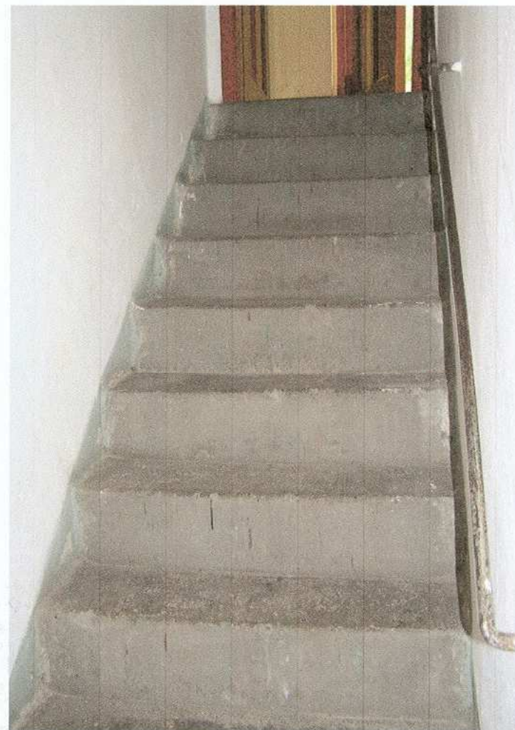
20. Schody do piwnicy
