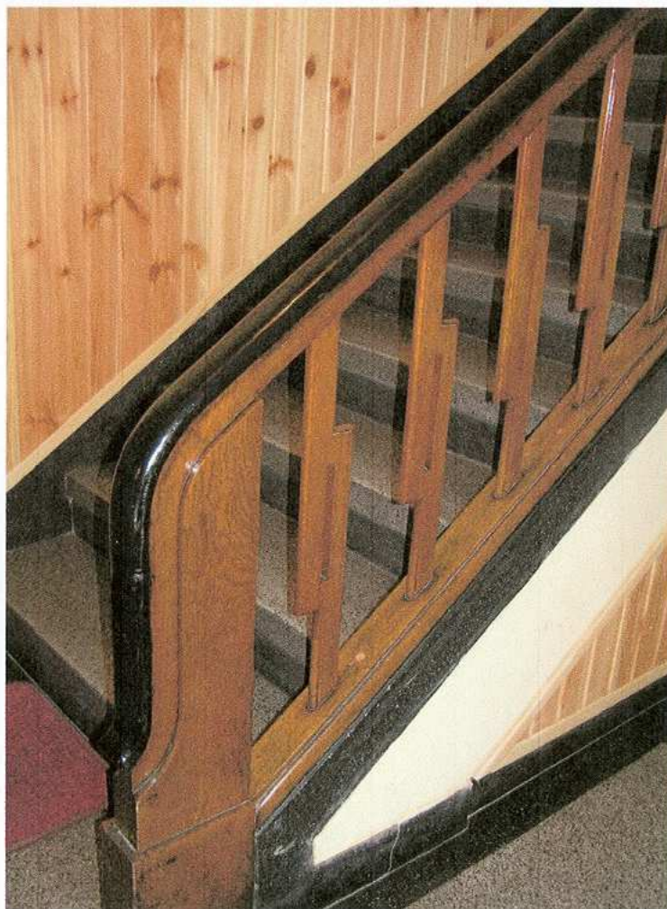
19. Klatka schodowa - balustrada
