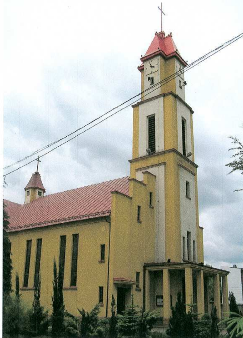
1. Fasada oraz fragment elewacji zach.
