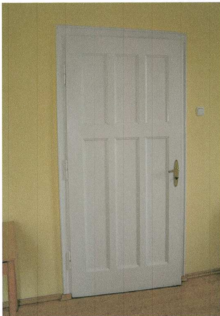
17. Typowa pierwotna stolarka drzwiowa wewnętrzna
