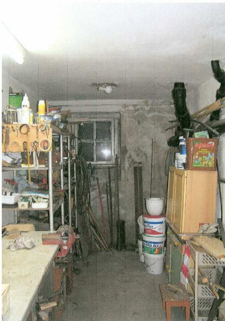
27. Pomieszczenie piwniczne - magazyn
