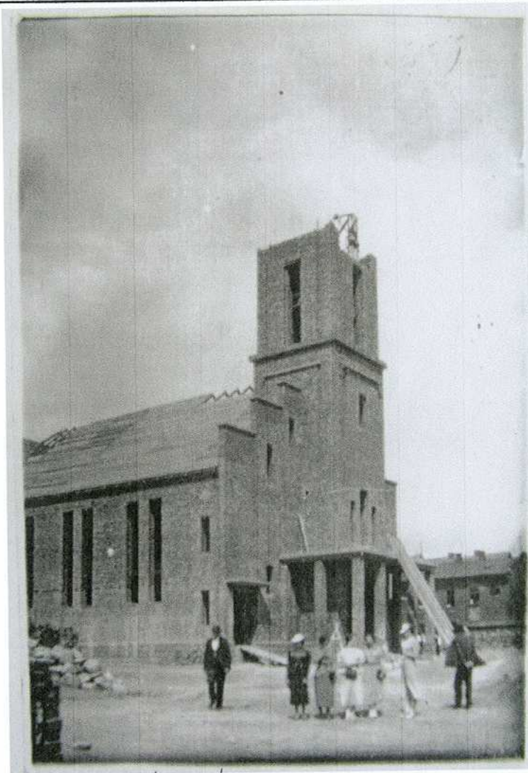
Kościół w trakcie budowy
