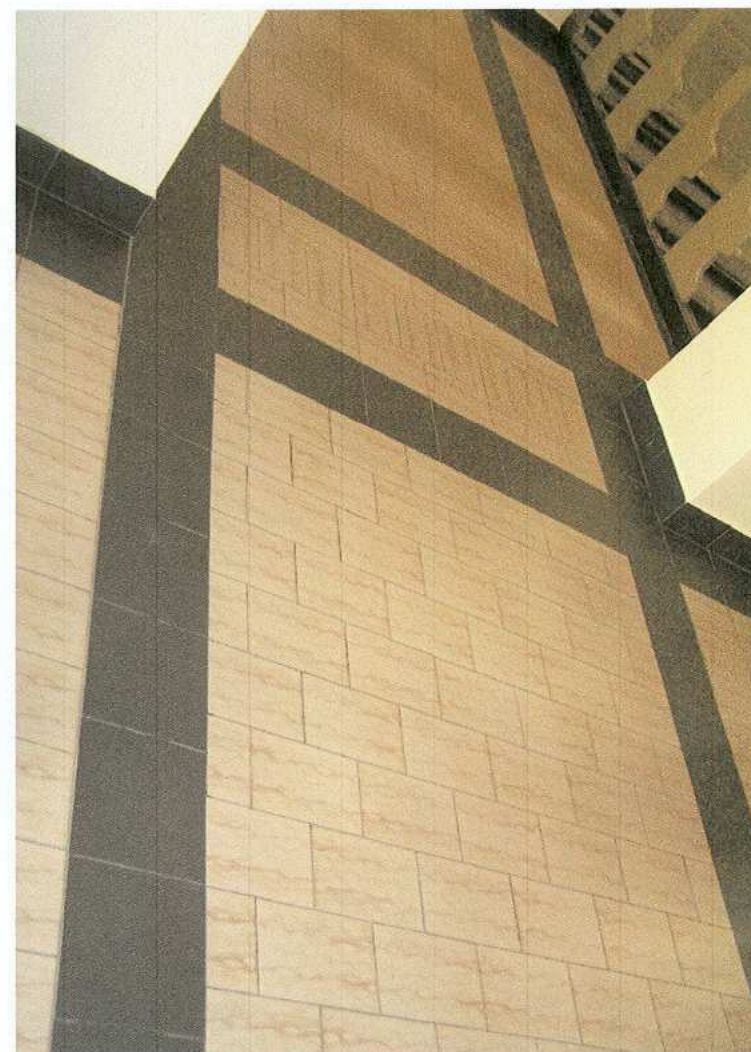
18. Posadzka w nawie
