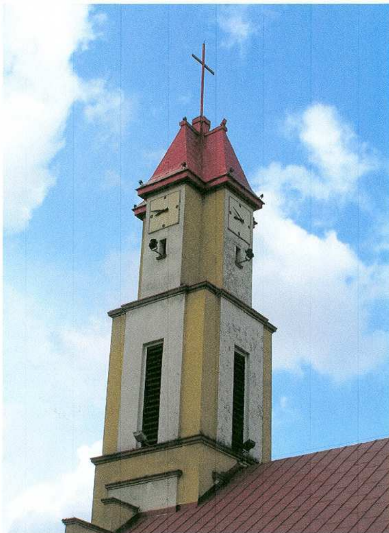
7. Górne partie wieży
