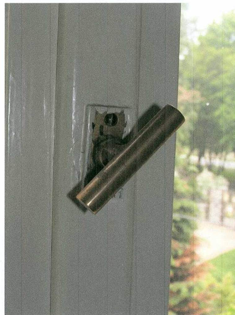
10. Klamka pierwotnej stolarki okiennej
