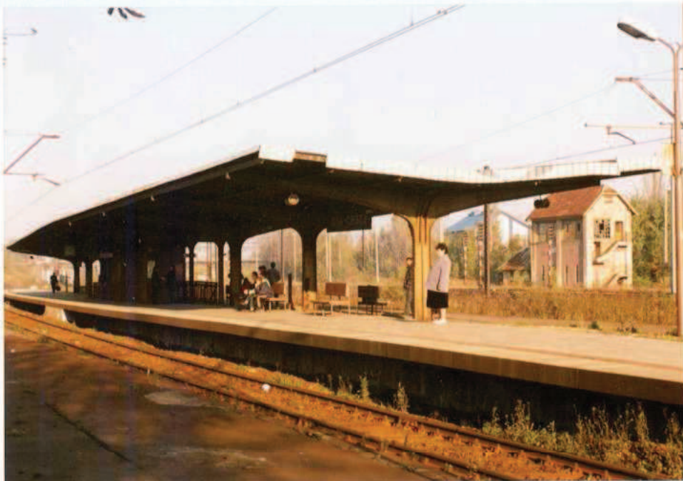
32. Widok na peron na trasie Głiwice – Katowice.
