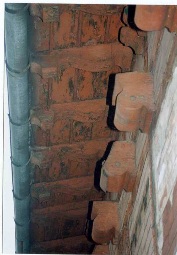
7. Fragment okapu dachu.
