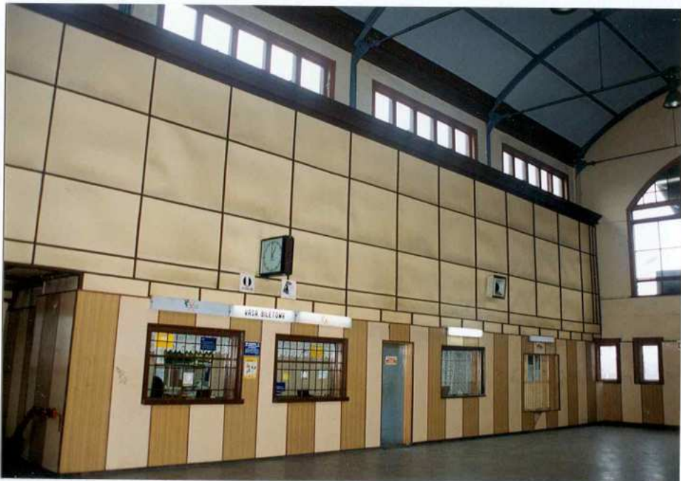
18. Widok wnętrza hali dworcowej.
