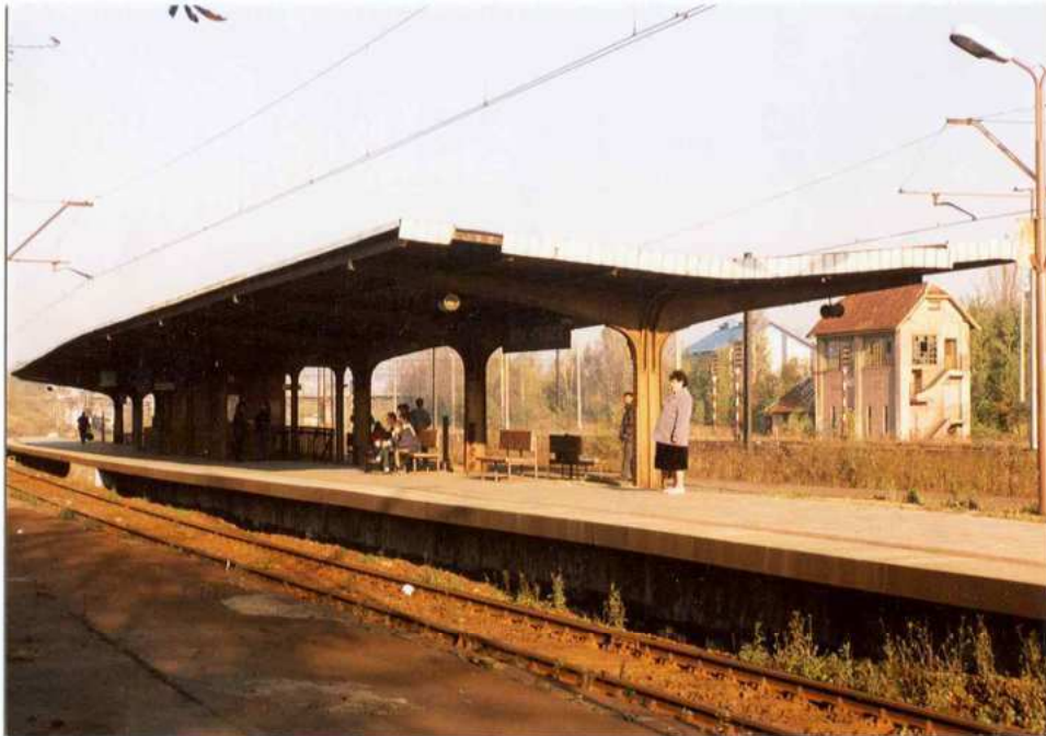
32. Widok na peron na trasie Gliwice – Katowice.
