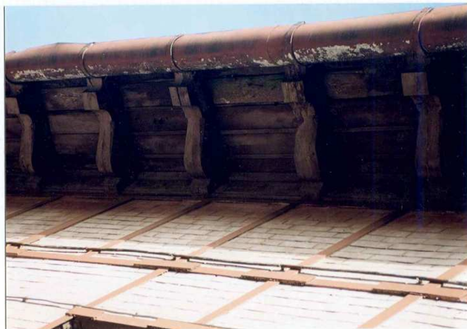
14. Fragment okap dachu.
