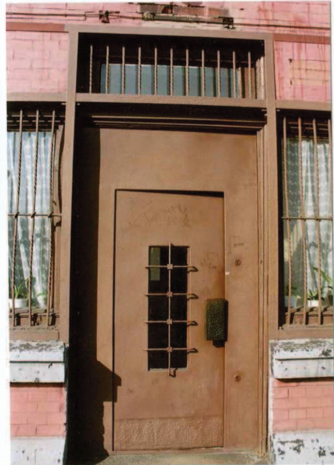
5. Drzwi w elewacji południowo-wschodniej.
