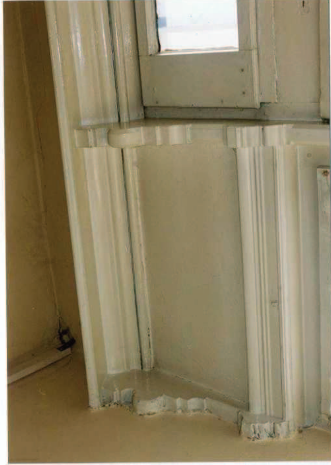
12, 13 Fragment zachowanej stolarki portalu w części wschodniej.
