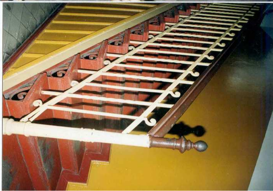
8. Schody na piętro .
