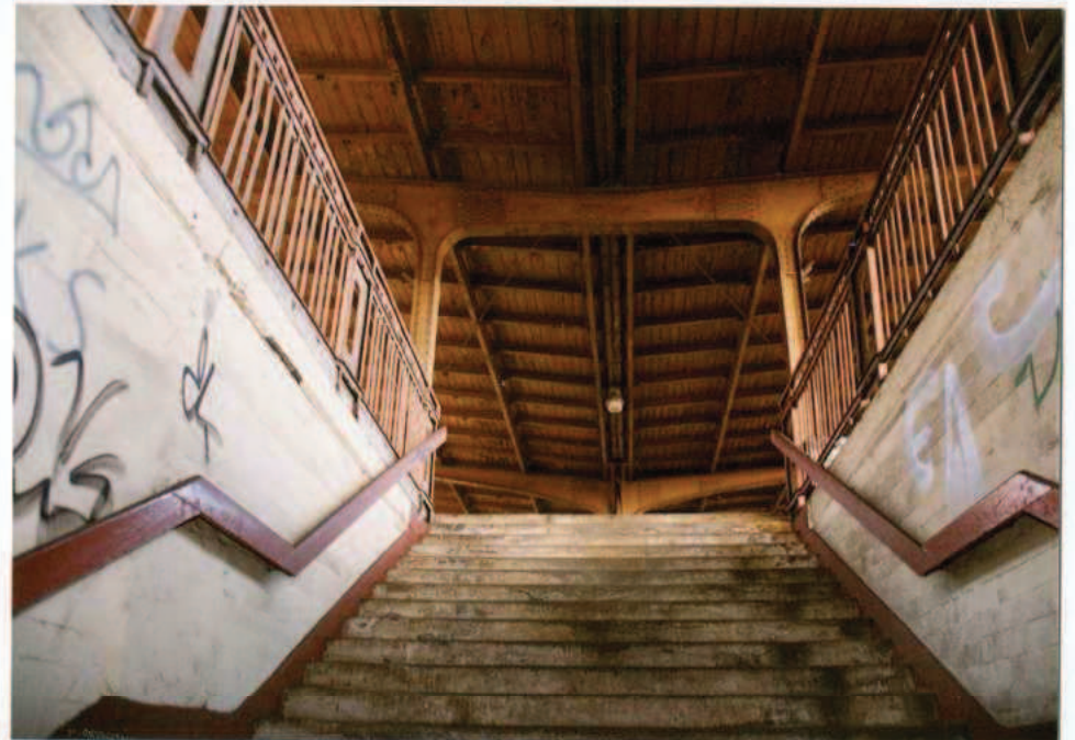
33. Wyjście na peron z tunelu.
