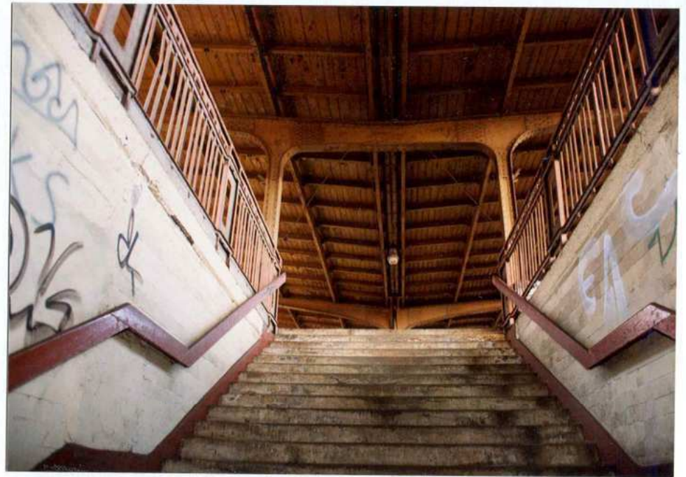
33. Wyjście na peron z tunelu.
