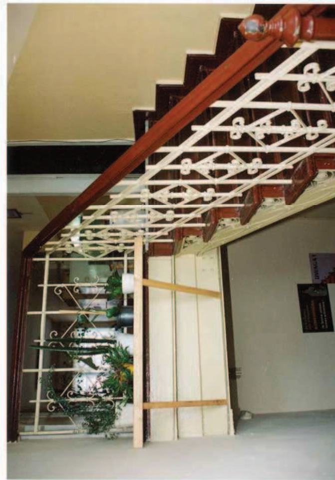
7., 8., 9 Widok na klatkę schodową.
