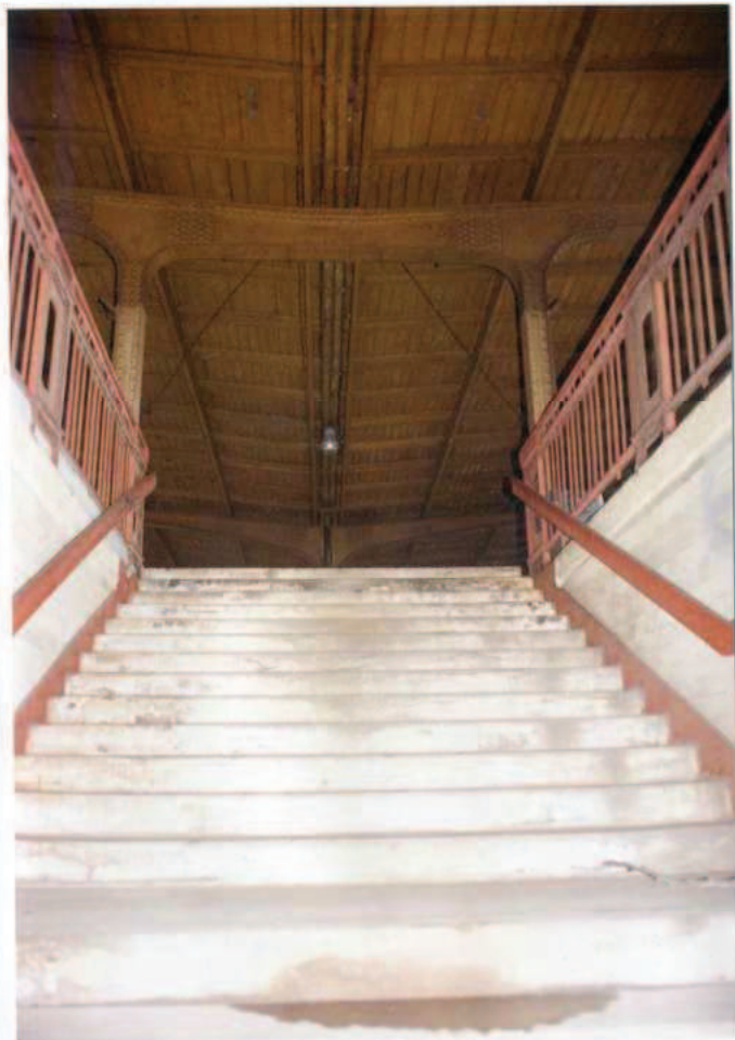
36. Zejście z peronu do tunelu.
