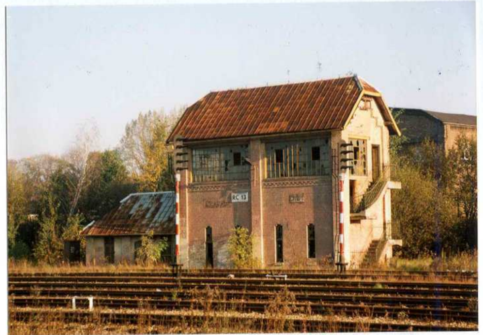
39. Budynek nastawni w północnej części zespołu dworca.
