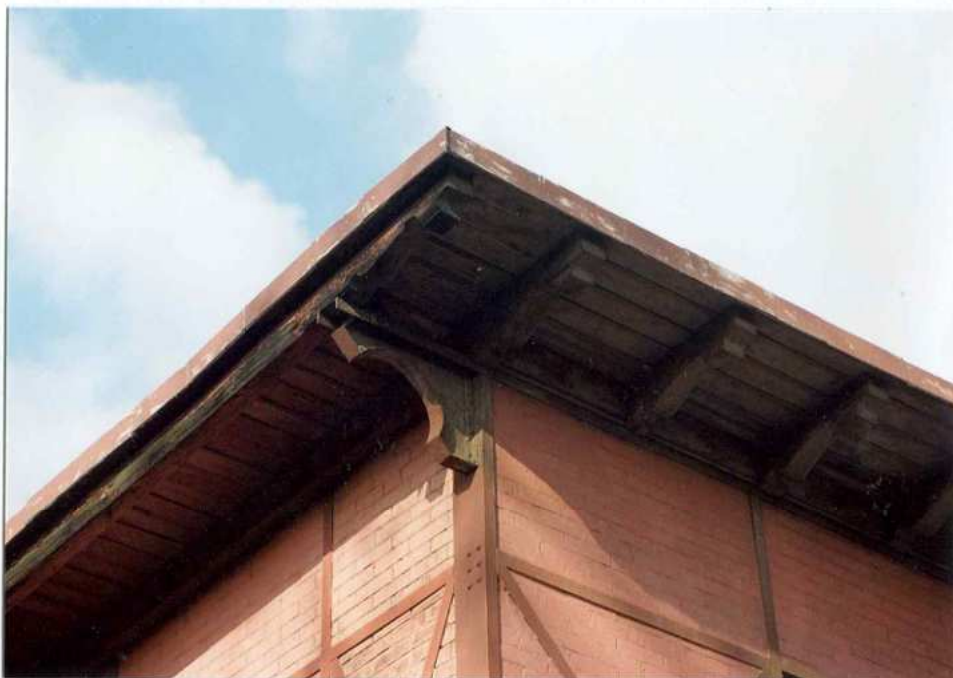
6. Fragment okapu dachu.
