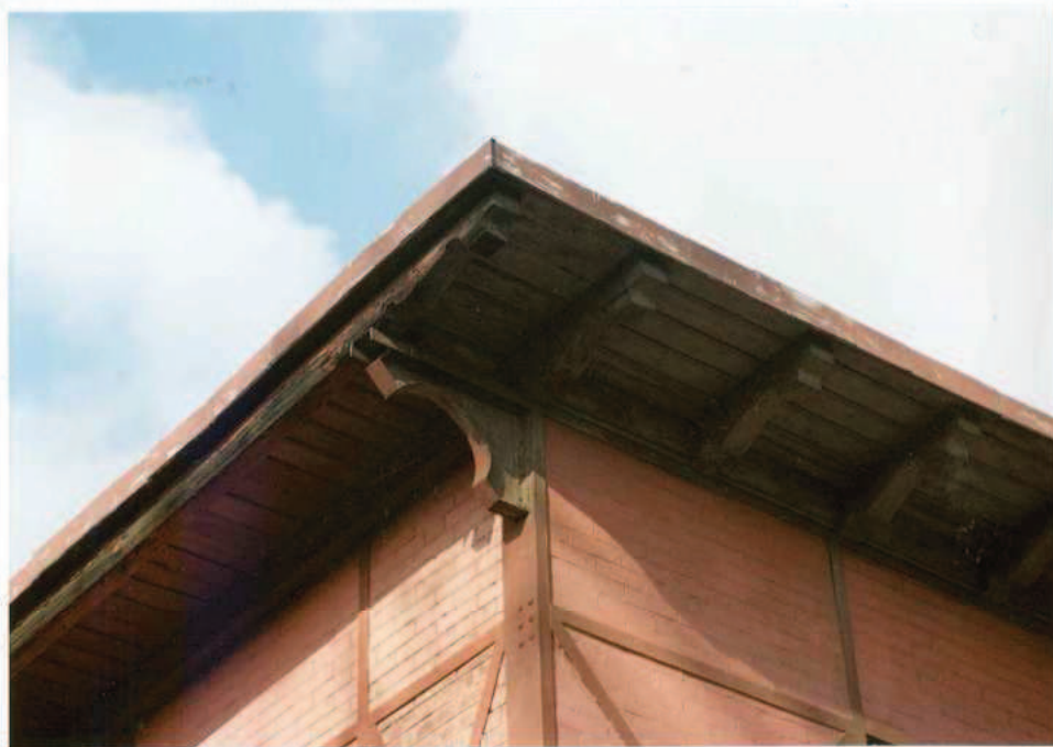
6. Fragment okapu dachu.
