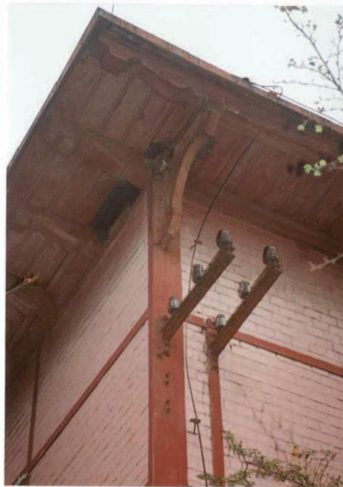
5. Fragment okapu dachu.
