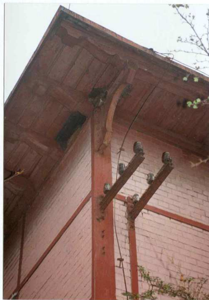
5. Fragment okapu dachu.
