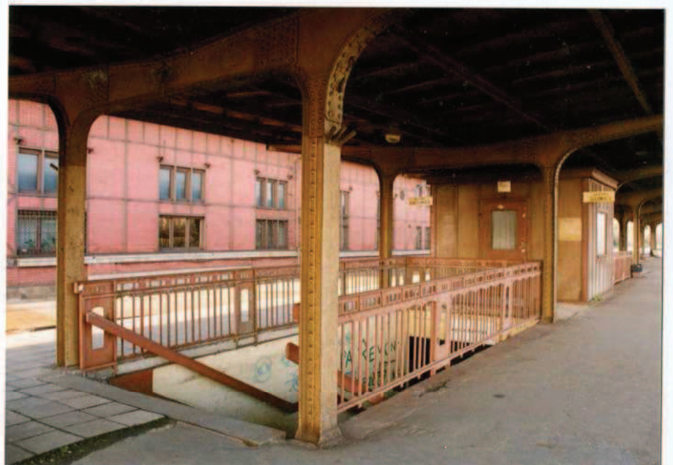
35. Widok na klatkę schodową prowadzącą do tunelu.
