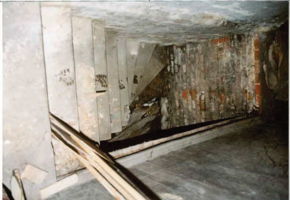
7. Schody do piwnicy.
