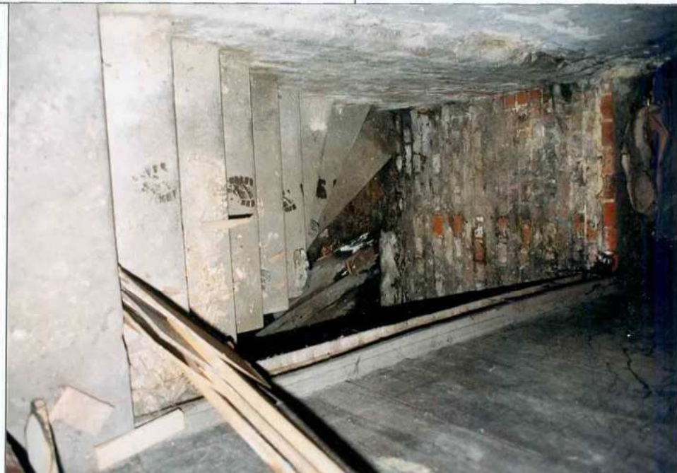
7. Schody do piwnicy.
