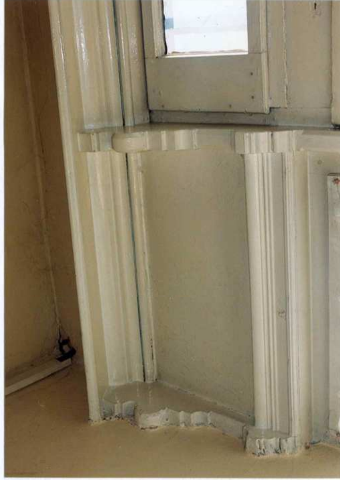
12, 13 Fragment zachowanej stolarki portalu w części wschodniej.
