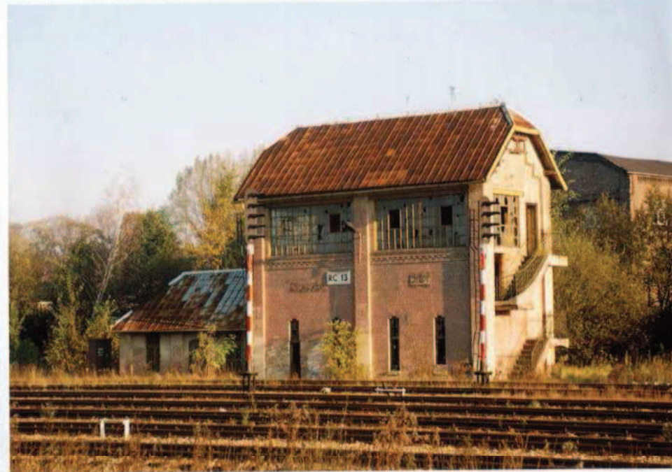
39. Budynek nastawni w północnej części zespołu dworca.
