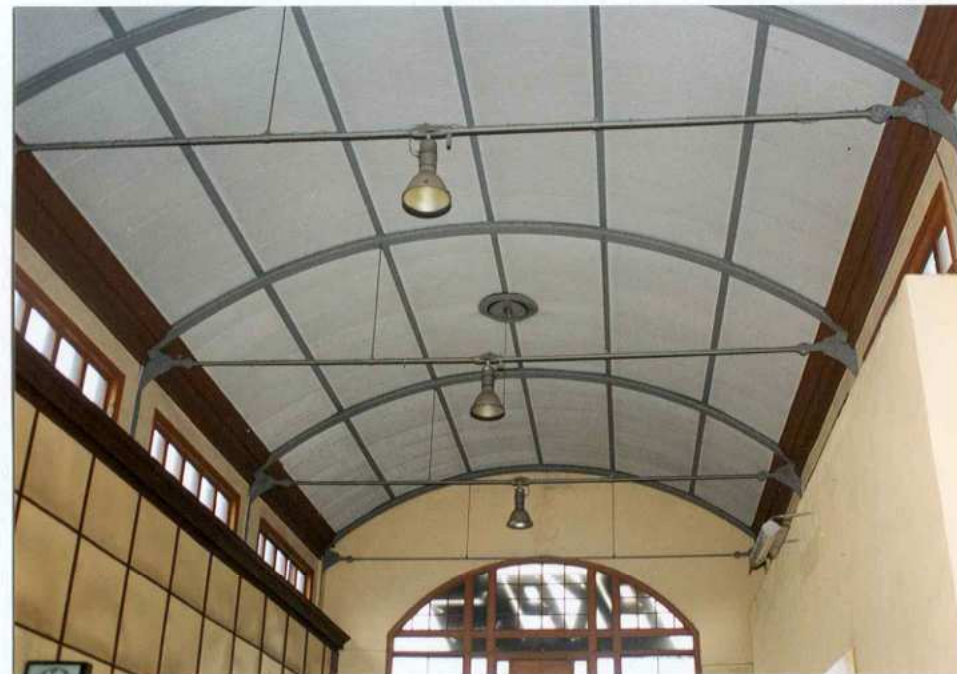
19. Widok dachu nad halą dworca.
