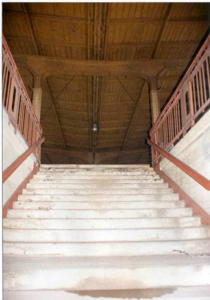
36. Zejście z peronu do tunelu.
