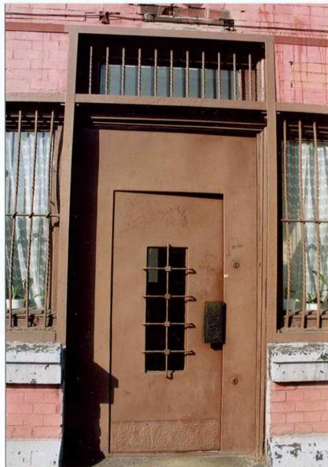
5. Drzwi w elewacji południowo-wschodniej.
