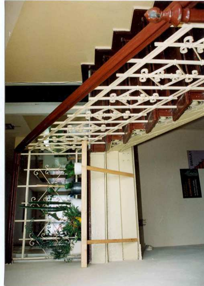
7., 8., 9 Widok na klatkę schodową.
