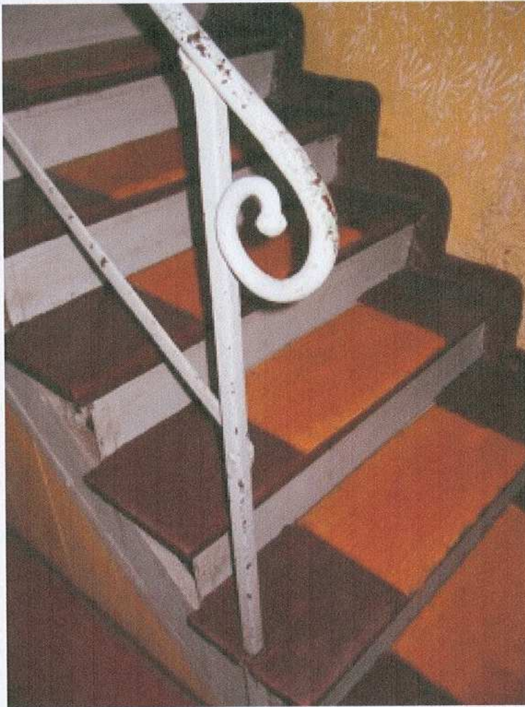
13. klatka schodowa – fragment bariery
