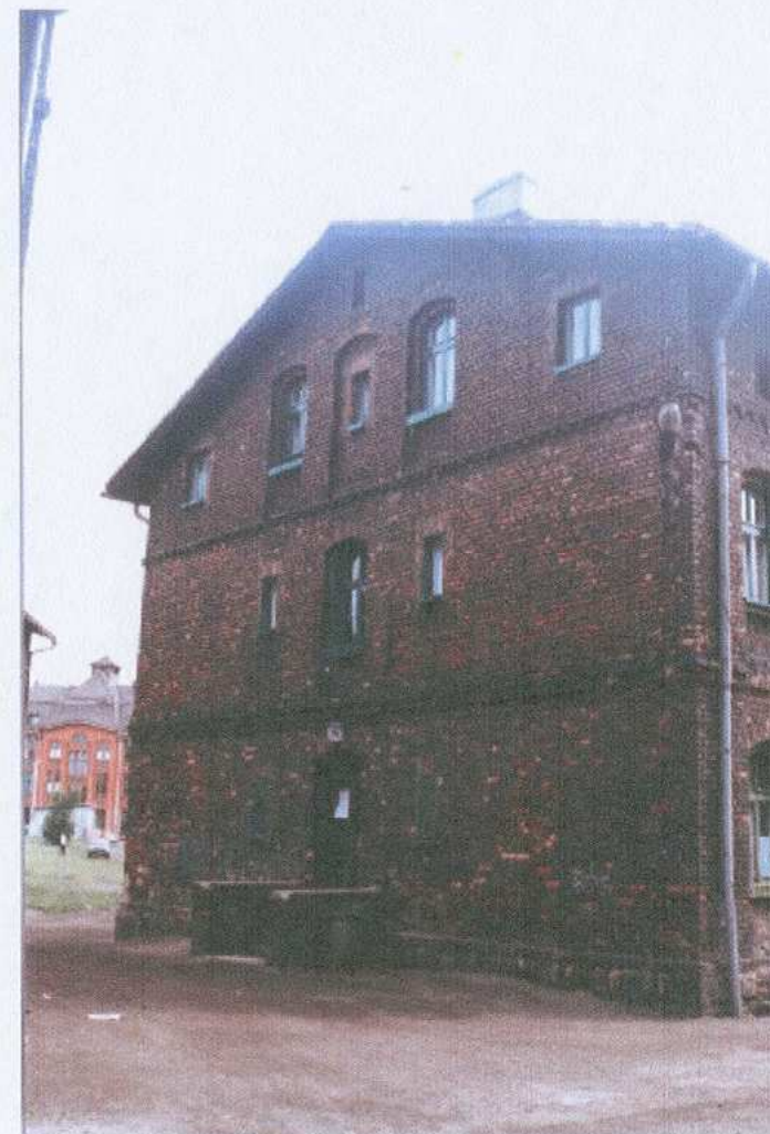
4. elewacja zachodnia – widok od strony południowo-zachodniej
