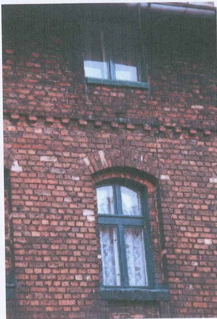
9. fragment elewacji północnej - okna
