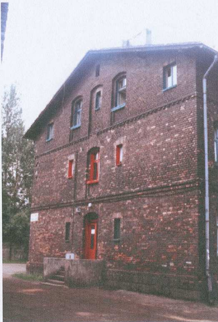
3. elewacja wschodnia – widok od strony północno - wschodniej
