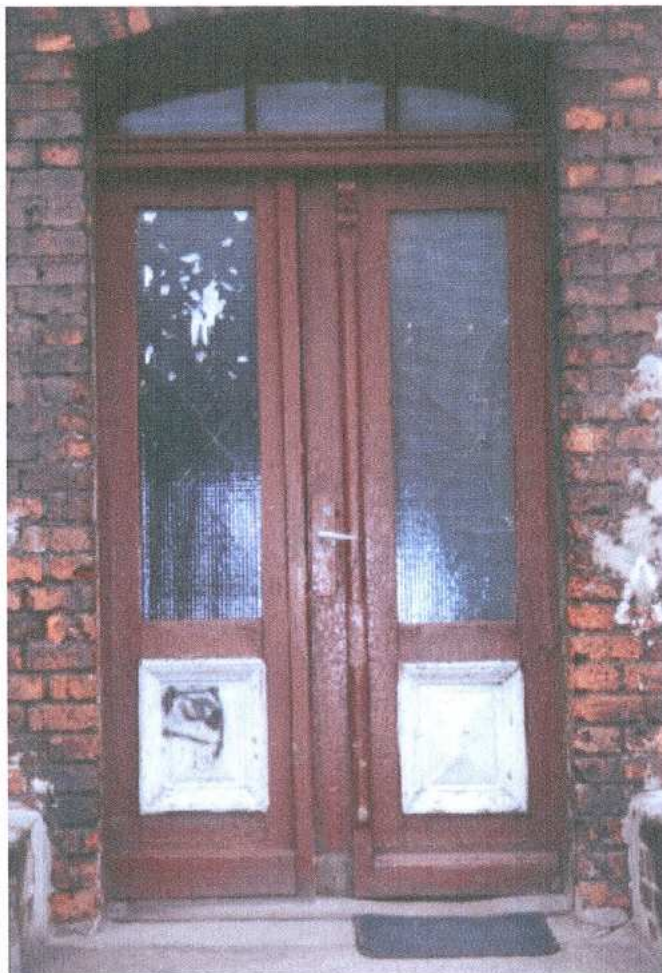
5. fragment elewacji północnej - drzwi
