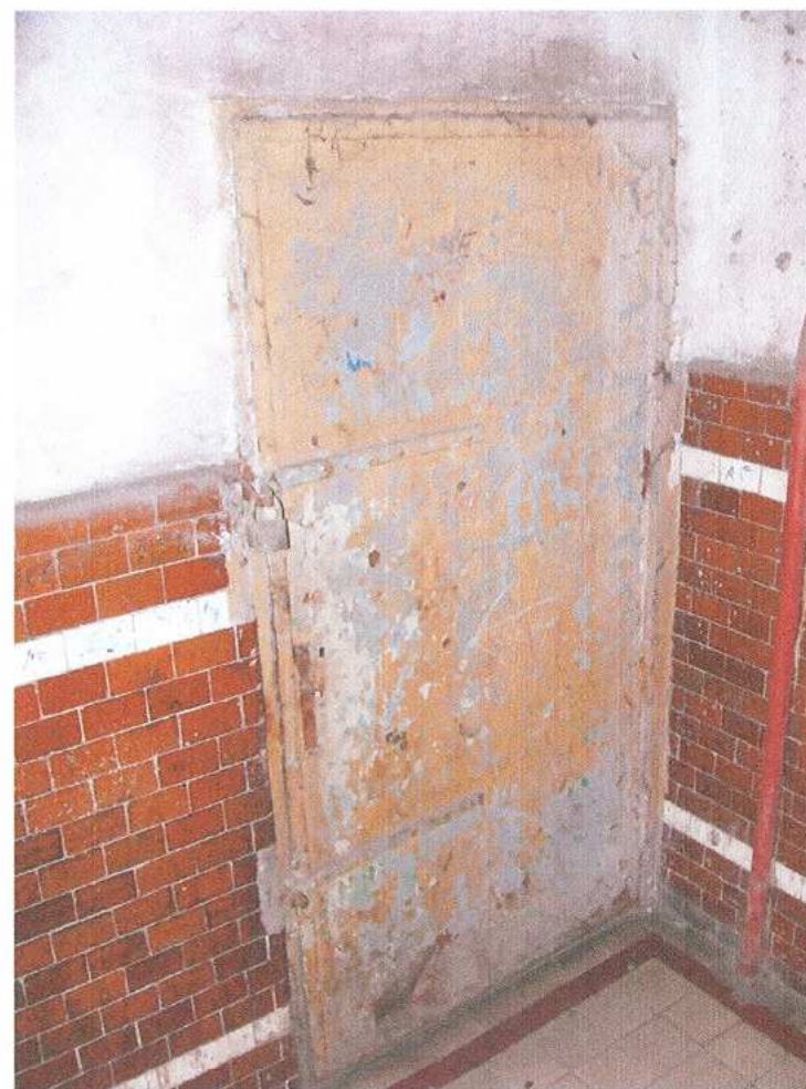
34.Klatka schodowa. Stolarka drzwiowa.
