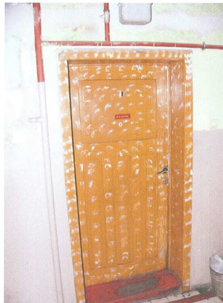
54.Klatka schodowa. Stolarka drzwiowa.
