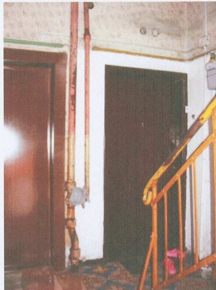
26. klatka schodowa - drzwi
