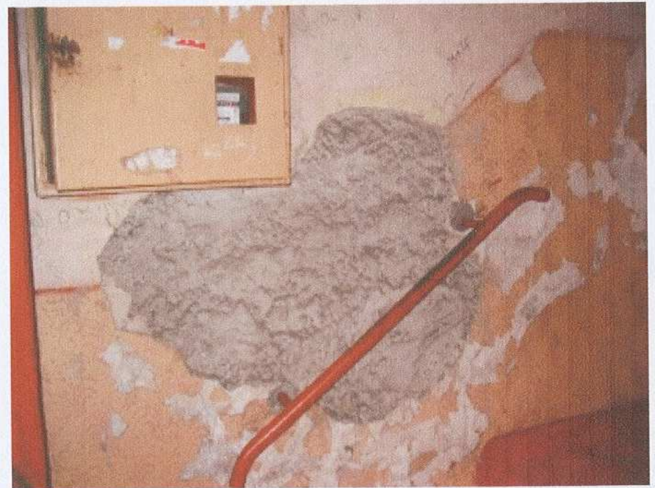
22. fragment klatki schodowej
