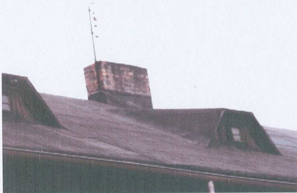
9. fragment dachu – widok od strony wschodniej
