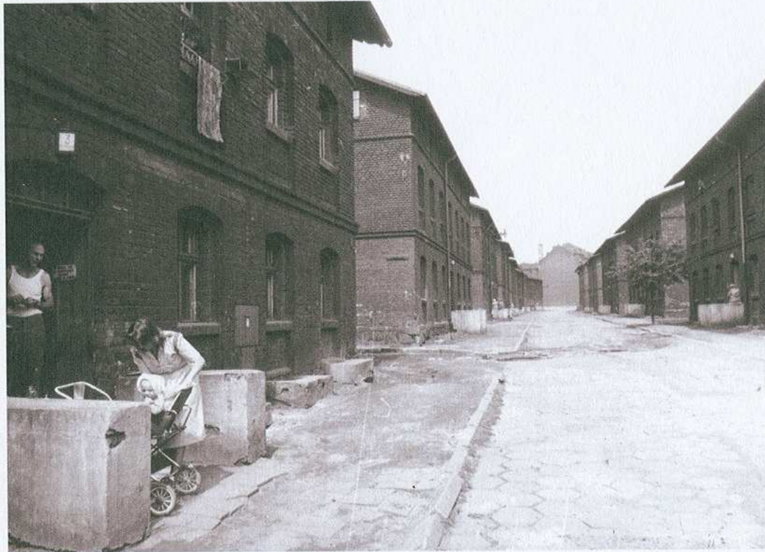
nieistniejąca zabudowa Gwardii Ludowej - zdjęcie z 1970r.
