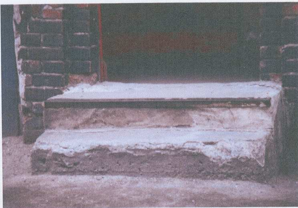
11. fragment elewacji zachodniej (frontowej) - schody
