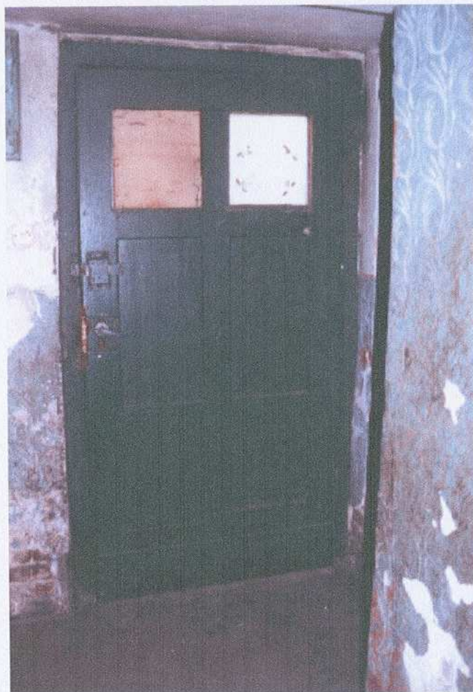
17. drzwi zewnętrzne – widok od wewnątrz
