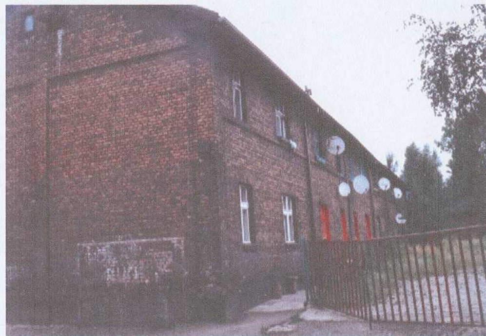
6. elewacja wschodnia – widok od strony południowo-wschodniej
