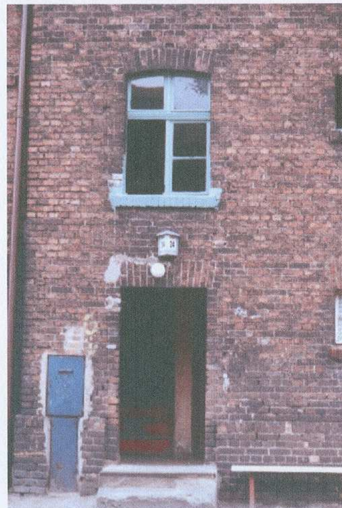
10. fragment elewacji zachodniej (frontowej) – strefa wejściowa
