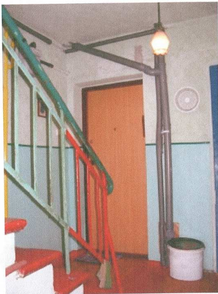
13. klatka schodowa - bariera
