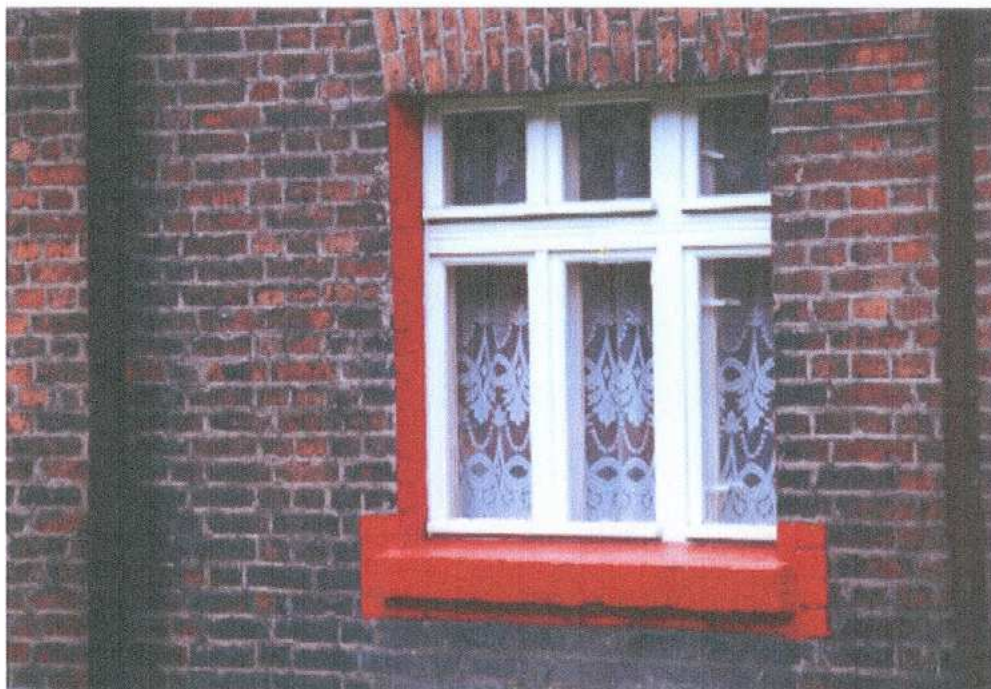
11. fragment elewacji północnej – okno
