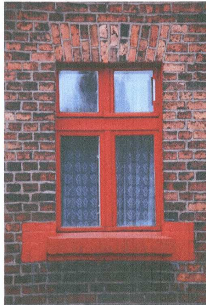
10. fragment elewacji południowej – okno
