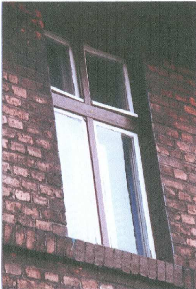
9. fragment elewacji południowej – okno
