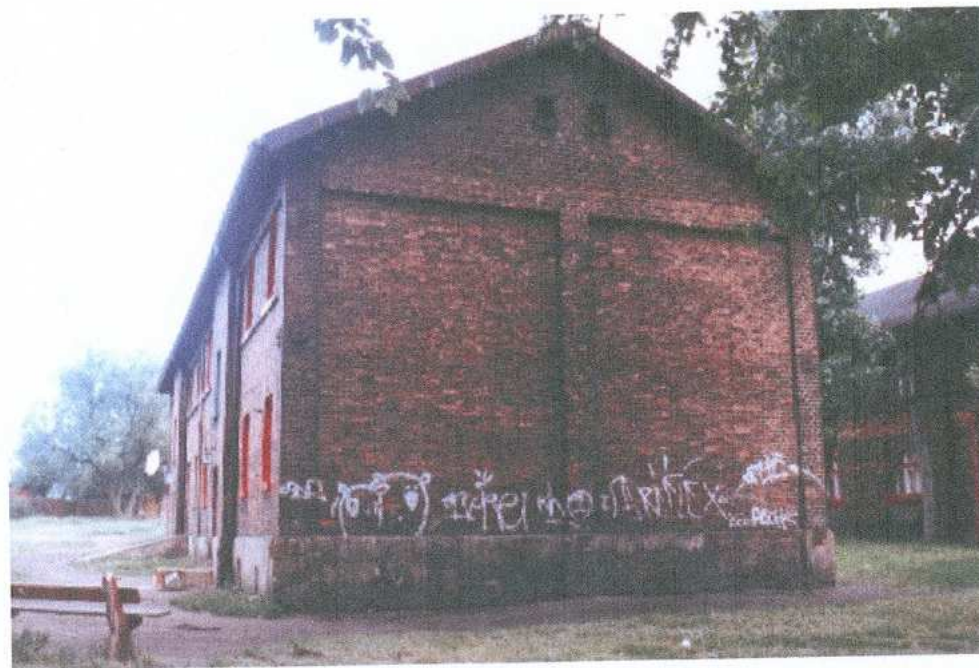
4. elewacja wschodnia – widok od strony południowo-wschodniej
