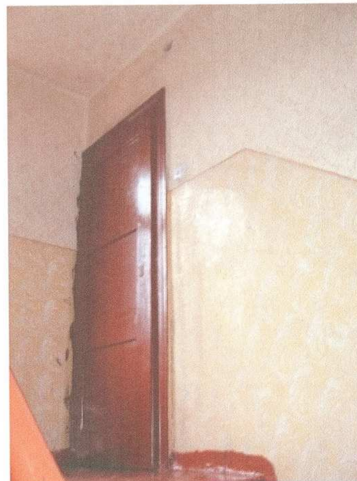
8. klatka schodowa – toalety - drzwi
