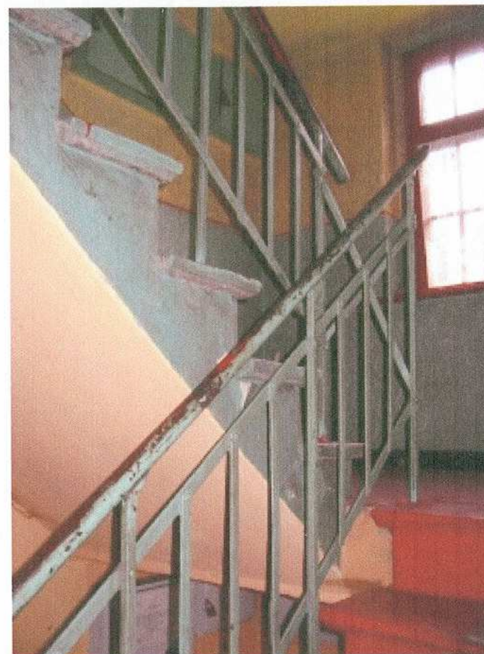
10. fragment klatki schodowej
