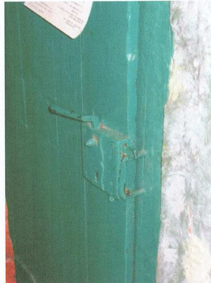
8. fragment drzwi piwnicznych – zamek skrzynkowy
