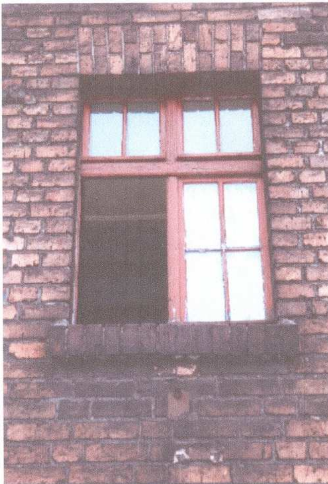
5. fragment elewacji północnej - okno
