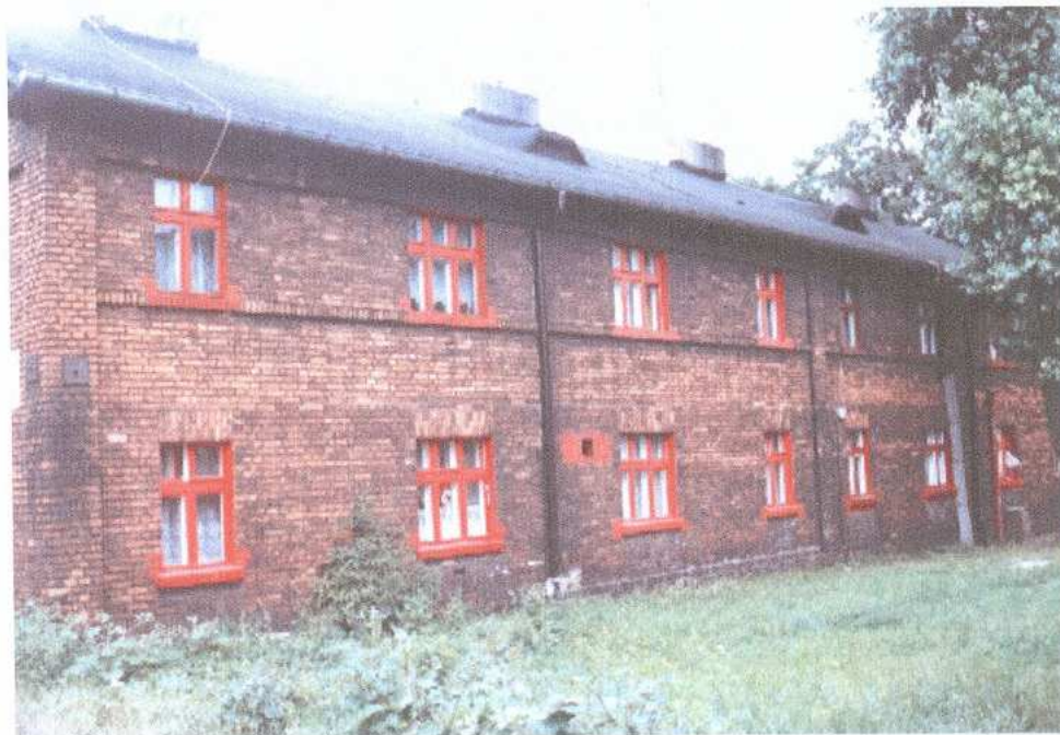
3. fragment elewacji południowej
