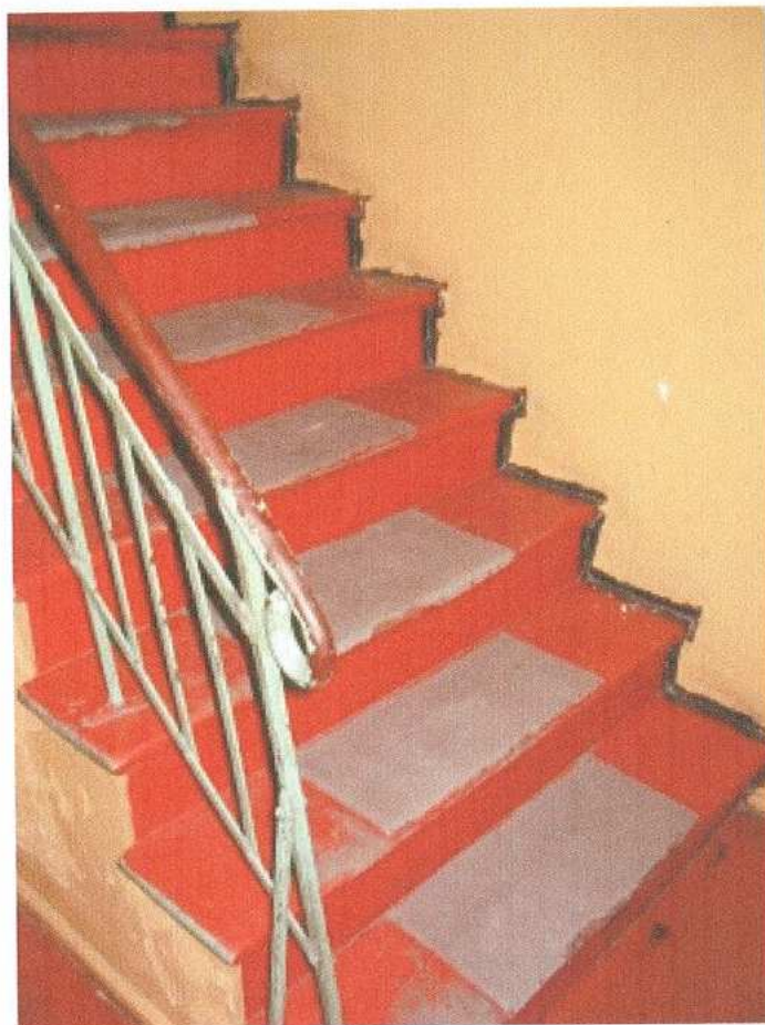
9. klatka schodowa - balustrada
