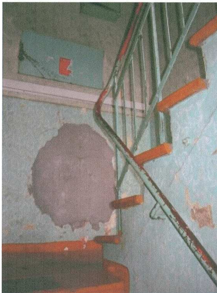
21. klatka schodowa - balustrada
