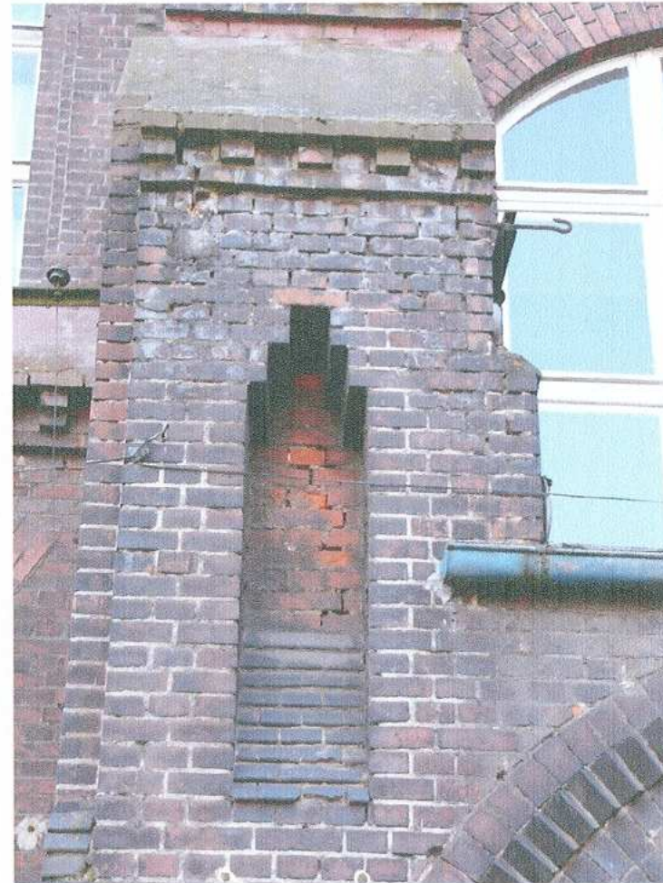
26. fragment elewacji tylnej – część portalu
