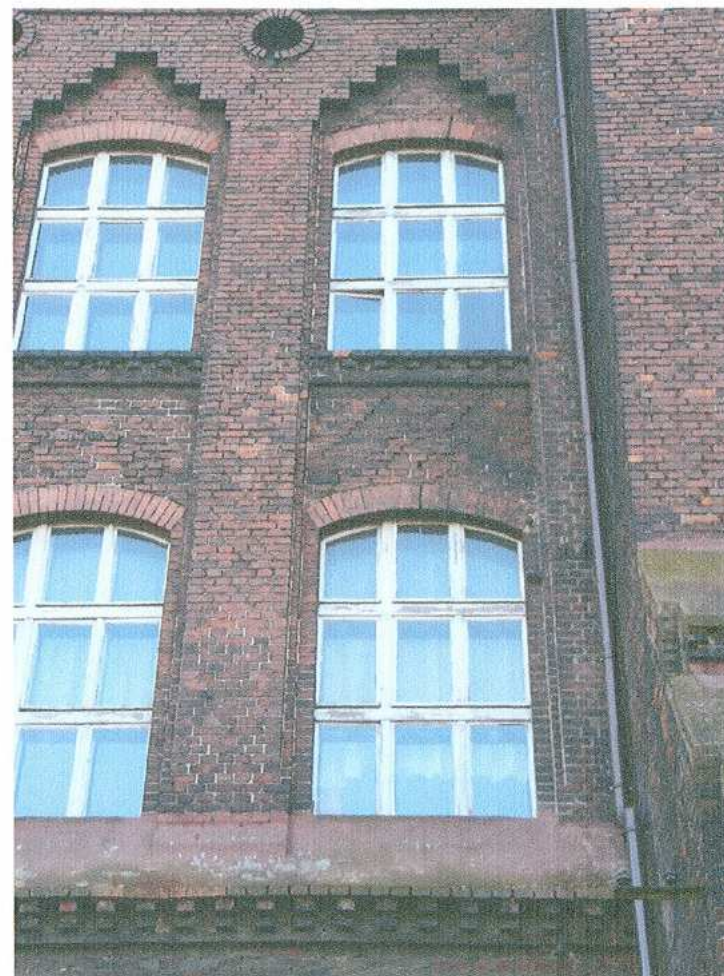
20. fragment elewacji tylnej – I i II piętro
