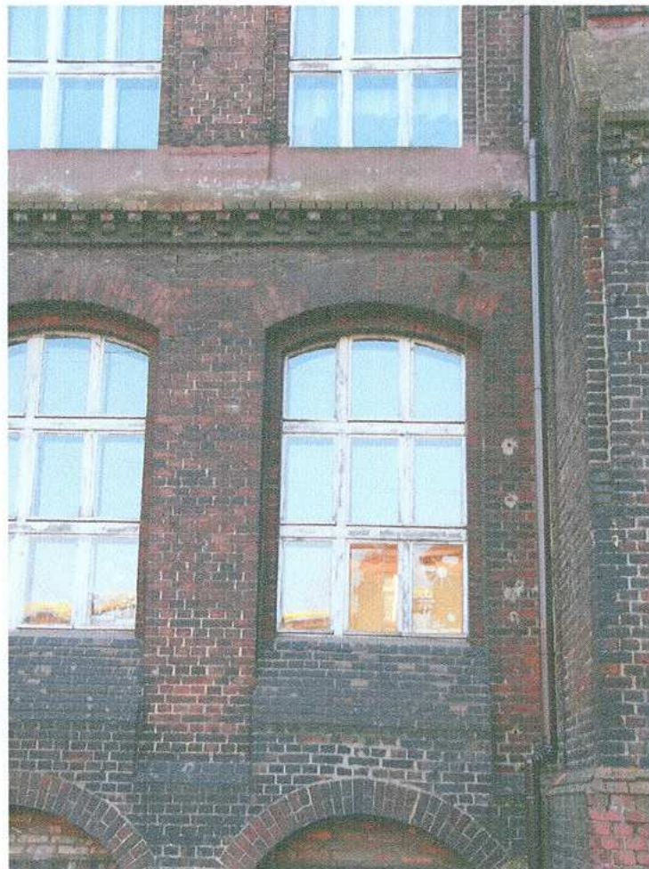
23. fragment elewacji tylnej – I piętro
