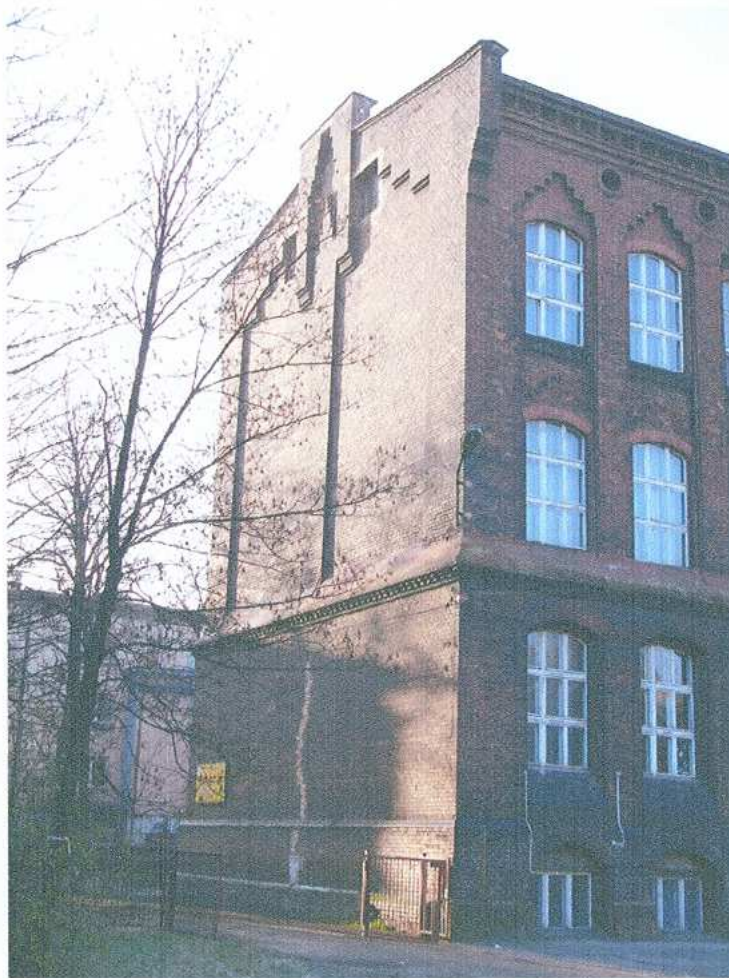
15. fragment elewacji tylnej i elewacja boczna (wschodnia)
