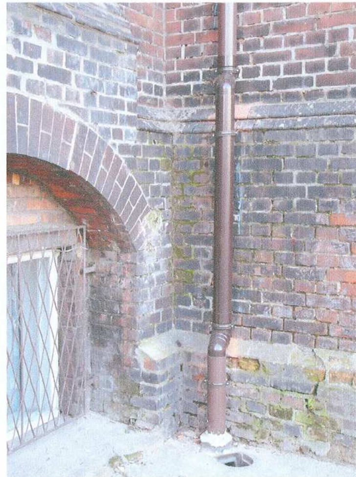
18. elewacja tylna – fragment przyziemia
