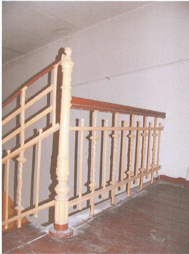
31. wewnątrz – balustrada schodów i podłoga w partii strychowej
