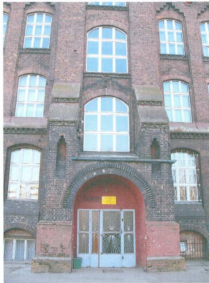
16. elewacja tylna – portal wejściowy
