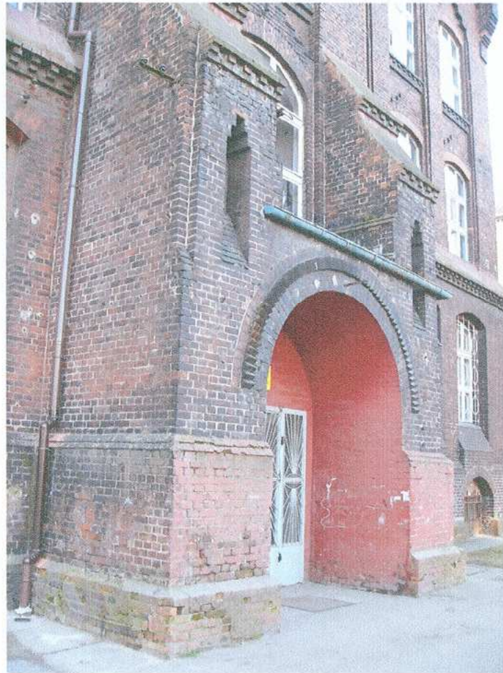
17. elewacja tylna – portal wejściowy
