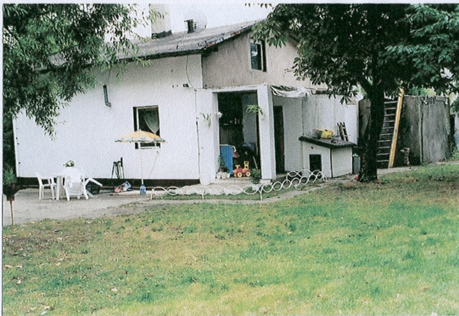
Przebudowany budynek gospodarczy ze schronem bojowym
