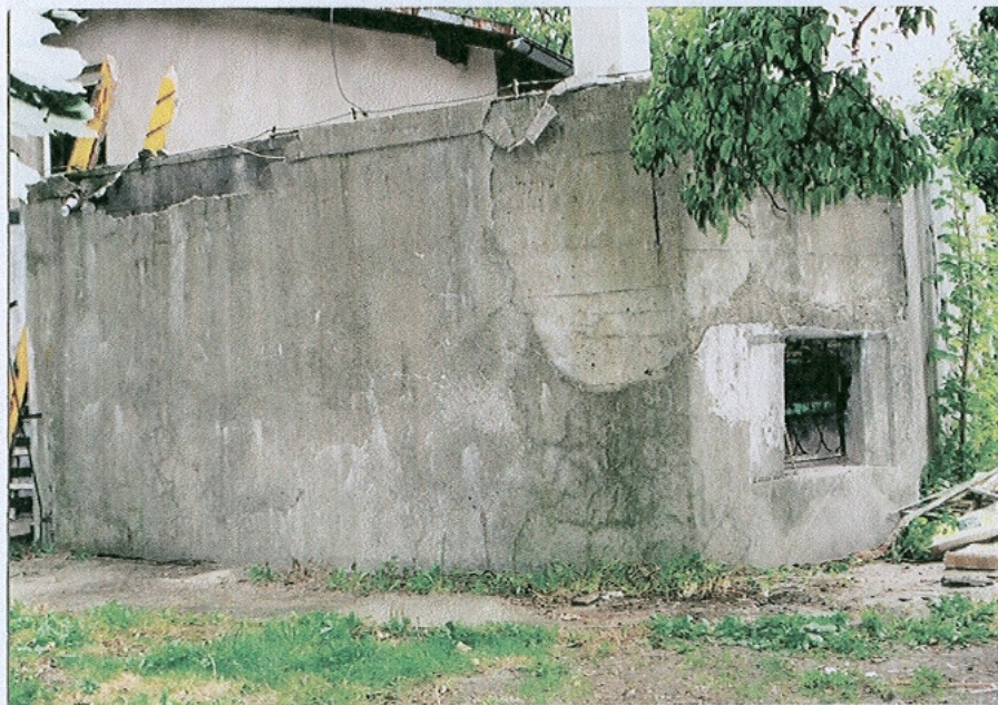
Schron bojowy - widok od strony zach.
