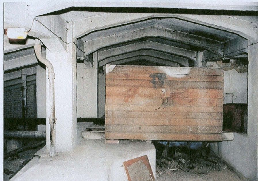
Konstrukcja poddasza oraz zbiornik wody
