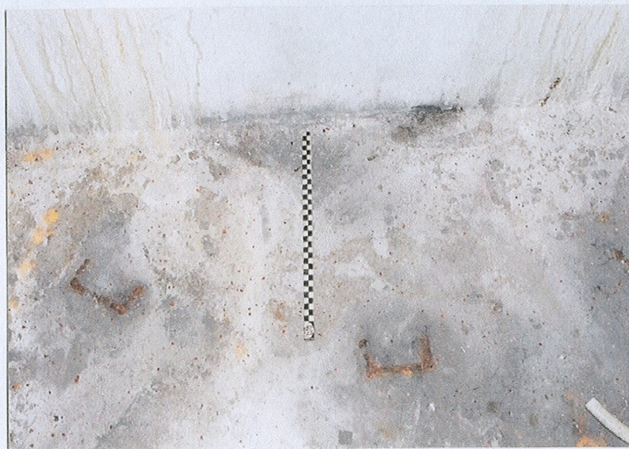
Posadzka przy strzelnicy ckm z odciętymi ceownikami podstawy ckm
