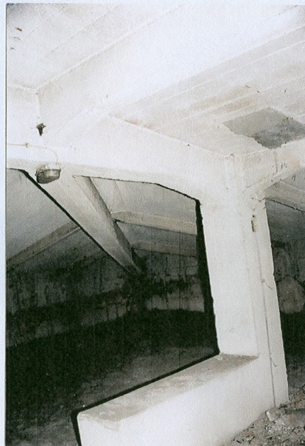
Fragment konstrukcji poddasza
