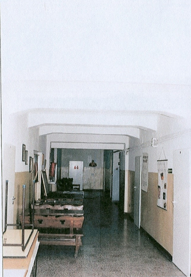
Korytarz w poziomie podpiwniczenia ze wzmocnionym stropem /w zakończeniu na wprost wejście do schrony bojowego/
