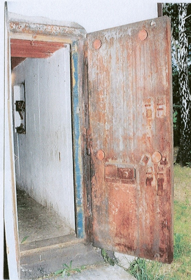
Wewnętrzna strona skrzydła drzwi pancernych pomieszczenia armaty -h
