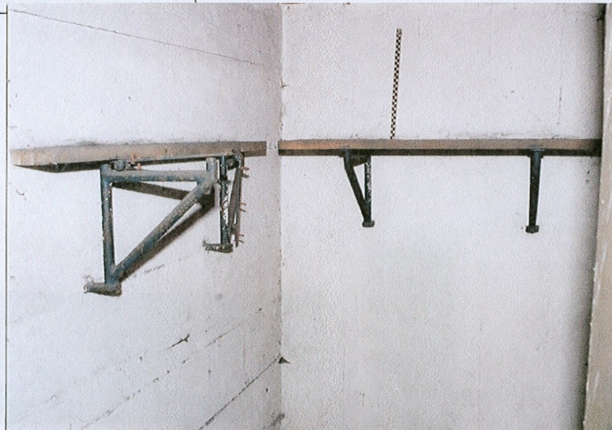
Półki pomieszczenie –f
