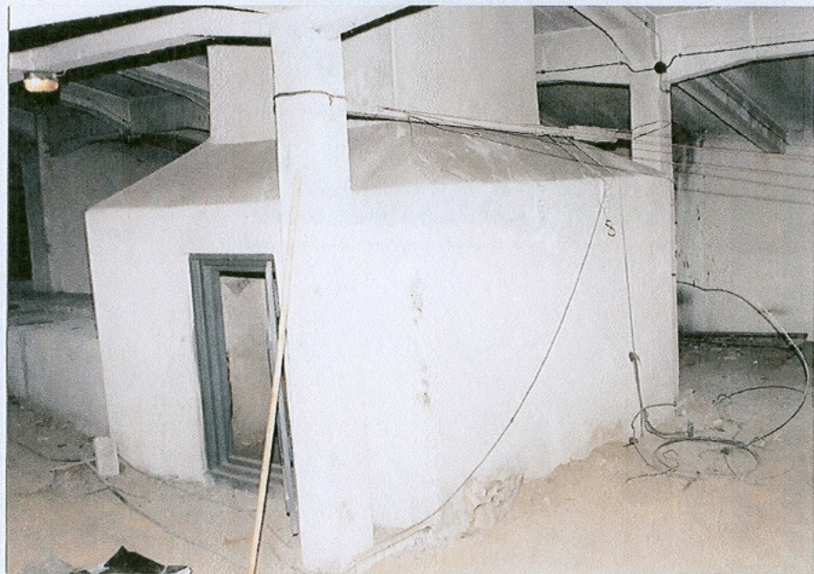
Konstrukcja poddasza oraz kanał wentylacyjny
