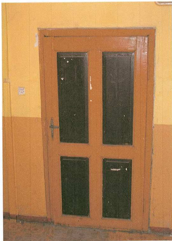
15. Drzwi wewnętrzne do mieszkania
