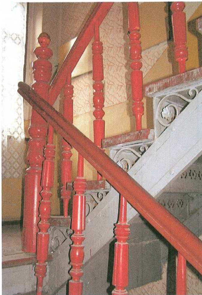
21. Klatka schodowa - fragment
