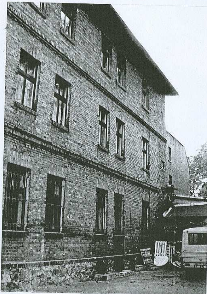
Fot. 11. Elewacja tylna 3 – oficyna. Widok od południowego-zachodu.
