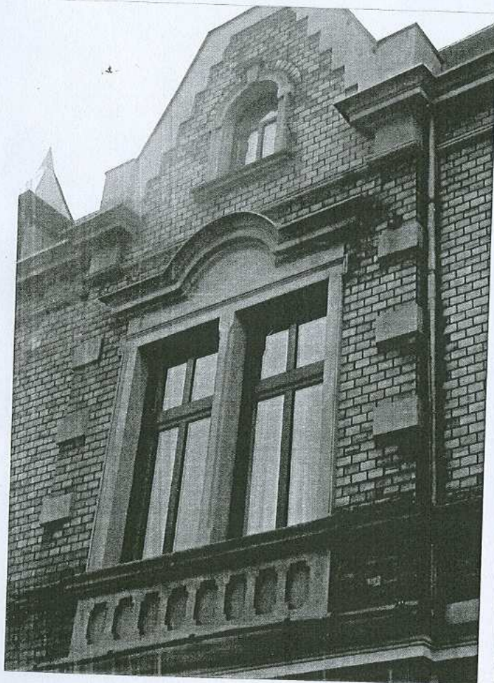
Fot. 5. Przykład dekoracji architektonicznej. Fragment ryzalitu skrzydła południowego.
