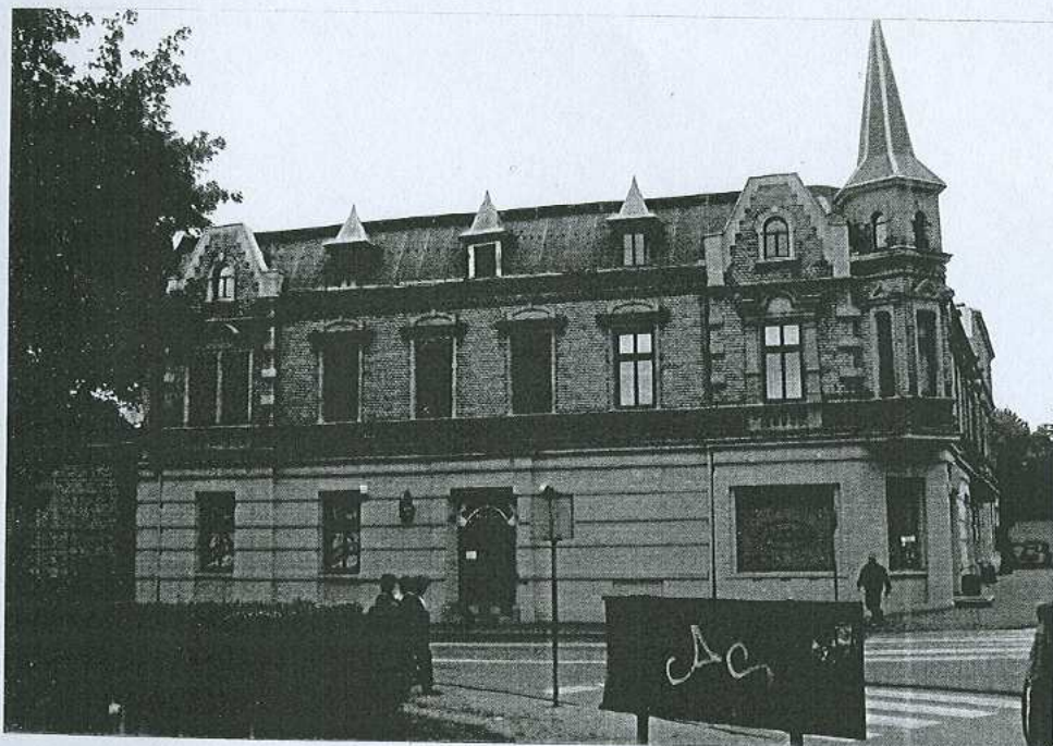
Fot. 1. Elewacja frontowa – skrzydło zachodnie.
