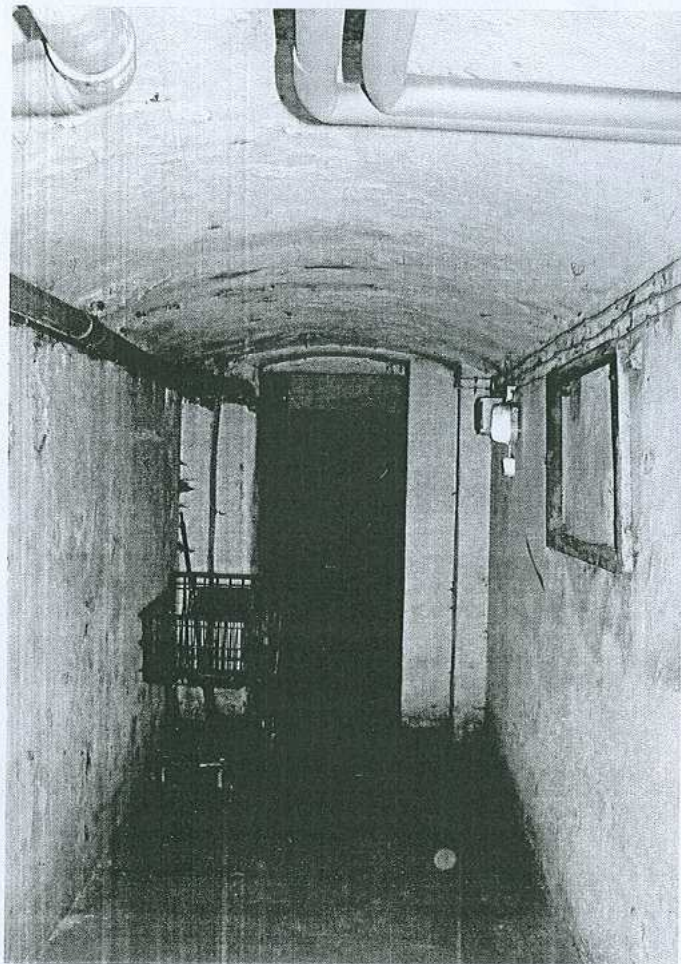
Fot. 17. Fragment korytarza piwnicy. Skrzydło zachodnie.
