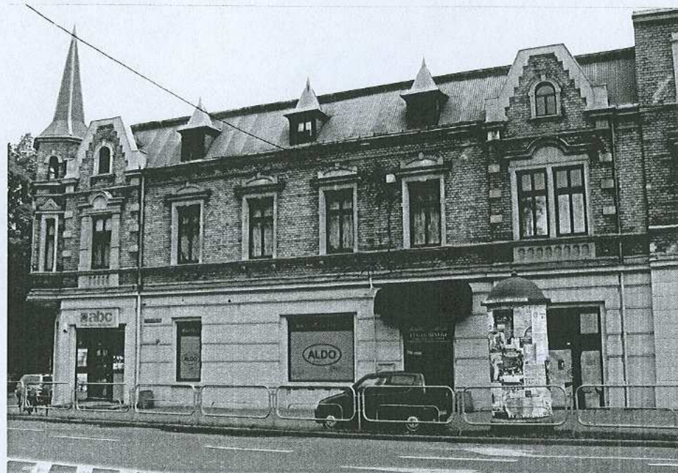
Fot. 2. Elewacja frontowa – skrzydło południowe.
