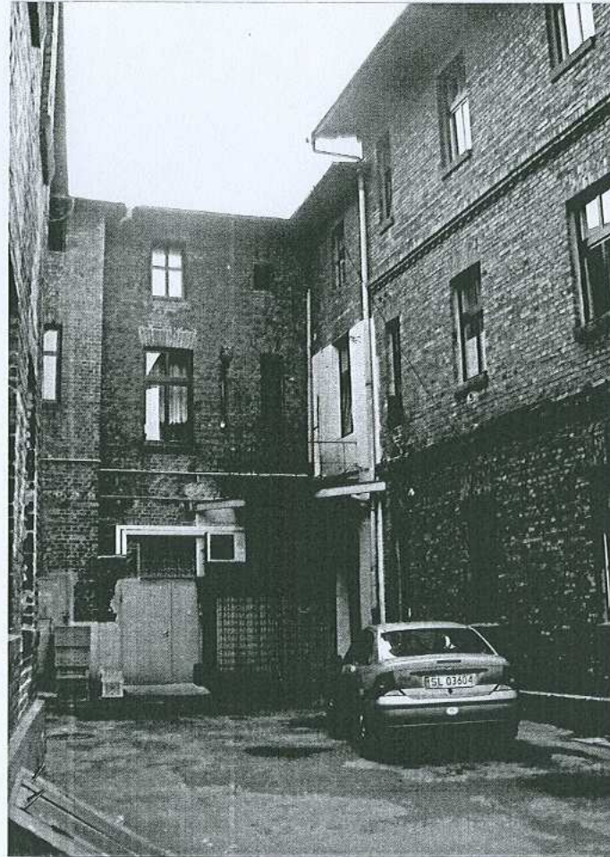
Fot. 9. Elewacja tylna 2. Widok od wschodu.
