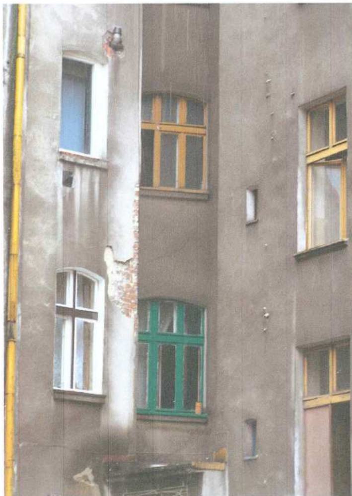
9. Fragment elewacji tylnej z łącznikiem i oficyną
