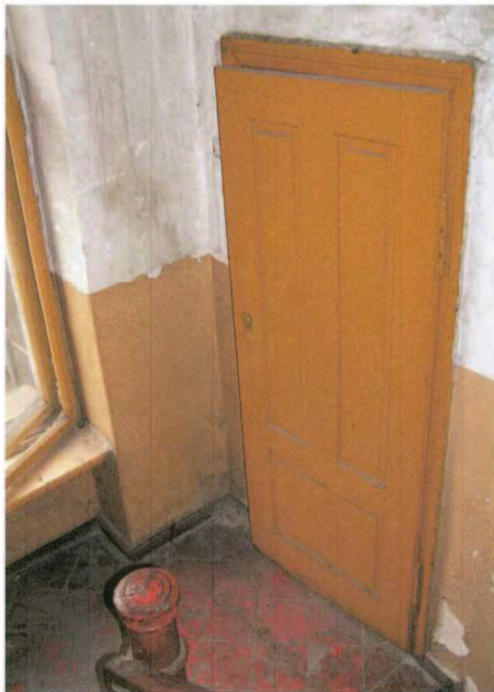
7. Drzwi wewnętrzne do WC-tu
