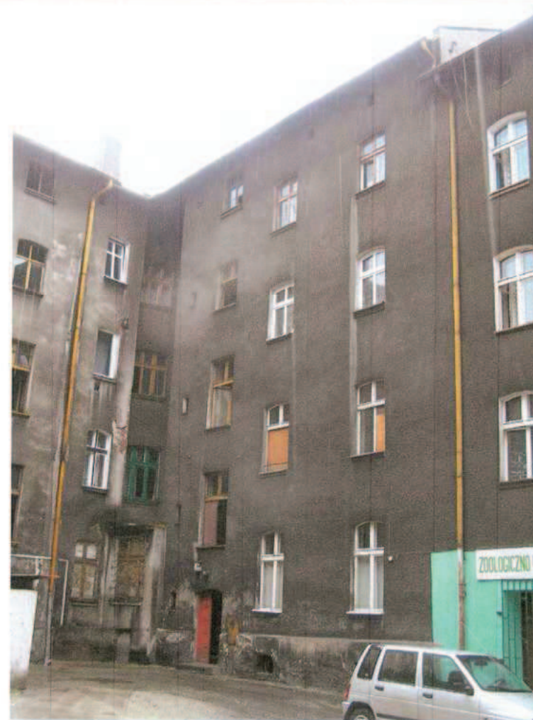
2. Elewacja frontowa oficyny wraz z przyległymi budynkami
