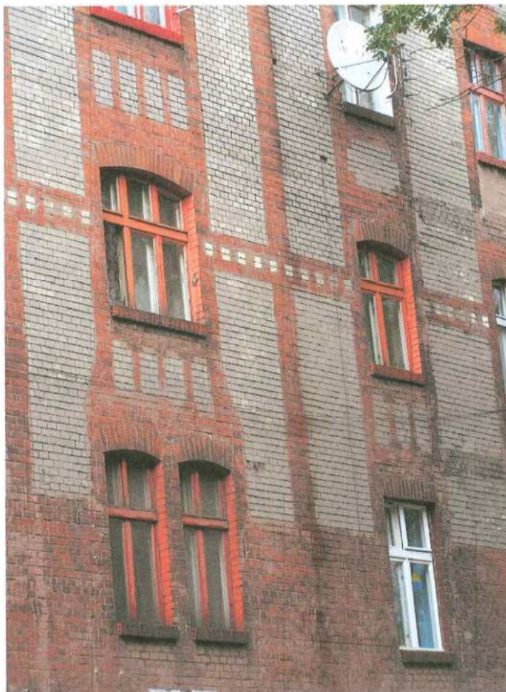
5. Fragment fasady z pierwotnymi oknami
