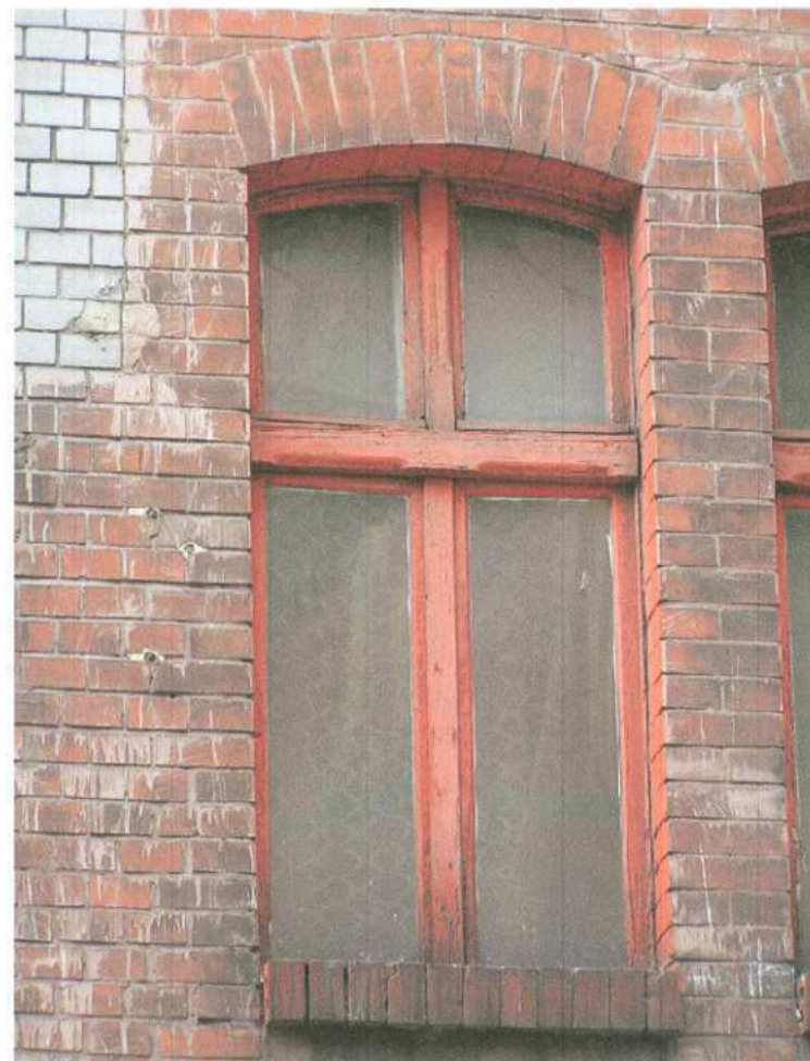
12. Stolarka okienna w fasadzie
