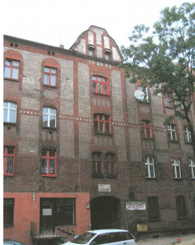
4. Część centralna fasady
