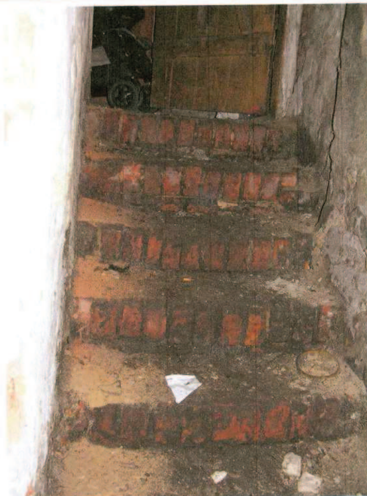
10. Schody do piwnicy
