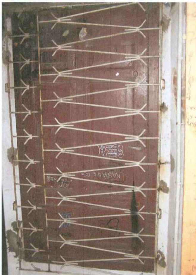
21. Drzwi z klatki schodowej do sklepu
