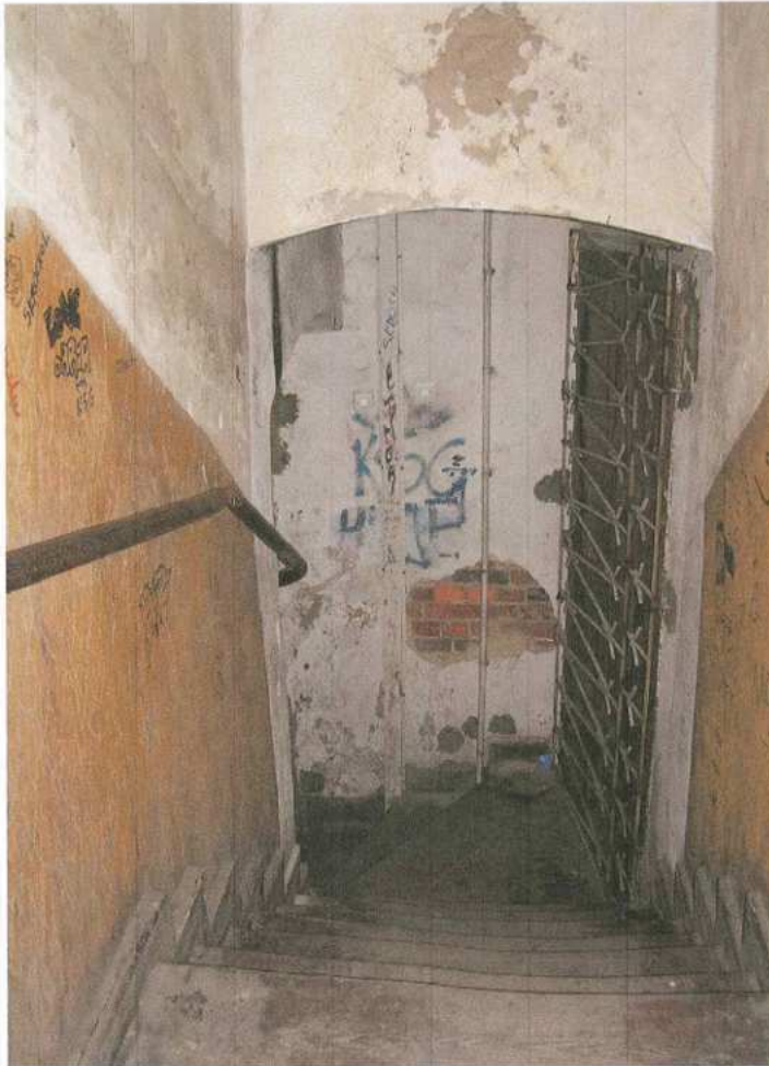
13. Schody w partii parteru
