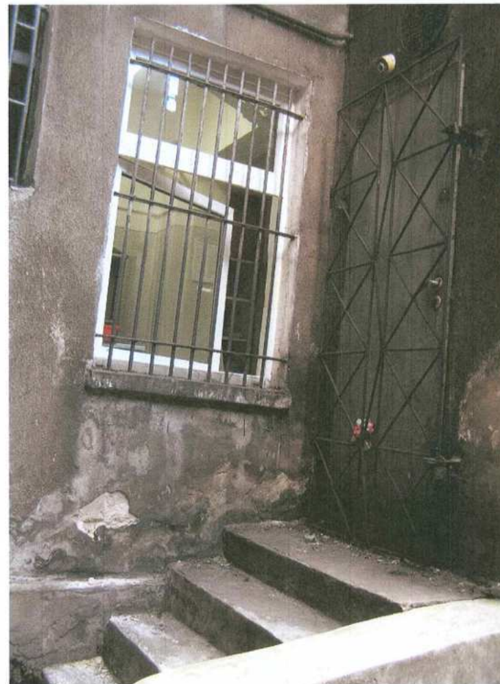
10. wejście na zaplecze restauracyjne w elewacji tylnej
