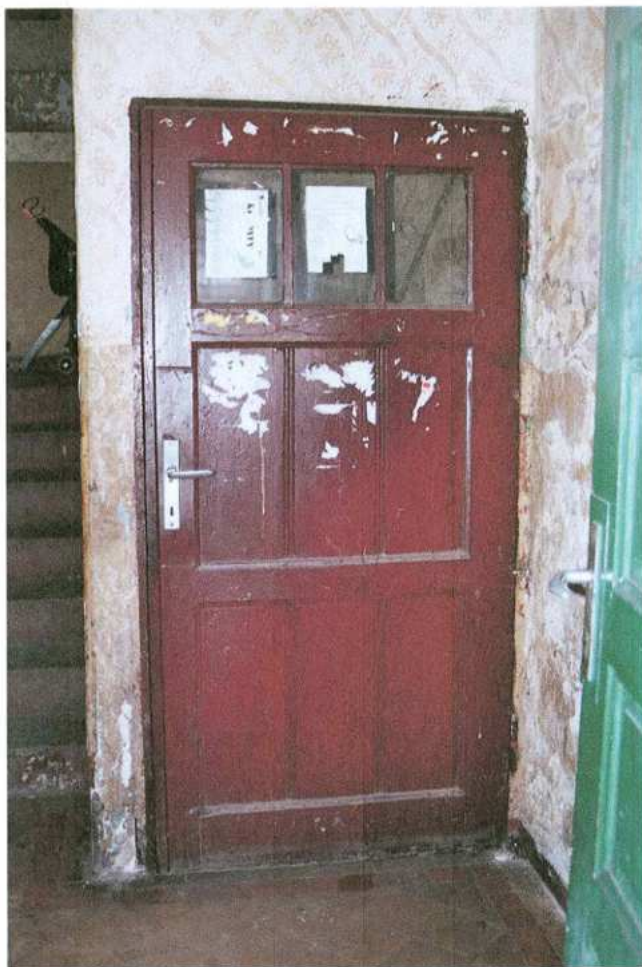
19. Kościuszki 10 – drzwi do piwnicy
