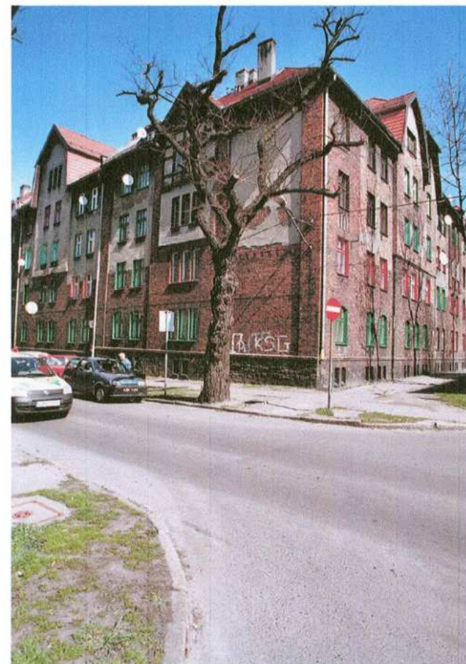
6. Kościuszki 12/W.P. 16 – widok ogólny na elewacje
