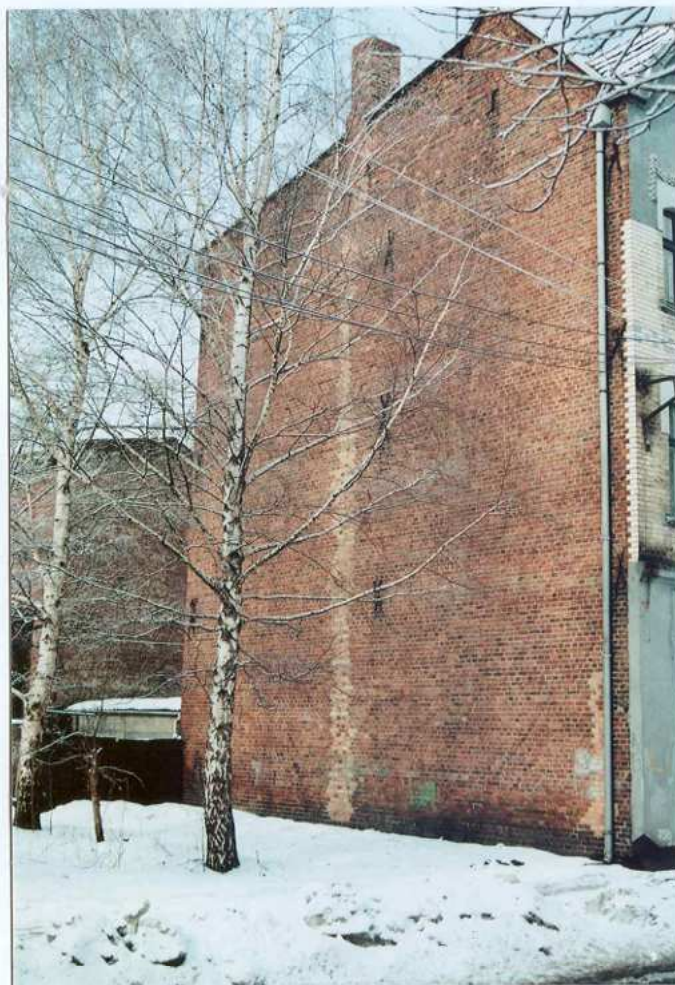
Fot. 25. Elewacja południowa, skrzydło południowe.
