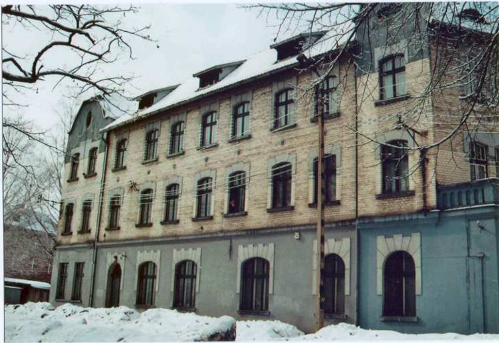
Fot. 18. Elewacja wschodnia, skrzydło południowe.
