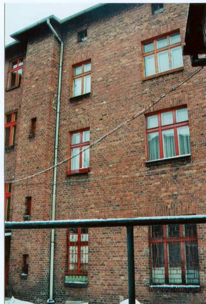
Fot. 26. Fragment elewacji zachodniej, skrzydło południowe.
