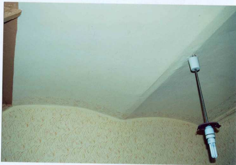
Fot. 38. Sufit podestu.
