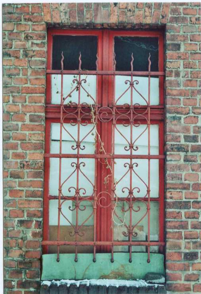
Fot. 29. Okno – parter elewacji zachodniej, skrzydło południowe.
