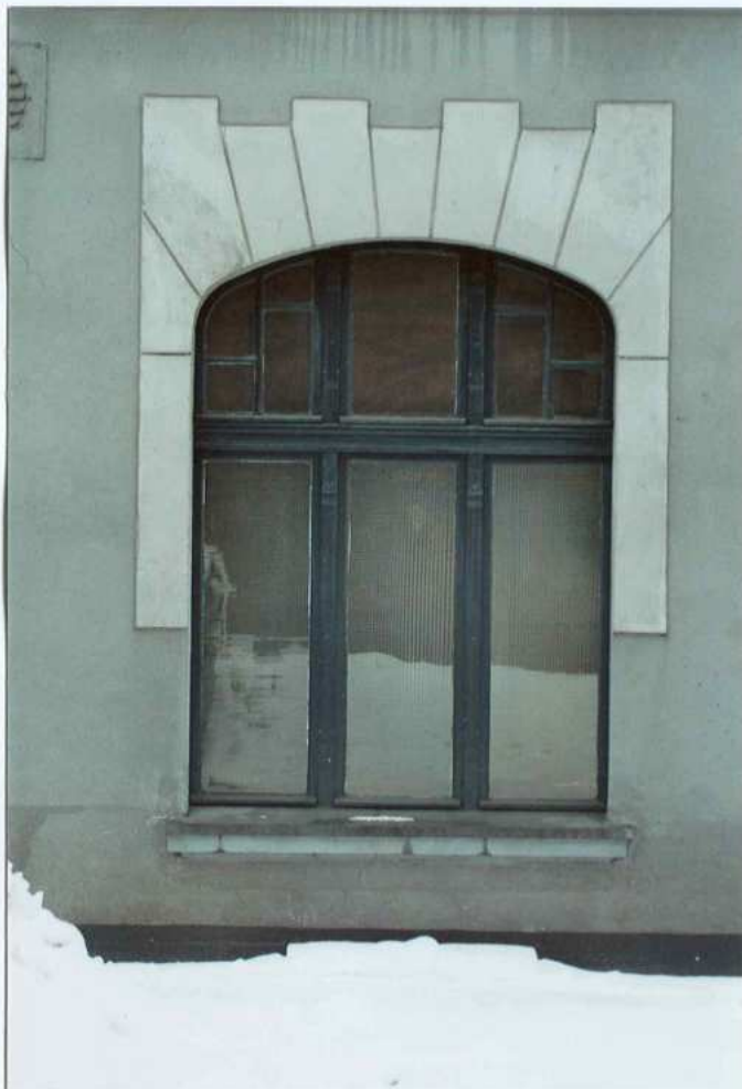
Fot. 11. Okno – 3 oś parteru elewacji północnej.
