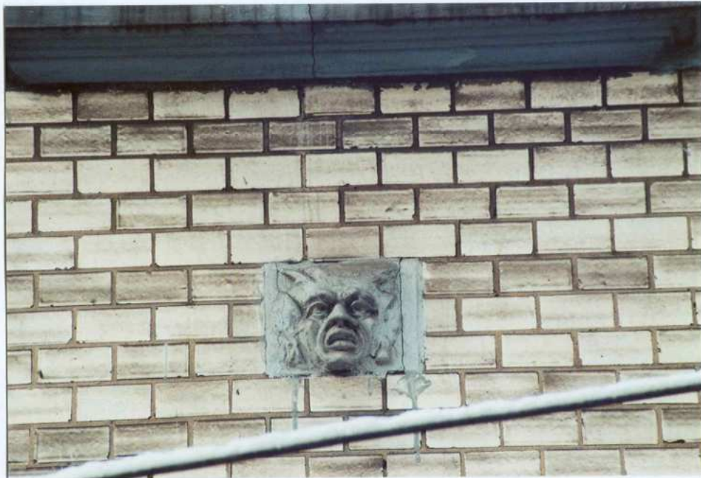
Fot. 23. Dekor z motywem maszkaronu – elewacja wschodnia.
