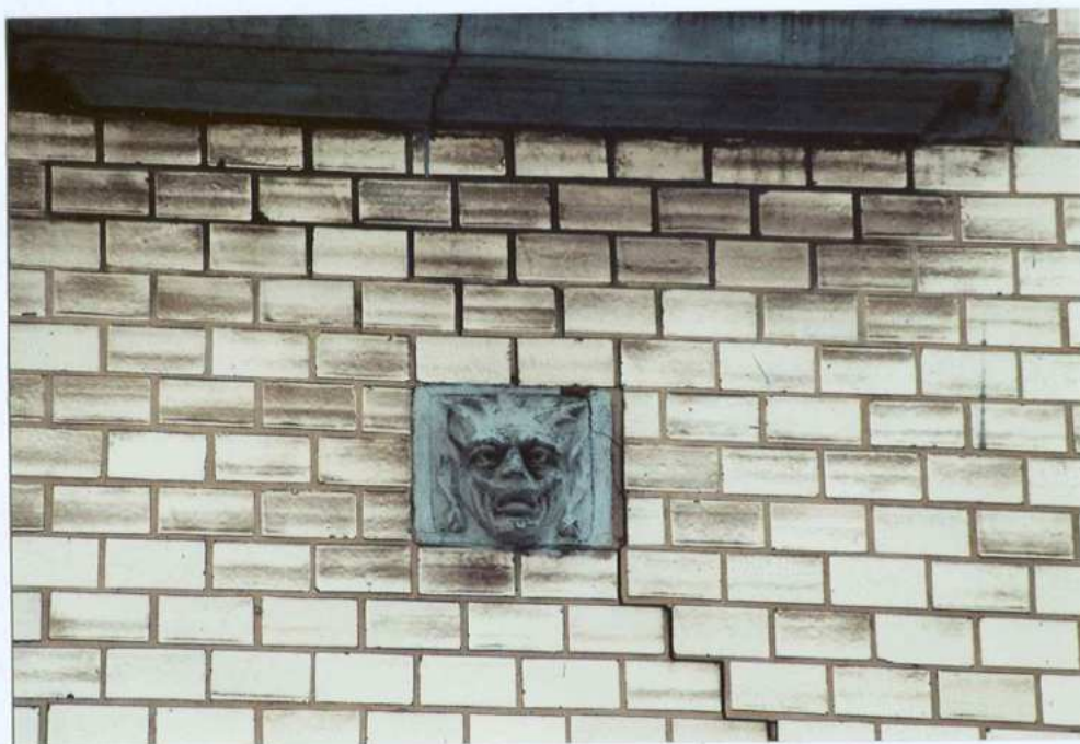
Fot. 5. Dekor z motywem maszkaronu – elewacja północna.
