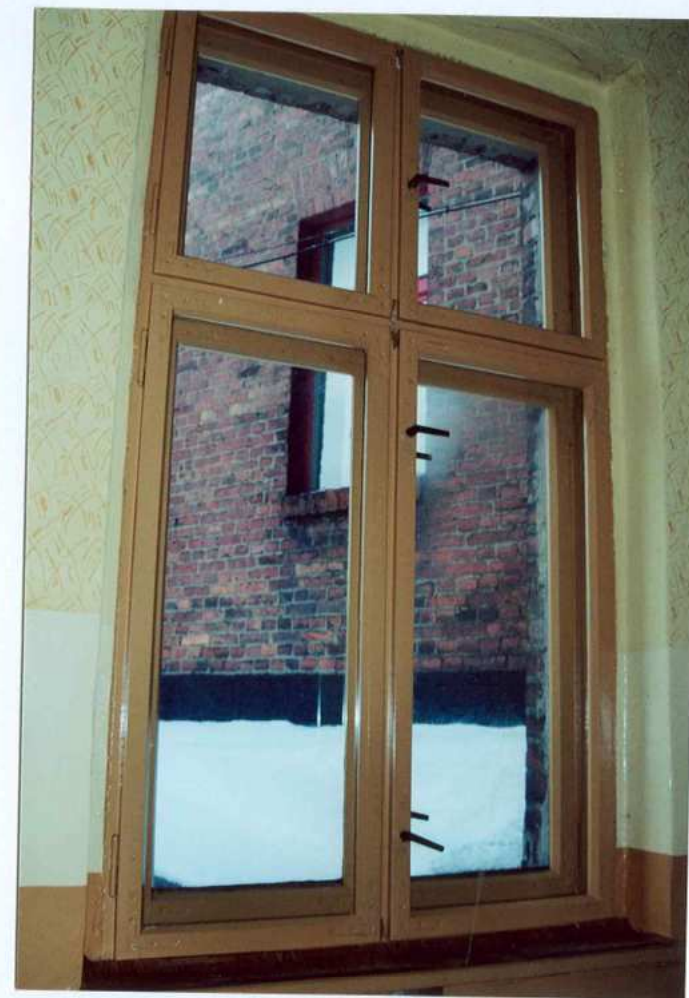
Fot. 53. Okno na klatce schodowej.
