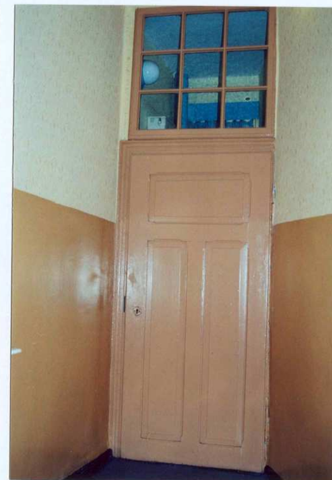
Fot. 47. Drzwi wewnętrzne, jednoskrzydłowe do łazienki.
