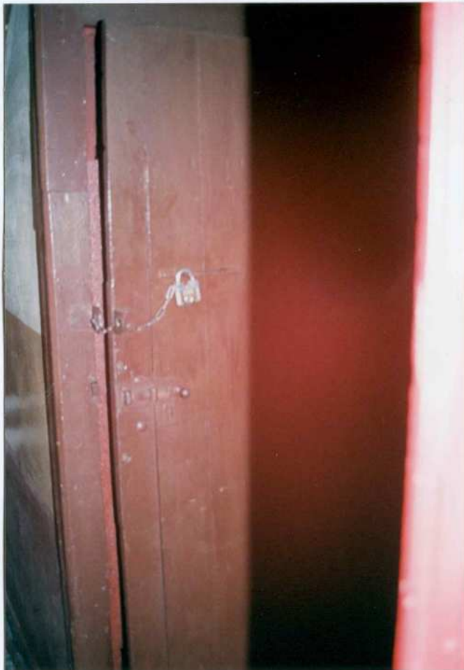
Fot. 42. Drzwi do piwnicy.
