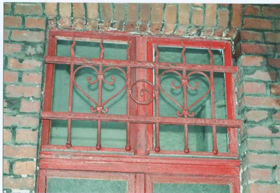
Fot. 30. Krata w górnej partii okna.
