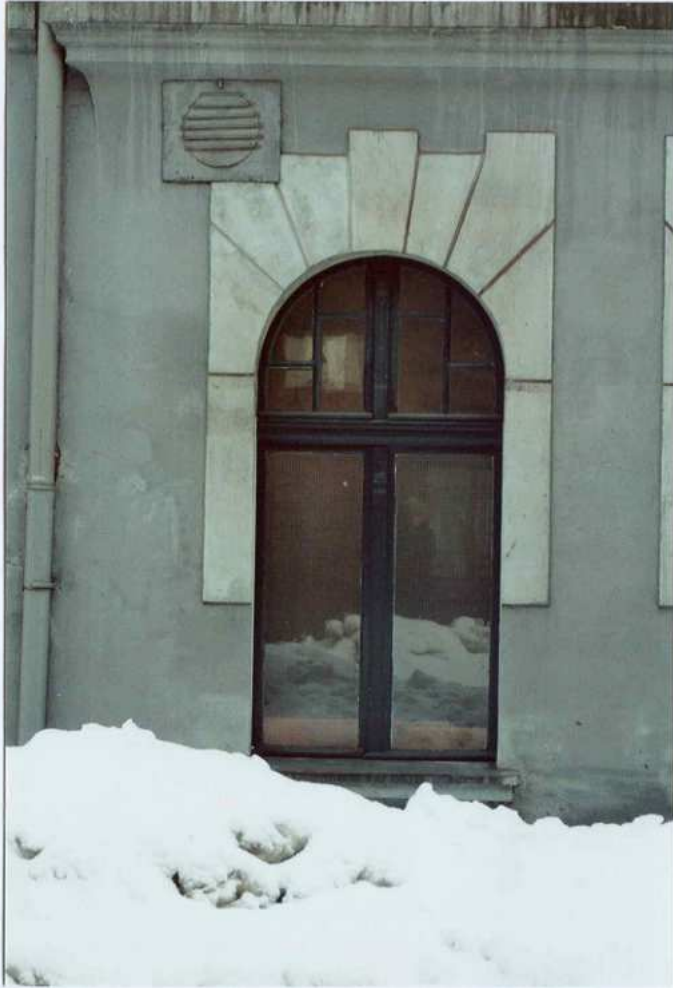
Fot. 14. Okno – 3 oś parteru elewacji północnej.
