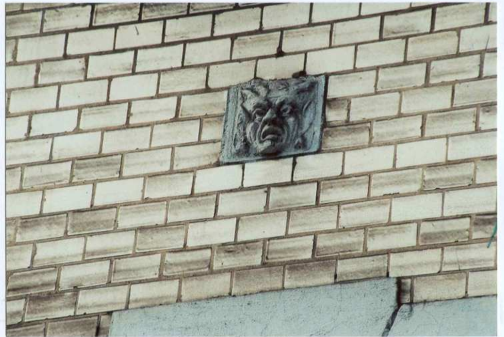
Fot. 24. Dekor z motywem maszkaronu – elewacja wschodnia.
