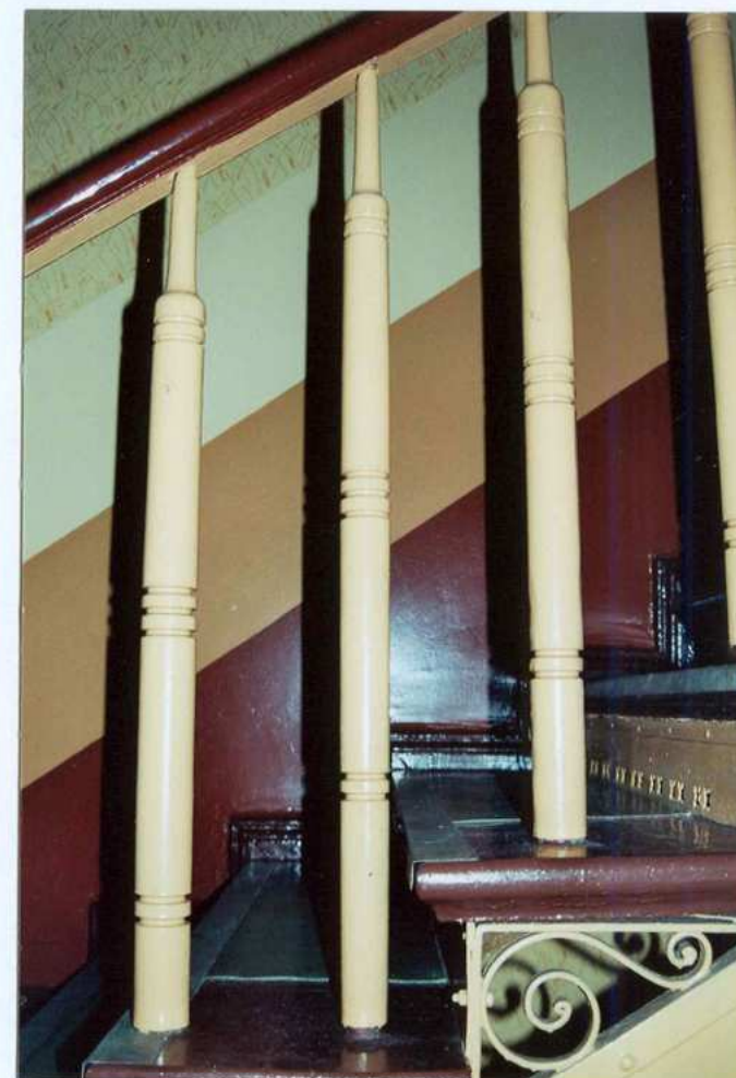
Fot. 36. Tralkowa balustrada schodów.
