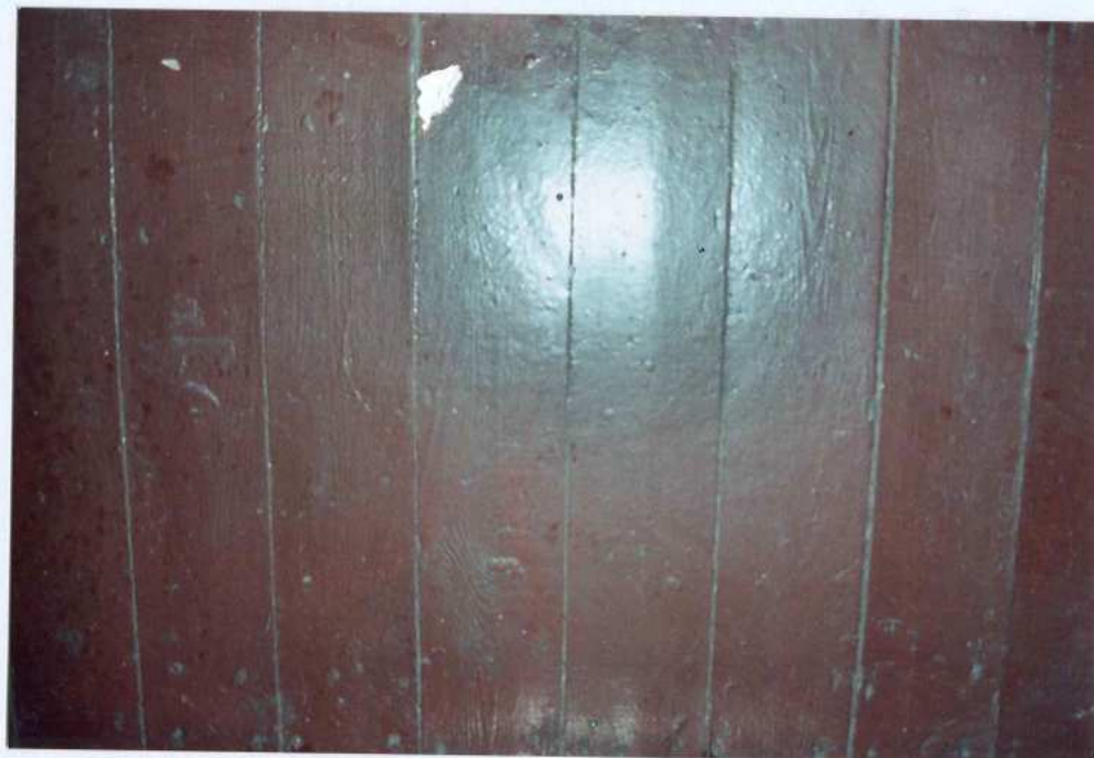
Fot. 39. Deski na podeście schodów.
