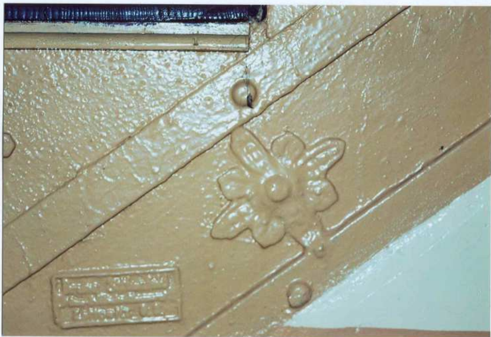
Fot. 37. Belka policzkowa schodów – detal.
