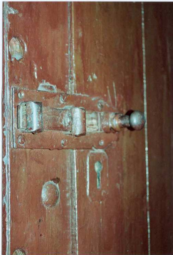
Fot. 43. Zasuwa na drzwiach do piwnicy.
