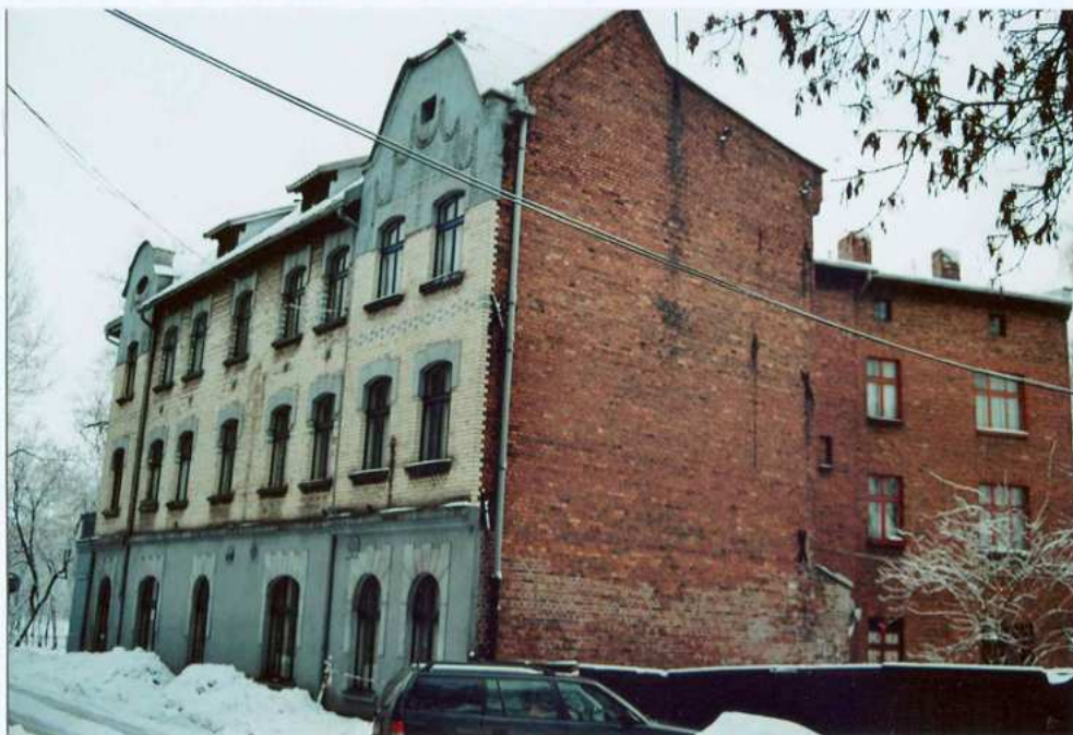
Fot. 1. Widok od strony północno – zachodniej na elewację szczytową (zachodnią) i północną skrzydła północnego.
