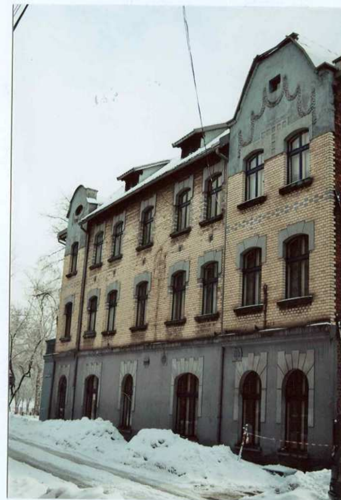
Fot. 2. Elewacja północna, skrzydło północne.
