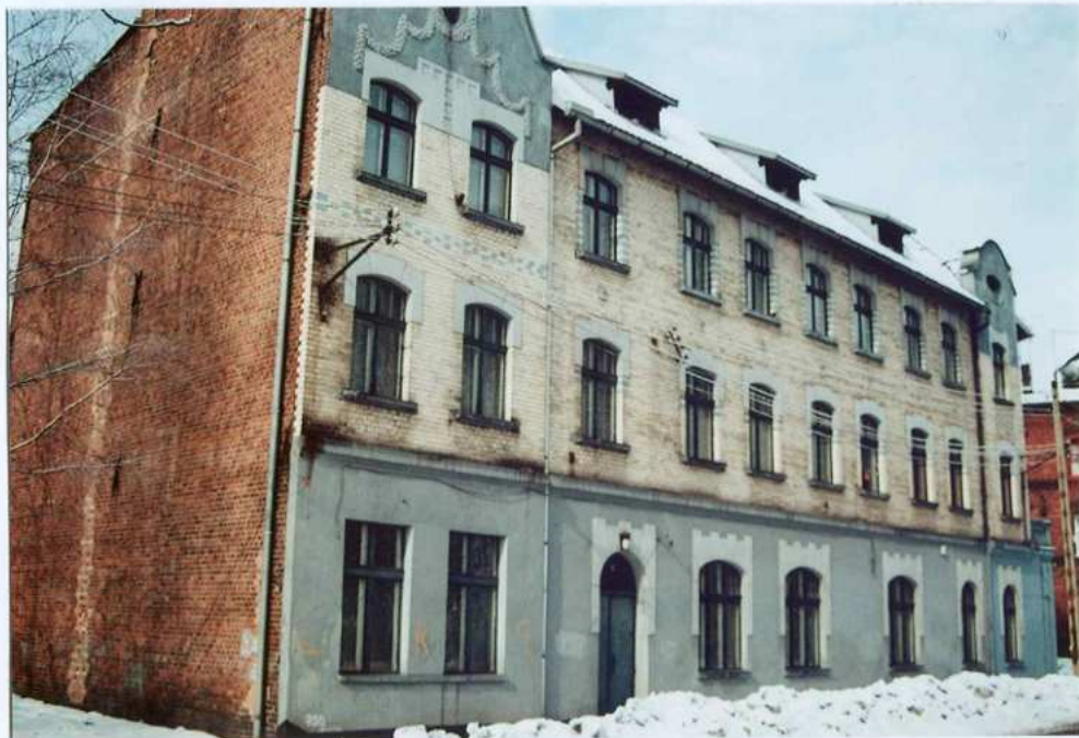
Fot. 19. Elewacja wschodnia, skrzydło południowe – widok od strony południowo – wschodniej.
