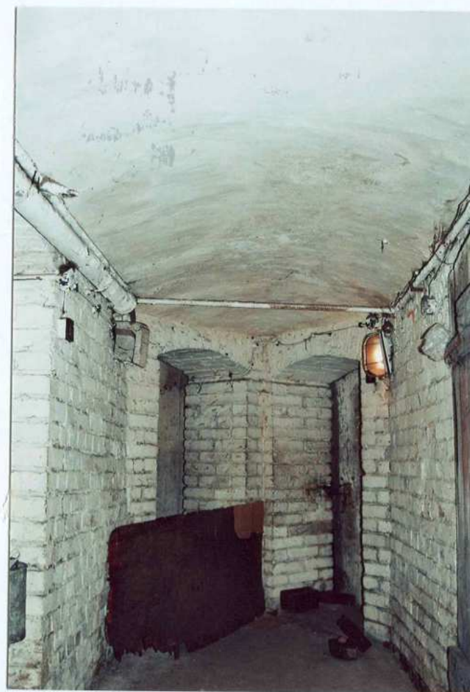
Fot. 41. Korytarz w piwnicy.
