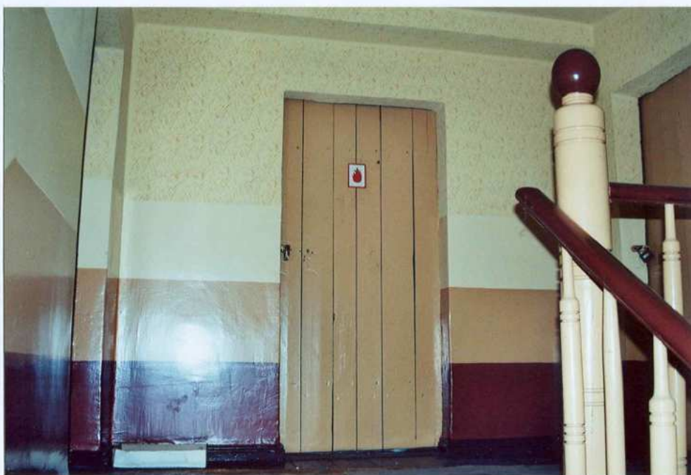
Fot. 52. Drzwi na strych.
