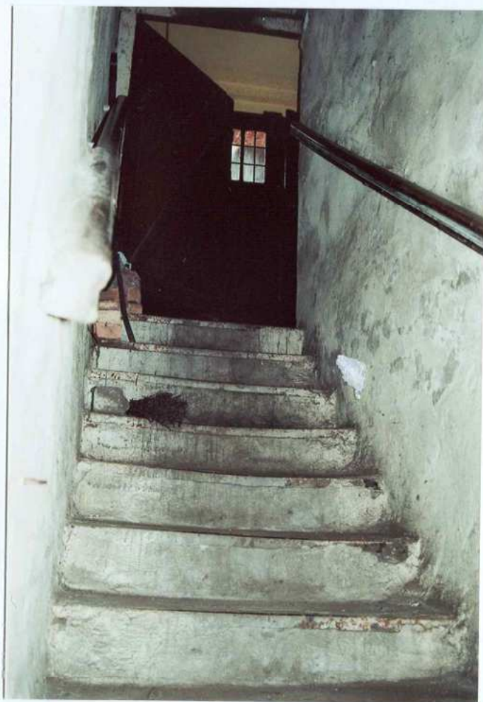
Fot. 40. Schody do piwnicy.
