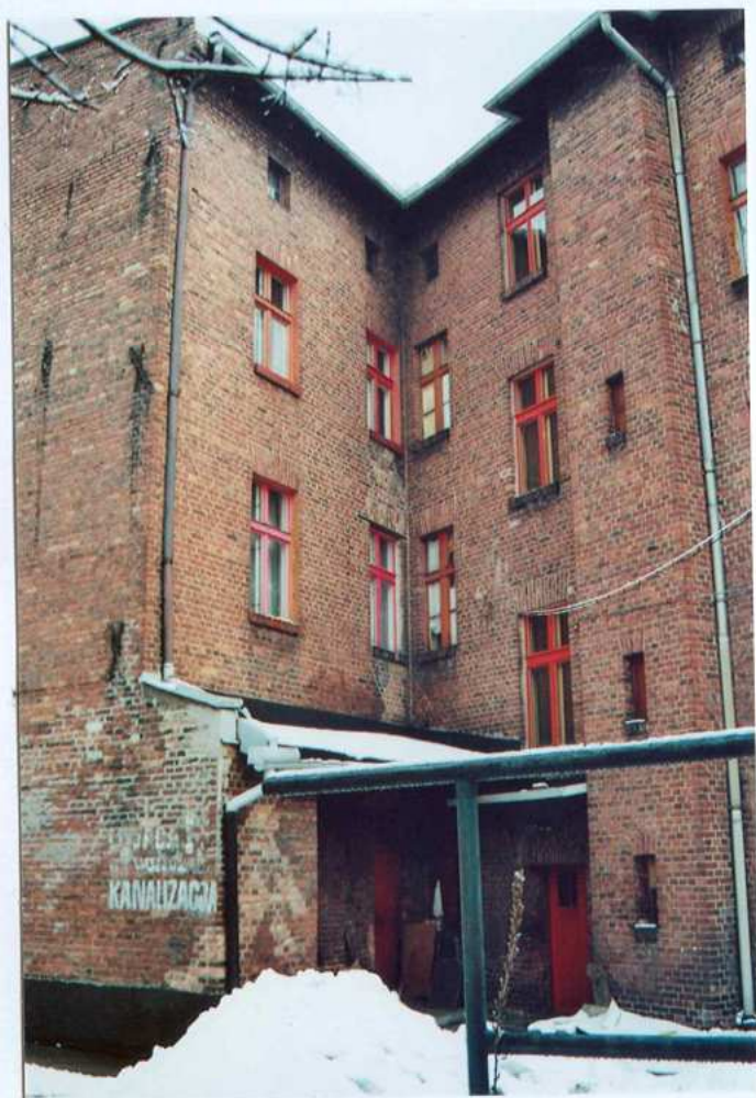
Fot. 27. Styk elewacji zachodniej (skrzydło południowe) i elewacji południowej (skrzydło północne)
