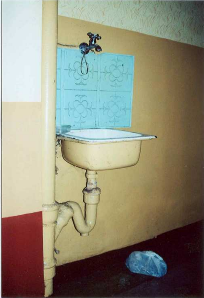
Fot. 54. Zlew żeliwny na korytarzu.
