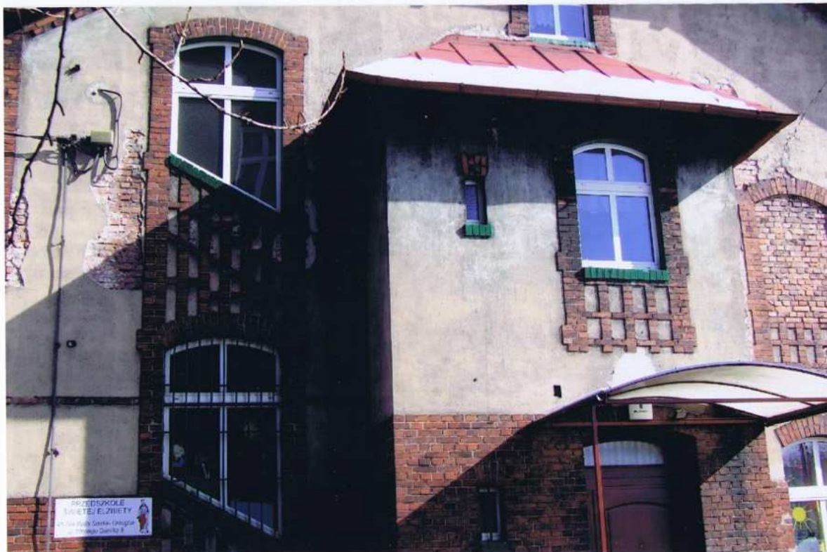
Fot. 7 fragment elewacji zachodniej
