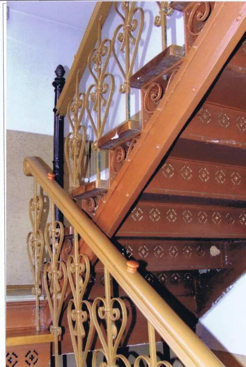
Fot. 5 główna klatka schodowa
