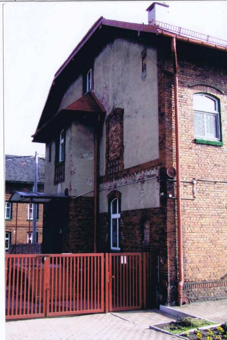
Fot. 8 elewacja zachodnia, fragment elewacji południowej
