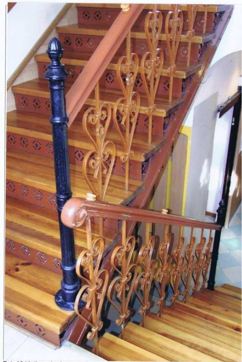
Fot. 10 klatka schodowa usytuowana w części PD - WSCH budynku
