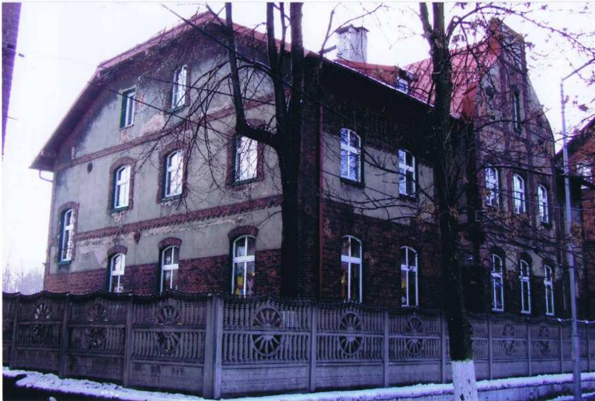
Fot. 2 elewacja północna i wschodnia
