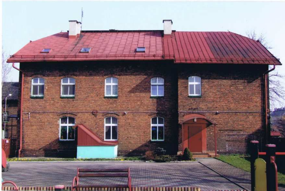
Fot. 6 elewacja południowa
