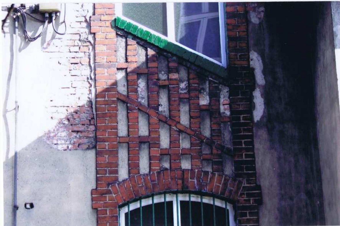
Fot. 4 fragment dekoracji ściennych pomiędzy oknami klatki schodowej na elewacji zachodniej
