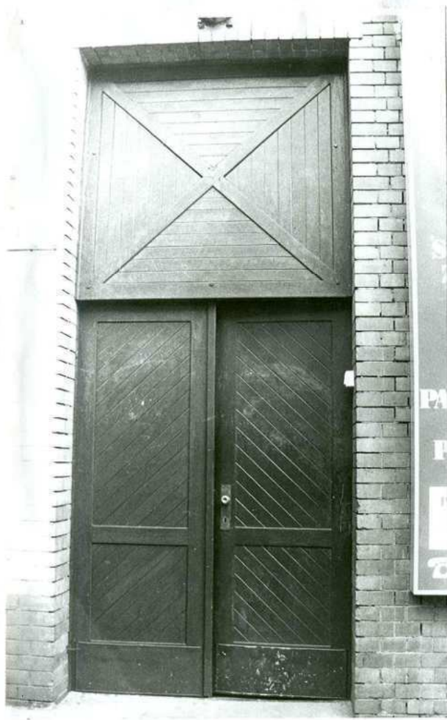
5 - drzwi od ulicy Niedurnego
