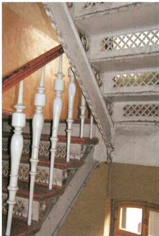
27. Wnętrze – klatka schodowa
