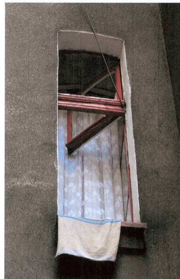
18. Pierwotna stolarka okienna elewacji tylnej
