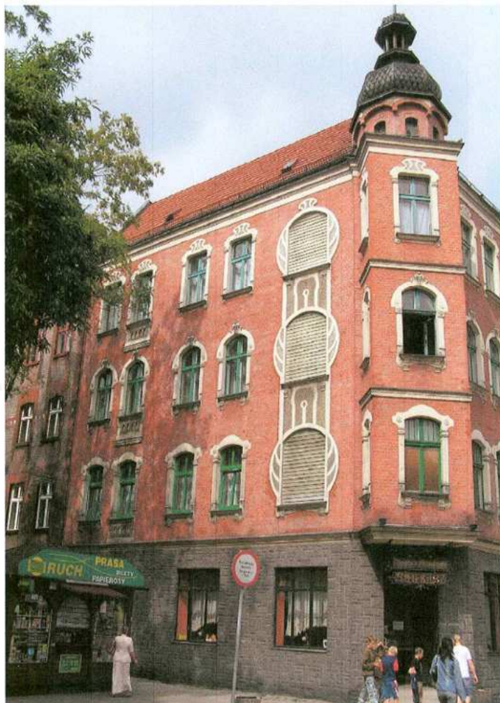
5. elewacja od ul. Kościuszki
