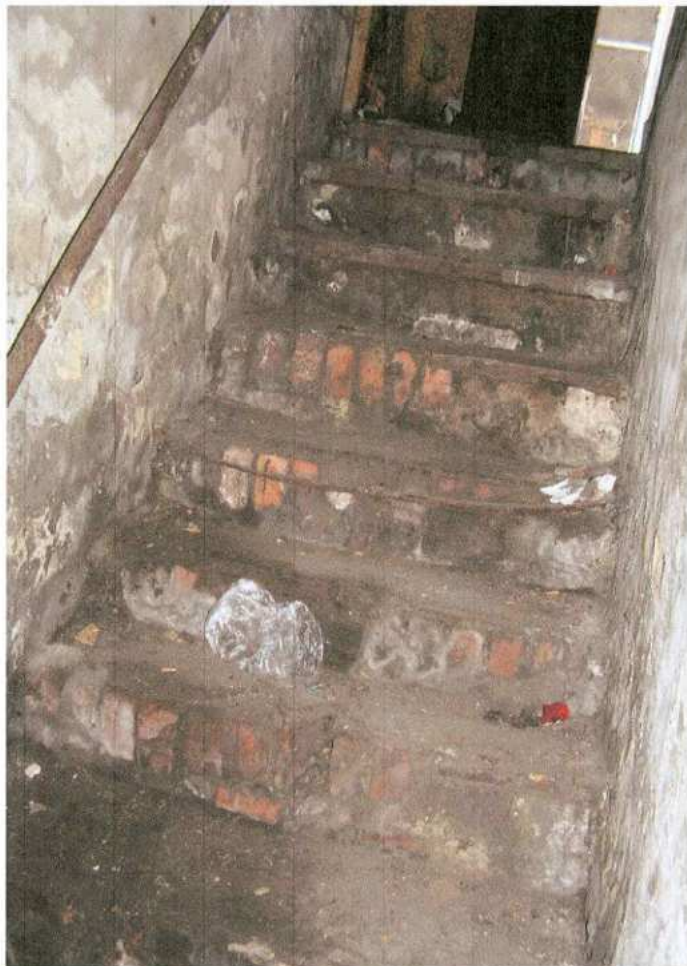
29. Wnętrze – schody do piwnicy
