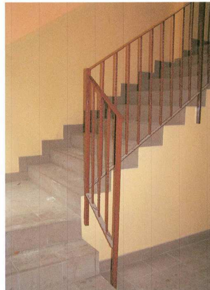
20. Klatka schodowa w partii parteru
