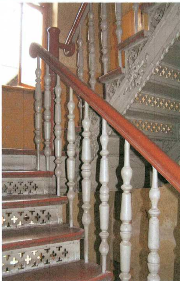
21. Schody klatki schodowej
