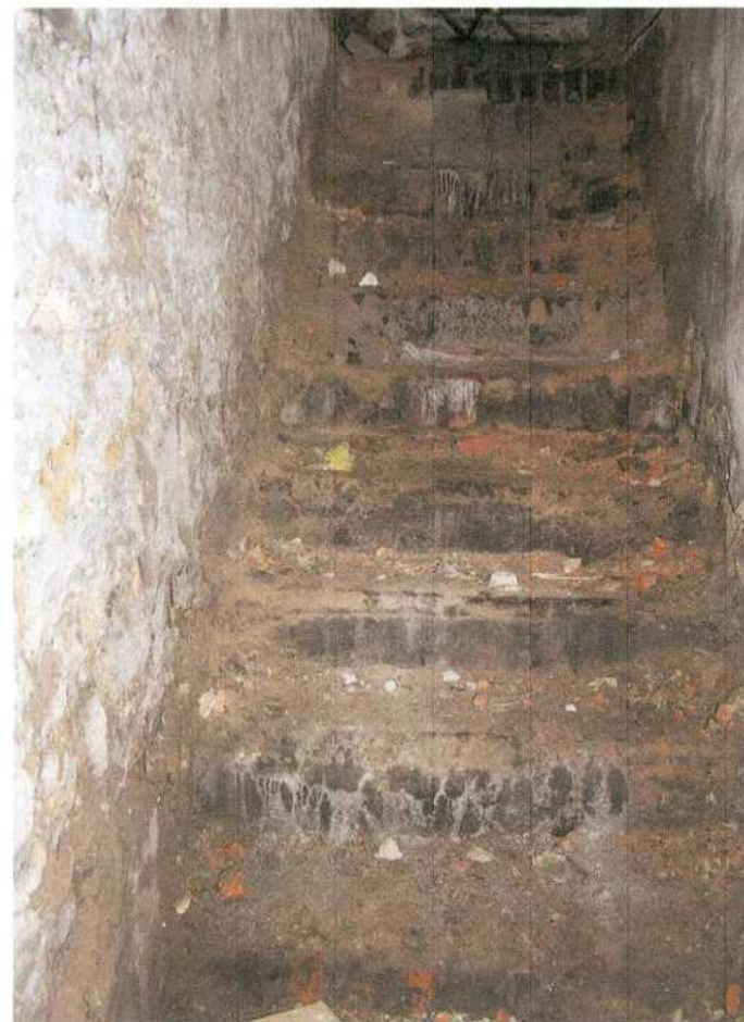
22. Schody do piwnicy
