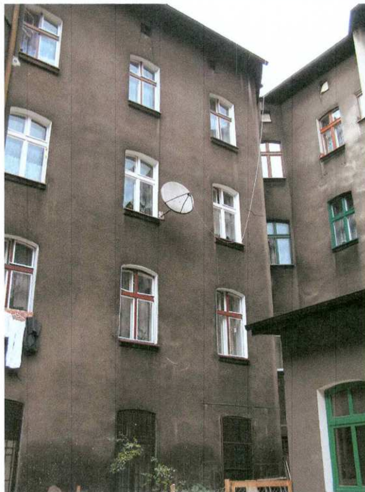
3. Fragment elewacji frontowej
